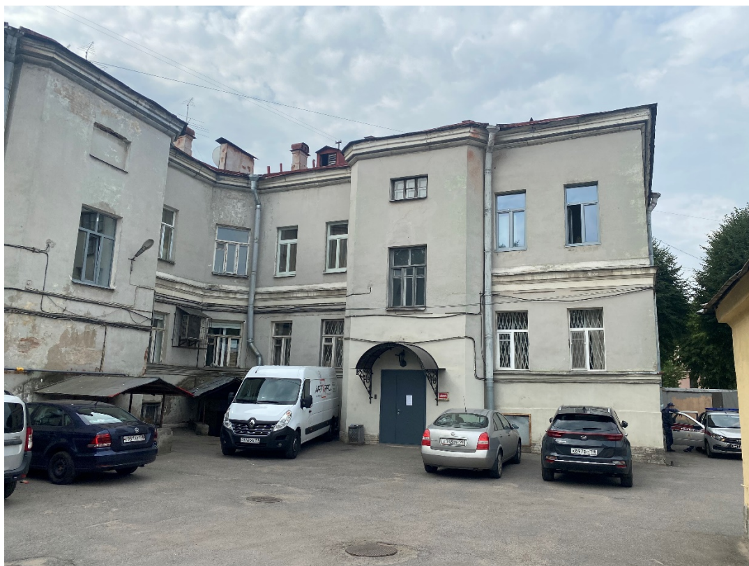
7. Вид на дворовой фасад;
