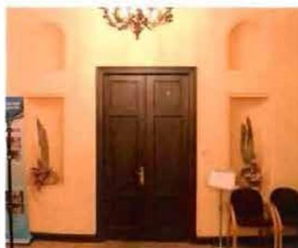
откосы дверного проема (в помещение 8-Н (6) оформлены деревянными филенчатыми панелями;
