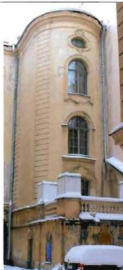
прямоугольный ризалит в уровне первого этажа, завершен балконом с металлическим ограждением (рисунок - вертикальные стойки, волнообразные завитки, рокайли);
