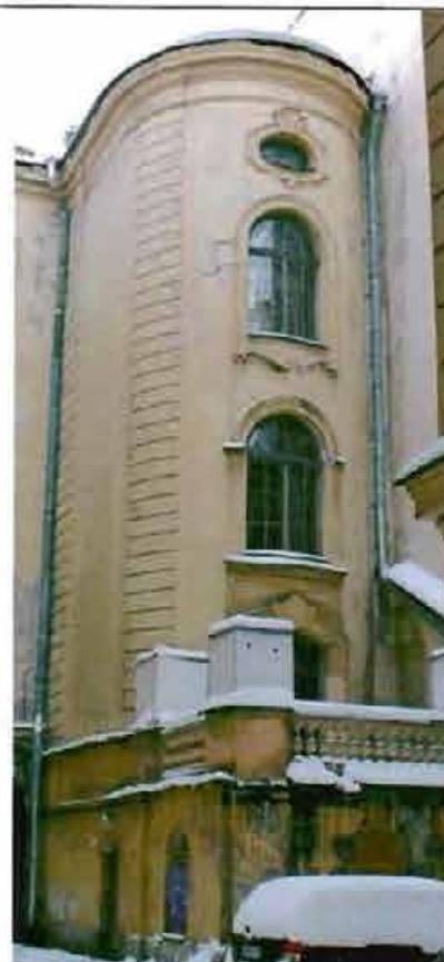
прямоугольный ризалит в уровне первого этажа, завершен балконом с металлическим ограждением (рисунок - вертикальные стойки, волнообразные завитки, рокайли);
