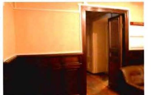
оформление входных проемов в помещения 16-Н (3,5,6,7,11) – деревянный профилированный наличник; деревянное одностворчатое глухое дверное заполнение (пять), створка на две прямоугольные филенки;
