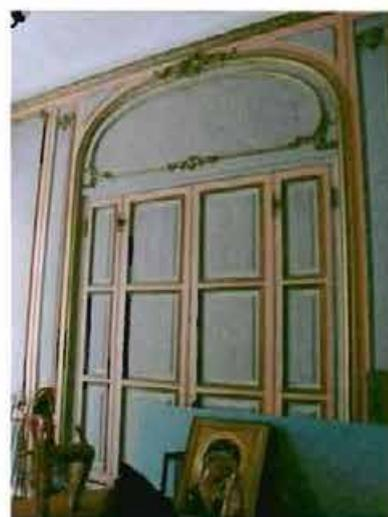
оформление дверного проема в помещение 9-Н(7) и проема встроенного шкафа: десюдепорты в виде фигурных филенок, декорированных растительным орнаментом, цветочными гирляндами и рокайлями, деревянный позолоченные профилированные наличники; деревянное глухое одностворчатое дверное заполнение, каждая створка на две фигурные филенки, декорированные рокайлями; деревянное полусветлое одностворчатое дверное заполнение, каждая створка на две фигурные филенки, декорированные рокайлями;
