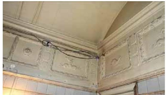
характер облицовки стен - светлая керамическая поливная плитка; в верхних частях профилированная тяга с волнообразным орнаментом;
