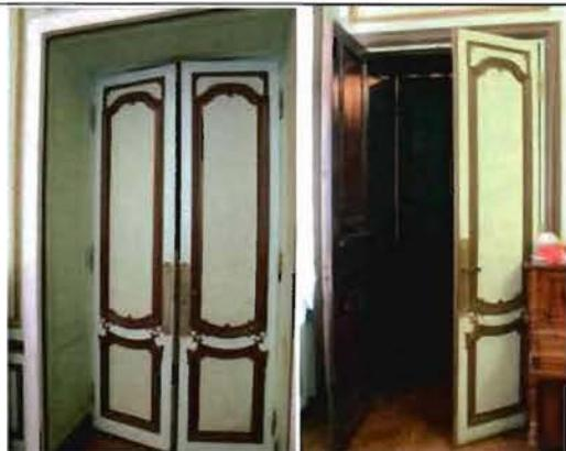
оформление оконных проемов и балконной двери: деревянные профилированные наличники с лепными замковыми камнями в виде картушей со стилизованными раковинами и цветочными гирляндами по сторонам; деревянное двустворчатое полусветлое заполнение балконного входного проема, каждая створка на одну прямоугольную филенку, латунная фурнитура (шпингалеты с фигурными орнаментированными ручками); подоконные доски (две) белого мрамора (фигурные, с профилем по краю);
