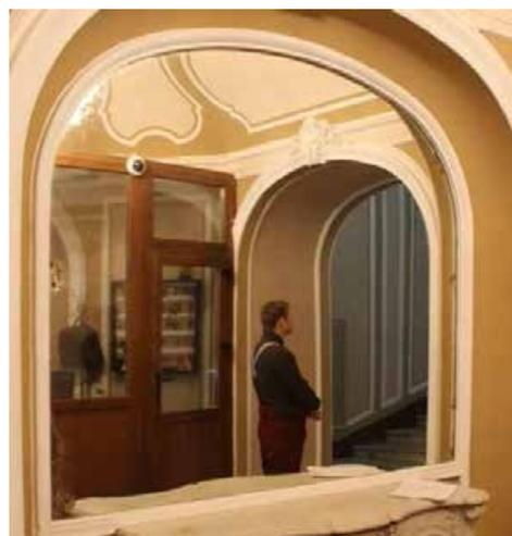
оформление входных проемов в прямоугольную часть вестибюля и на парадную лестницу: штукатурный профилированный наличник с лепным замковым камнем в виде картуша со стилизованной раковиной и цветочными гирляндами по сторонам;
