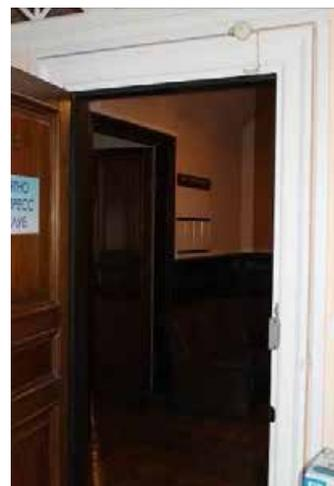
над дверным проемом - фрамуга с лучковым завершением: в деревянном профилированном обрамлении, трехчастная, с мелкой расстекловкой;
