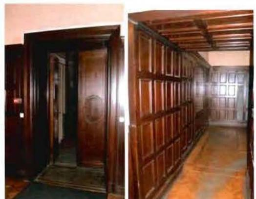
помещение 16-Н(8): нижние части стен облицованы деревянными дубовыми филенчатыми панелями, профилированный венчающий карниз;
