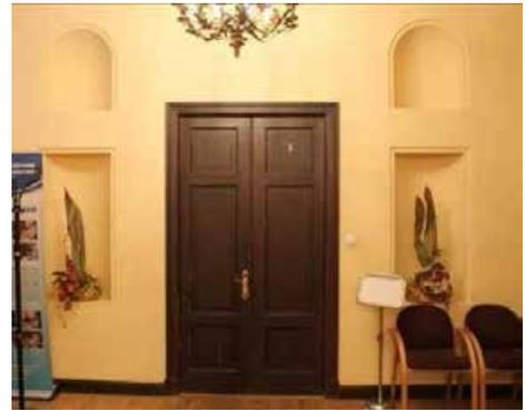
откосы дверного проема (в помещении 8-Н (6) оформлены деревянными филенчатыми панелями;
