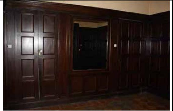
оформление входного проема на парадную лестницу Л-2 и в помещение 16-Н (8): деревянный профилированный наличник, откосы оформлены деревянными филенчатыми панелями, пороги с латунными накладками;
