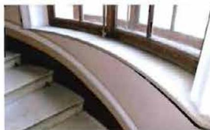
порог балконной двери (между 1-м и 2-м этажами) облицован белым мрамором (с профилем по краю);
