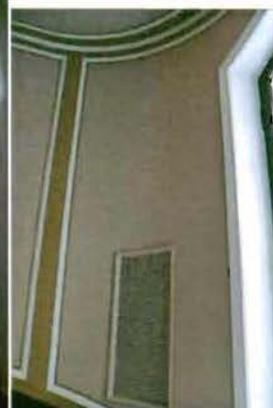
оформление оконных проемов лестницы и балконной двери (в уровне между 1 и 2-м этажами) – штукатурные профилированные наличники; латунная фурнитура (шпингалеты с фигурными ручками);
