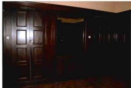
оформление входного проема на парадную лестницу Л-2 и в помещение 16-Н(8): деревянный профилированный наличник, откосы оформлены деревянными филенчатыми панелями;
