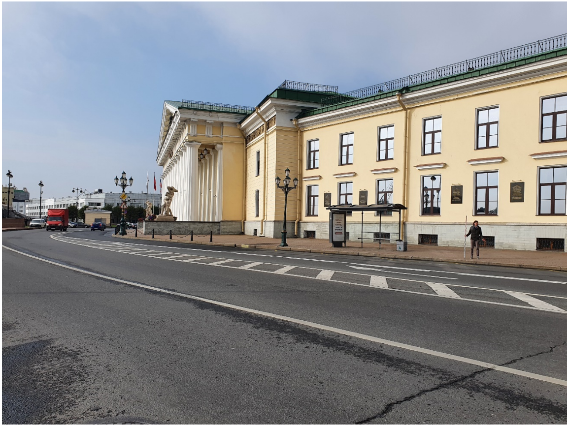
Рис. 14. СПб-2021. 20-я линия В.О. Общий вид трассы обследования. Точка фотофиксации 3. Направление проектируемой трассы вдоль здания Горного университета. Вид с востока
