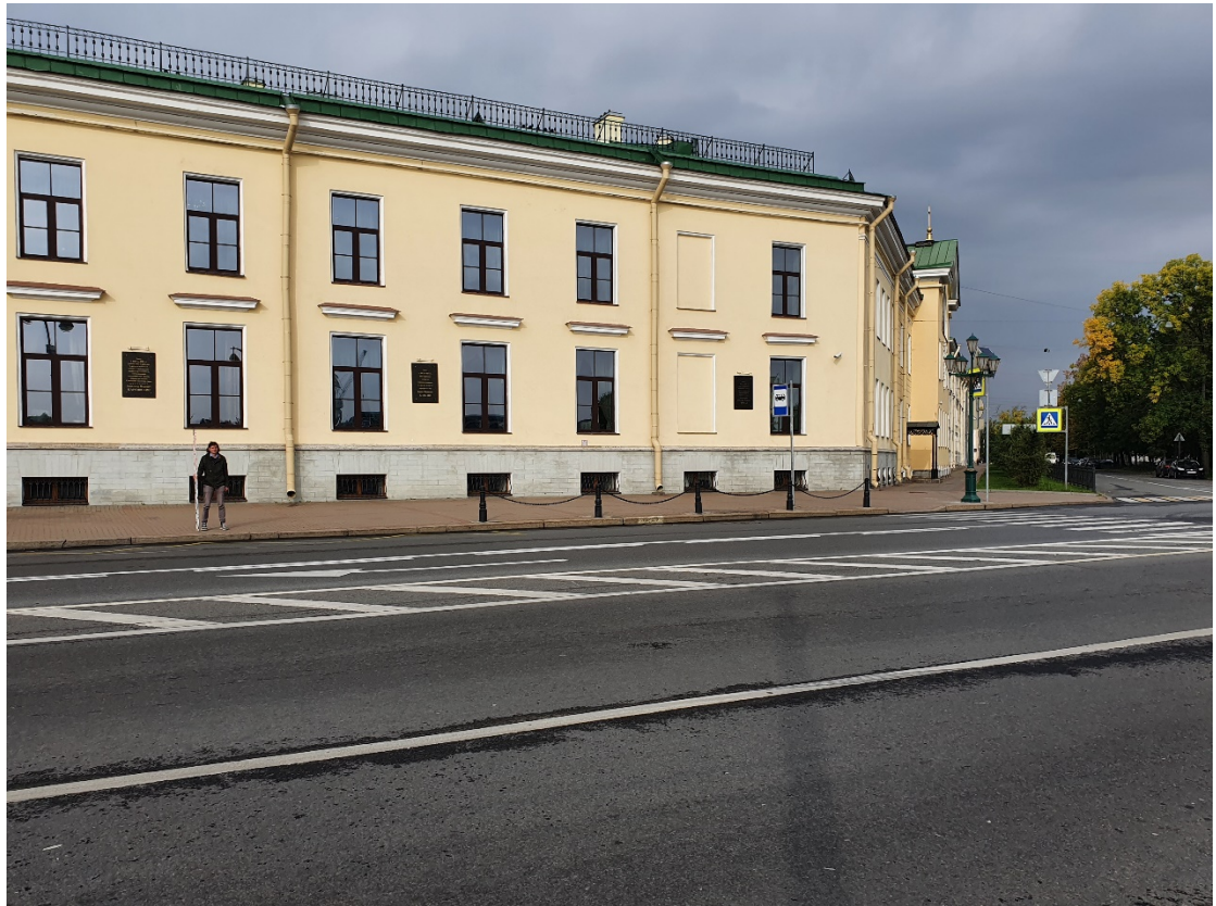
Рис. 16. СПб-2021. 20-я линия В.О. Общий вид трассы обследования. Точка фотофиксации 5. Направление проектируемой трассы вдоль здания Горного университета с поворотом на 20-21 линию. Вид с юга
