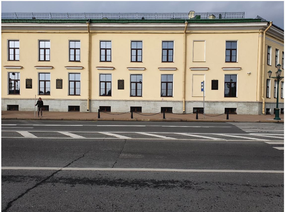
Рис. 15. СПб-2021. 20-я линия В.О. Общий вид трассы обследования. Точка фотофиксации 4. Направление проектируемой трассы вдоль здания Горного университета. Вид с юга
