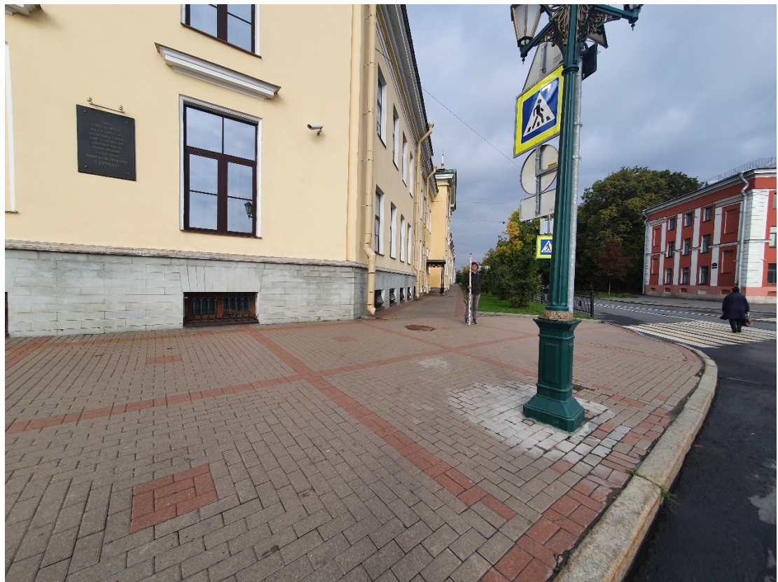
Рис. 17. СПб-2021. 20-я линия В.О. Общий вид трассы обследования. Точка фотофиксации 6. Направление проектируемой трассы вдоль здания Горного университета с поворотом на 20-21 линию. Вид с юга
