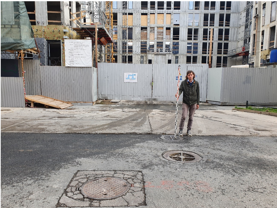
Рис. 27. СПб-2021. 20-я линия В.О. Общий вид трассы обследования. Точка фотофиксации 15. Направление проектируемой трассы, поворот на 20 линию к дому № 5. Вид с запада
