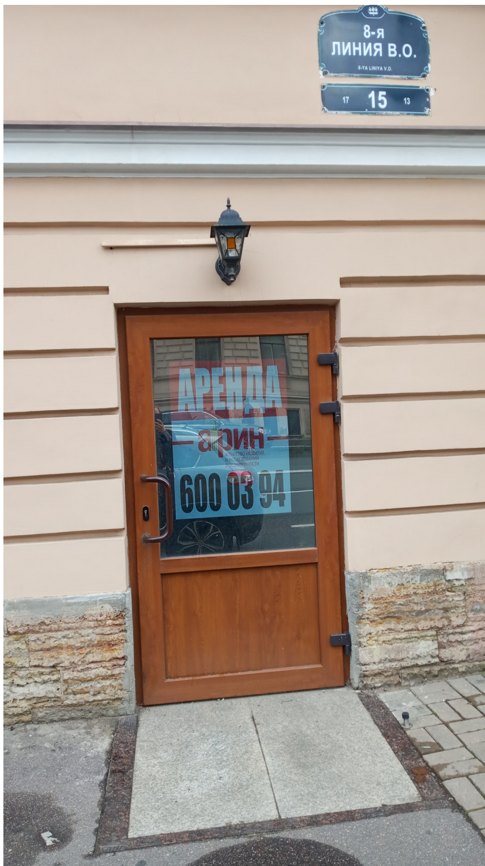
Фото 4. Выявленный объект культурного наследия «Дом И. М. Барышева». Вход в помещение 3-Н.
