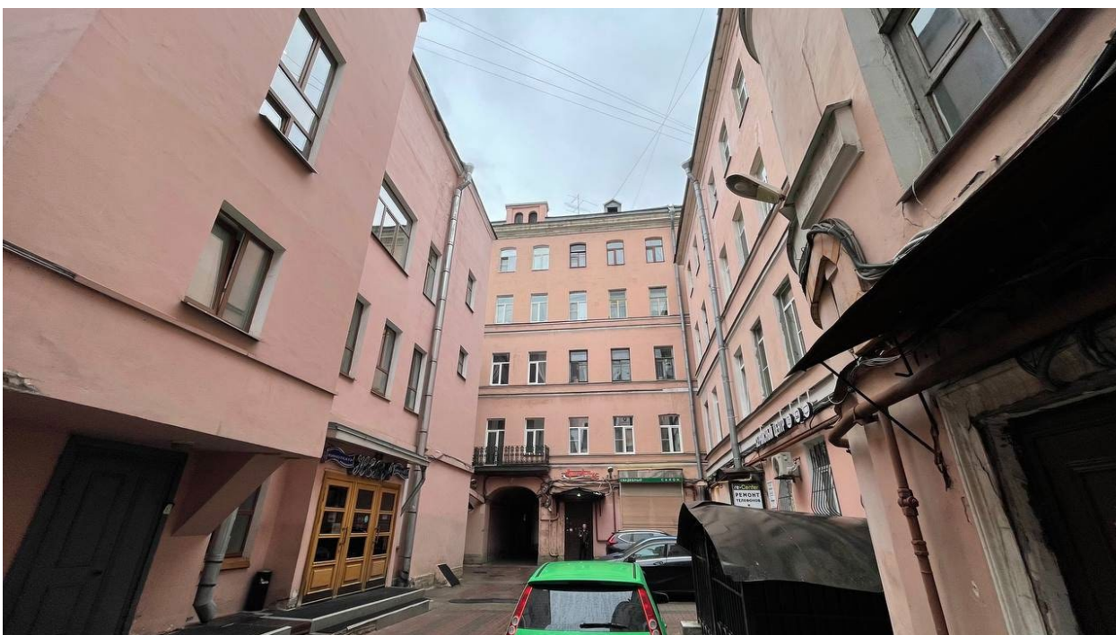
2. Вид на дворовой фасад;
