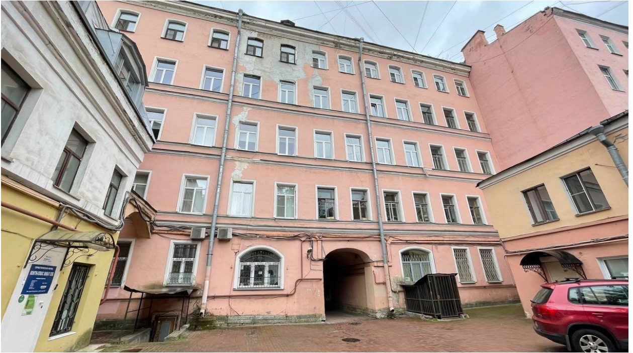
3. Вид на дворовой фасад здания и окна квартиры;
