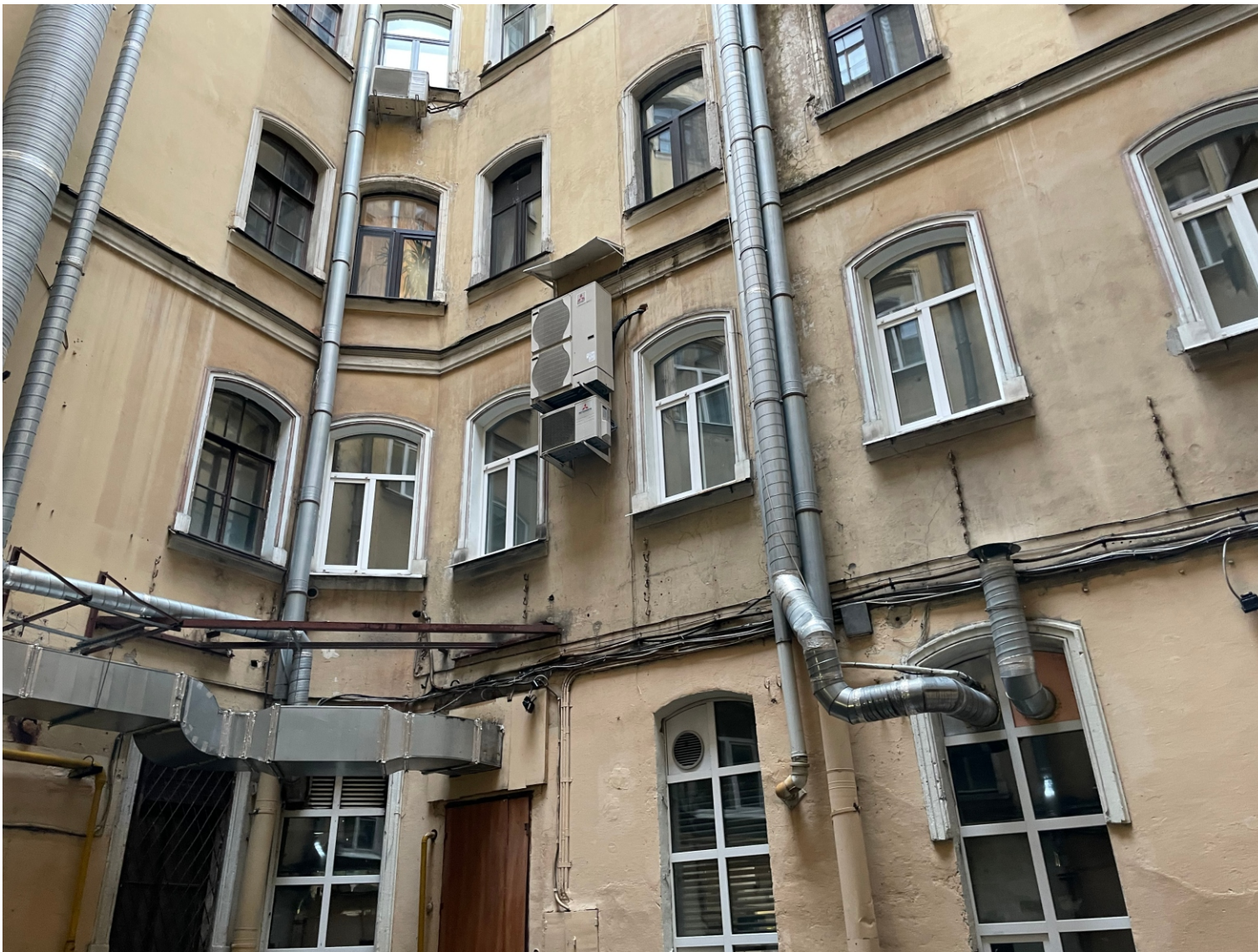
10. «Дом Г.Г.Елисева». Санкт-Петербург, ул. Ломоносова, д.14, литера А. 2-й двор. Фрагмент дворового фасада. Фото: 15.10.2022.
