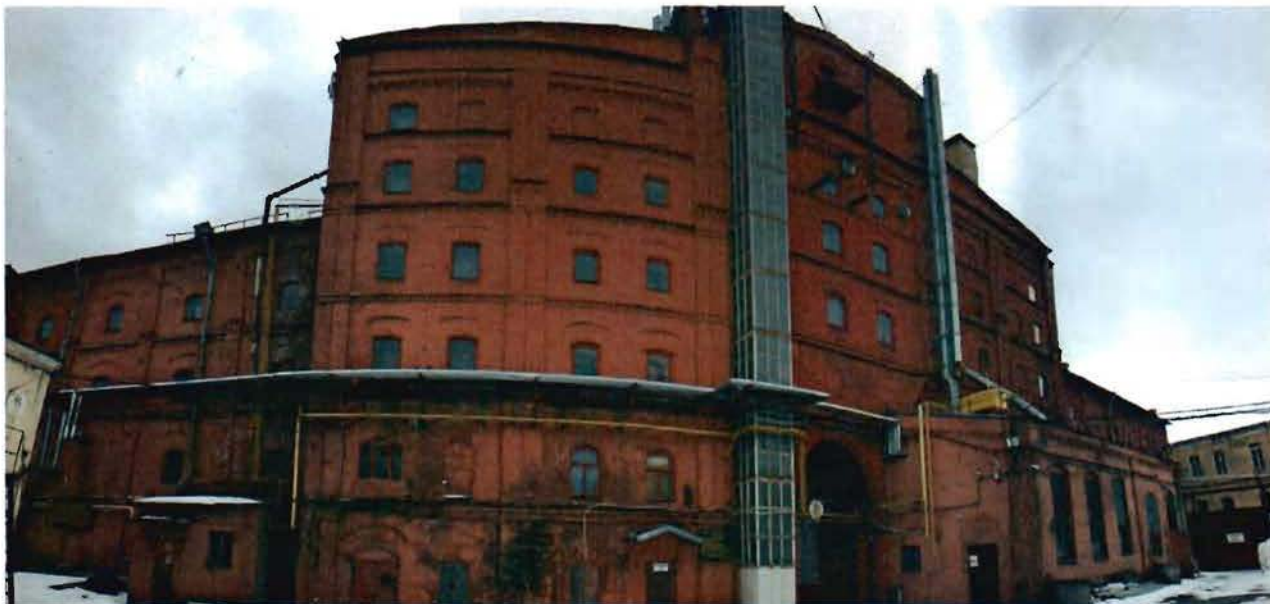
1. Северный фасад. Общий вид.
