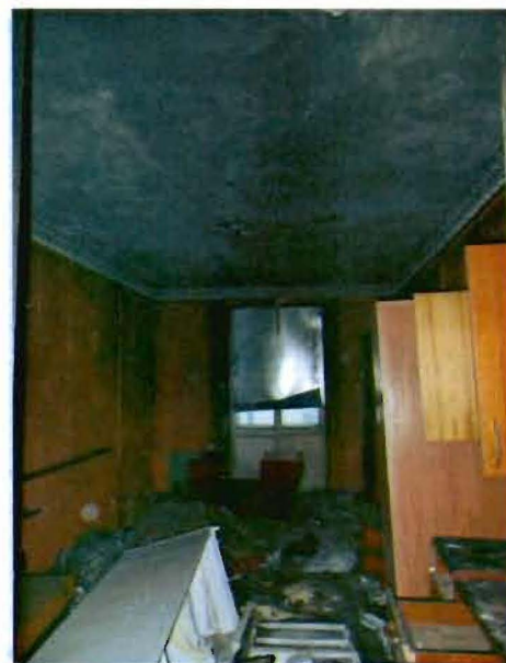
20. Помещение третьего этажа.
