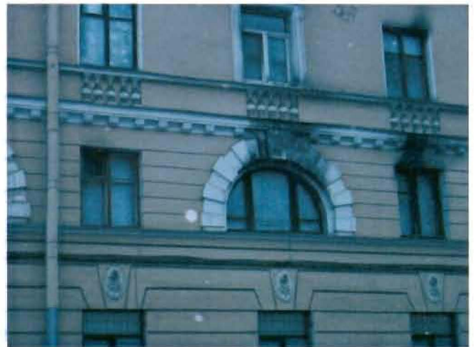
12. Оконные проемы второго этажа.
