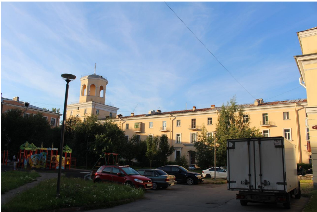
Фото 11. Вид на здание, расположенное по адресу: Санкт-Петербург, пр. Стачек, д. 158, лит. А, с юго-запада.
