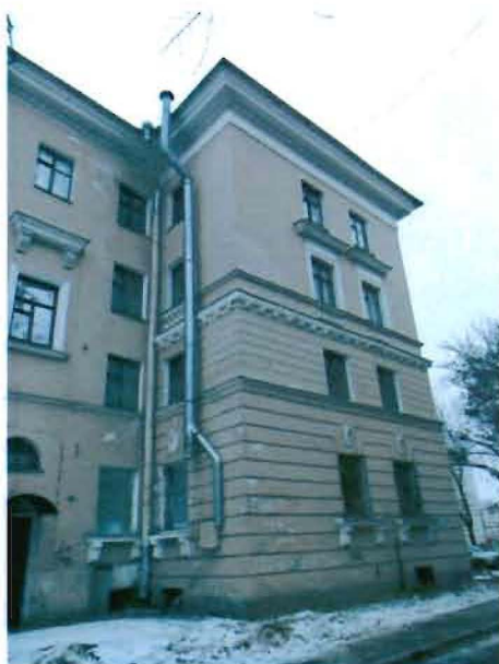
6. Ризалит в западной части.
