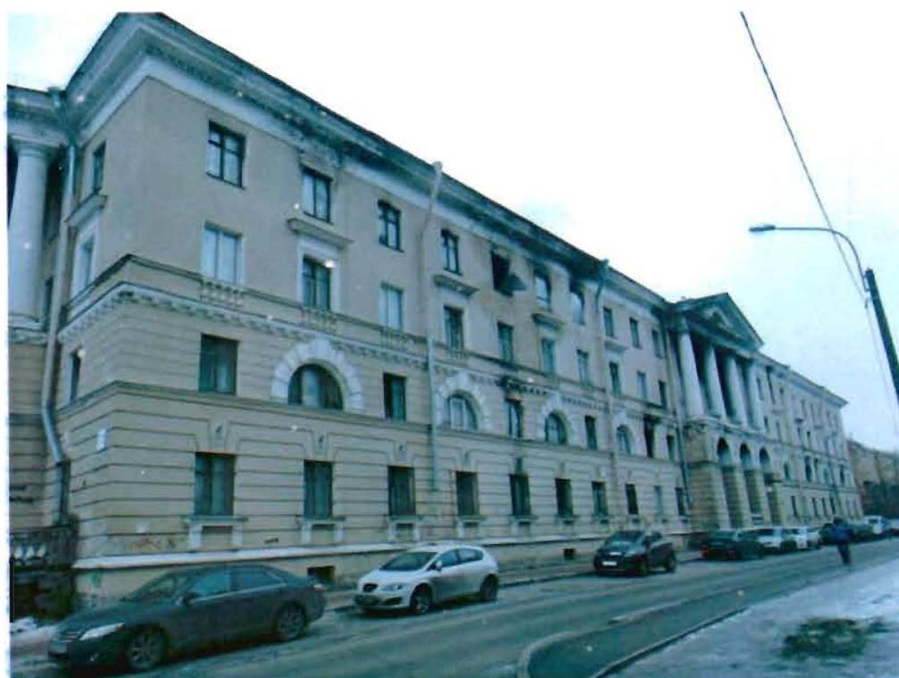
2. Лицевой фасад. Вид с запада.
