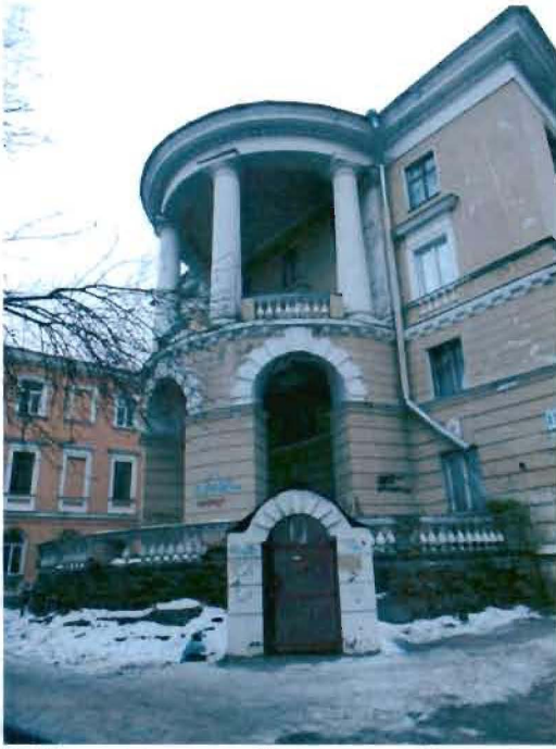
9. Полуциркульный ризалит с балконом и террасой.
