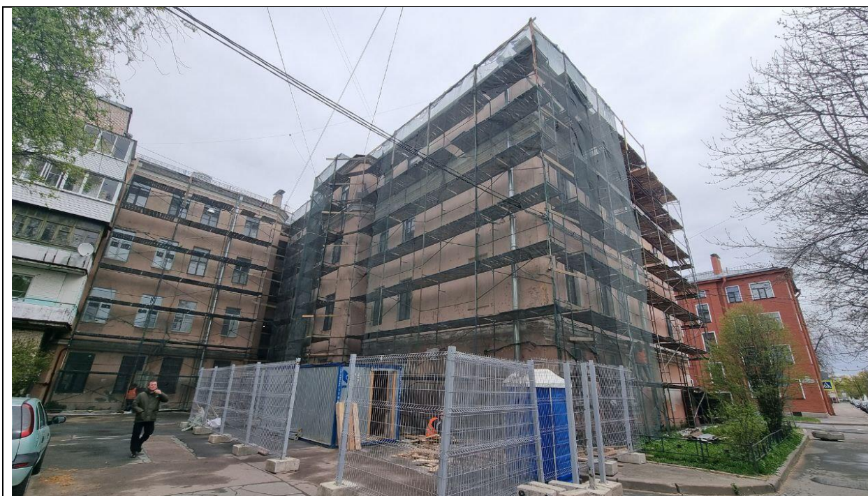
Фото 4. Общий вид дворовых фасадов.
