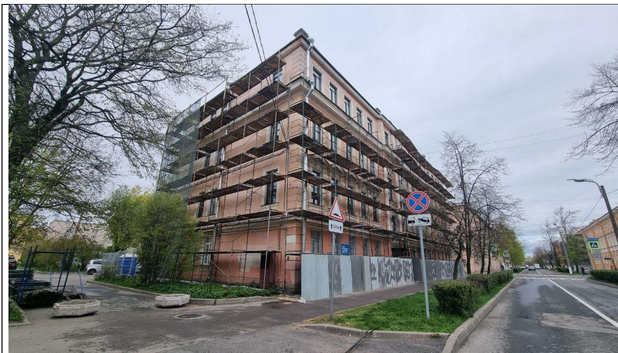
Фото 3. Общий вид торцевого фасада по ул. Посадской.
