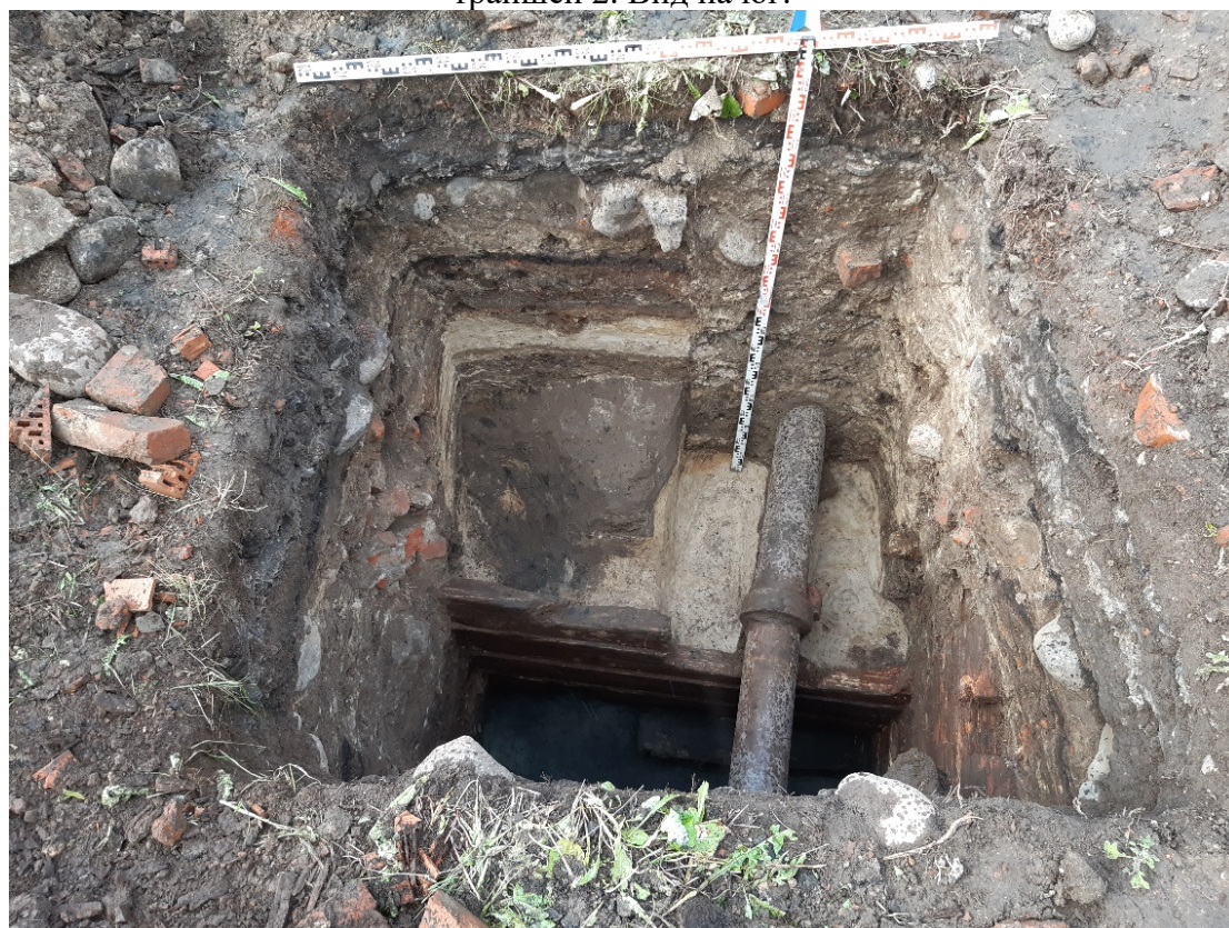
Рис. 57. Санкт-Петербург, Шпалерная ул. д. 51, лит.Б. Шурф 1. Фотофиксация сохранившегося фрагмента слоя погребенной почвы (темно-серая супесь) и выбранного деревянного короба. Вид на север.
