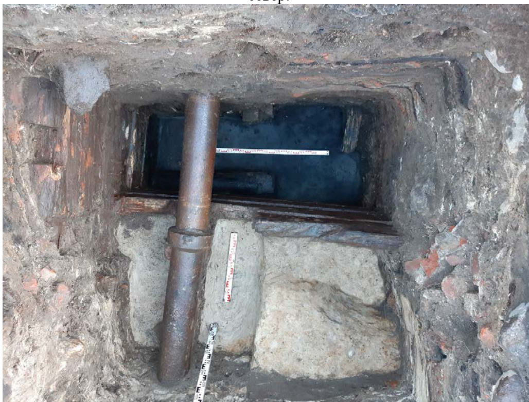
Рис. 60. Санкт-Петербург, Шпалерная ул. д. 51, лит.Б. Шурф 1. Фотофиксация по светло-серой супеси с пятнами ожелезнения (материку) Уровень прекращения работ. Вид на юг.
