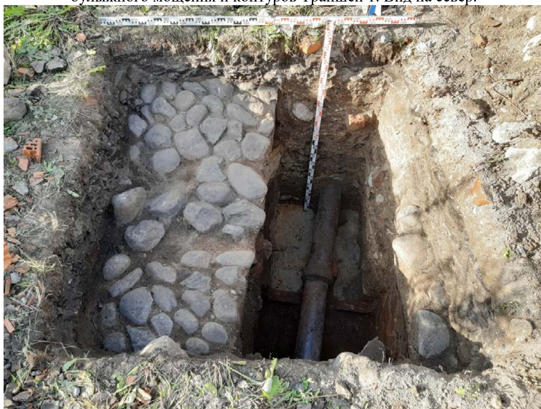
Рис. 51. Санкт-Петербург, Шпалерная ул. д. 51, лит.Б. Шурф 1. Фотофиксация по дну выбранной траншеи 1. Вид на север.
