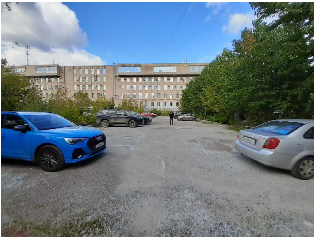
Рис. 33. Санкт-Петербург, Шпалерная ул. д. 51, лит.Б. Общий вид участка. Точка съемки 7. Вид на север.
