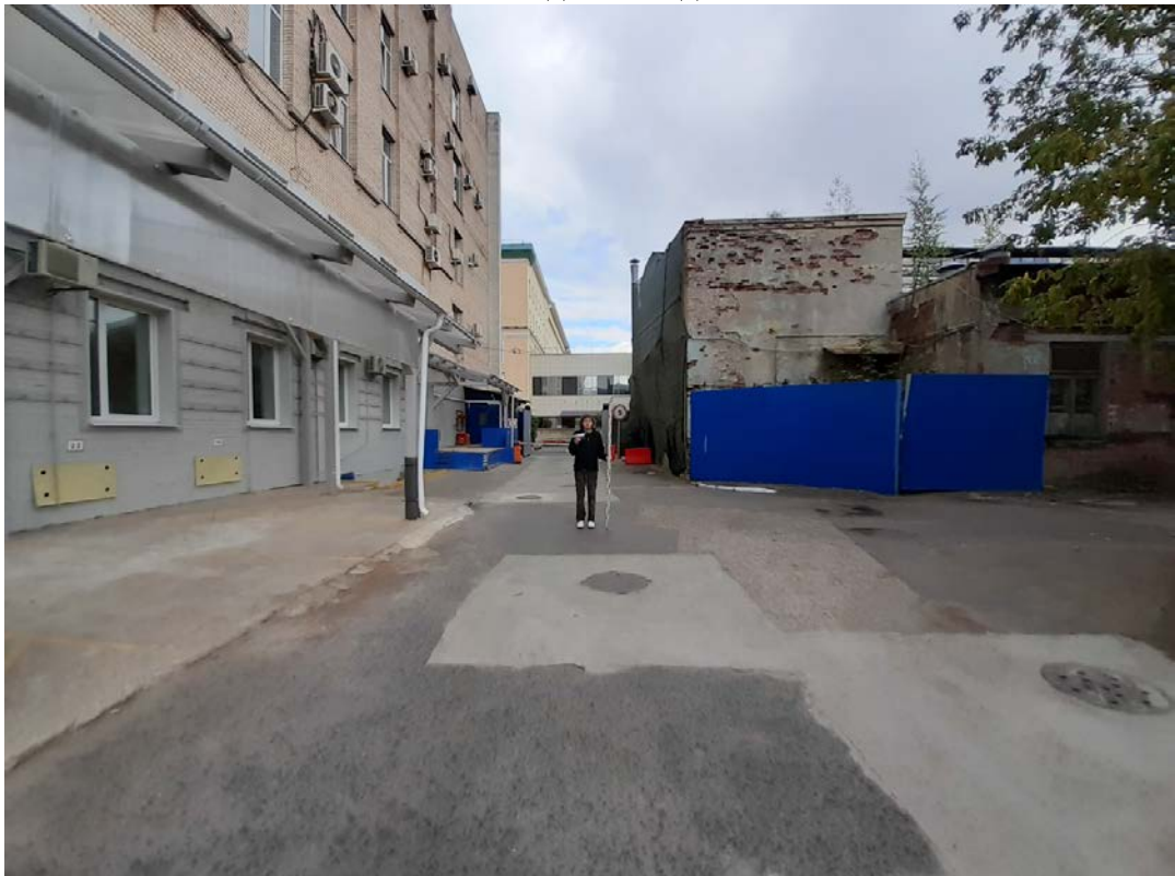
Рис. 28. Санкт-Петербург, Шпалерная ул. д. 51, лит.Б. Общий вид участка. Точка съемки 5. Вид на восток.
