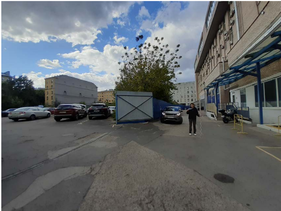
Рис. 27. Санкт-Петербург, Шпалерная ул. д. 51, лит.Б. Общий вид участка. Точка съемки 4. Вид на запад.
