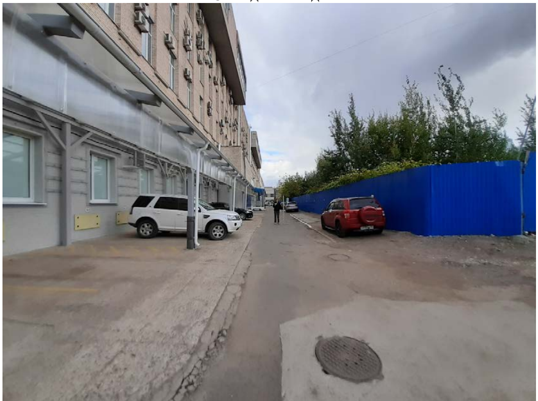
Рис. 24 Санкт-Петербург, Шпалерная ул. д. 51, лит.Б. Общий вид участка. Точка съемки 3. Вид на восток.
