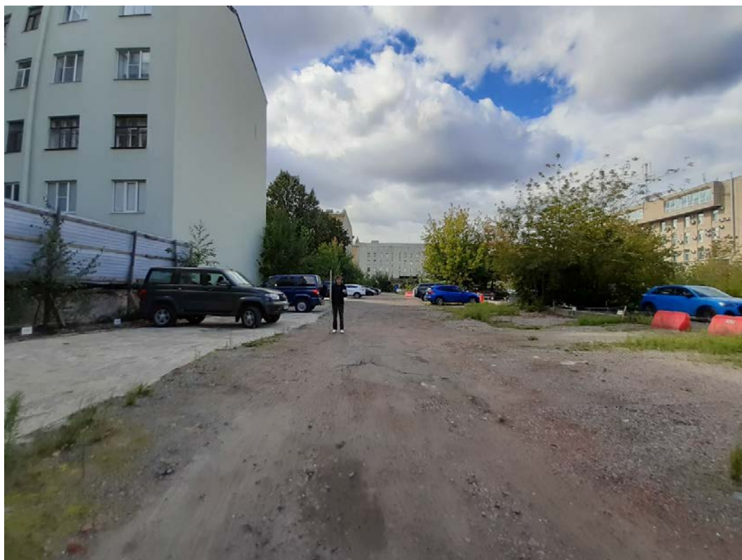
Рис. 35. Санкт-Петербург, Шпалерная ул. д. 51, лит.Б. Общий вид участка. Точка съемки 7. Вид на запад.
