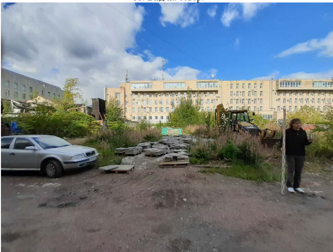
Рис. 42. Санкт-Петербург, Шпалерная ул. д. 51, лит.Б. Общий вид участка. Точка съемки 12. Вид на север.
