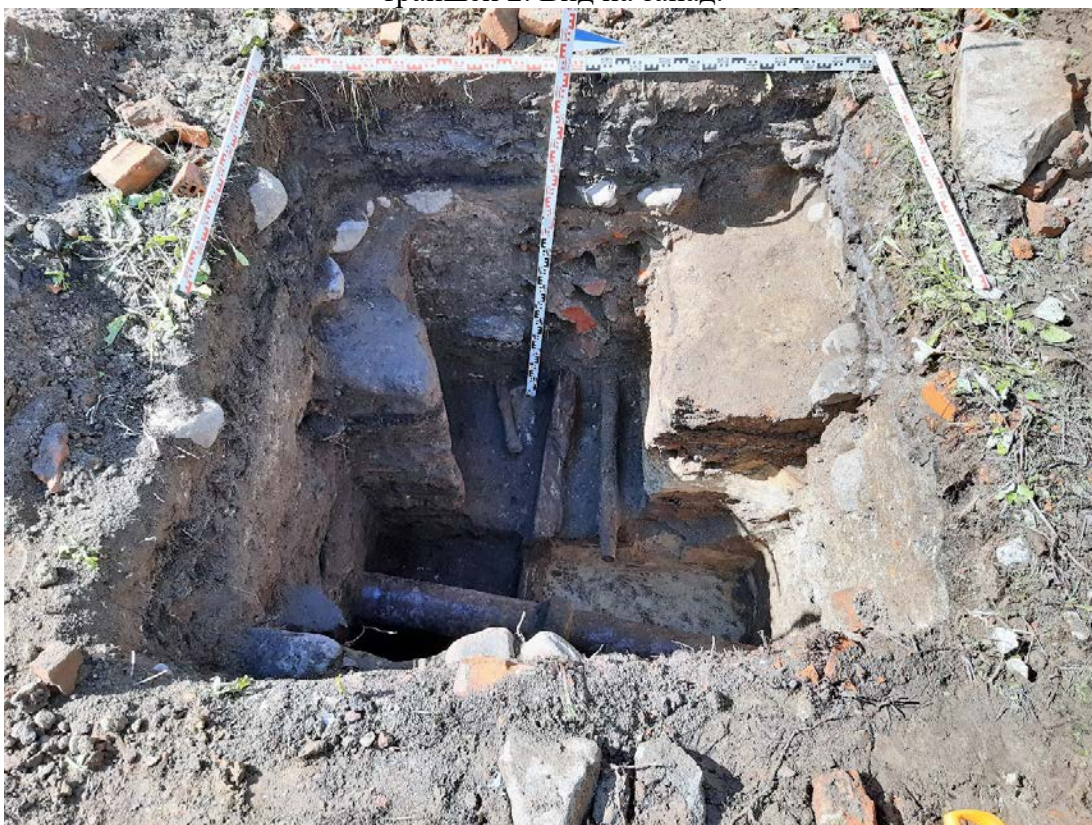
Рис. 55. Санкт-Петербург, Шпалерная ул. д. 51, лит.Б. Шурф 1. Фотофиксация по дну траншеи 2. Вид на запад.
