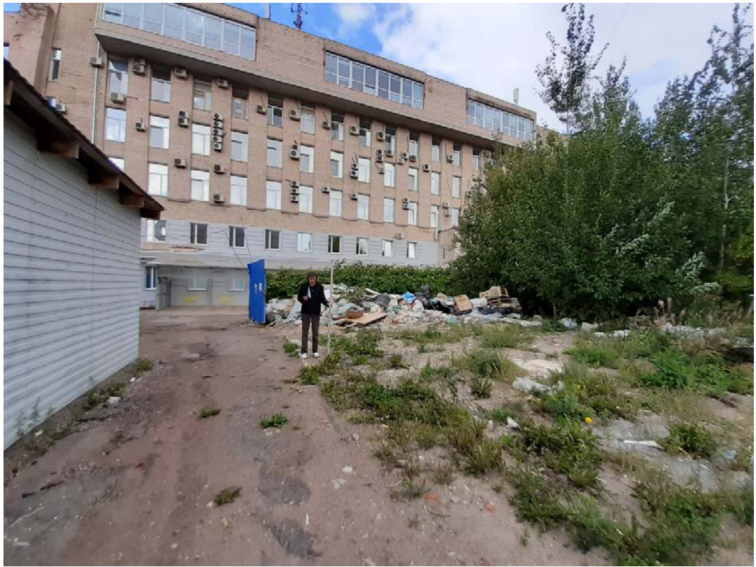
Рис. 21. Санкт-Петербург, Шпалерная ул. д. 51, лит.Б. Общий вид участка. Точка съемки 2. Вид на север.
