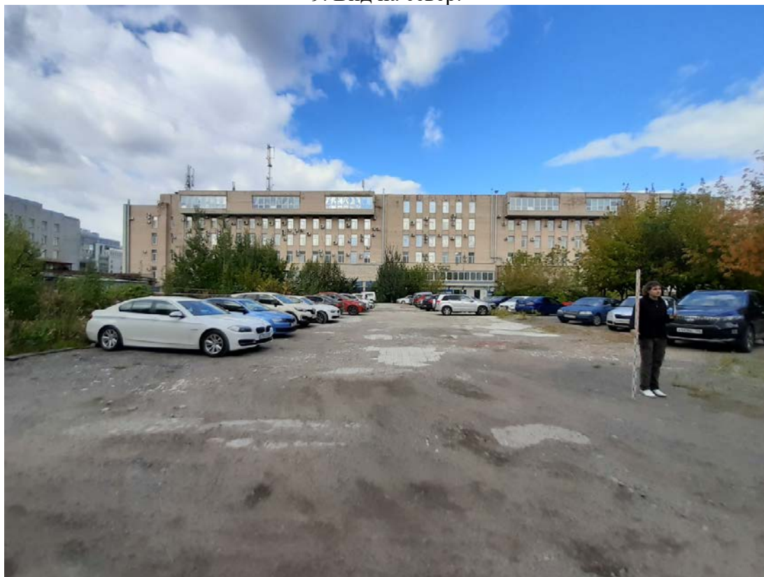
Рис. 38. . Санкт-Петербург, Шпалерная ул. д. 51, лит.Б. Общий вид участка. Точка съемки 10. Вид на север.
