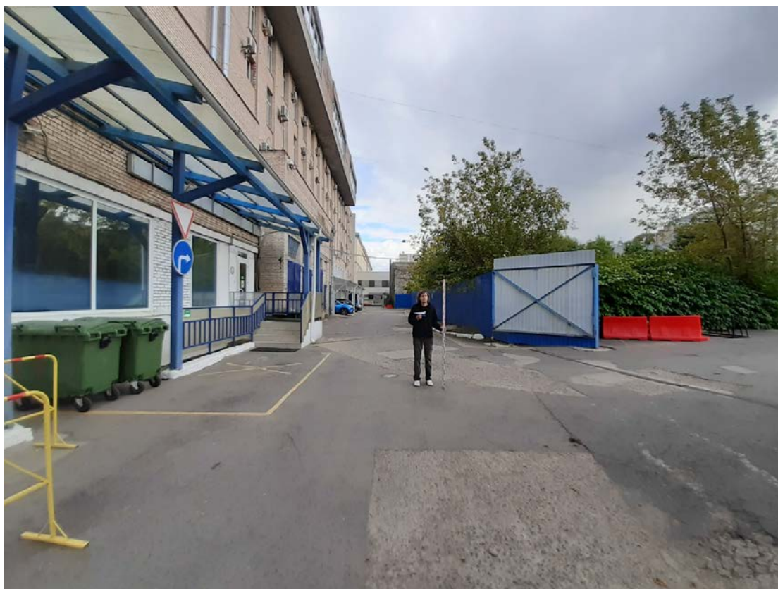
Рис. 25. Санкт-Петербург, Шпалерная ул. д. 51, лит.Б. Общий вид участка. Точка съемки 4. Вид на восток.
