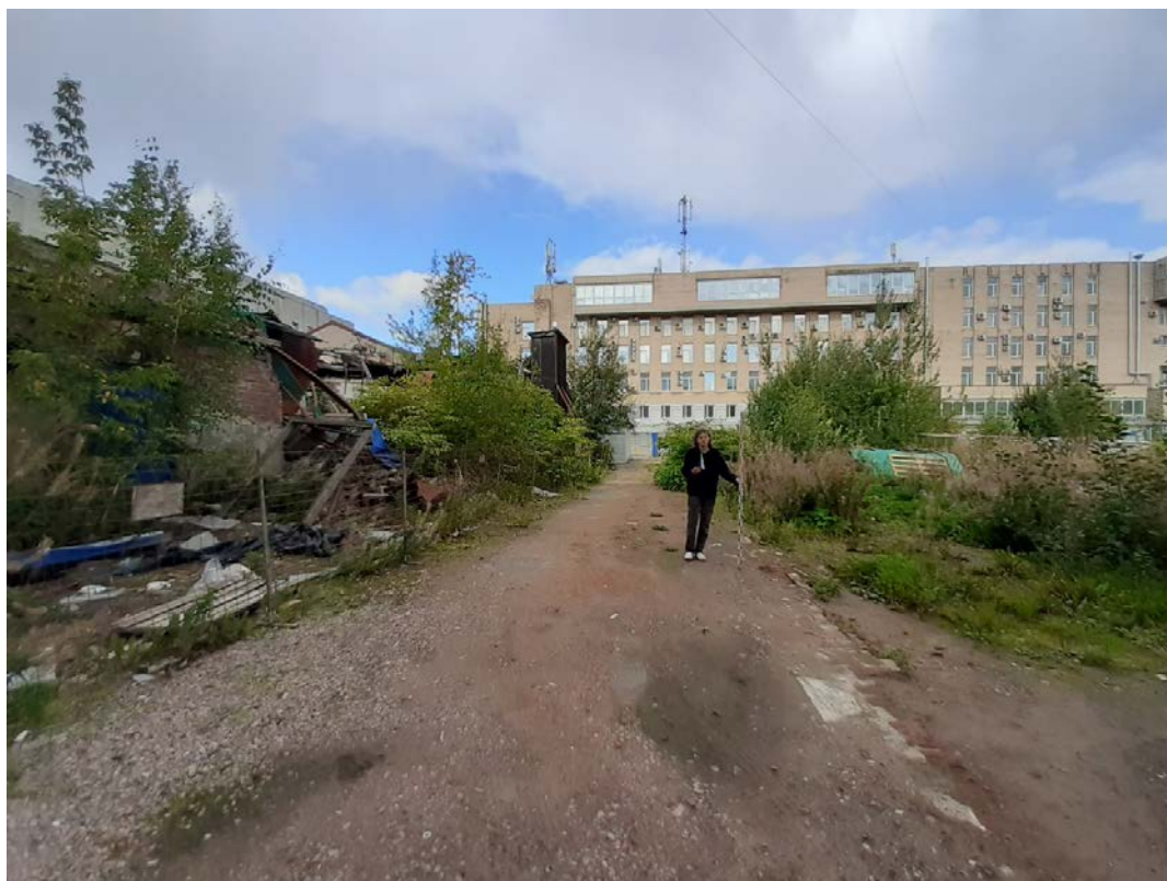
Рис. 19. Санкт-Петербург, Шпалерная ул. д. 51, лит.Б. Общий вид участка. Точка съемки 1. Вид на север.
