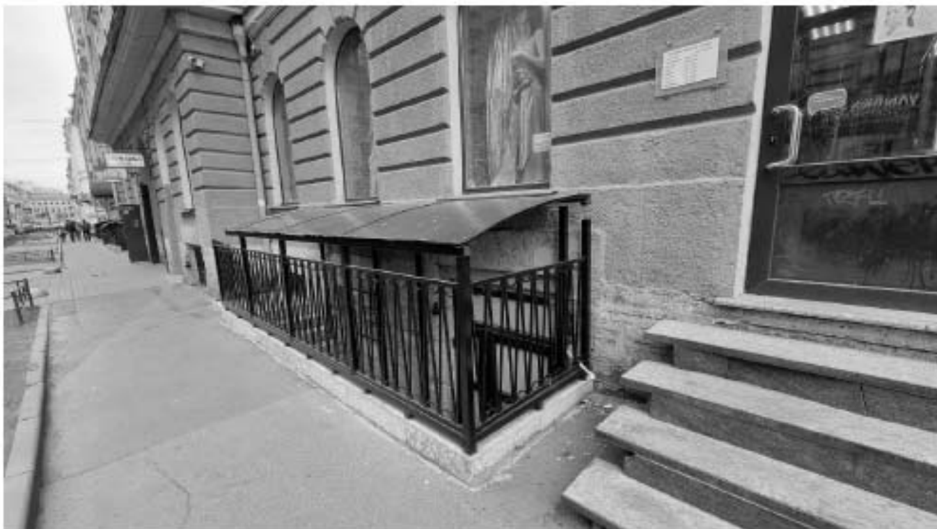
Фото 7 "Дом Зверкова". Вход в подвал с приямок на юго-западном лицевом фасаде по Столярному переулку. Приямок.
