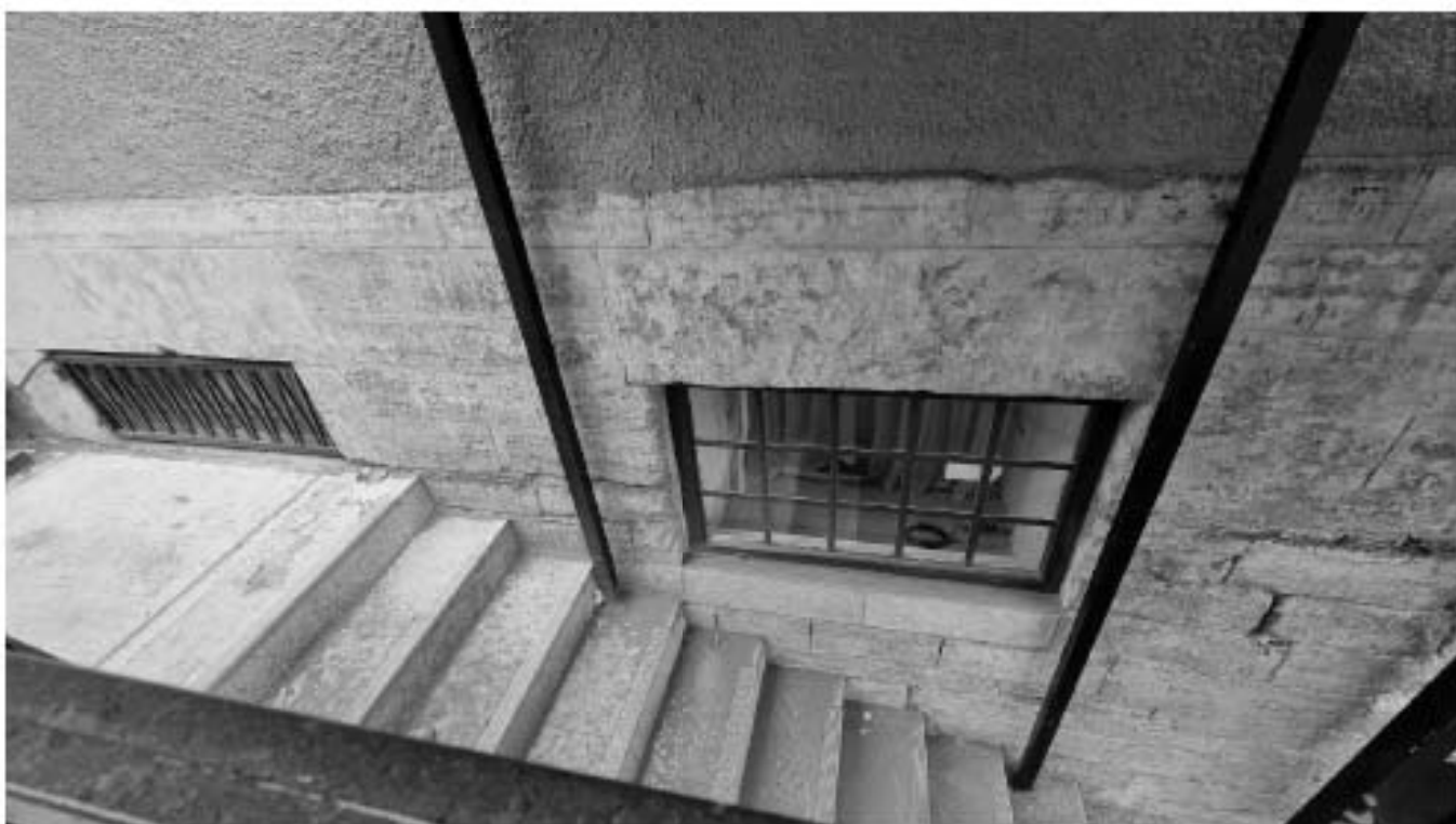
Фото 8 "Дом Зверкова". Вход в подвал с приямок на юго-западном лицевом фасаде по Столярному переулку. Окна помещения 4Н
