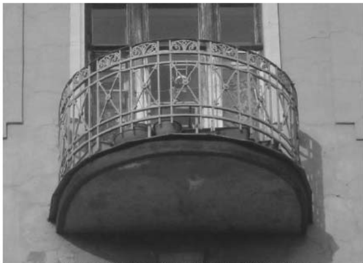
Доходный дом. Фрагмент. СПб, 6-я линия ВО, д. 43. 1913-1914 гг. Неоклассицизм, Арх. Шагин Д. А. Современное состояние. Фотография. Автор съемки: неизвестен. www.sitywalls.ru
