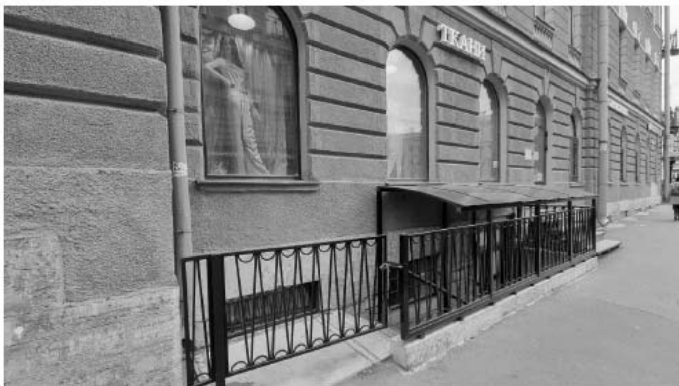
Фото 5 "Дом Зверкова". Вход в подвал с приямок на юго-западном лицевом фасаде по Столярному переулку. Приямок.
