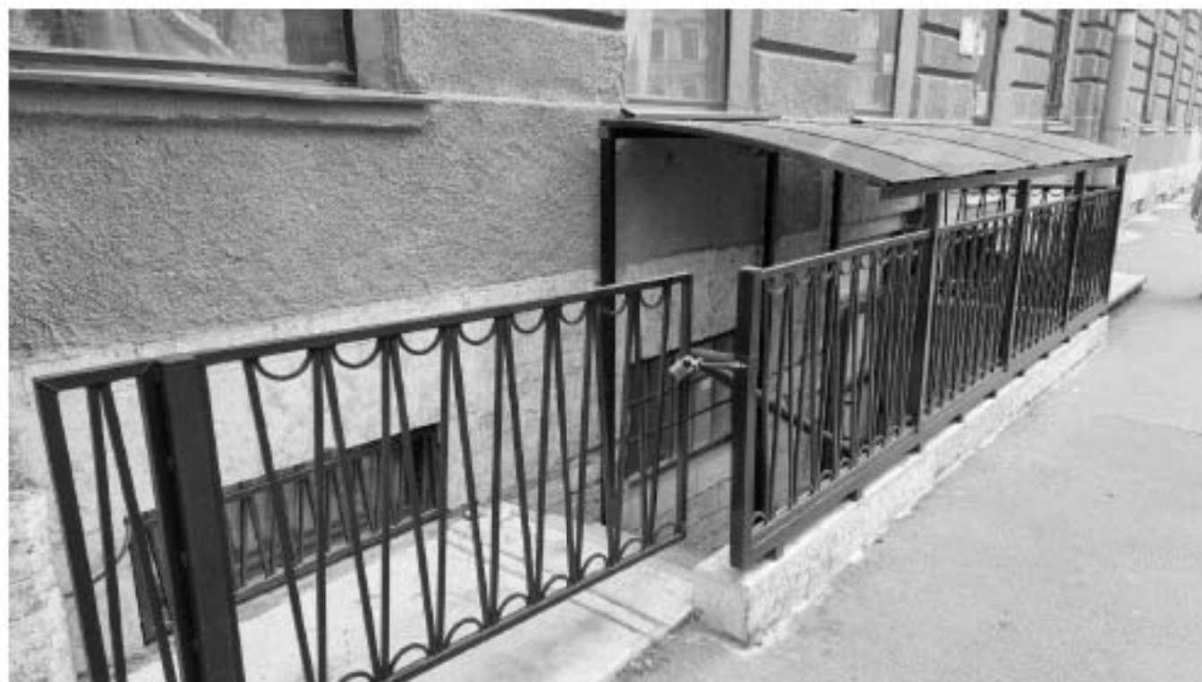
Фото 6 "Дом Зверкова". Вход в подвал с приямок на юго-западном лицевом фасаде по Столярному переулку. Приямок.
