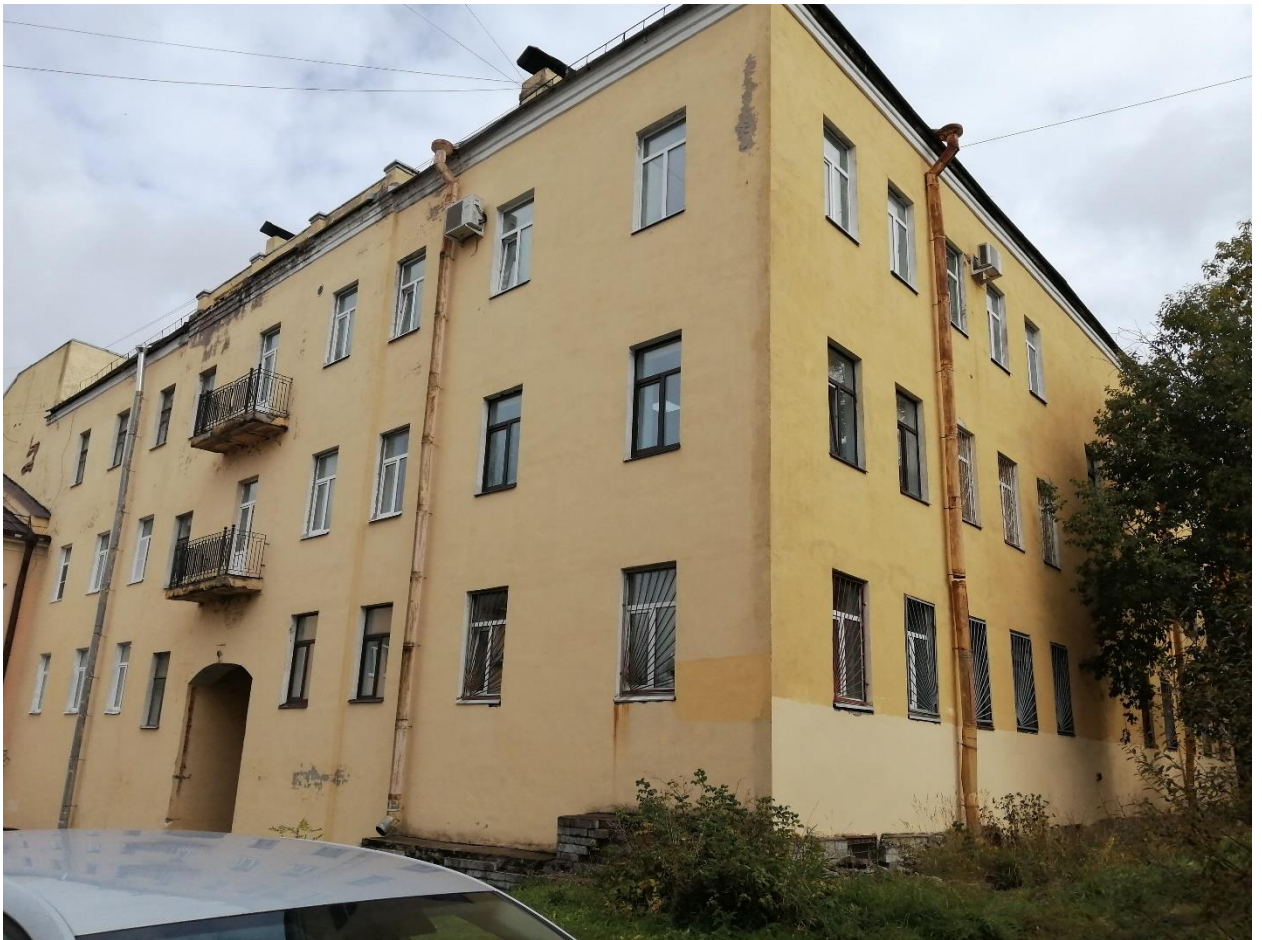
Фото 7. Объект культурного наследия регионального значения «Жилой дом», расположенный по адресу: Санкт-Петербург, город Ломоносов, Дворцовый проспект, д.40, лит.Б. Центральный дворовый корпус, южный фасад, правый дворовый корпус, западный фасад.
