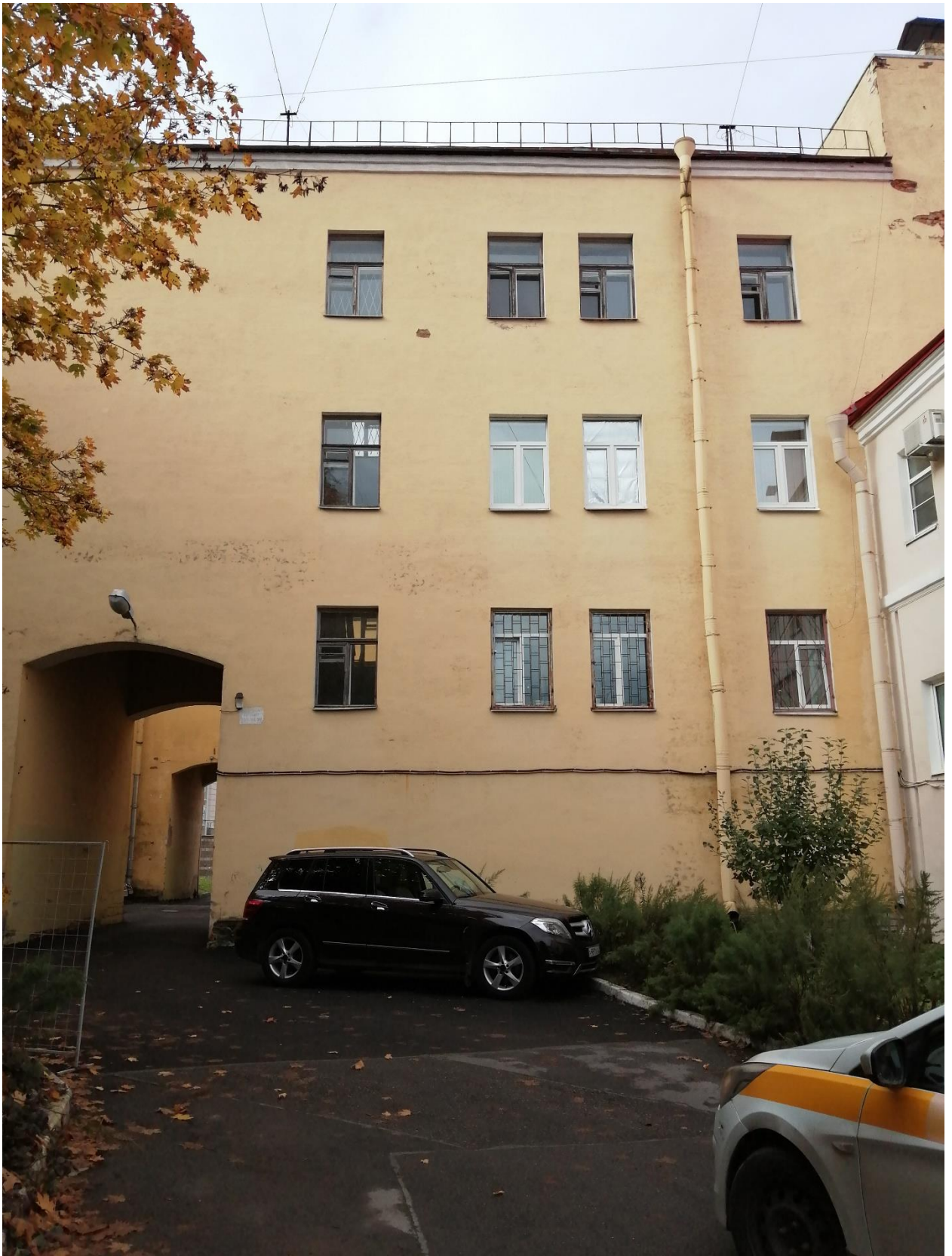
Фото 8. Объект культурного наследия регионального значения «Жилой дом», расположенный по адресу: Санкт-Петербург, город Ломоносов, Дворцовый проспект, д.40, лит.Б. Левый дворовый корпус, восточный фасад.
