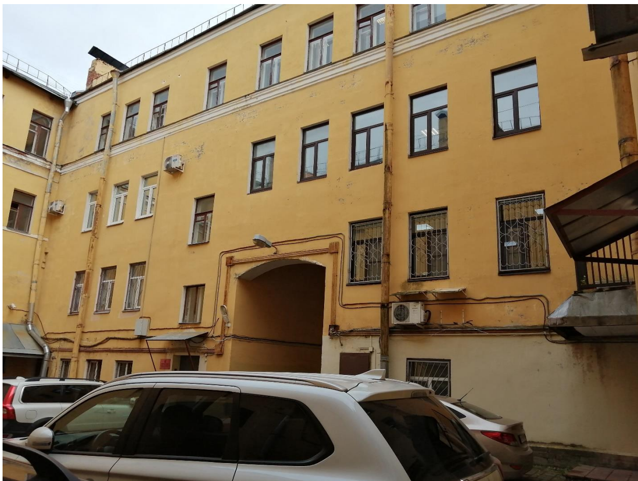
Фото 3. Объект культурного наследия регионального значения «Жилой дом», расположенный по адресу: Санкт-Петербург, город Ломоносов, Дворцовый проспект, д.40, лит.Б. Левый дворовый корпус. Западный фасад.
