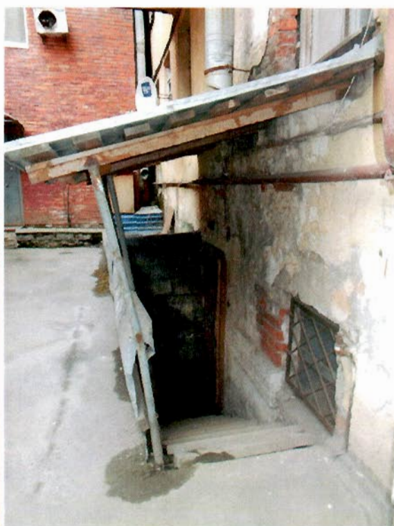
13. Прямок (дворовой фасад, западная часть)
