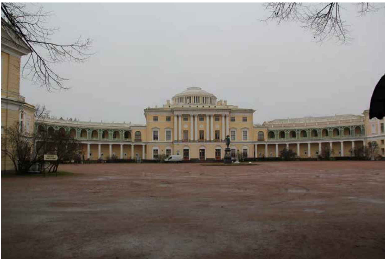
Фото 5. Вид на главный корпус и галереи с востока.
