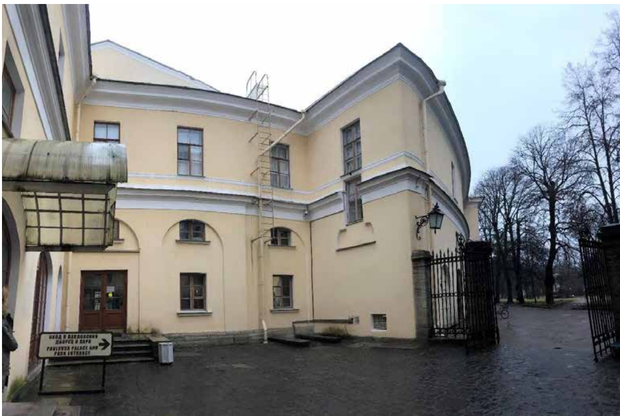
Фото 15. Вид на южный фасад южного бокового корпуса.
