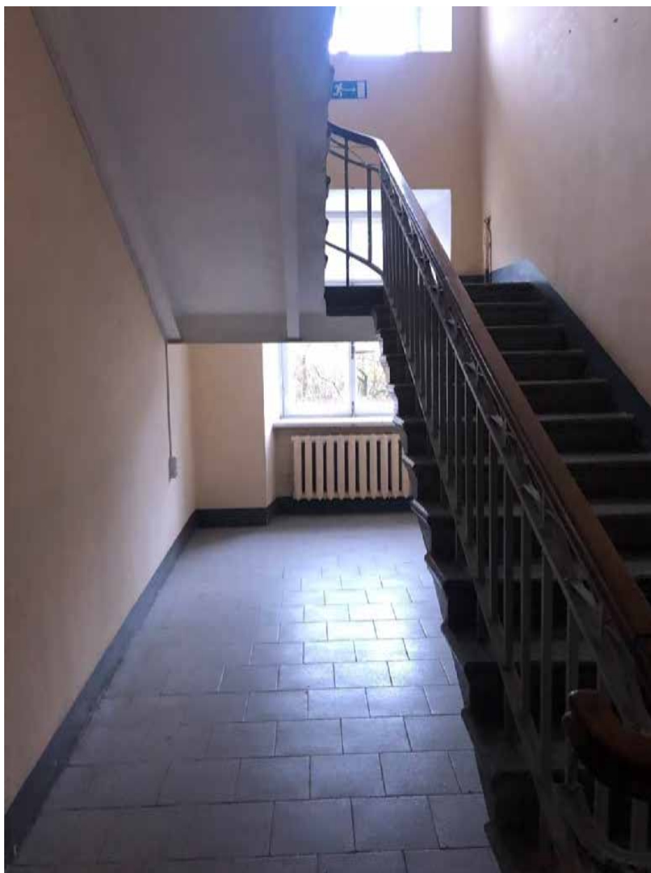
Фото 97. Интерьер внутренних помещений 1-го этажа перехода в церковный флигель.
