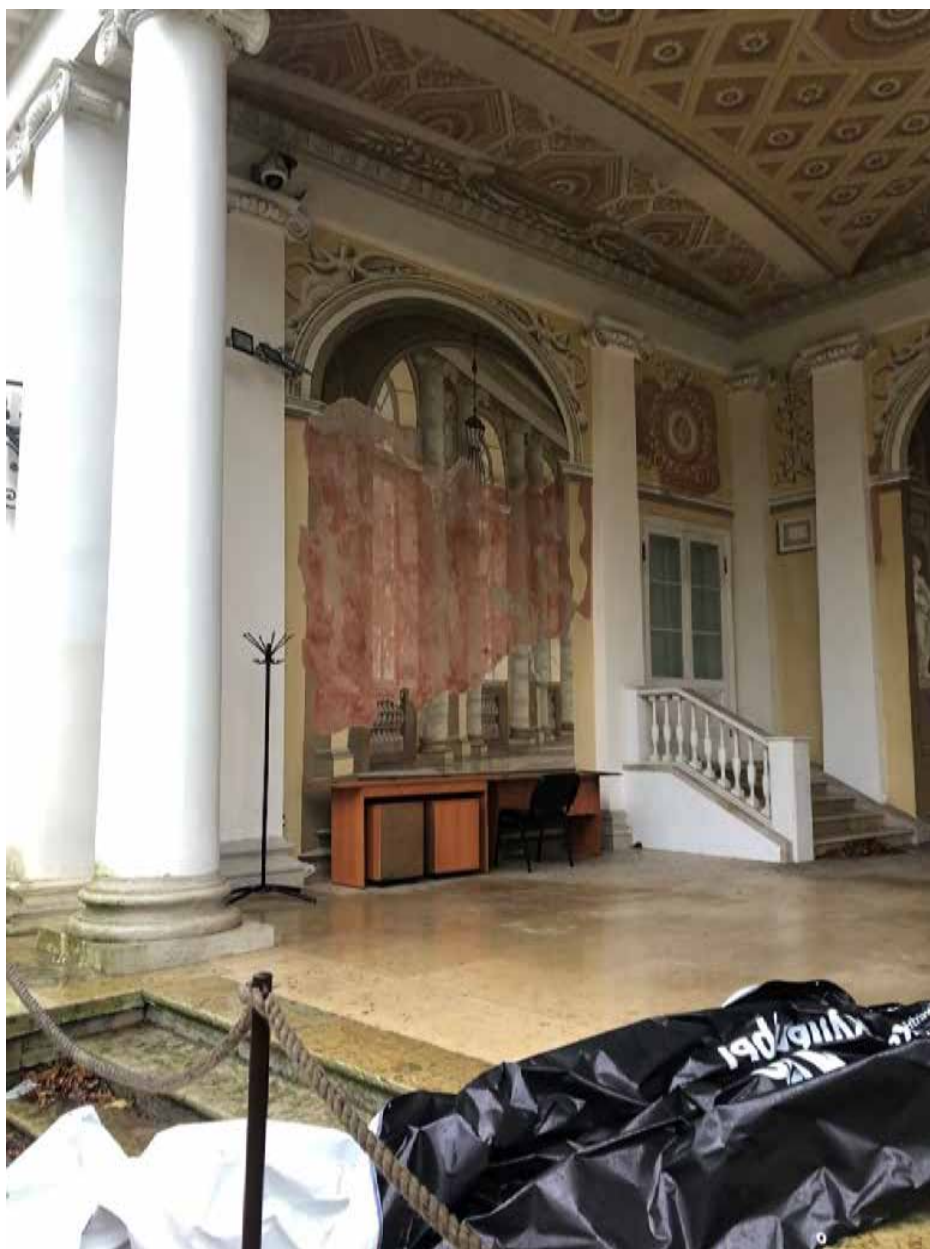
Фото 8. Вид на северную галерею в уровне 1-го этажа (западный фасад).
