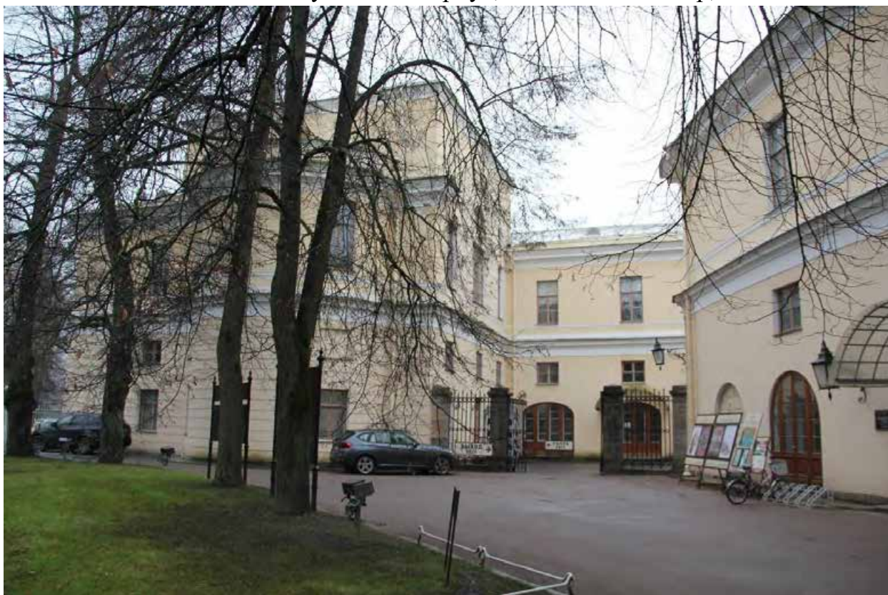
Фото 14. Вид на восточный фасад церковного флигеля.
