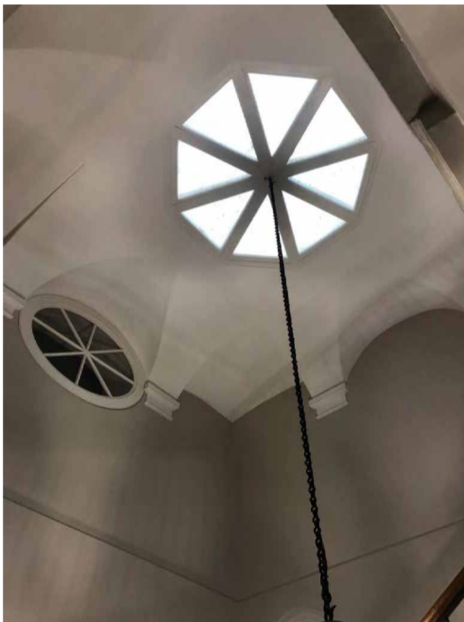
Фото 83. Вид на лестницу главного корпуса в уровне 3-го этажа.
