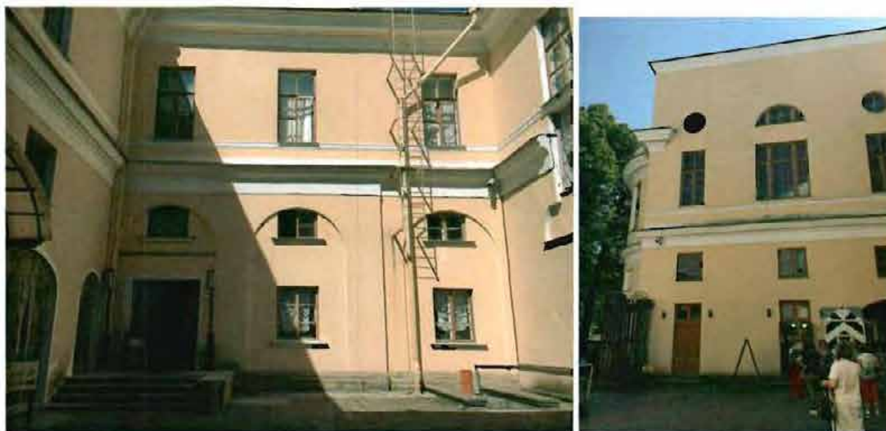
16, 17. Общий вид фасадов со стороны внутреннего двора.
