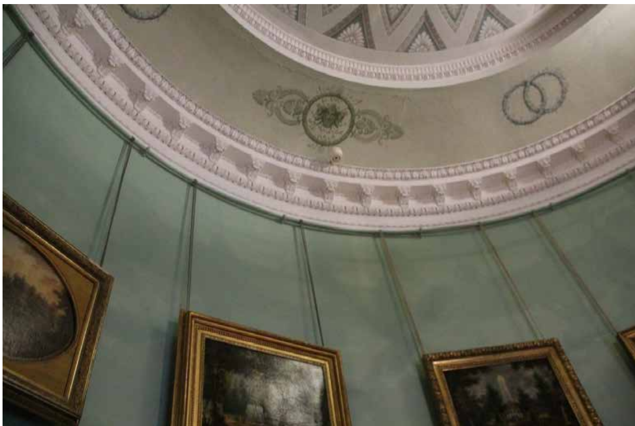
Фото 21. Интерьер внутренних помещений 1-го этажа южной галереи.
