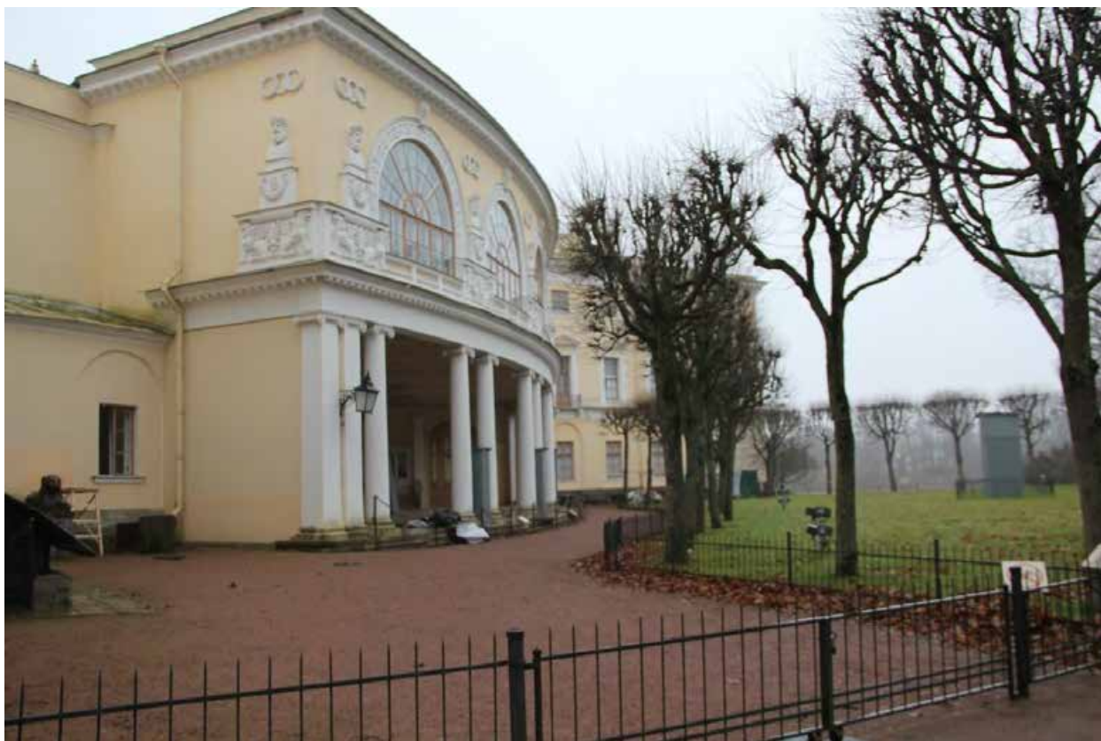
Фото 9. Вид на северную галерею (западный фасад) с севера.
