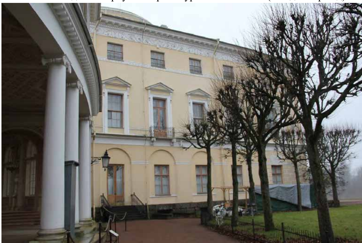
Фото 12. Вид на северный фасад главного корпуса.
