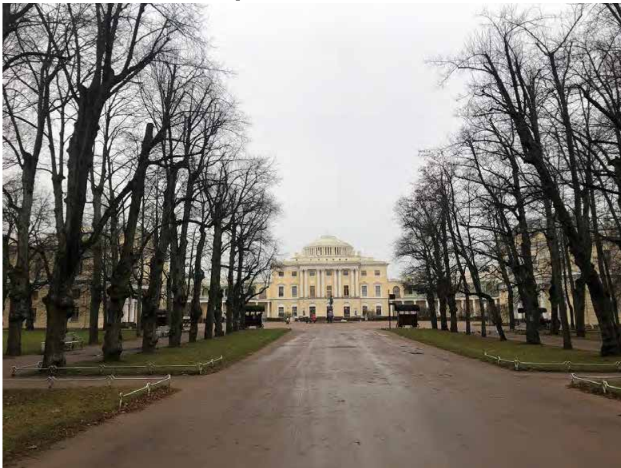
Фото 1. Общий вид объекта культурного наследия федерального значения «Дворец Павловский (Большой)».
