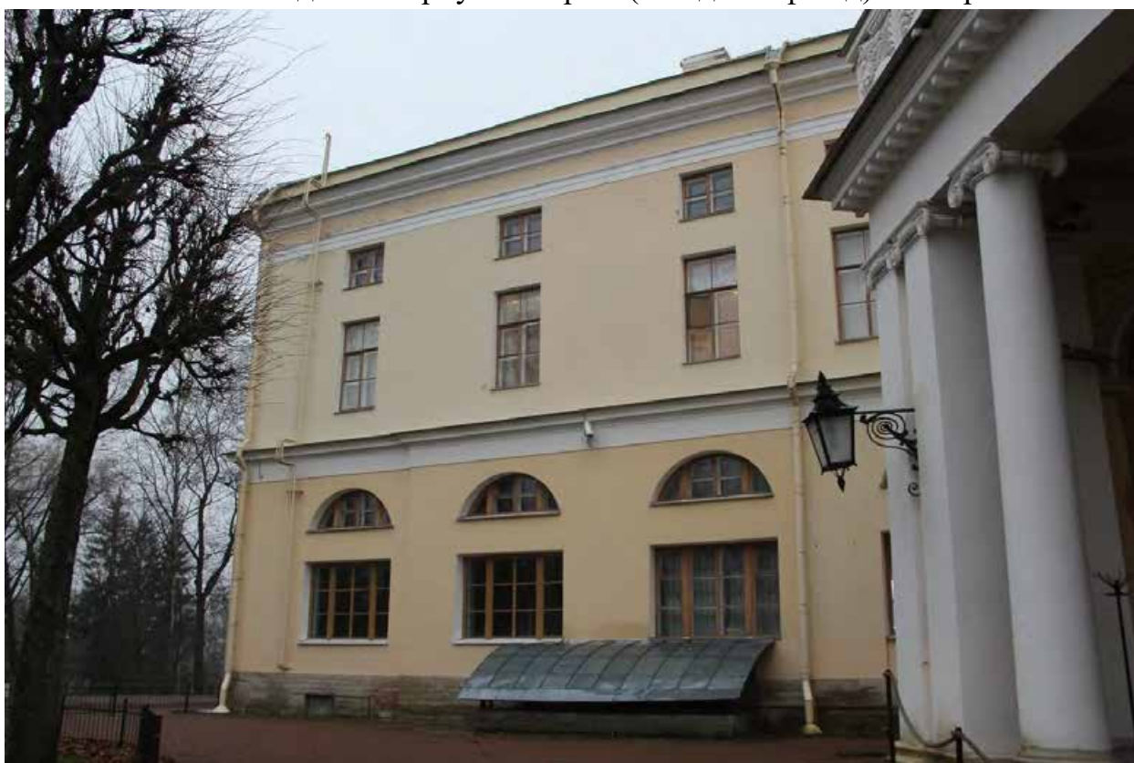
Фото 10. Вид на западный фасад северного бокового корпуса.
