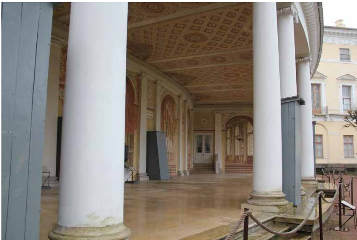
Фото 11. Вид на северную галерею в уровне 1-го этажа (западный фасад).
