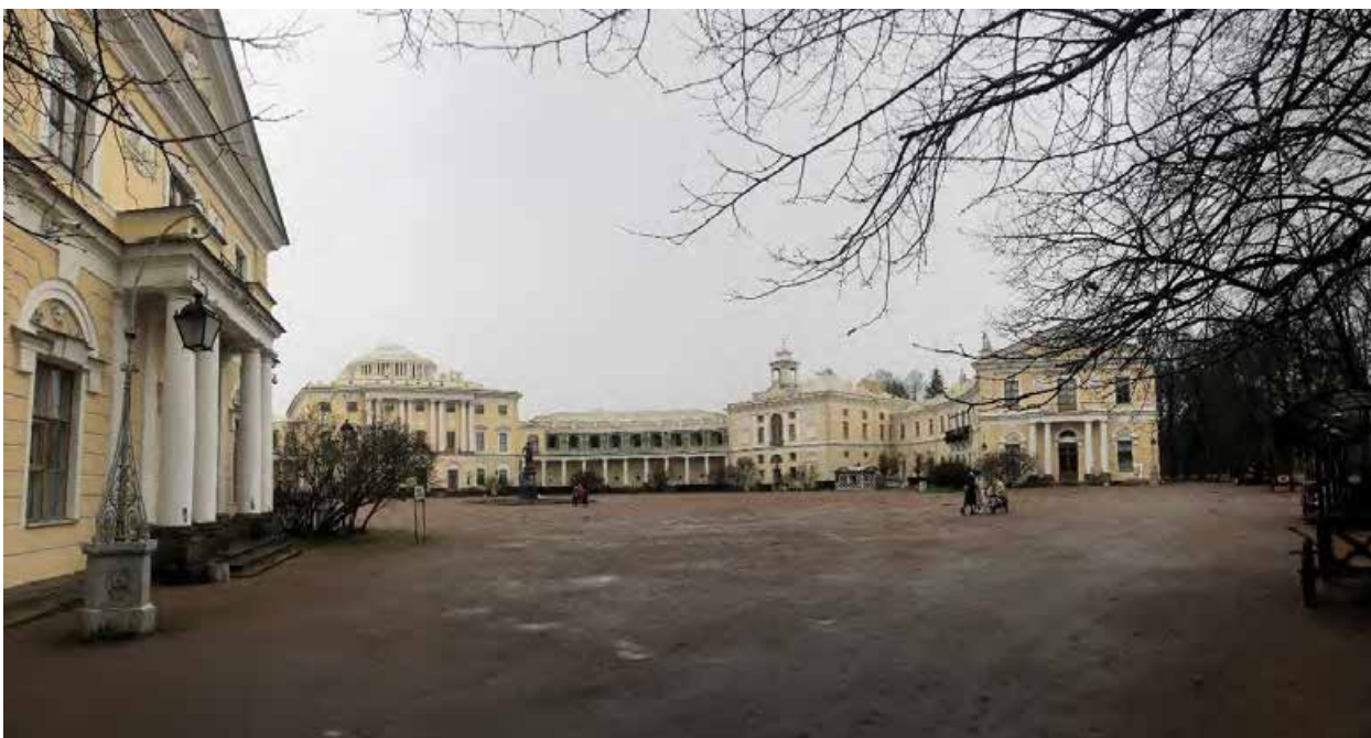
Фото 3. Вид на главный корпус, северную галерею, северный боковой корпус и северный служебный корпус, замыкающий двор, с юго-востока.
