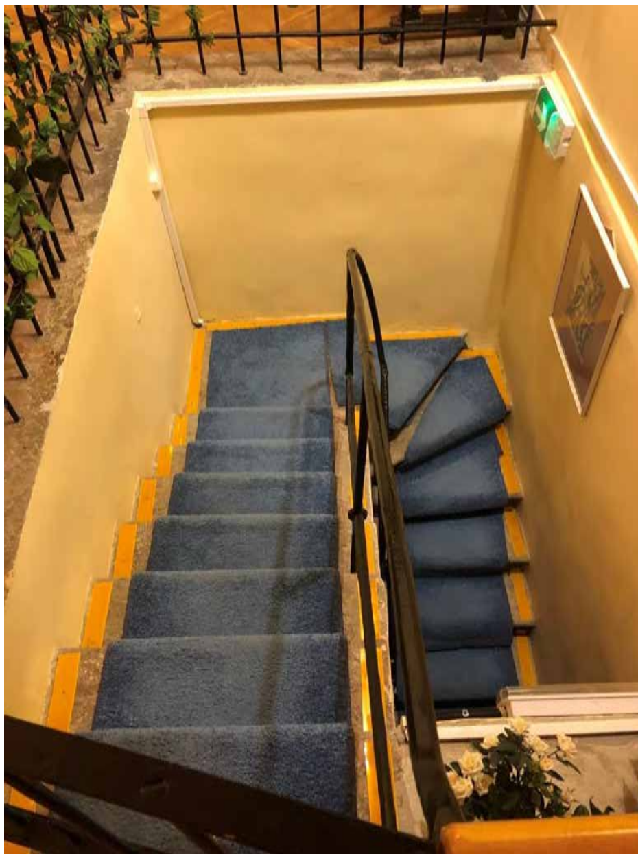
Фото 85. Вид на служебную лестницу главного корпуса в уровне 3-го этажа.
