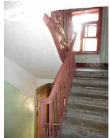
ступени: материал (лещадная плита), конфигурация; материал площадок (лещадная плита);
