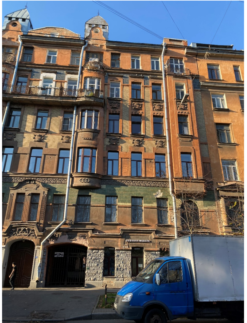
4. Объект культурного наследия регионального значения «Дом К.Г.Чубакова», по адресу: г. Санкт-Петербург, 11-я линия В.О., дом 58, литера А Вид с северо-востока Дата съемки: 01 октября 2021 г.
