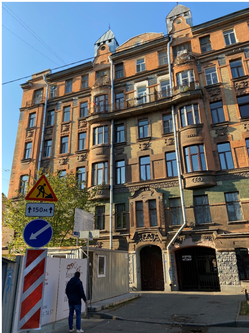
3. Объект культурного наследия регионального значения «Дом К.Г.Чубакова», по адресу: г. Санкт-Петербург, 11-я линия В.О., дом 58, литера А Вид с северо-востока Дата съемки: 01 октября 2021 г.
