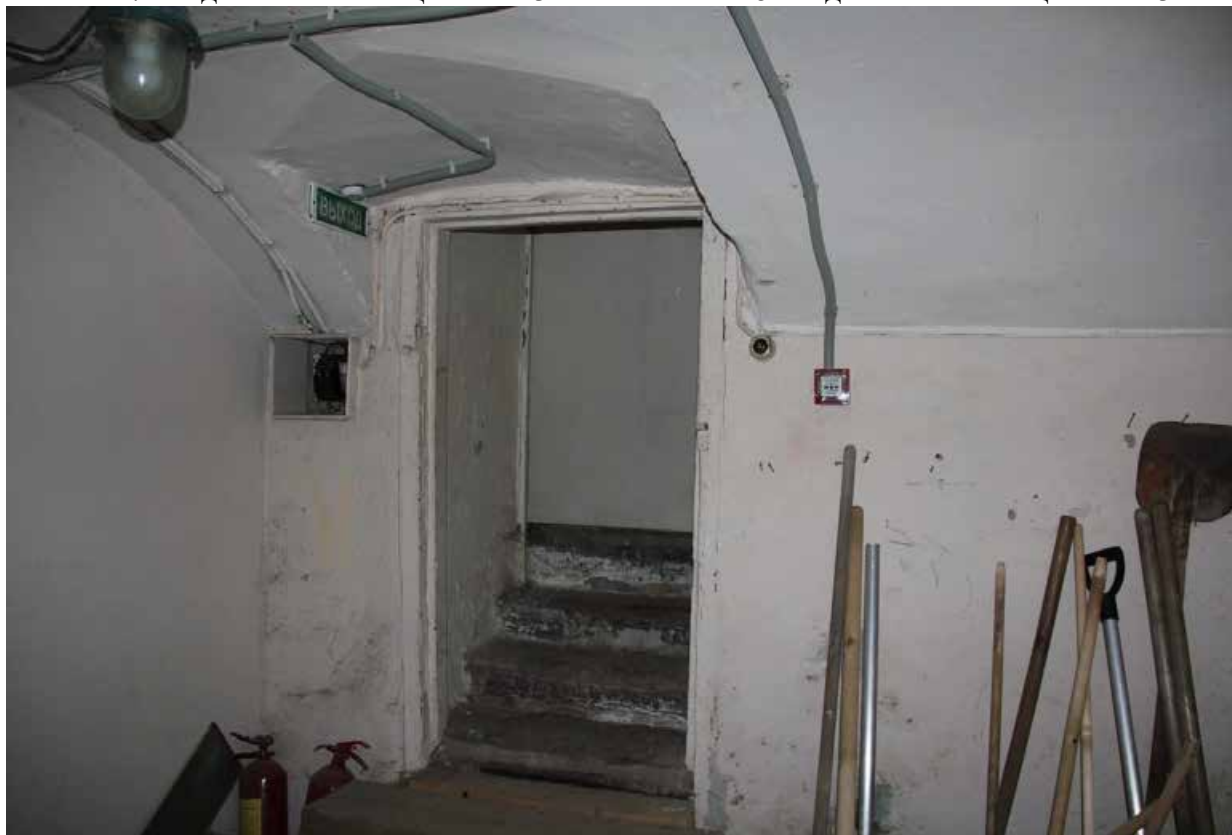
Фото 19. Вид на вход в подвал со стороны улицы.
