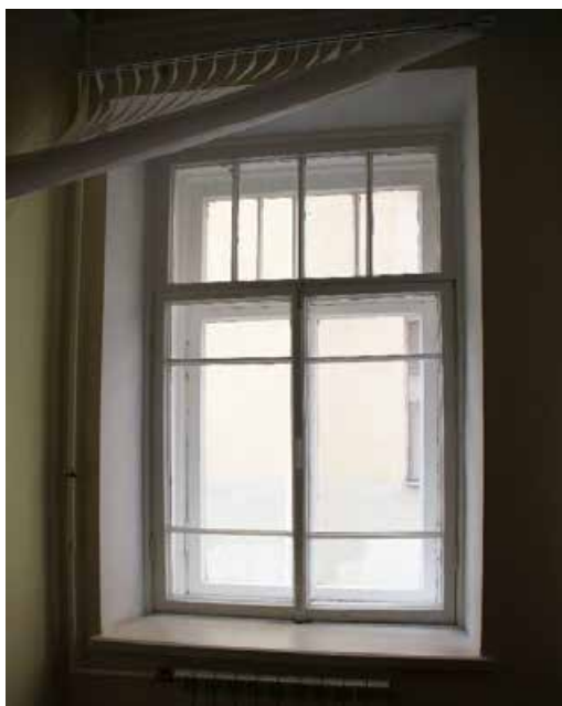
Фото 26. Заполнение оконного проема в помещении № 62.
