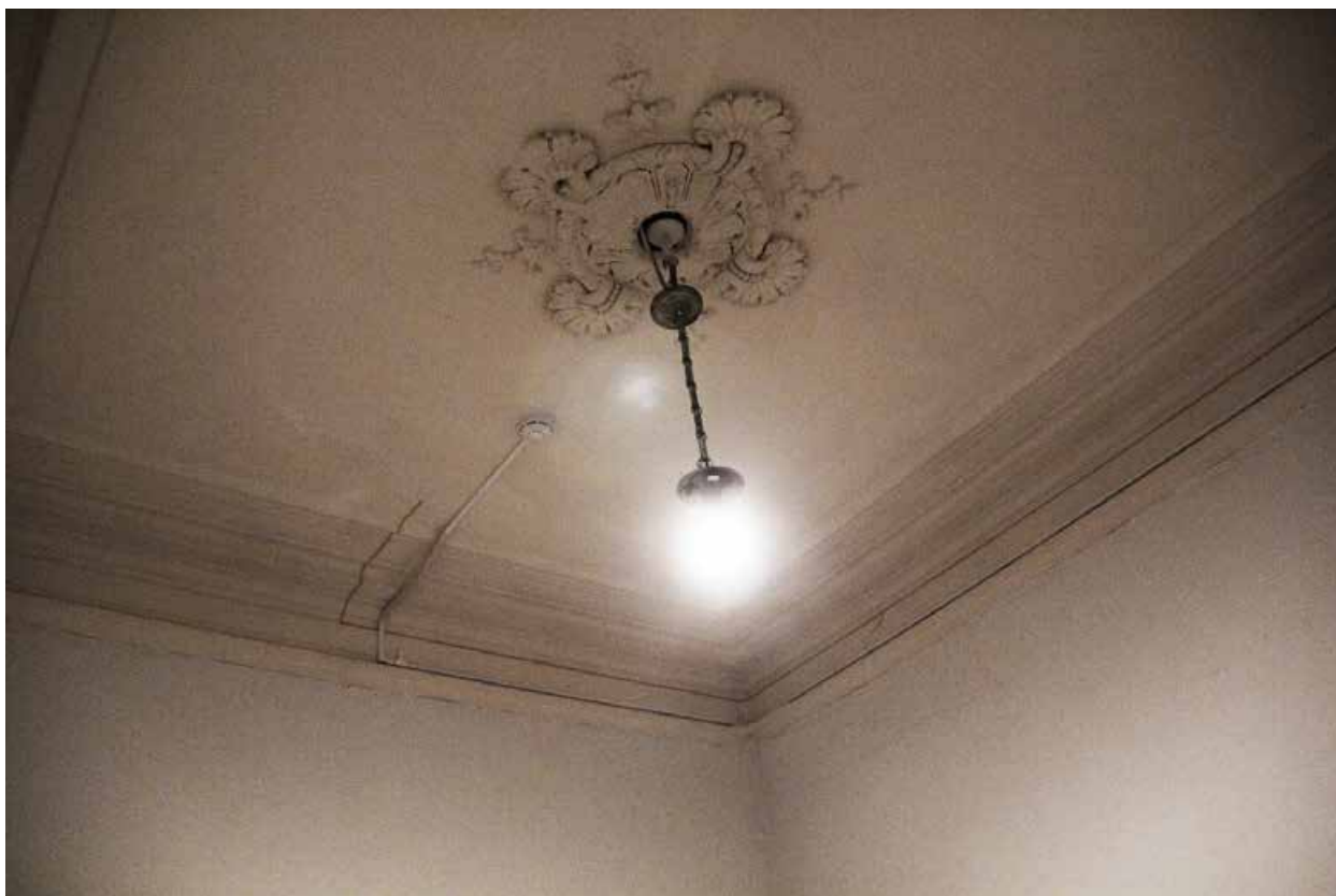
Фото 14. Оформление потолка в помещении № 55.
