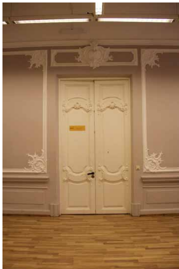
Фото 106. Заполнение дверного проема в помещении № 100.
