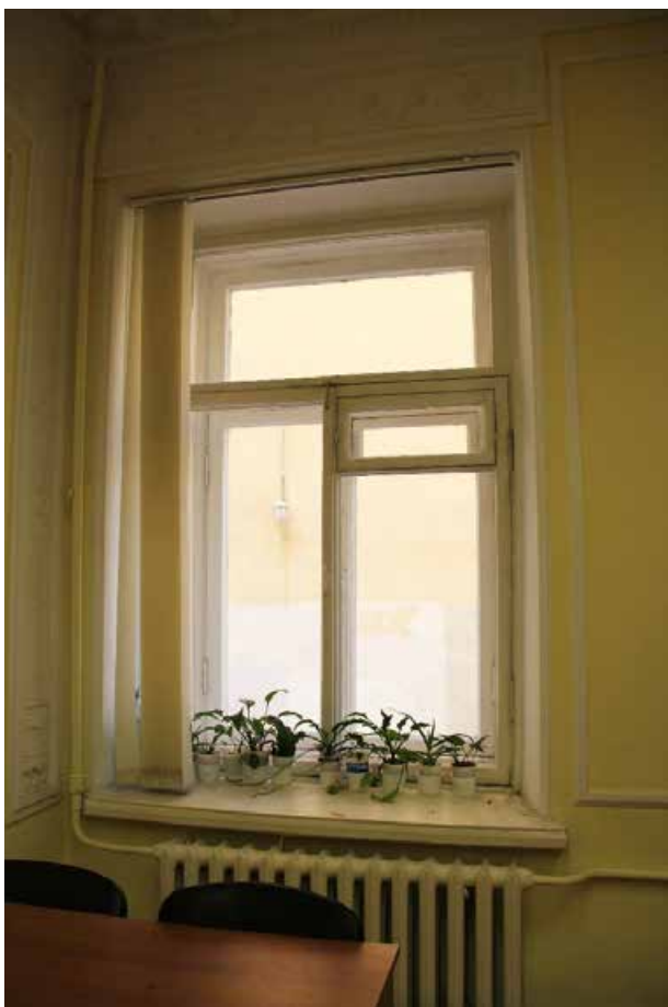
Фото 39. Заполнение оконного проема.
