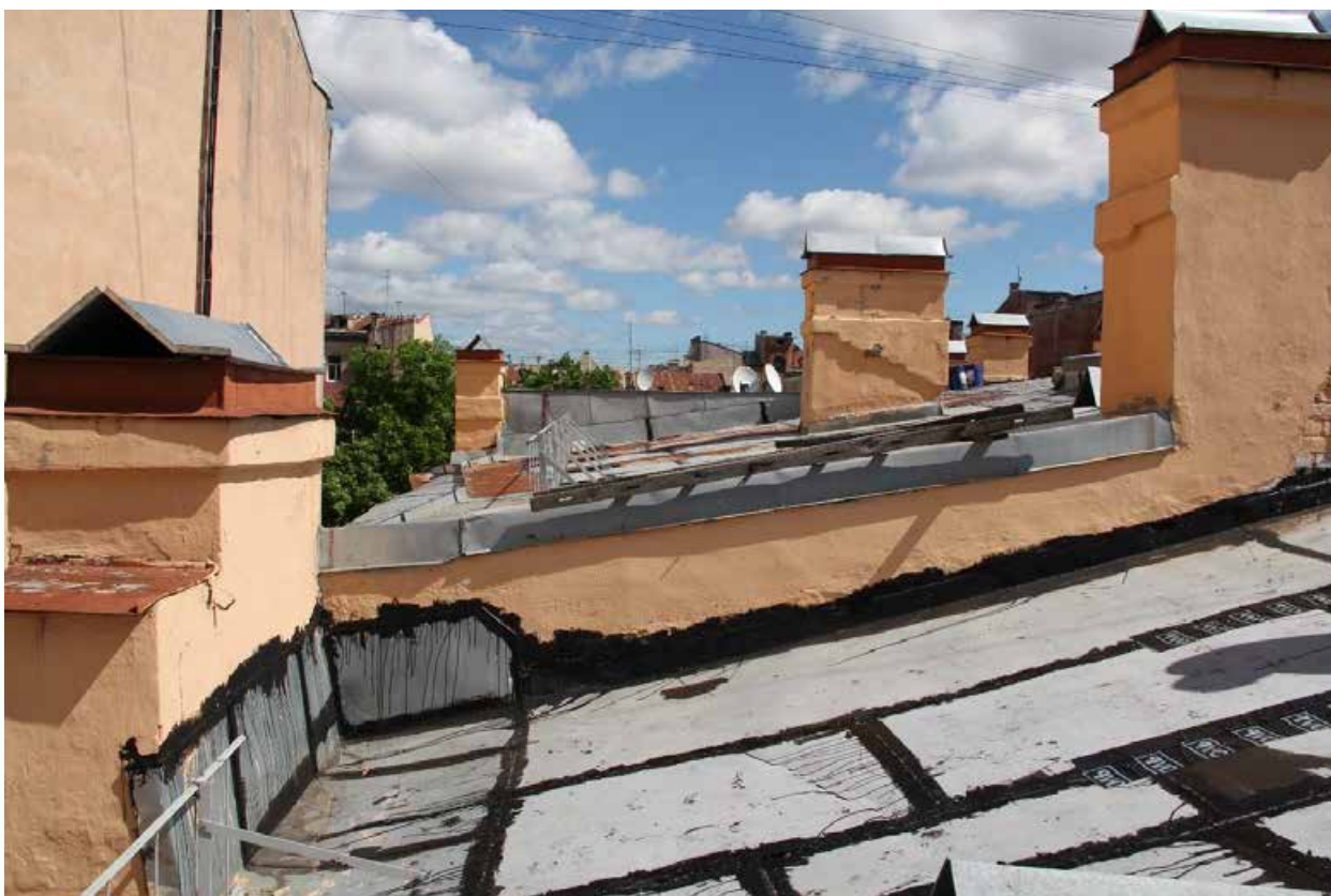
Фото 10. Вид на северо-западную часть крыши.
