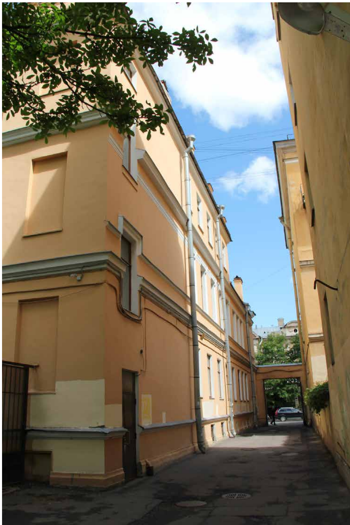
Фото 3. Вид на торцевой юго-восточный фасад.
