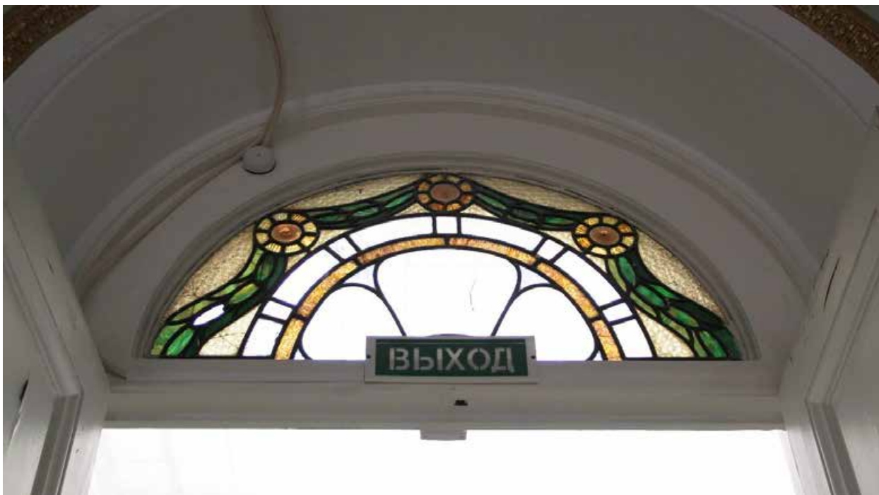
Фото 100. Витраж во фрамуге дверного проема помещения № 98.
