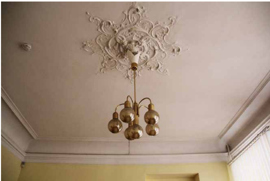
Фото 25. Оформление потолка в помещении № 62.
