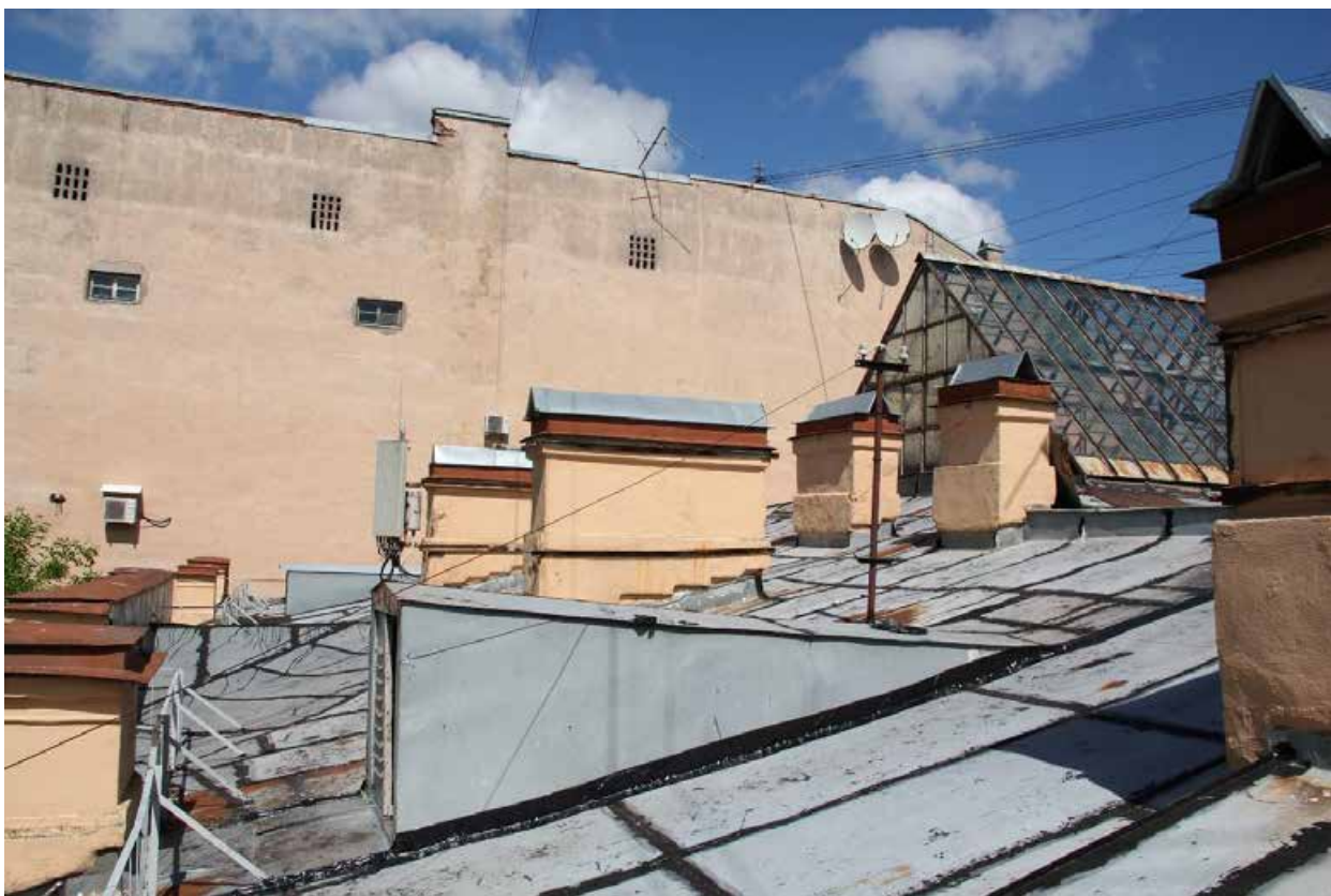
Фото 3. Вид на северо-западную часть крыши.
