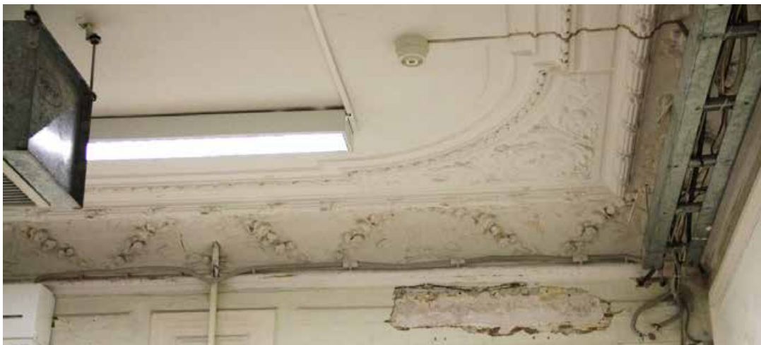
Фото 74. Оформление потолка в помещении № 89.
