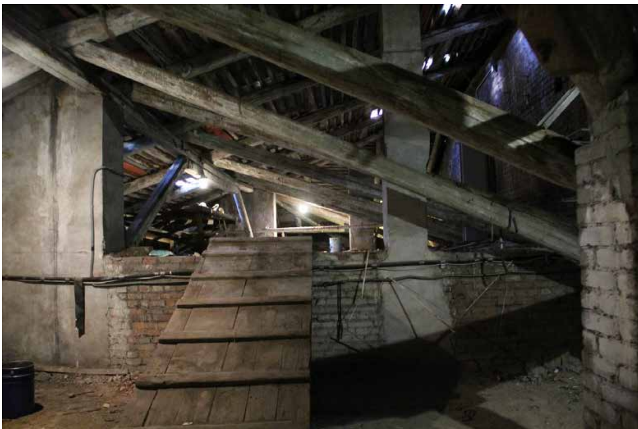
Фото 1. Северо-восточная часть чердачного помещения.
