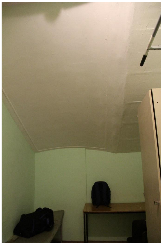
Фото 9. Помещение под лестницей.
