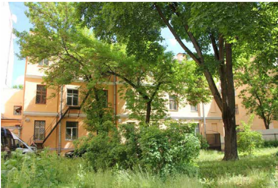
Фото 6. Вид на дворовый юго-западный фасад с западной стороны двора.
