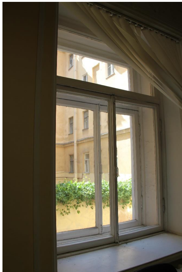
Фото 45. Заполнение оконного проема в библиотеке.
