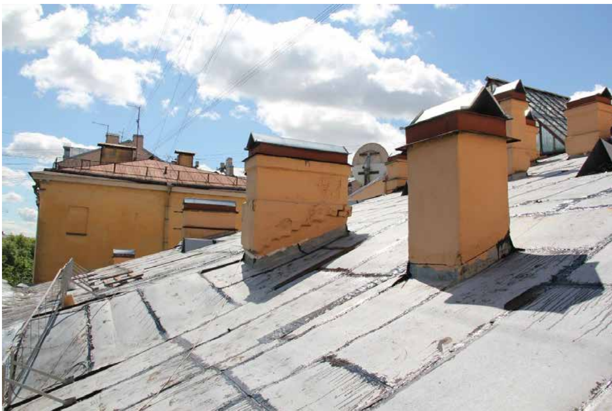
Фото 7. Вид на юго-восточную часть крыши.
