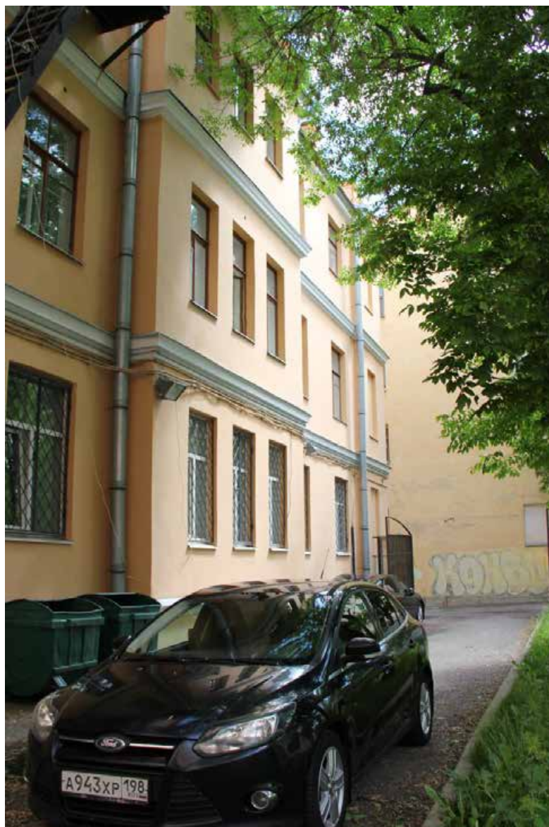
Фото 7. Вид на дворовый юго-западный фасад.
