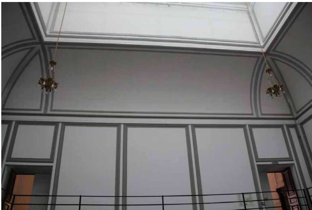
Фото 136. Атриумный зал в уровне второго этажа.
