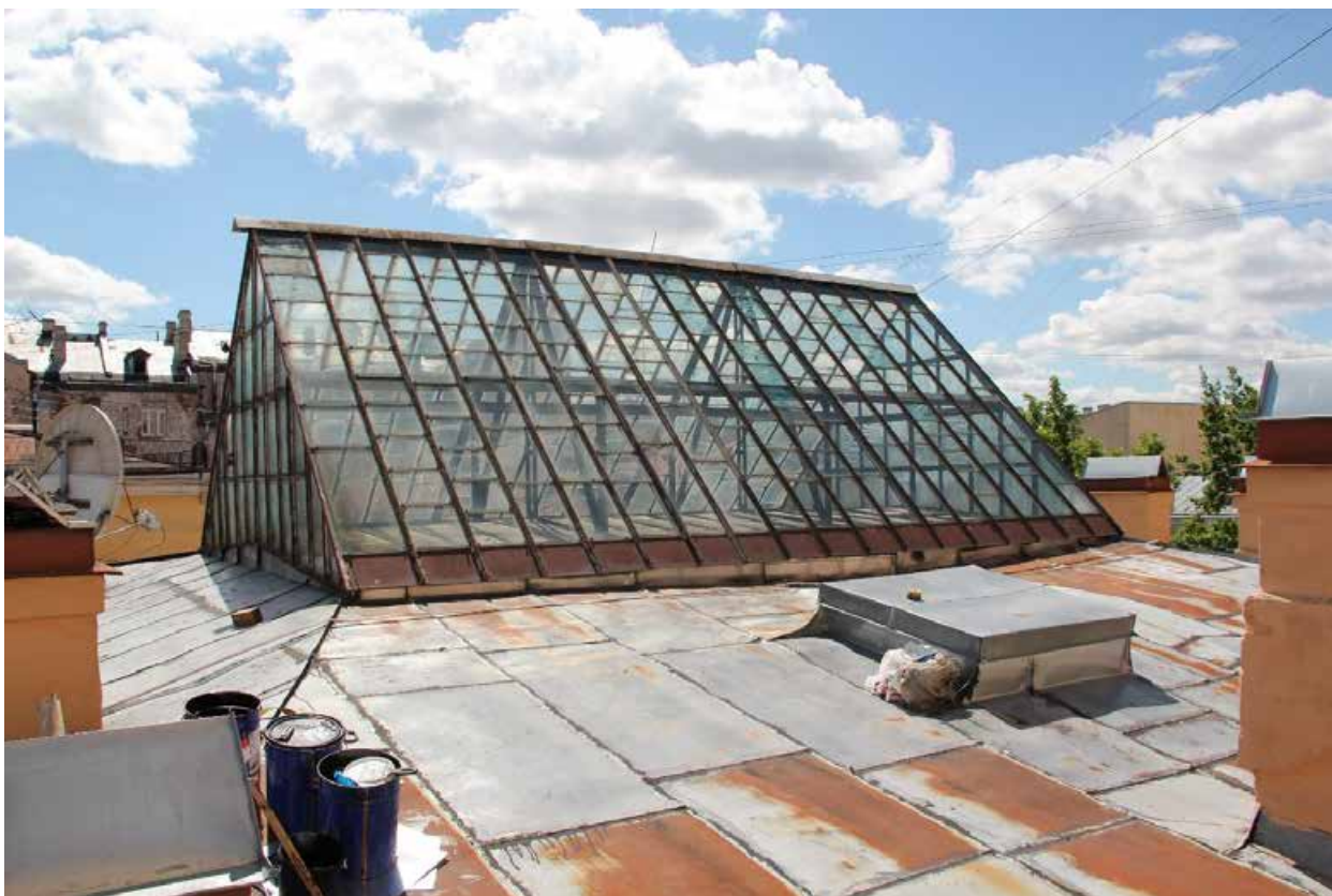
Фото 9. Вид на световой фонарь с северной стороны.
