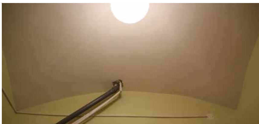
Фото 27. Перекрытие потолка в санузле.
