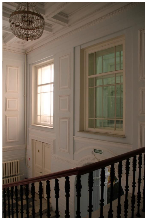
Фото 82. Помещение парадной лестницы.
