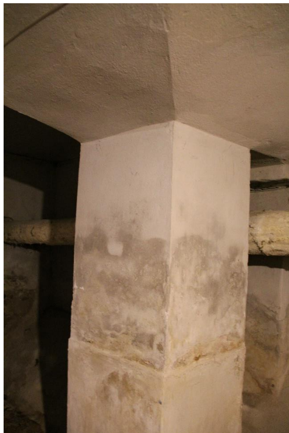
Фото 11. Пилон в помещении № 23.
