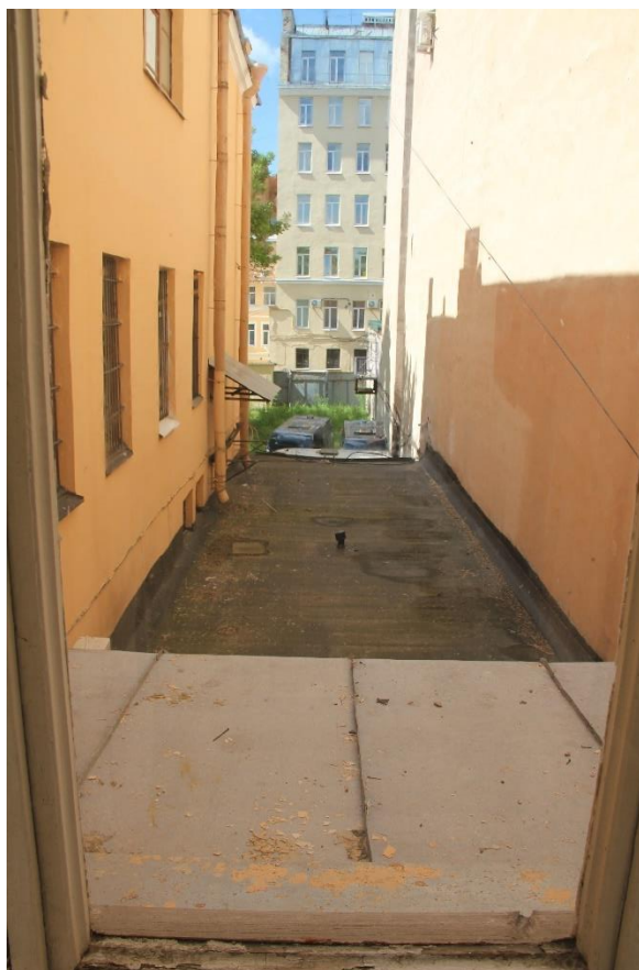
Фото 87. Вид из окна служебной лестницы во двор.
