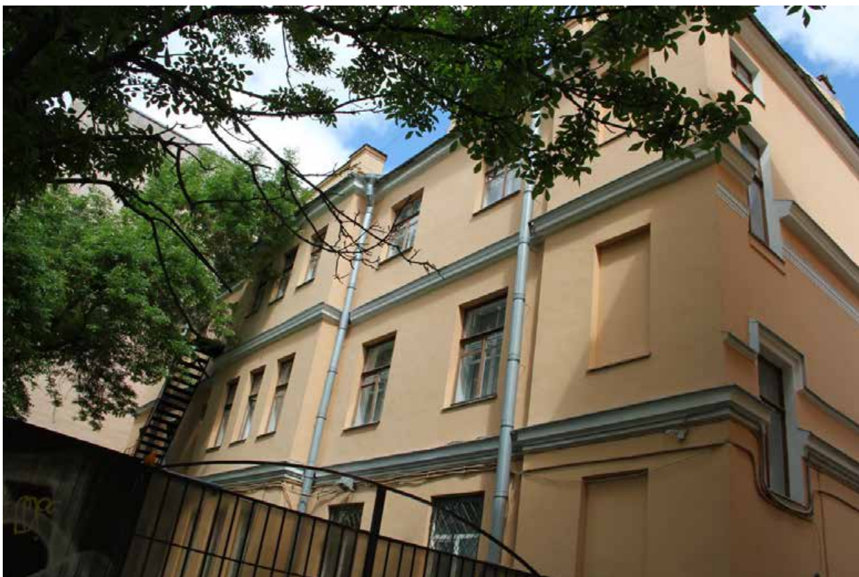
Фото 4. Вид на дворовый юго-западный фасад с проезда.
