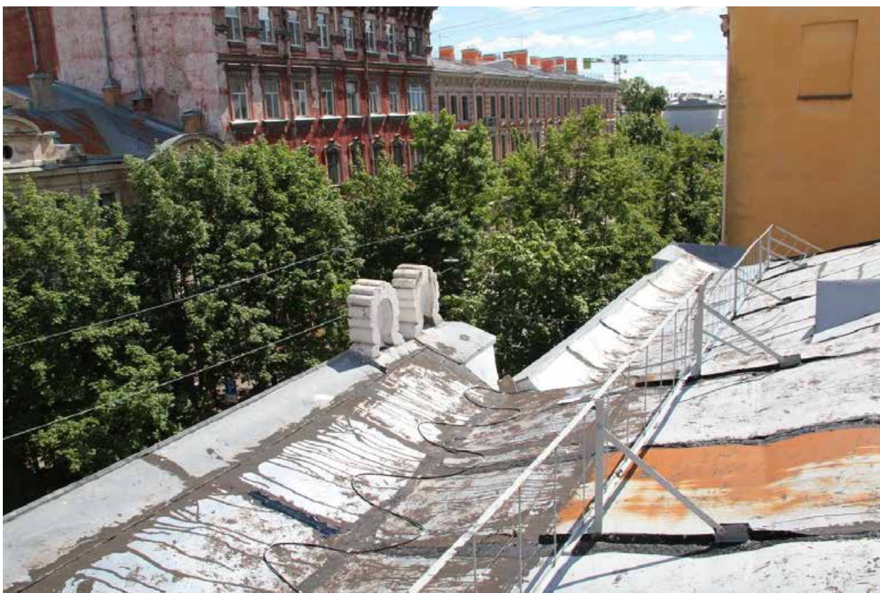
Фото 6. Вид на фрагмент аттика со стороны лицевого фасада.
