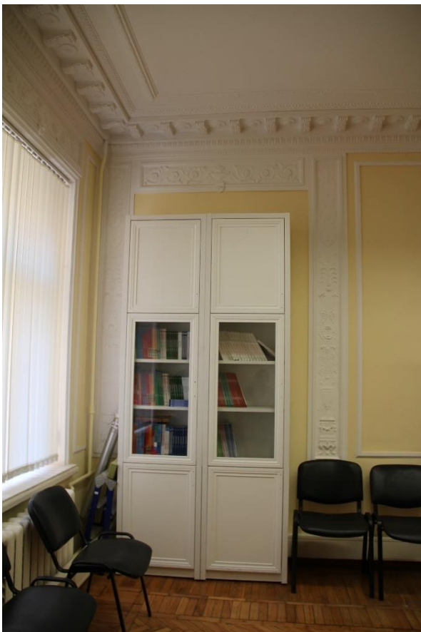
Фото 44. Оформление стен и потолка.
