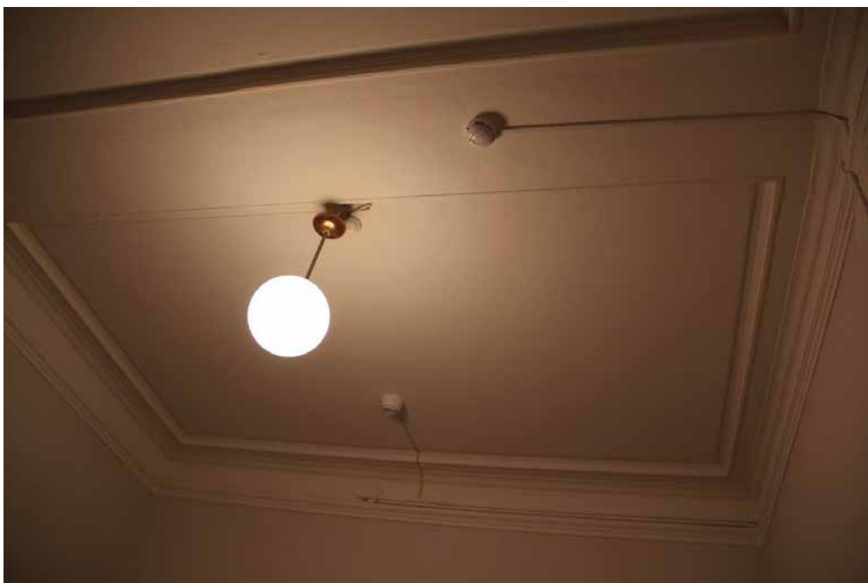
Фото 15. Оформление потолка в помещении № 56.
