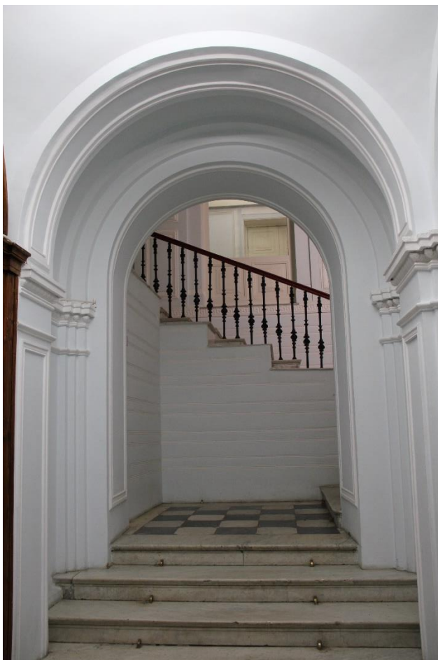
Фото 76. Вид на парадную лестницу из вестибюля.
