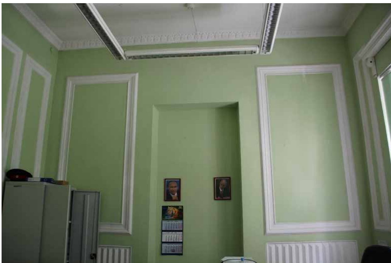
Фото 96. Оформление стен и потолка в помещении № 95.
