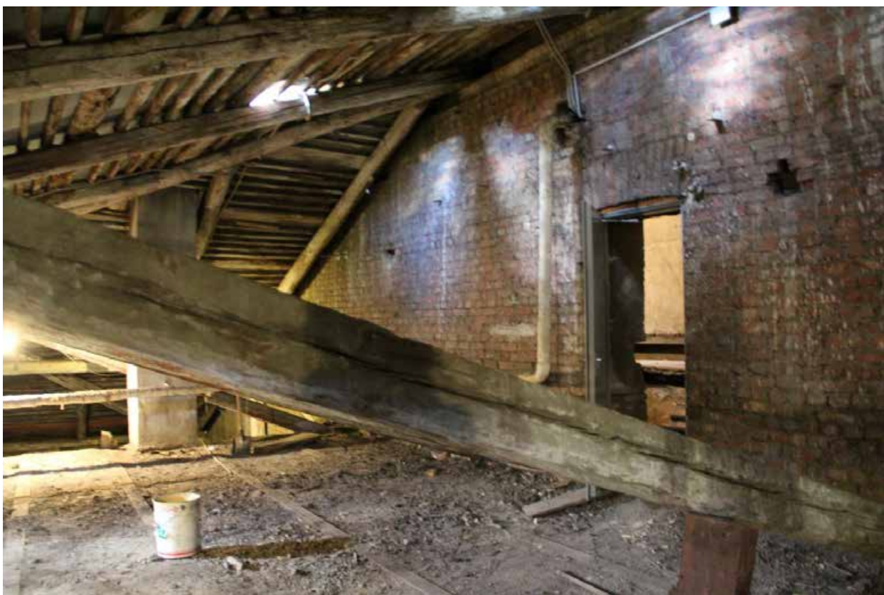
Фото 2. Северо-восточная часть чердачного помещения.
