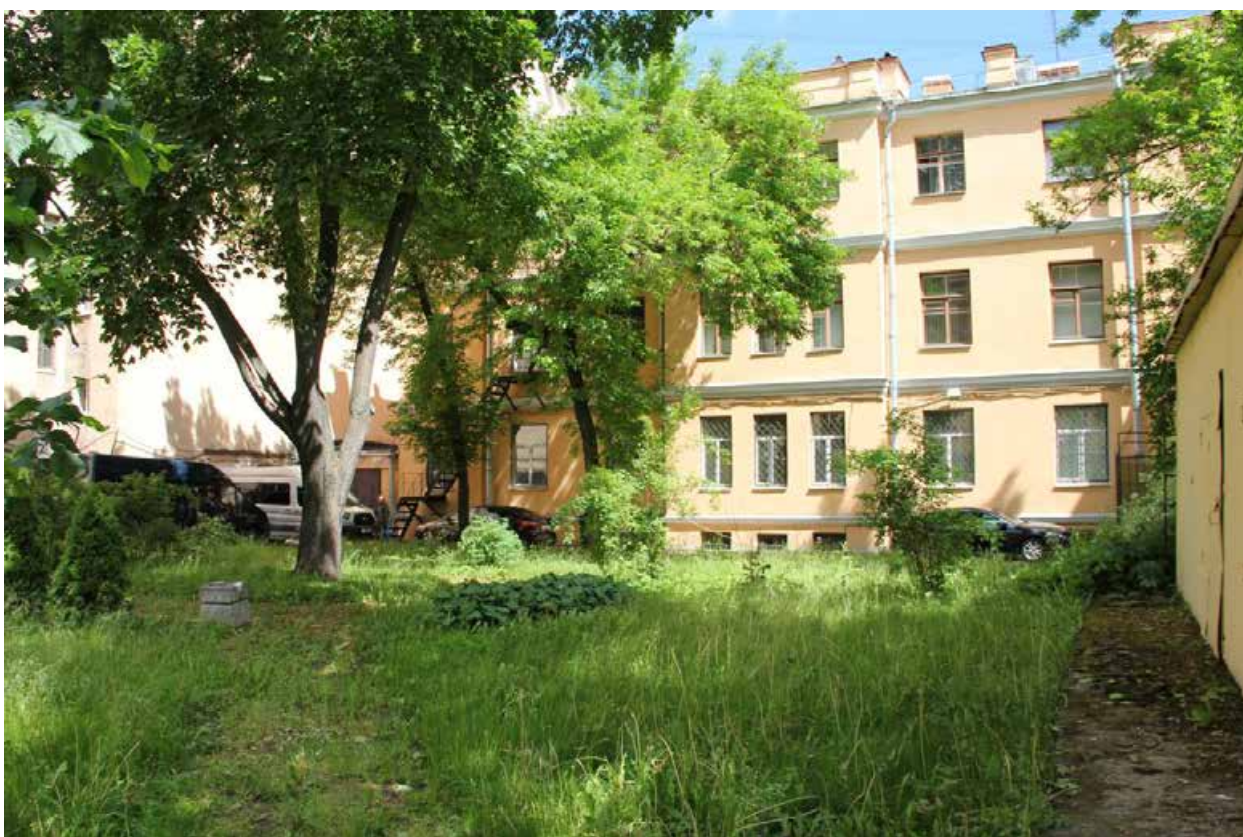
Фото 5. Вид на дворовый юго-западный фасад с южной стороны двора.
