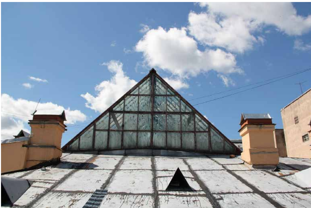
Фото 5. Фронтальный вид на световой фонарь с востока.
