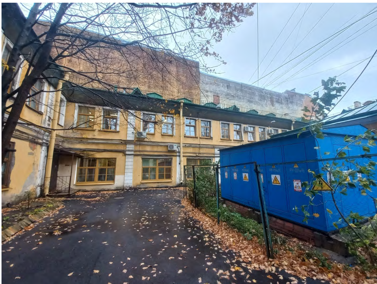
Фото 15. Фрагмент юго-восточного фасада (лит. А).
