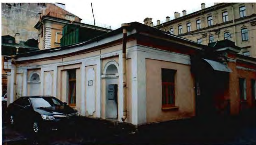
2. Общий вид на объект культурного наследия (литера Б).
