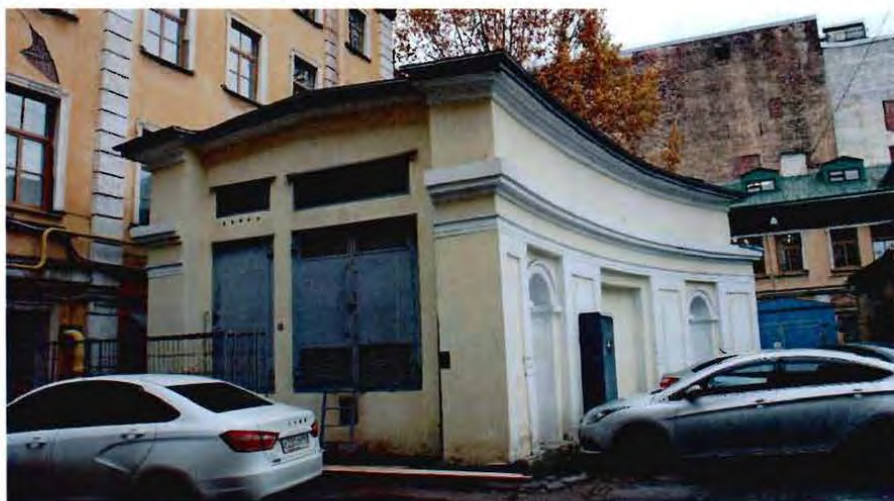
4. Общий вид на объект культурного наследия (здание, расположенное в восточной части двора).
