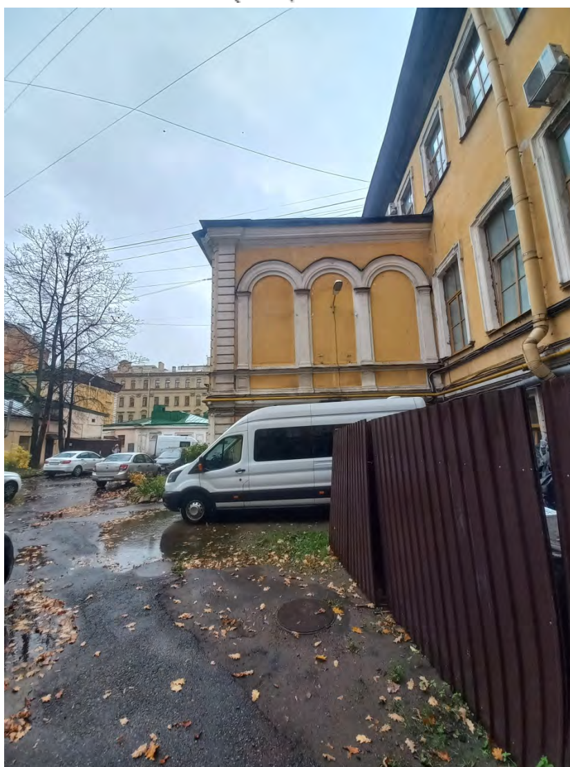
Фото 12. Двухэтажная часть (вестибюль) основного здания лит. А. Боковой фасад.
