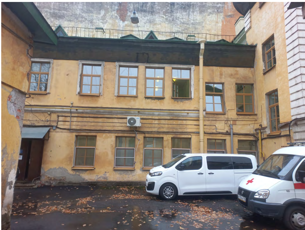
Фото 19. Фрагмент юго-восточного фасада (лит. А).
