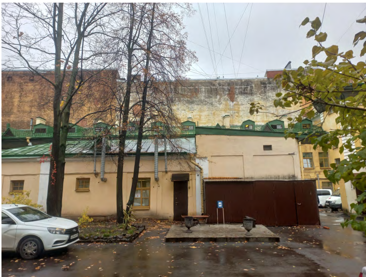
Фото 23. Служебное здание лит. В. Северо-западный фасад.
