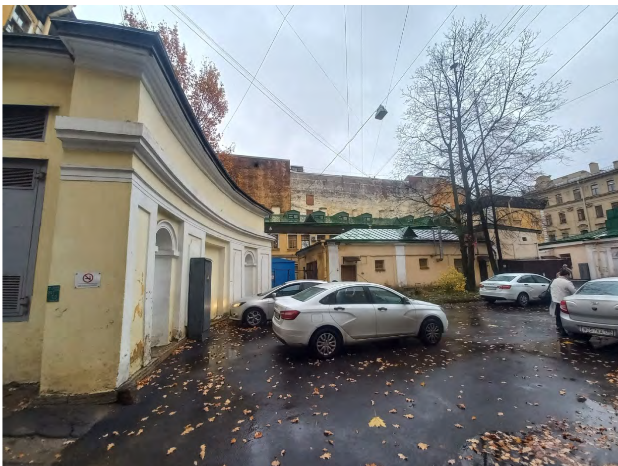
Фото 14. Общий вид двора. Восточная часть. Трансформаторная подстанция на территории.
