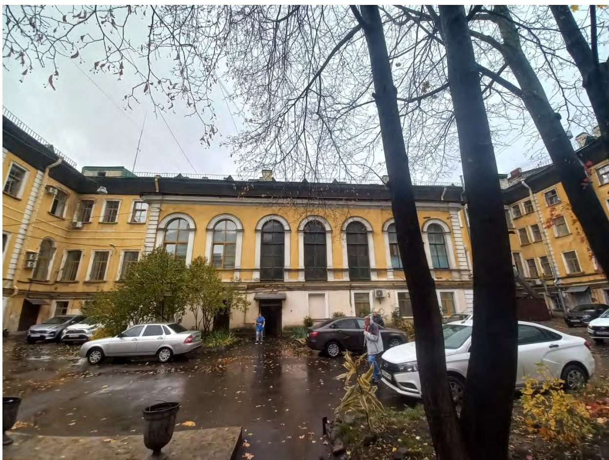
Фото 10. Двухэтажная часть (вестибюль) основного здания лит. А.
