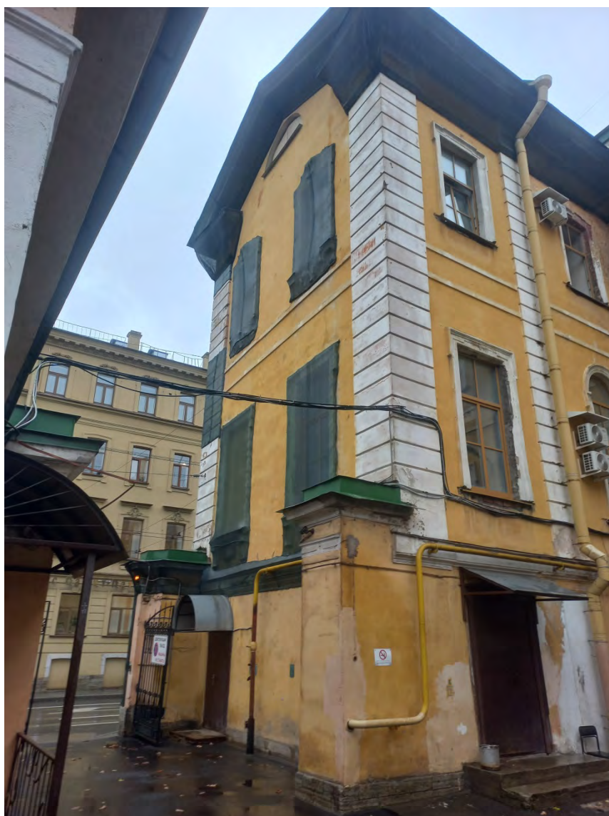
Фото 6. Торцевой фасад и фрагмент дворового.
