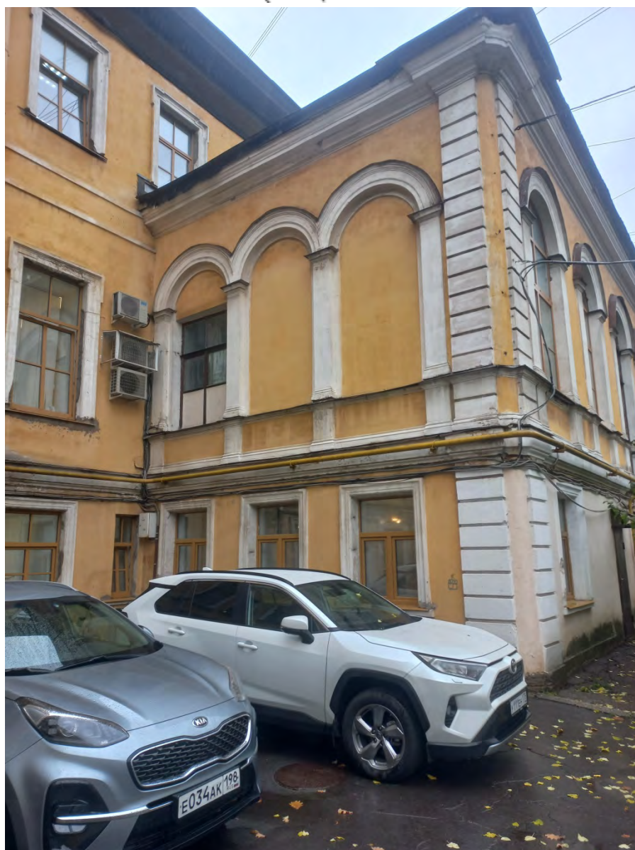
Фото 7. Дворовый фасад. Двухэтажная часть (вестибюль) основного здания лит. А.
