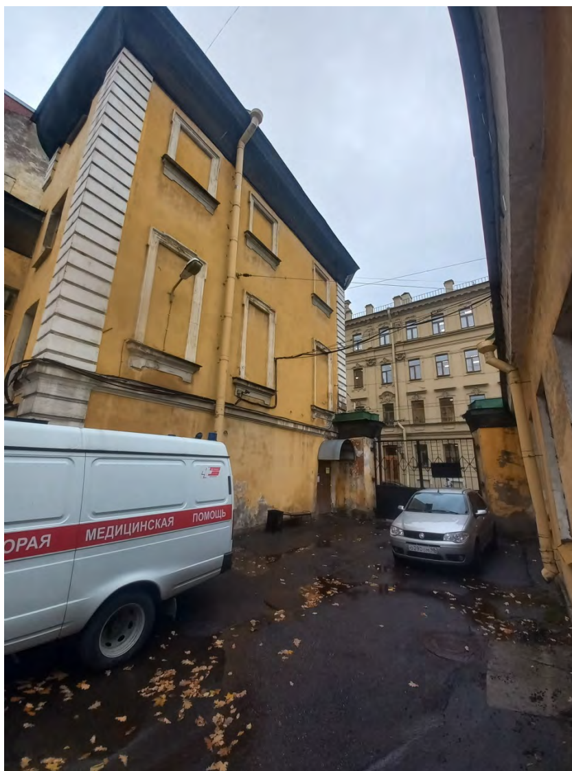
Фото 21. Торцевой фасад флигеля по ул. Гороховая (лит. А). Въездные ворота во двор.
