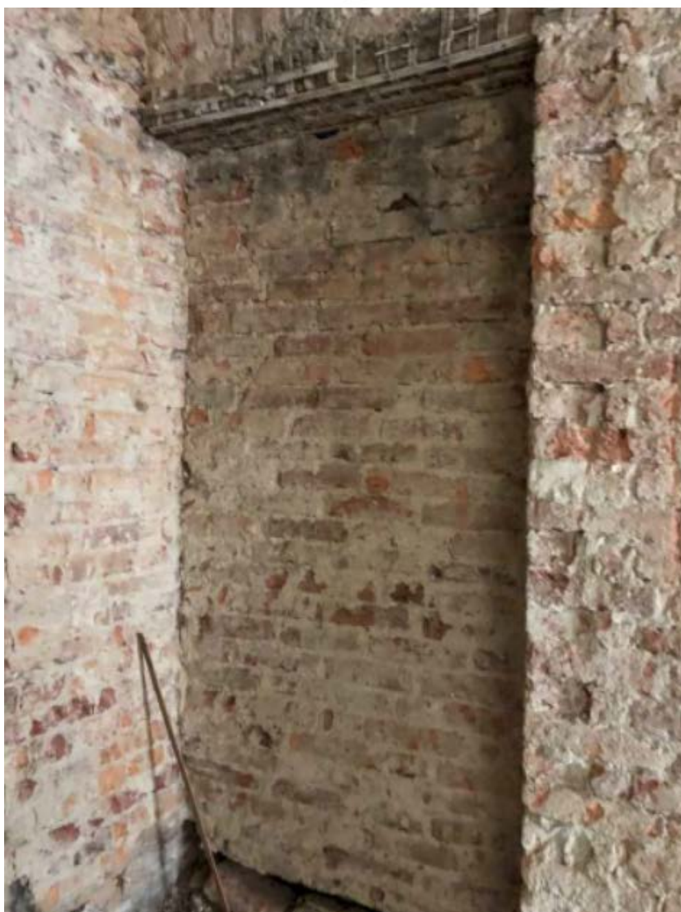
12. Помещение №6 кв. №18 в уровне 2-го этажа объекта культурного наследия регионального значения «Дом Г. Радинга (А.Ф. Пистолькорс)», расположенного по адресу: г. Санкт-Петербург, Галерная ул., д 50, литера А. 16.05.2022
