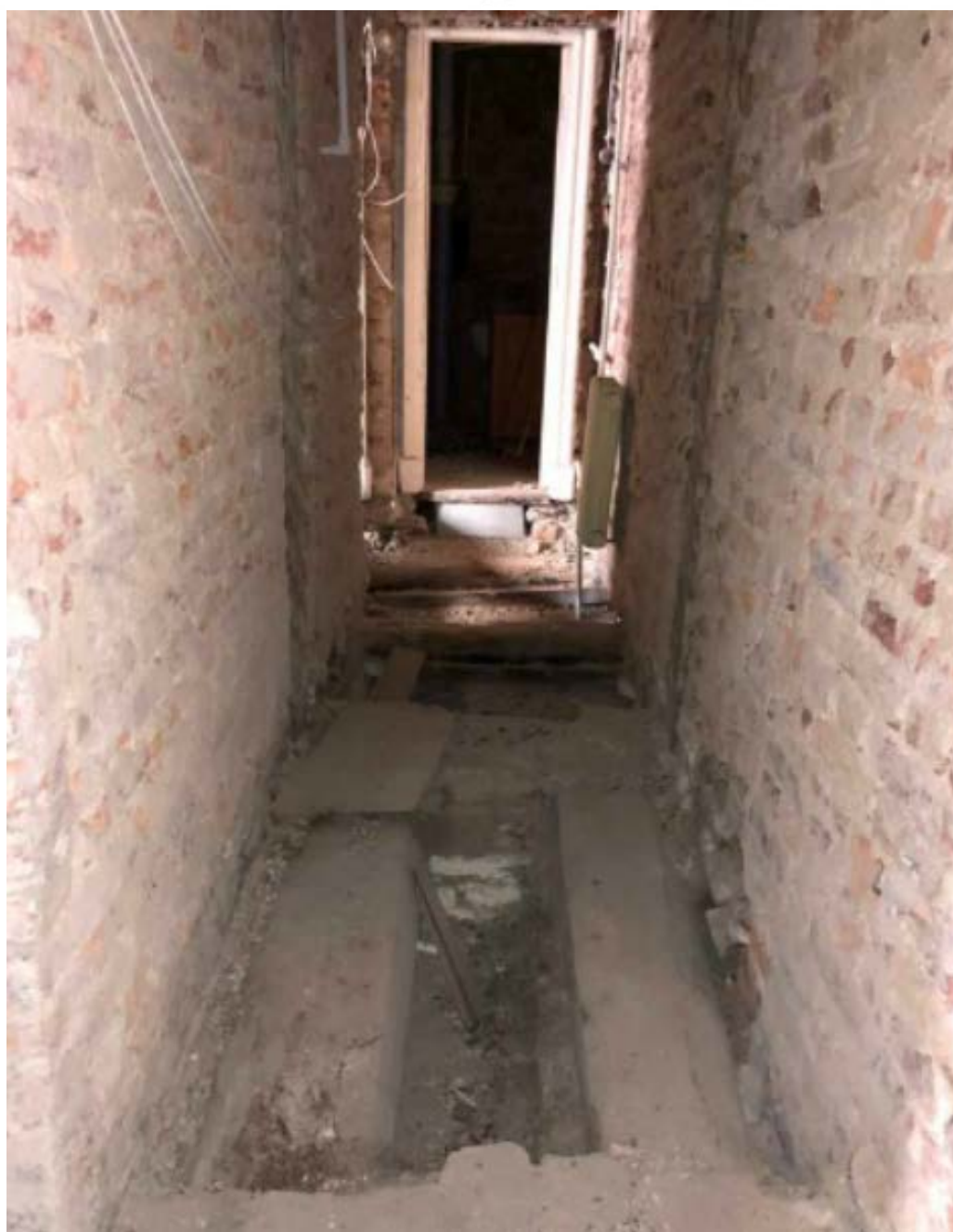
8. Помещение №7 кв. №18 в уровне 2-го этажа объекта культурного наследия регионального значения «Дом Г. Радинга (А.Ф. Пистолькорс)», расположенного по адресу: г. Санкт-Петербург, Галерная ул., д 50, литера А. 16.05.2022
