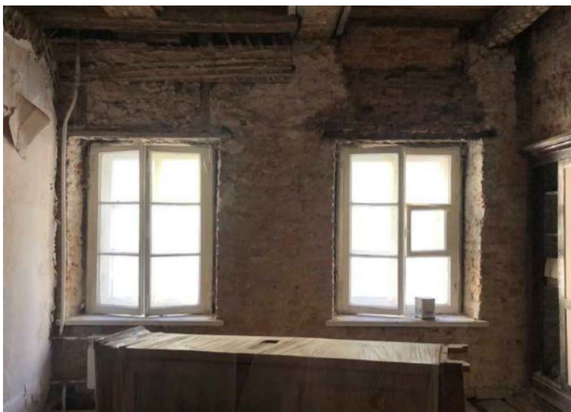
10. Помещение №5 кв. №18 в уровне 2-го этажа объекта культурного наследия регионального значения «Дом Г. Радинга (А.Ф. Пистолькорс)», расположенного по адресу: г. Санкт-Петербург, Галерная ул., д 50, литера А. 16.05.2022
