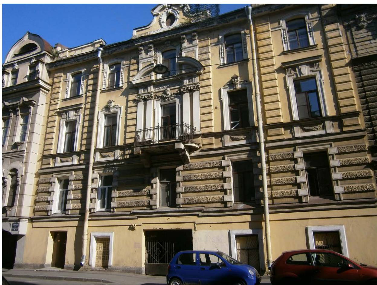
1. Лицевой юго-западный фасад объекта культурного наследия регионального значения «Дом Г. Радинга (А.Ф. Пистолькорс)», расположенного по адресу: г. Санкт-Петербург, Галерная ул., д 50, литера А. 16.05.2022
