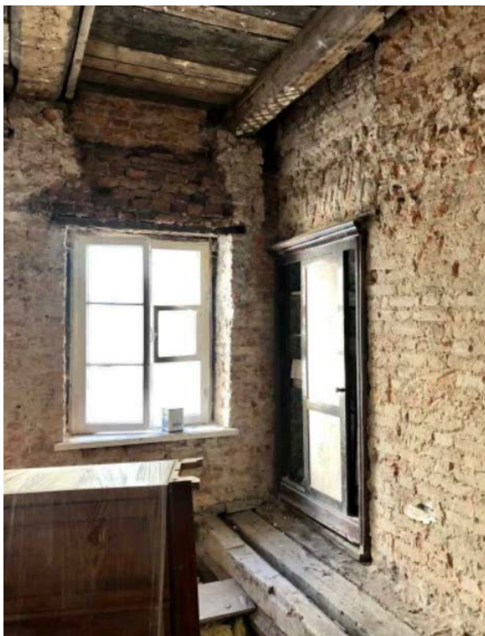
9. Помещение №5 кв. №18 в уровне 2-го этажа объекта культурного наследия регионального значения «Дом Г. Радинга (А.Ф. Пистолькорс)», расположенного по адресу: г. Санкт-Петербург, Галерная ул., д 50, литера А. 16.05.2022
