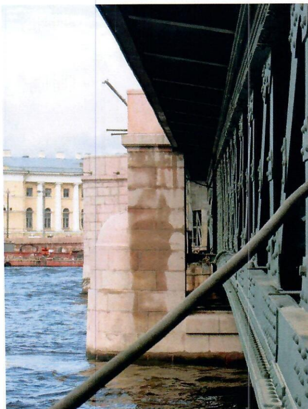
44. Вид на низовую сторону (фото слева) и верховую сторону (фото справа) опоры 2. Опоры 2 и 5 – массивные, бутобетонные, облицованные гранитными блоками, фундаменты – кессоны, заполненные бетоном.
