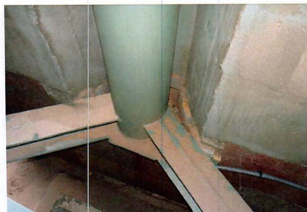
40. Виды на стойку под опору освещения на опоре 2.
