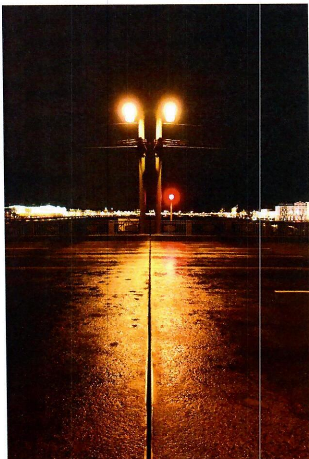
34. Вид на деформационный шов (зазор) в замке разводного пролетного строения.
