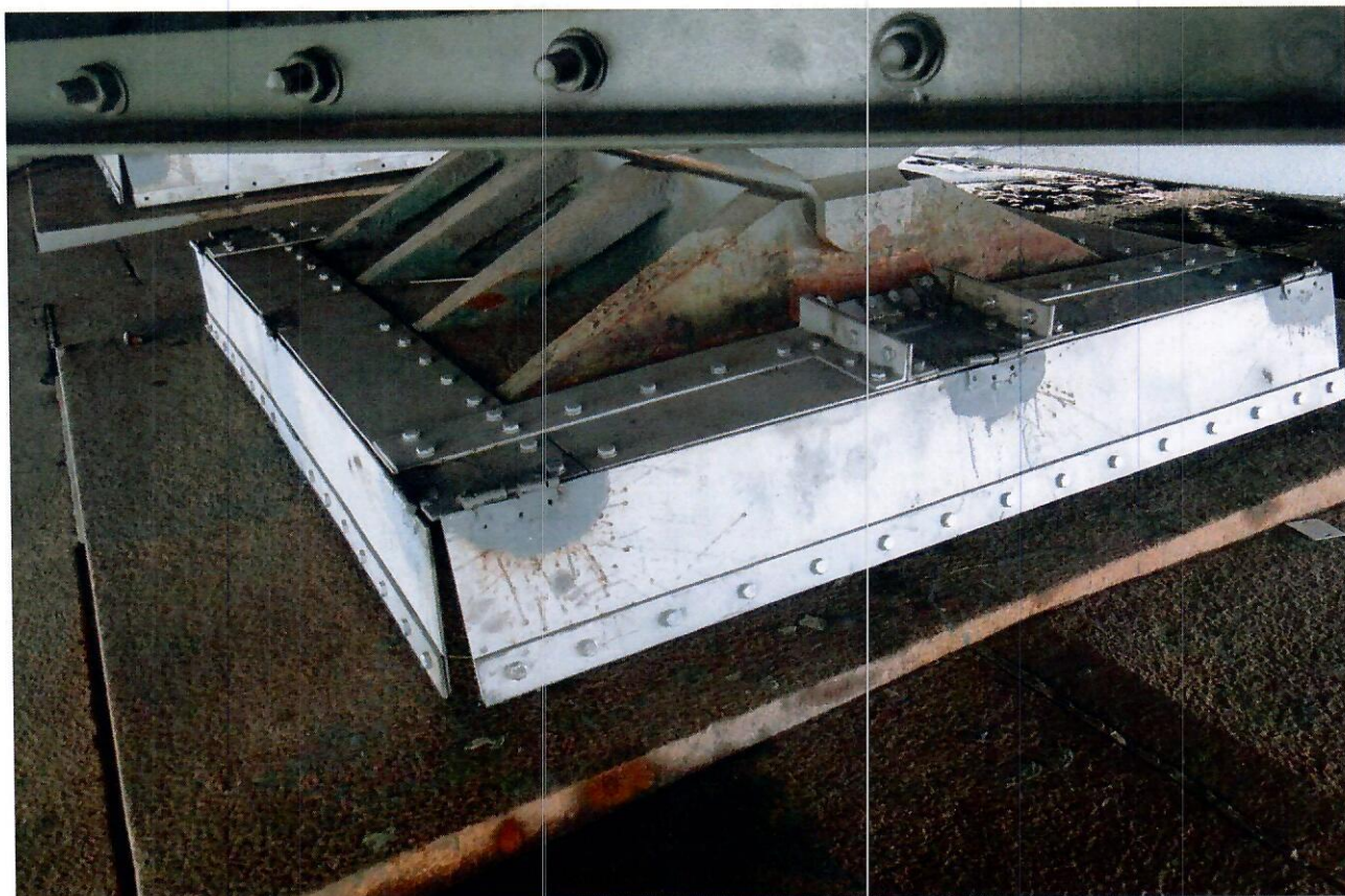
51. Вид на катковую опорную часть, установленную на опоре 5 под фермой Ф4'.
