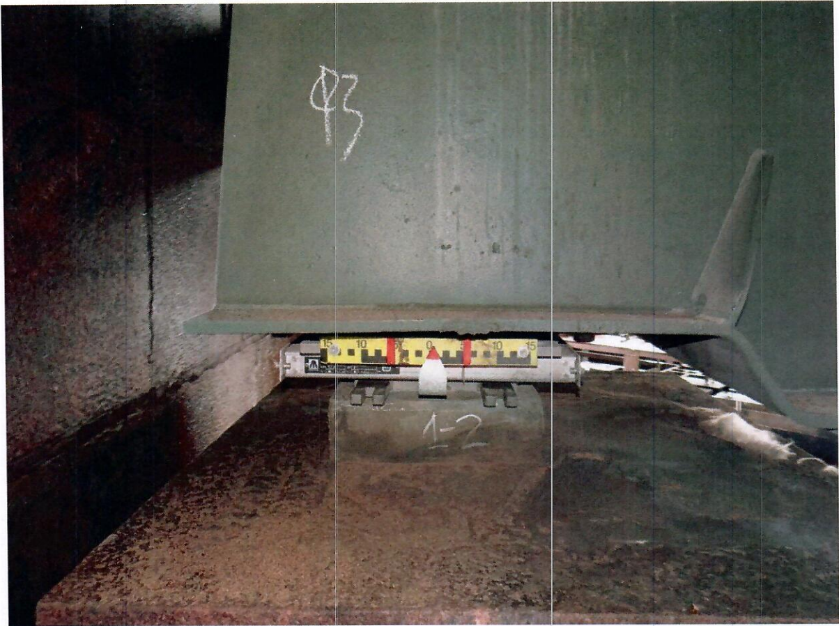
48. Вид на линейно-подвижную опорную часть «Maurer Sohne» тип Kge-1710 на опоре 1 под фермой Φ3.
