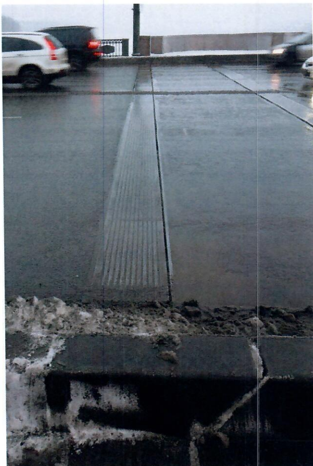
30. Виды с верхней стороны моста на деформационные швы над опорой 3. На фото слева шов между ПС 1-3 и противовесом, на фото справа шов между разводным пролетным строением и противовесом.
