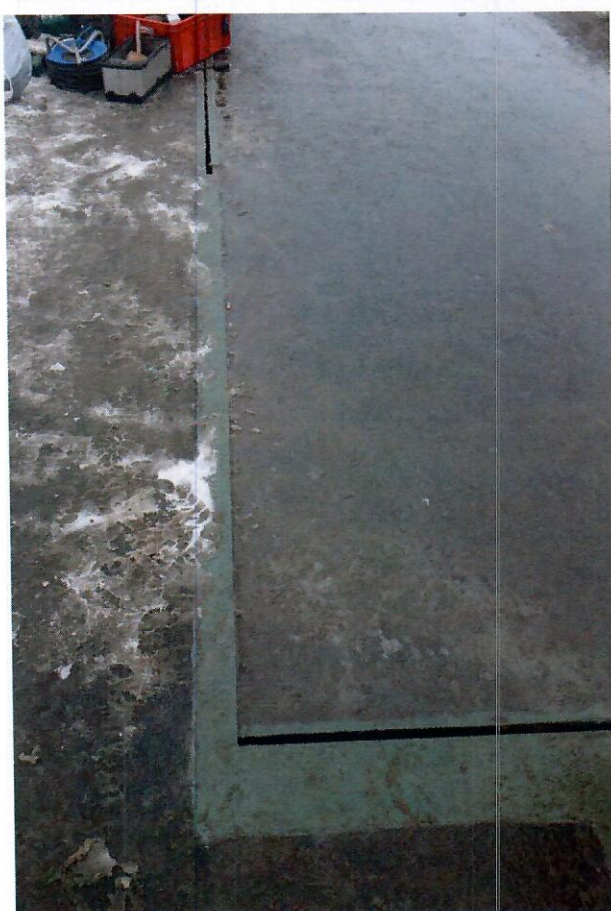
32. Виды с верховой стороны моста на деформационные швы над опорой 4. На фото справа сверху шов между ПС 4-6 и противовесом, на фото слева сверху шов между разводным пролетным строением и противовесом. Снизу фото шва на тротуаре.
