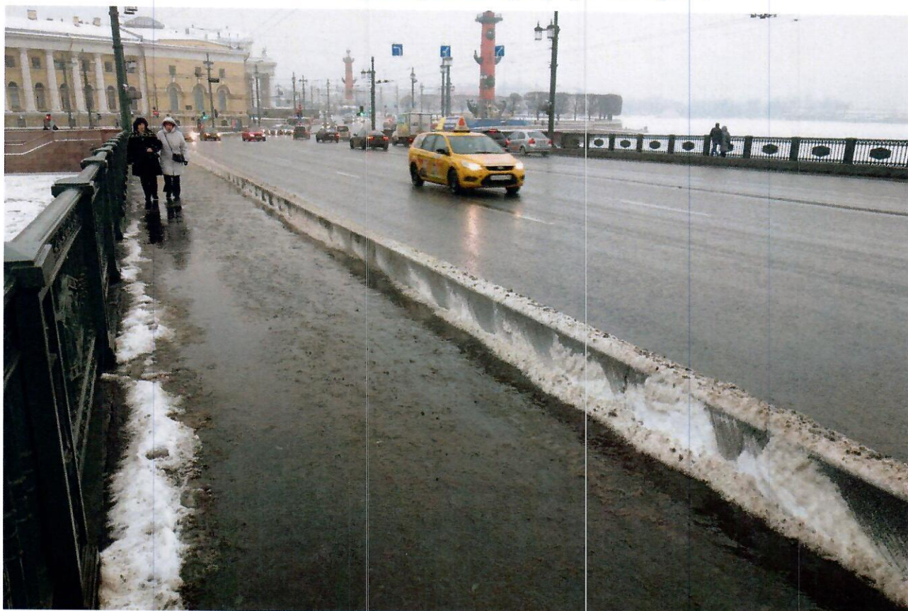
16. Вид на левый тротуар и проезжую часть от опоры 4.
