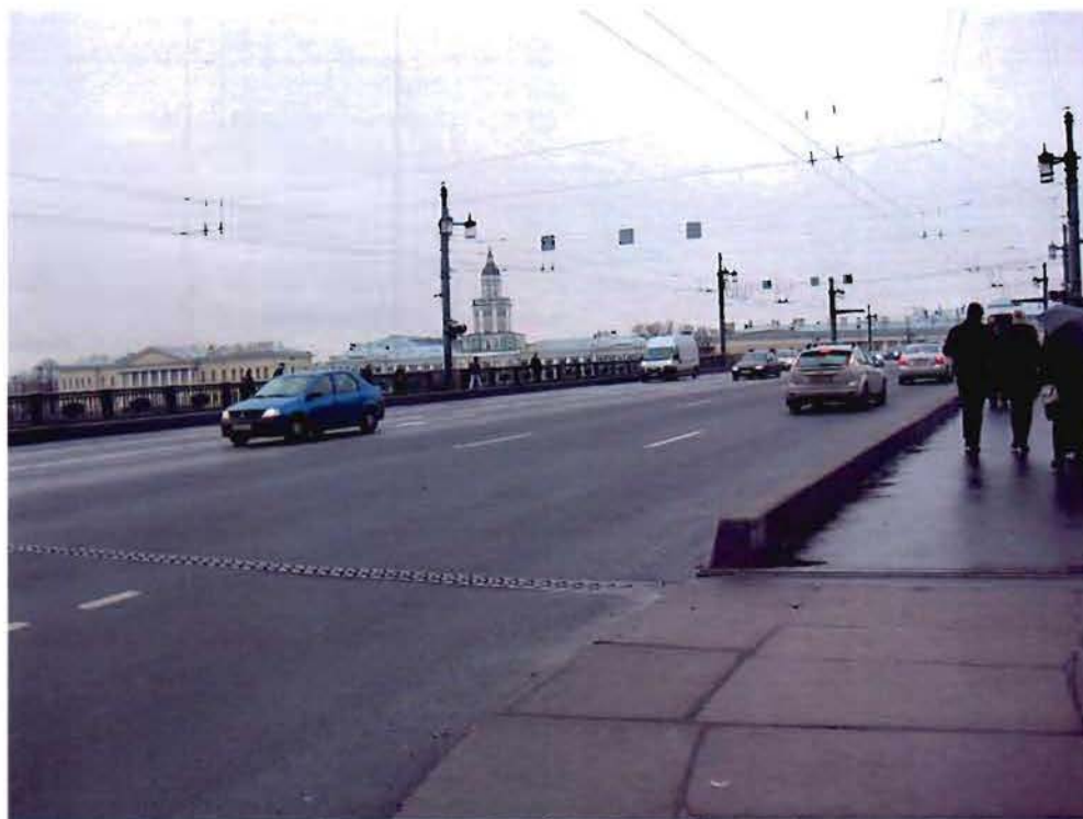
5. Вид на дорожное покрытие моста
