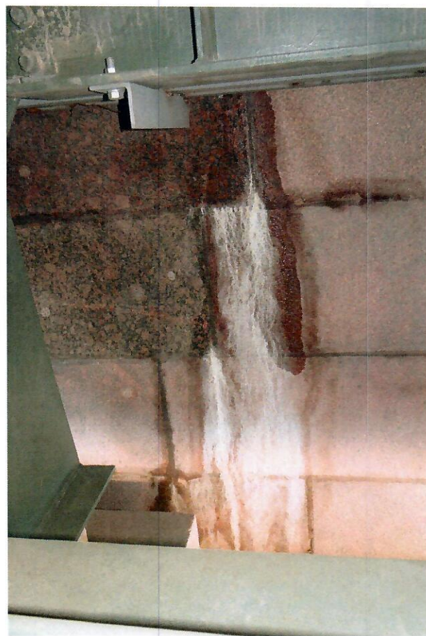
54. Виды снизу на шкафную стенку опоры 1 и на деформационный шов над опорой 1. Следы протечек воды.
