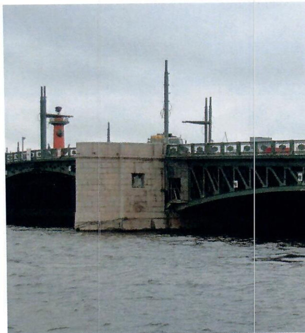
45. Вид на низовую сторону опоры 3. Опоры 3, 4 – массивные, бутобетонные, облицованы гранитными блоками, фундаменты – кессоны, заполненные бетоном.
