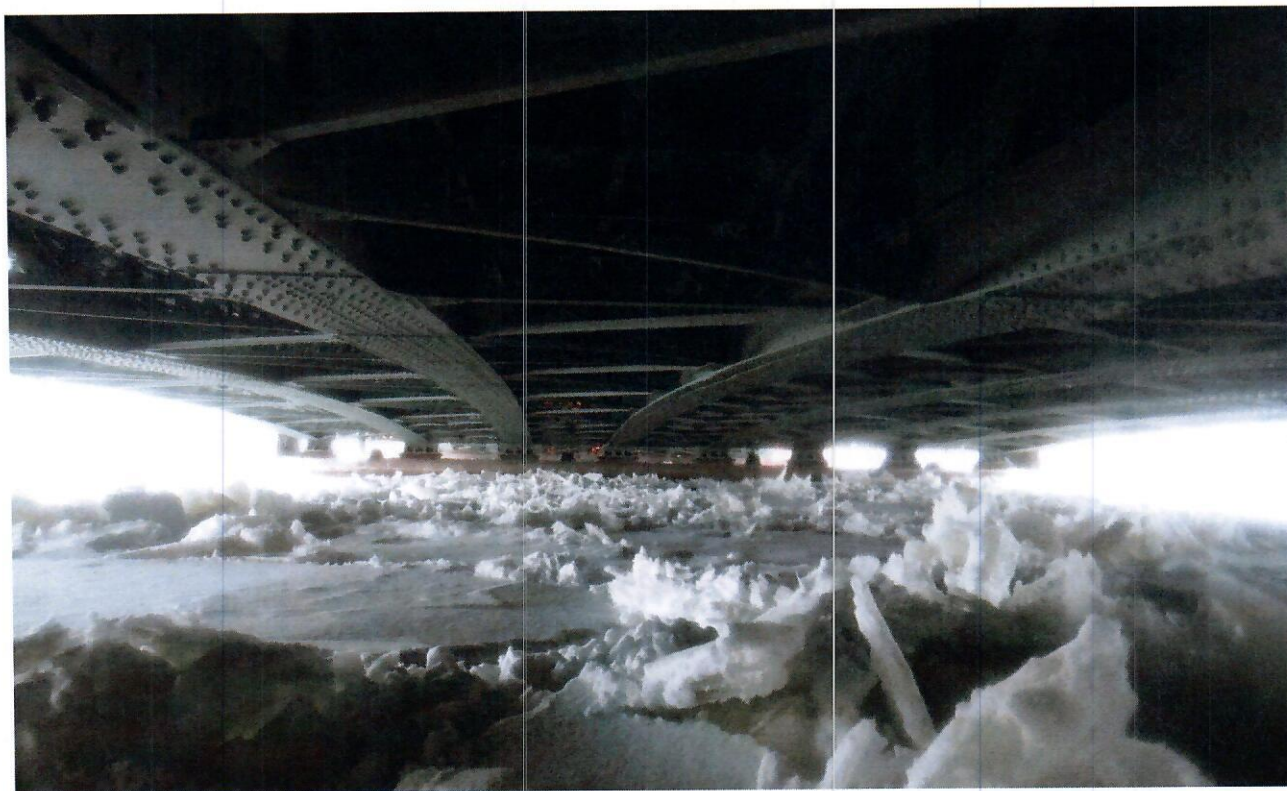
42. Общий вид снизу на пролетное строение 4-6 в пролете 5.
