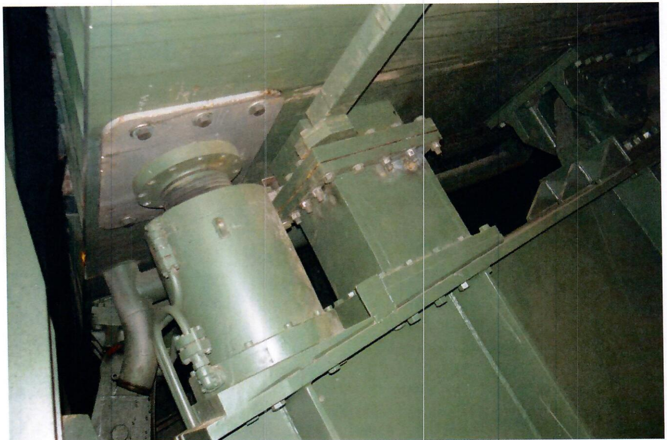
25. Вид на систему опирания противовеса. Слева гидроцилиндр подъема противовеса, посередине РОЧ и справа шарнир противовеса.
