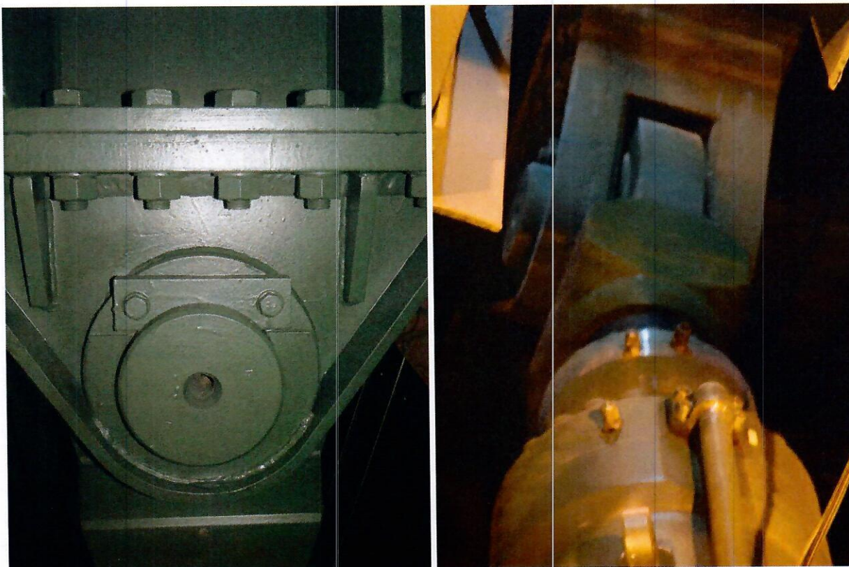
21. Вид на верхнее крепление гидроцилиндра на опоре 3 между фермами Ф1 и Ф1'.
