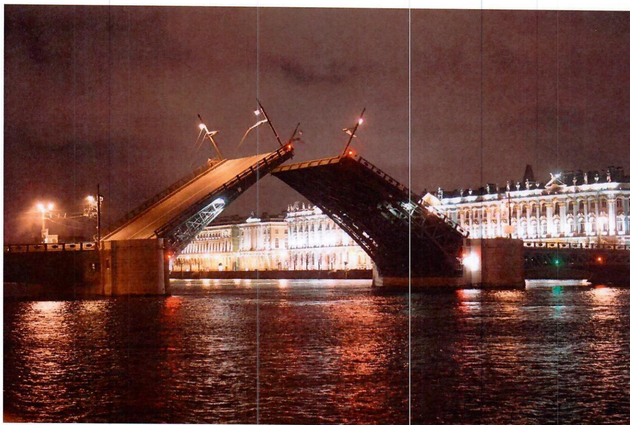
12. Общий вид на мост при сведении крыльев ПС с нижней стороны с Васильевского острова.
