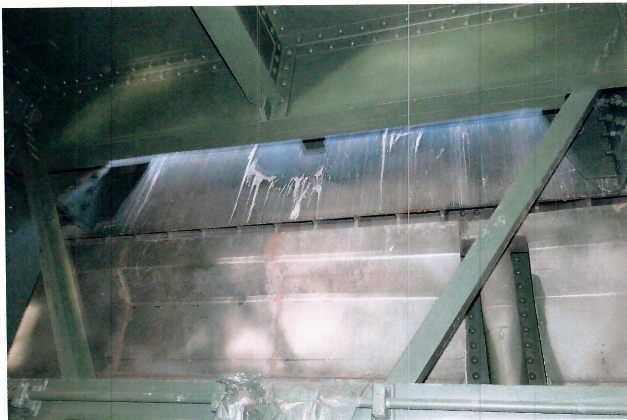
33. Вид снизу на водоотводный лоток под деформационным швом над опорой 3 между ПС 3-4 и 1-3.
