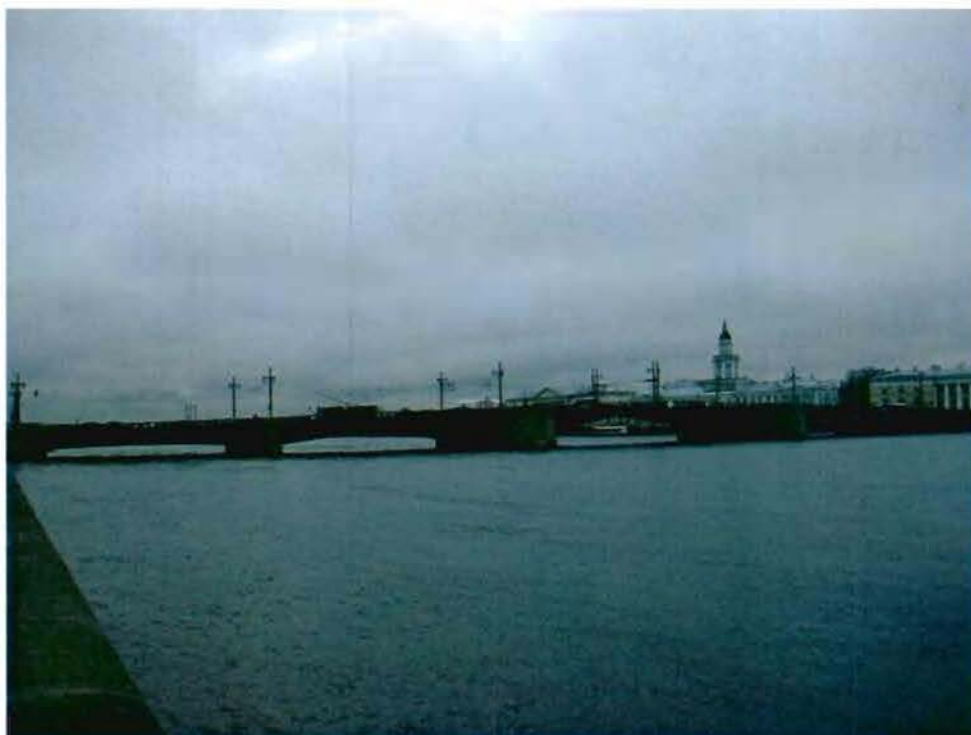
1. Вид на мост со стороны верхового фасада
