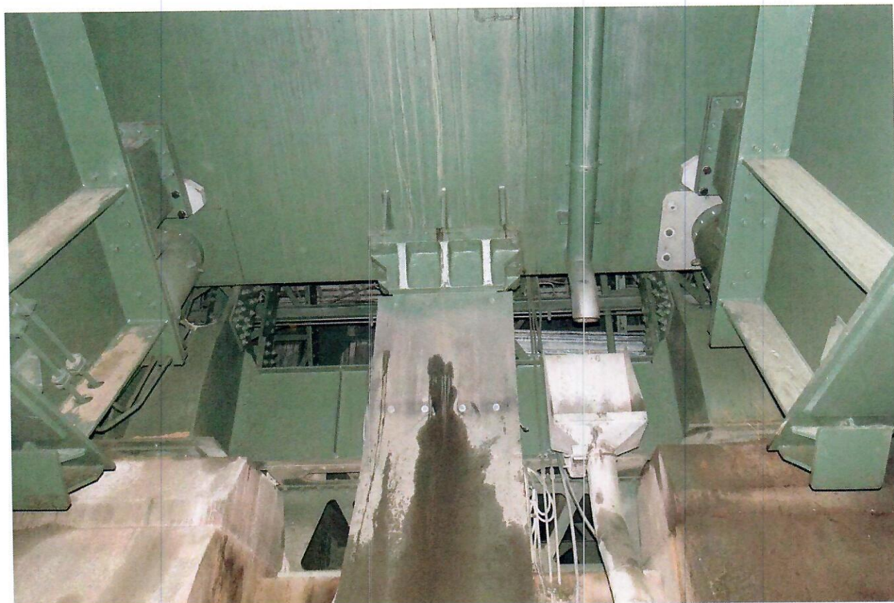
22. Вид снизу на механизм подклинки противовеса (за кожухом) и на места опирания противовеса на фермы.
