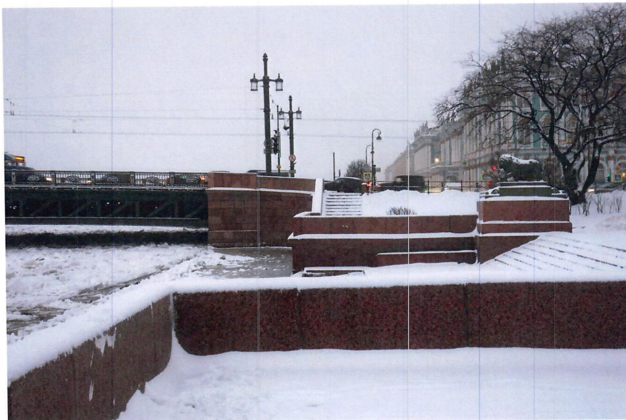
43. Вид на опору 1. Опора - является подпорной стенкой, фундамент – кессон, заполненный бетоном, сопряжен с набережной с помощью крыльев, тело выполнено из железобетона в верхней части и бутобетона в нижней части, облицовка - гранитными блоками.
