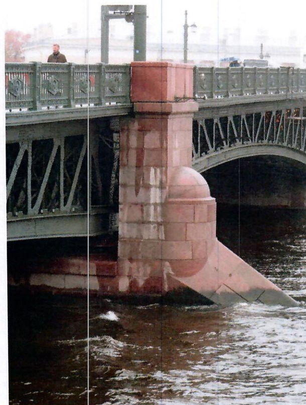
44. Вид на низовую сторону (фото слева) и верховую сторону (фото справа) опоры 2. Опоры 2 и 5 – массивные, бутобетонные, облицованные гранитными блоками, фундаменты – кессоны, заполненные бетоном.
