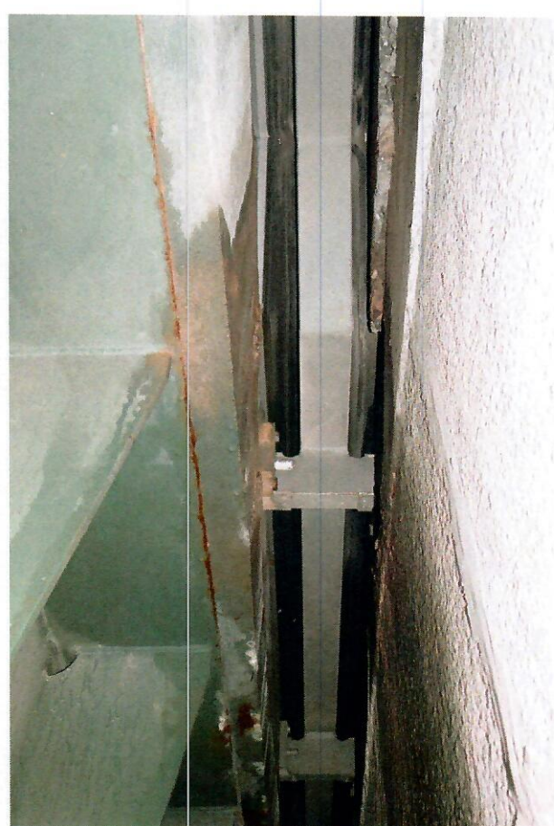
54. Виды снизу на шкафную стенку опоры 1 и на деформационный шов над опорой 1. Следы протечек воды.
