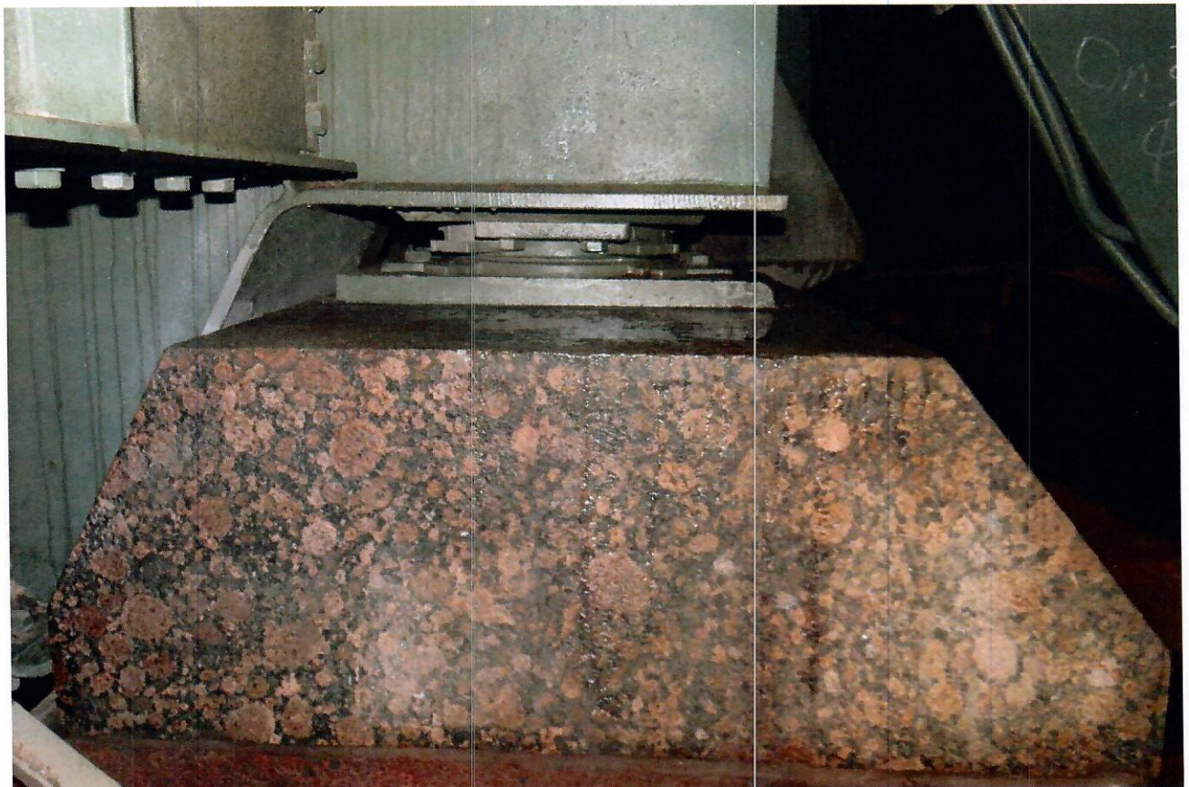
49. Вид на опорную часть, установленную на опоре 3 под фермой Φ1.
