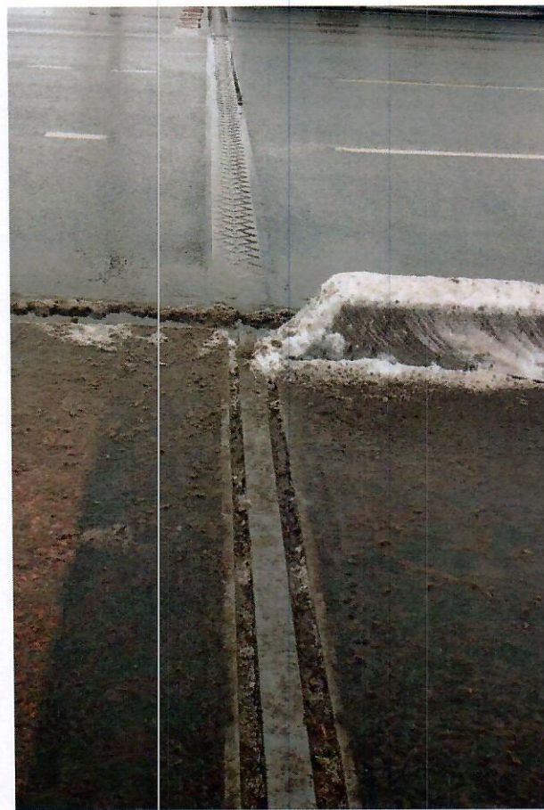
29. Виды сверху на деформационные швы Mauger D160 GO над опорой 1 (фото слева) и над опорой 6 (фото справа)
