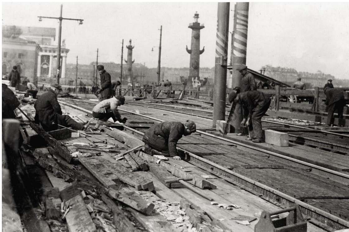
16. Республиканский (Дворцовый) мост на ремонте. 1934 г. — «PastVu» — ретро-фотографии стран и городов [Электронный ресурс]. URL: https://pastvu.com/p/451601 .
