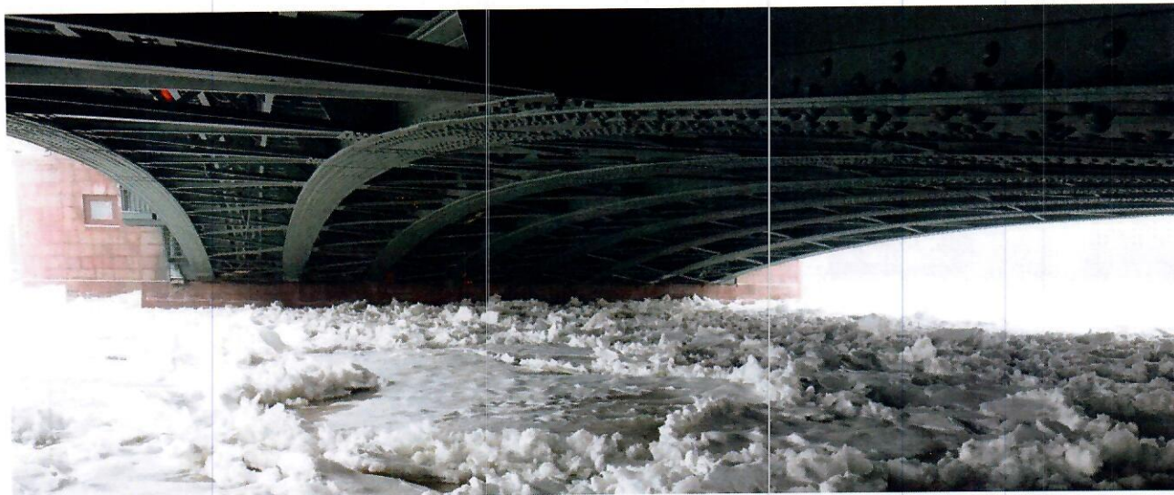
41. Общий вид снизу на пролетное строение 4-6 в пролете 4 и на опору 4.
