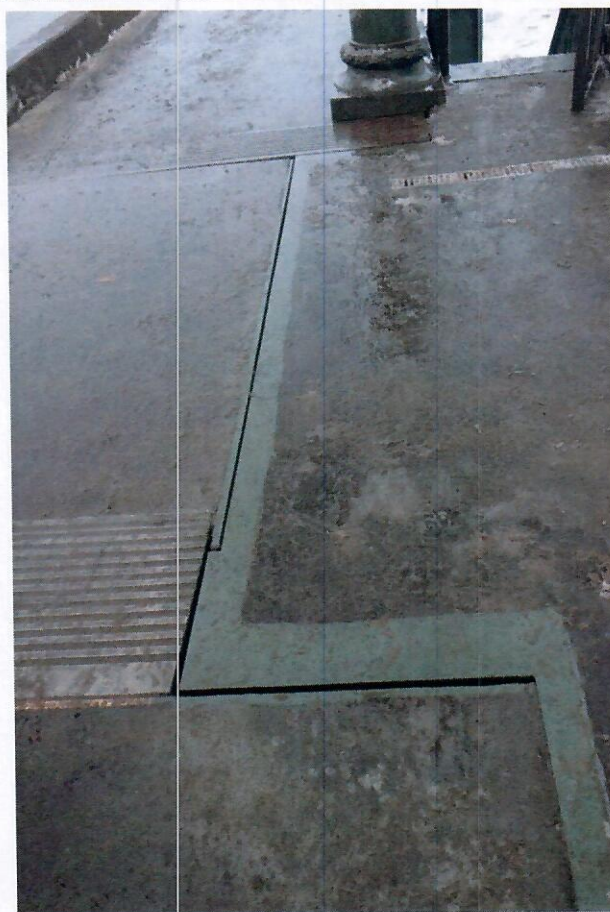
32. Виды с верховой стороны моста на деформационные швы над опорой 4. На фото справа сверху шов между ПС 4-6 и противовесом, на фото слева сверху шов между разводным пролетным строением и противовесом. Снизу фото шва на тротуаре.
