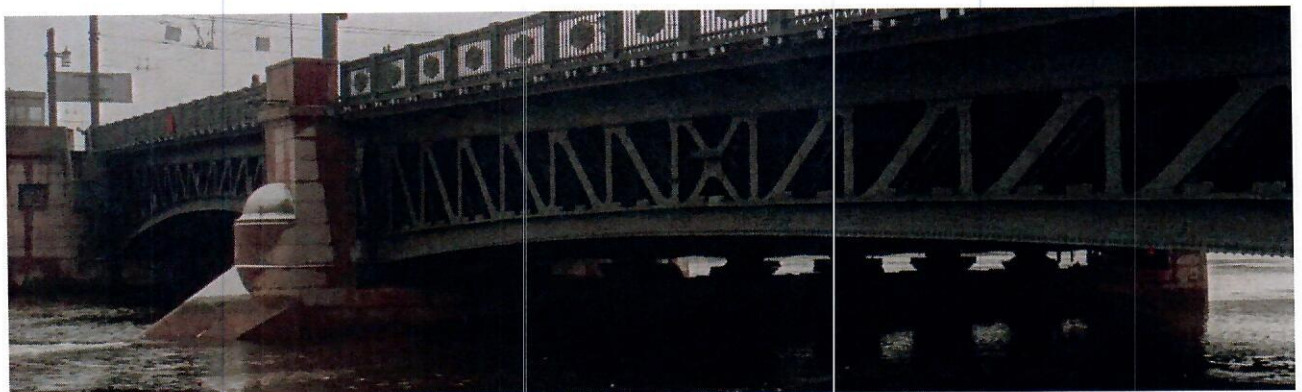
46. Вид на опору 5 с верхней стороны от опоры 6.
