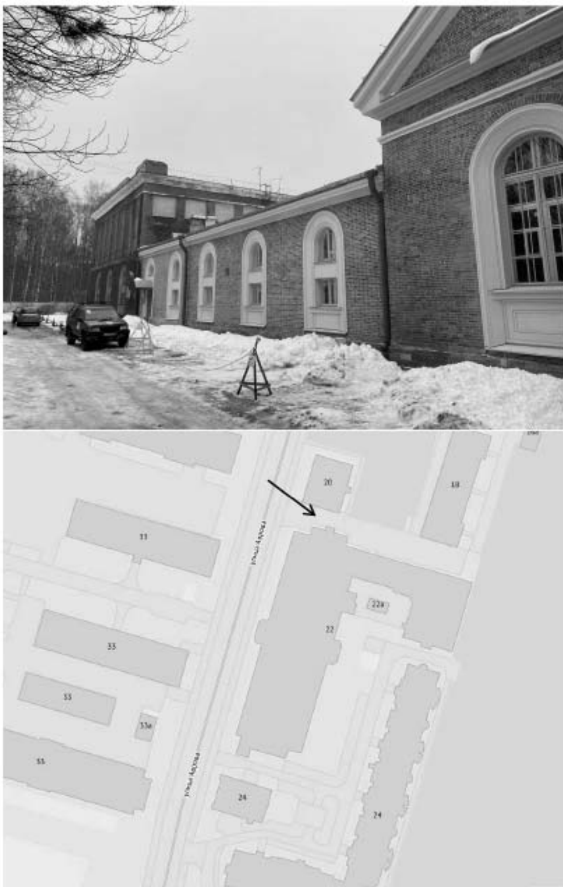
Фото 3. Объект культурного наследия регионального значения «Манеж Уланского полка» расположенный по адресу: Санкт-Петербург, Петродворцовый район, г. Петергоф, ул. Аврова, д. 22, лит. А. Дворовой фасады здания. Дата съемки 4.03.2022 г.
