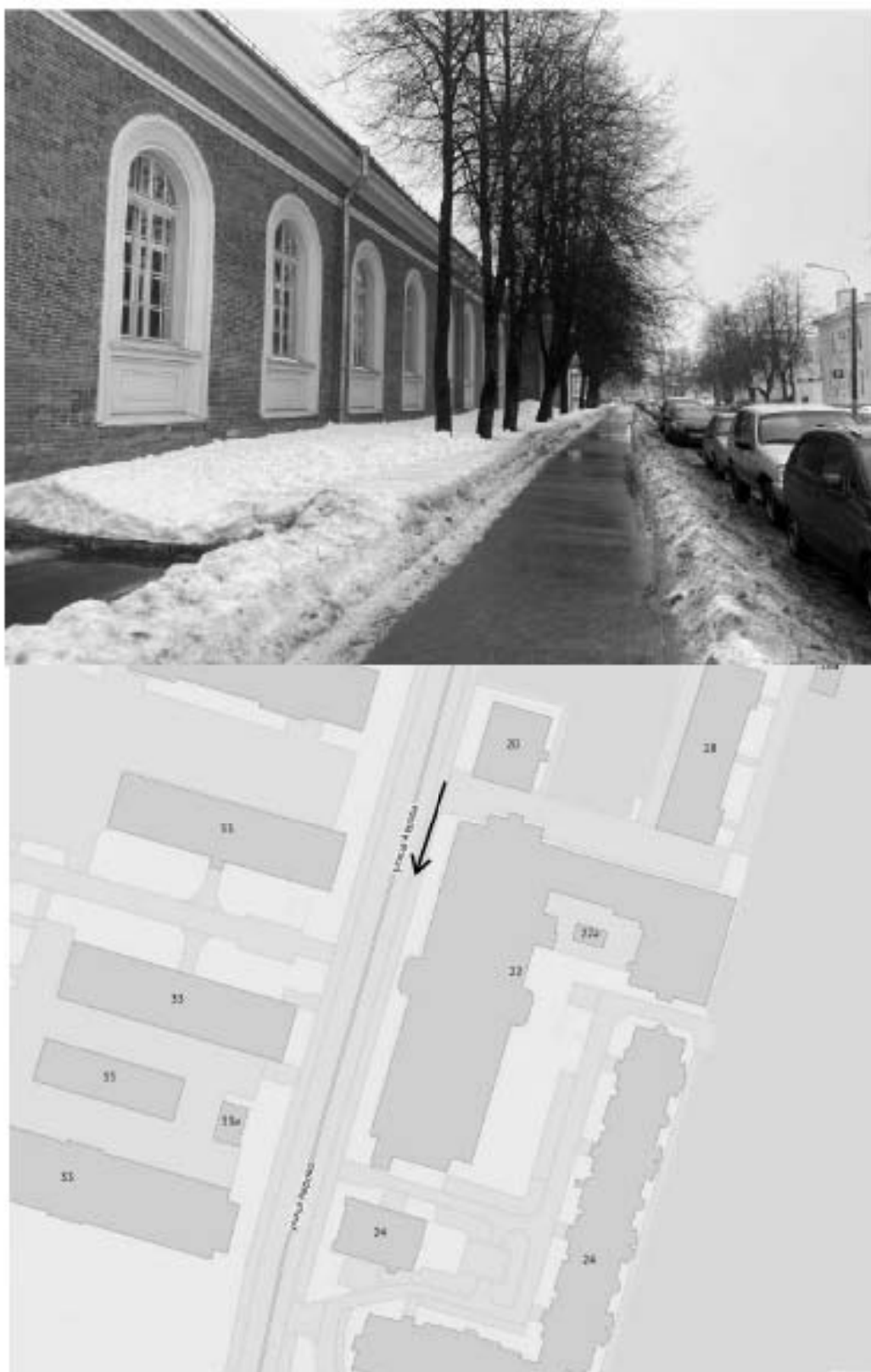
Фото 1. Объект культурного наследия регионального значения «Манеж Уланского полка» расположенный по адресу: Санкт-Петербург, Петродворцовый район, г. Петергоф, ул. Аврова, д. 22, лит. А. Лицевой фасад здания. Дата съемки 4.03.2022 г.
