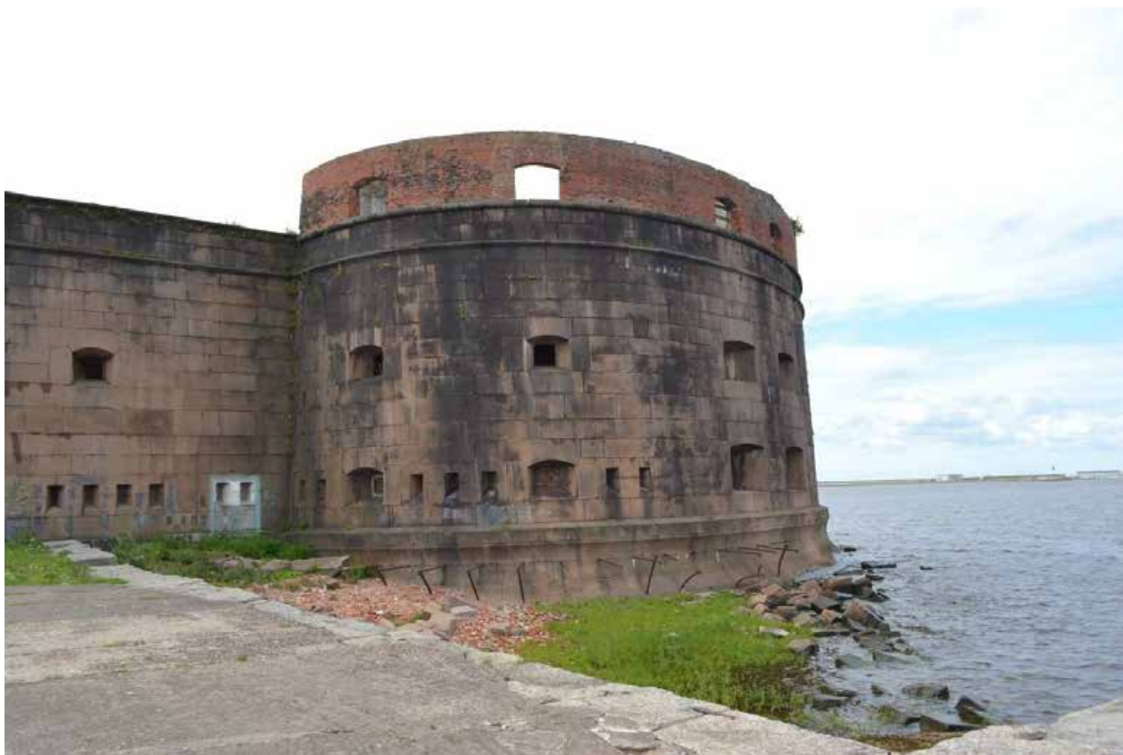
Фото 6. Форт Александр I. Правая часть северного фасада (лицевого). Вид с северо-востока.
