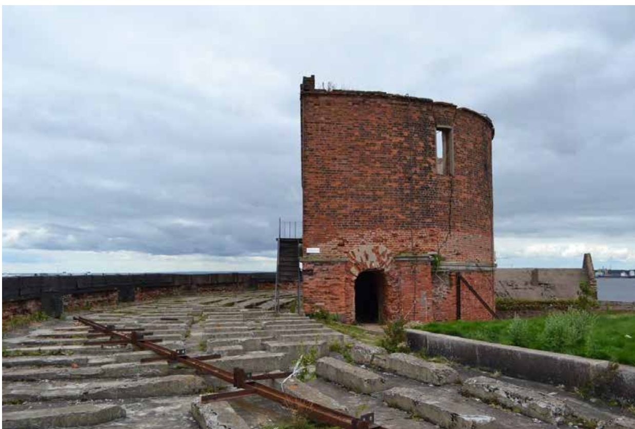
Фото 2. Ообъем западной лестничной клетки с надстройкой. Вид с валагнга.
