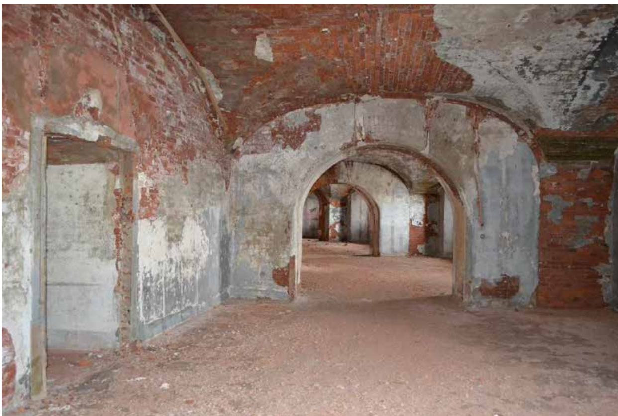
Фото 12. Второй этаж. Казематы. Общий вид.
