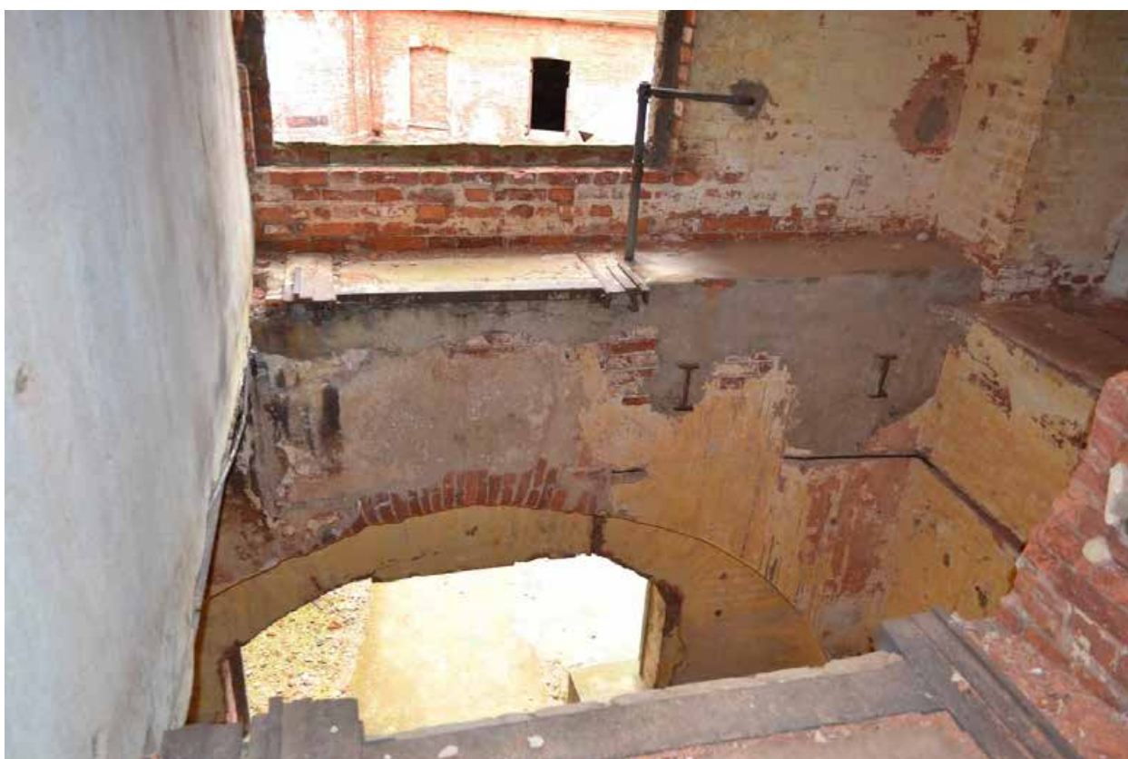
Фото 16. Второй этаж. Отверстие в перекрытии для шахты подъемного механизма.
