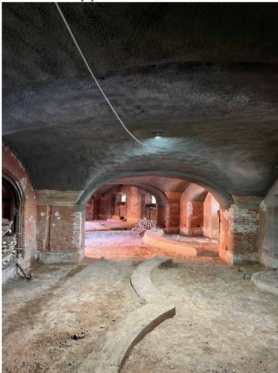
Фото 11. Первый этаж. Помещения казематов.
