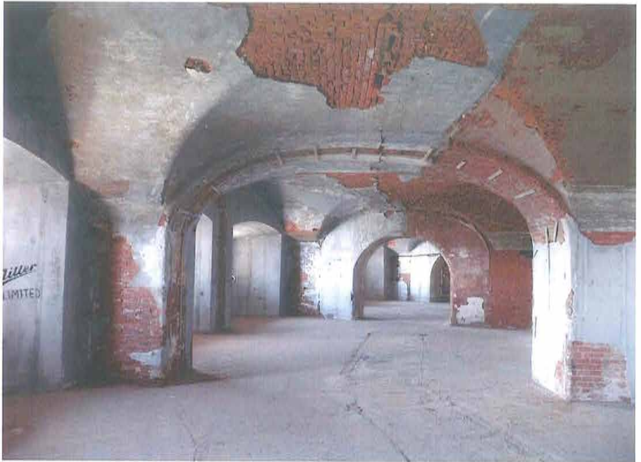
Фото № 6. Кирпичные казематы.
