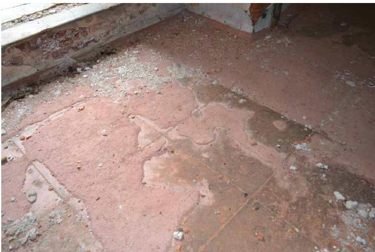
Фото 13. Второй этаж. Вид на напольное покрытие.
