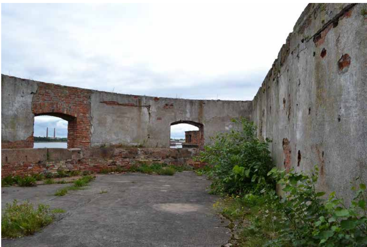
Фото 13. Казематы. Помещения третьего этажа. Выход на открытую площадку – кровлю второго этажа.
