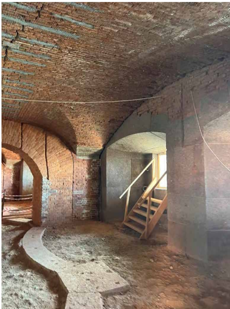
Фото 17. Первый этаж. Помещения казематов.
