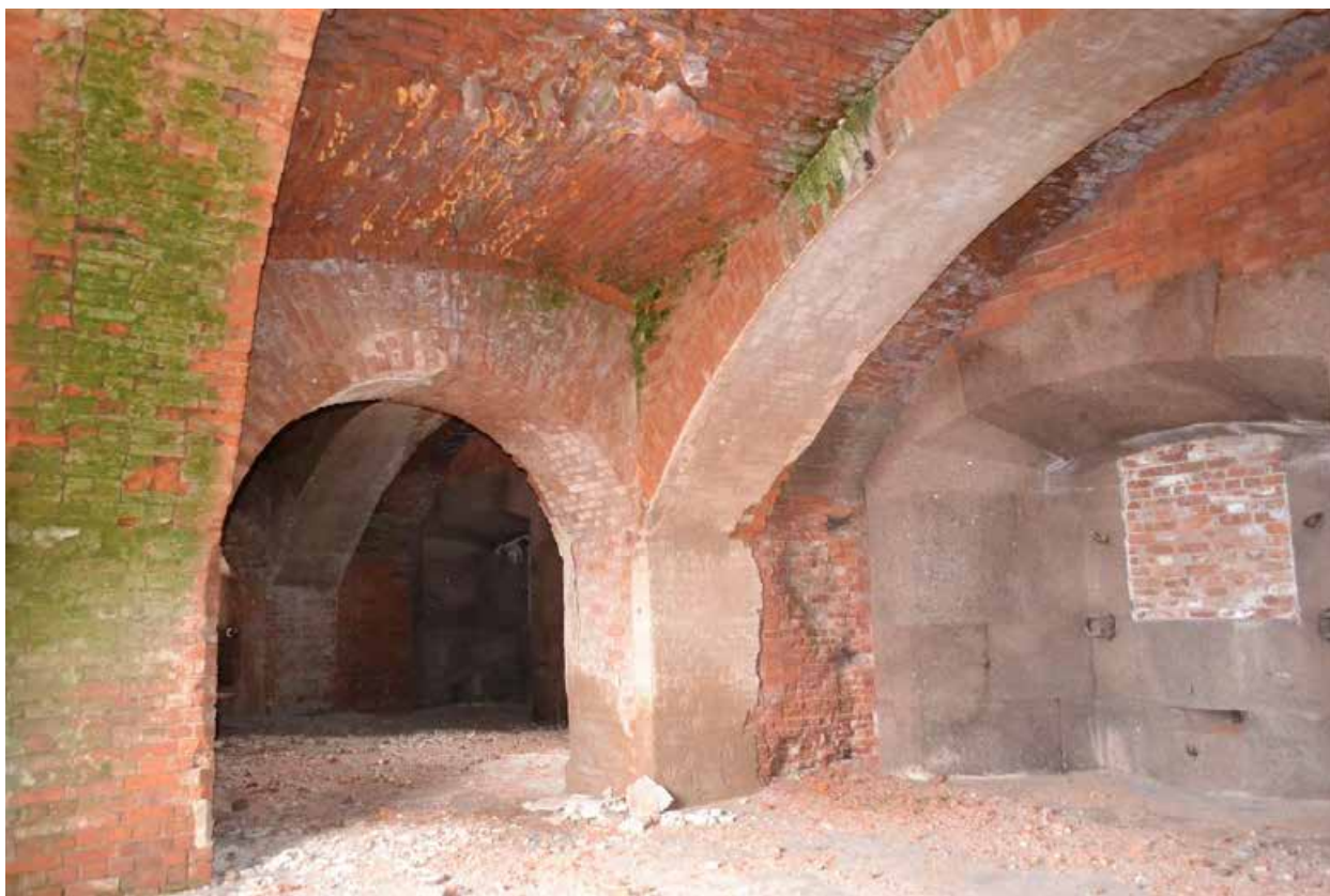
Фото 8. Казематы. Помещения третьего этажа. Общий вид.
