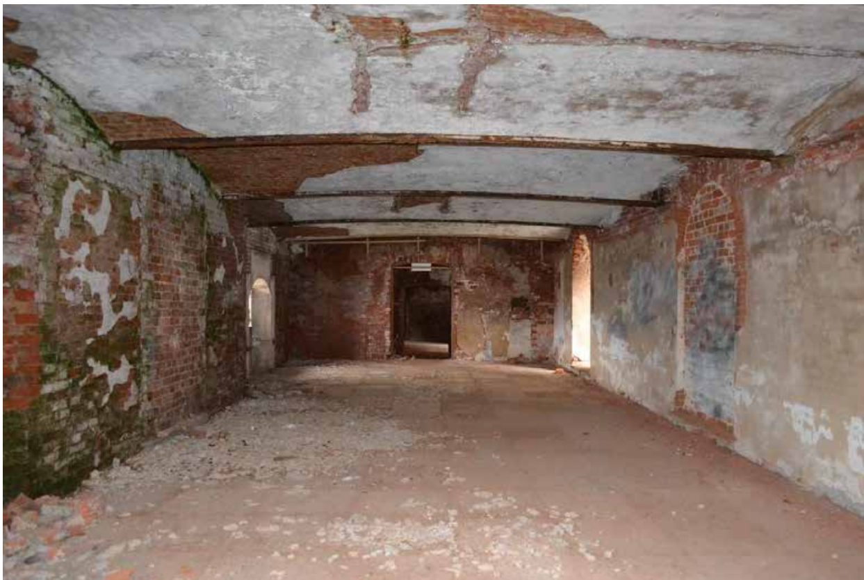
Фото 5. Второй этаж. Помещение горжевой части.
