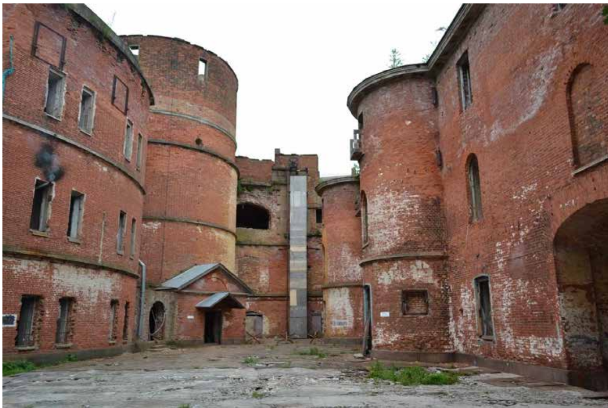
Фото 8. Форт Александр I. Пространство внутреннего двора. Вид с востока.
