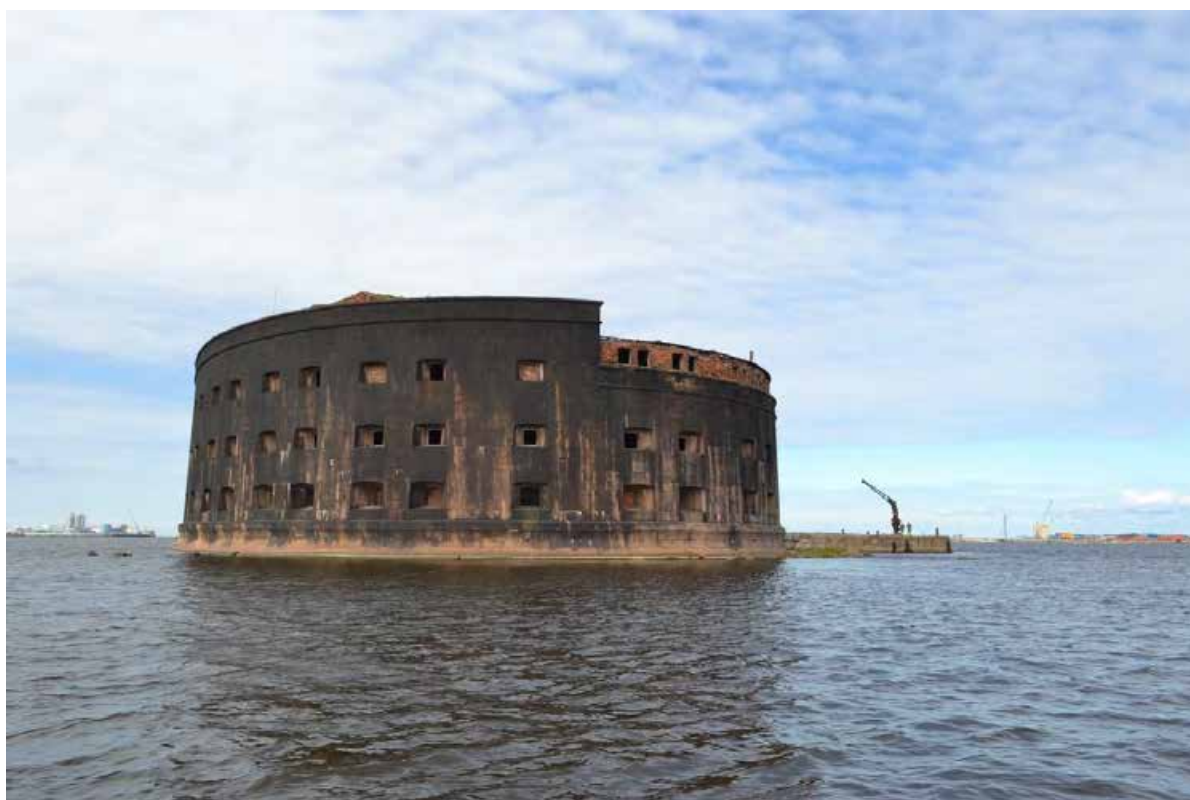
Фото 2. Форт Александр I. Восточный фасад. Вид с востока.
