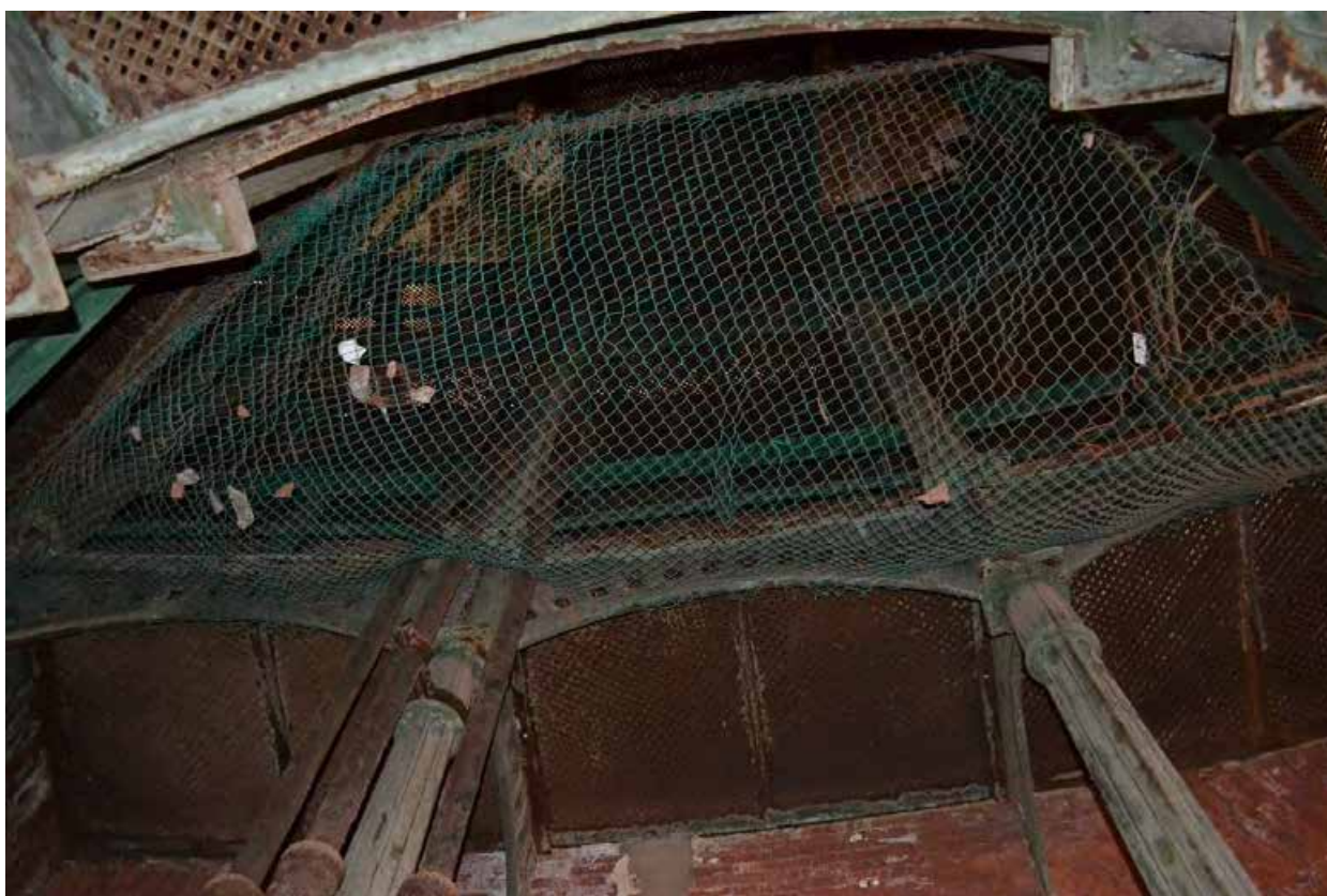
Фото 2. Лестничная клетка западного объема. Общий вид с первого этажа.
