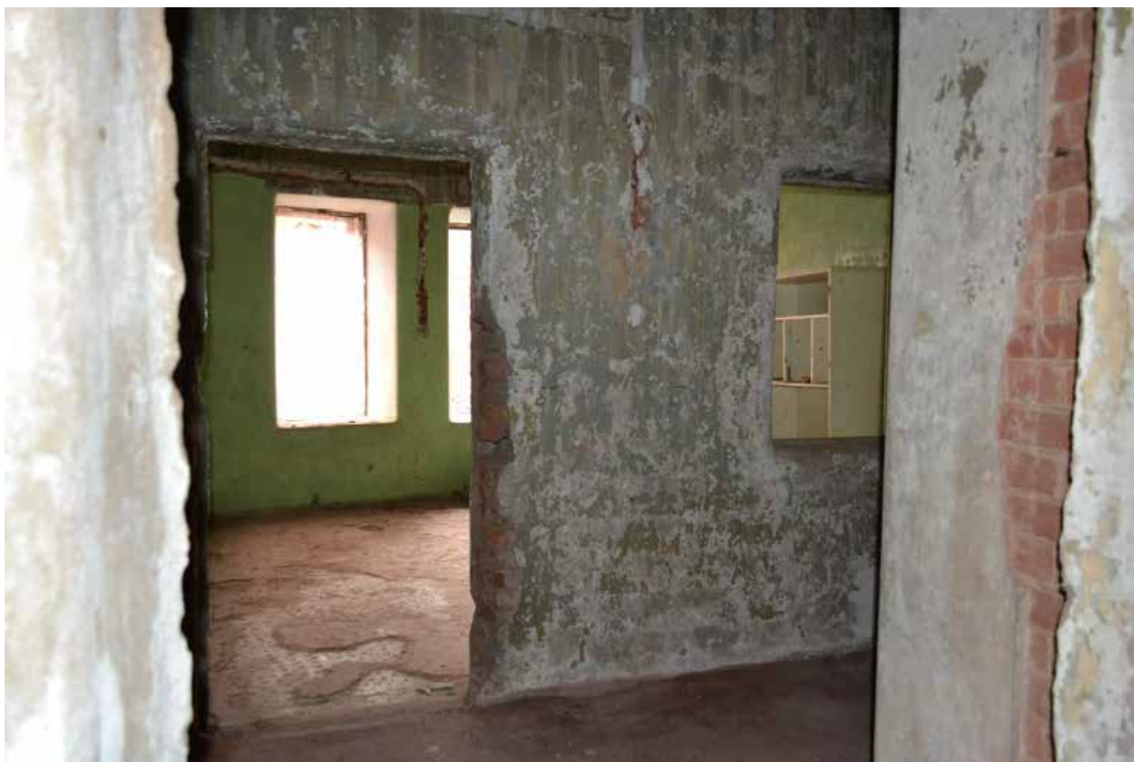
Фото 9. Помещение второго этажа.
