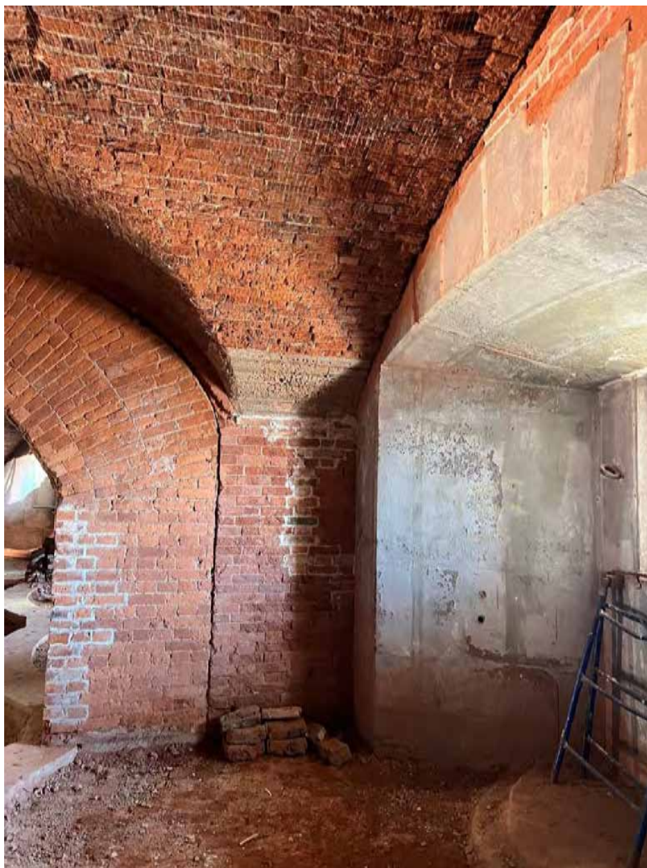
Фото 13. Первый этаж. Помещения казематов.
