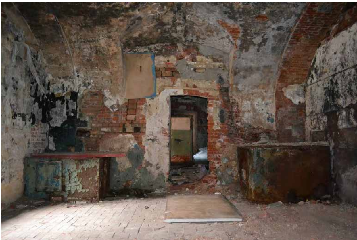
Фото 1. Первый этаж. Помещение горжевой части.
