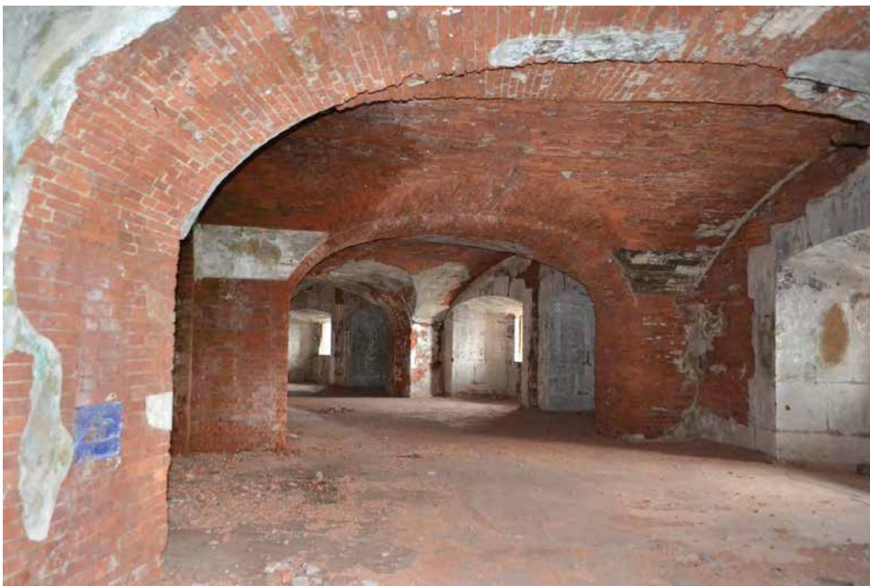
Фото 8. Второй этаж. Казематы. Общий вид.
