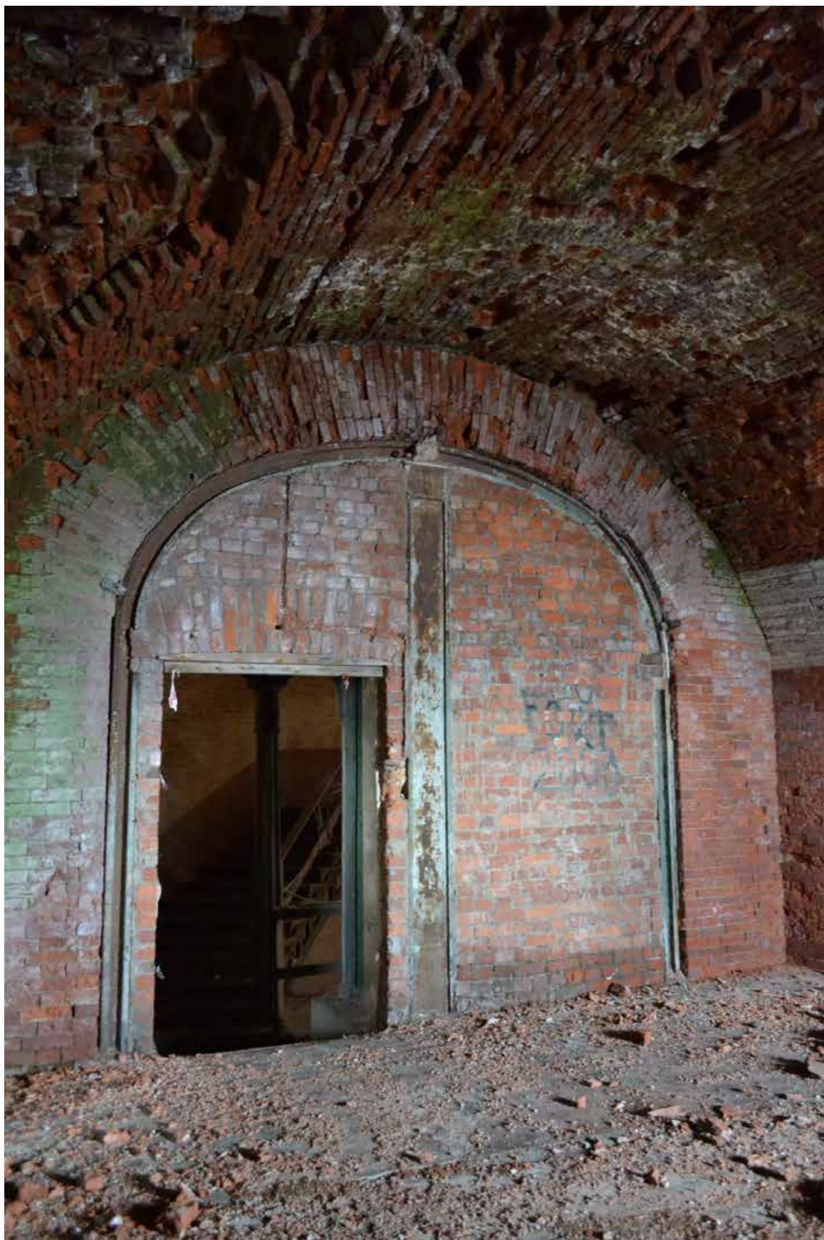
Фото 1. Казематы третьего этажа. Вид на частично заложённый проем на лестницу.
