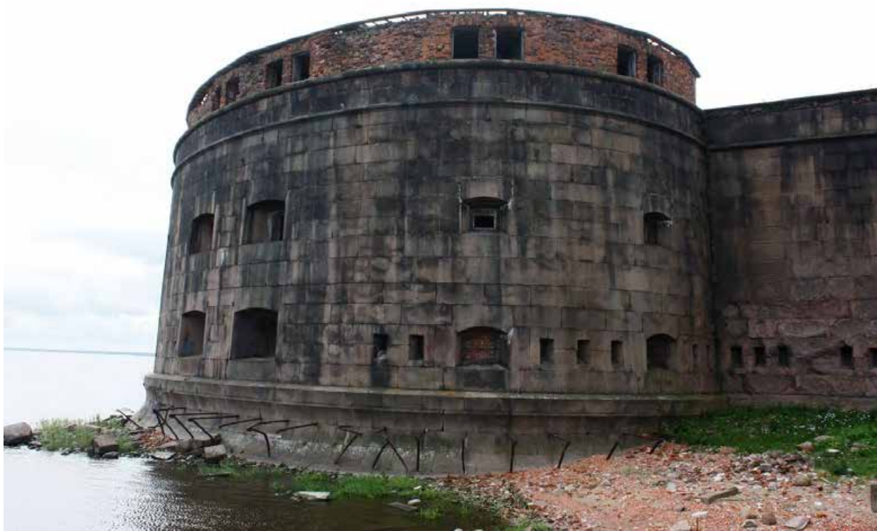
Фото 5. Форт Александр I. Левая часть северного фасада (лицевого). Вид с северо-запада.
