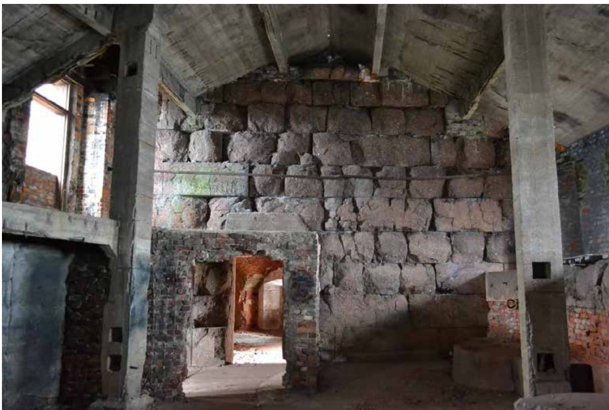
Фото 11. Казематы. Помещения третьего этажа.
