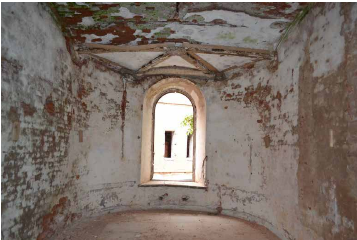
Фото 6. Второй этаж. Помещение горжевой части.
