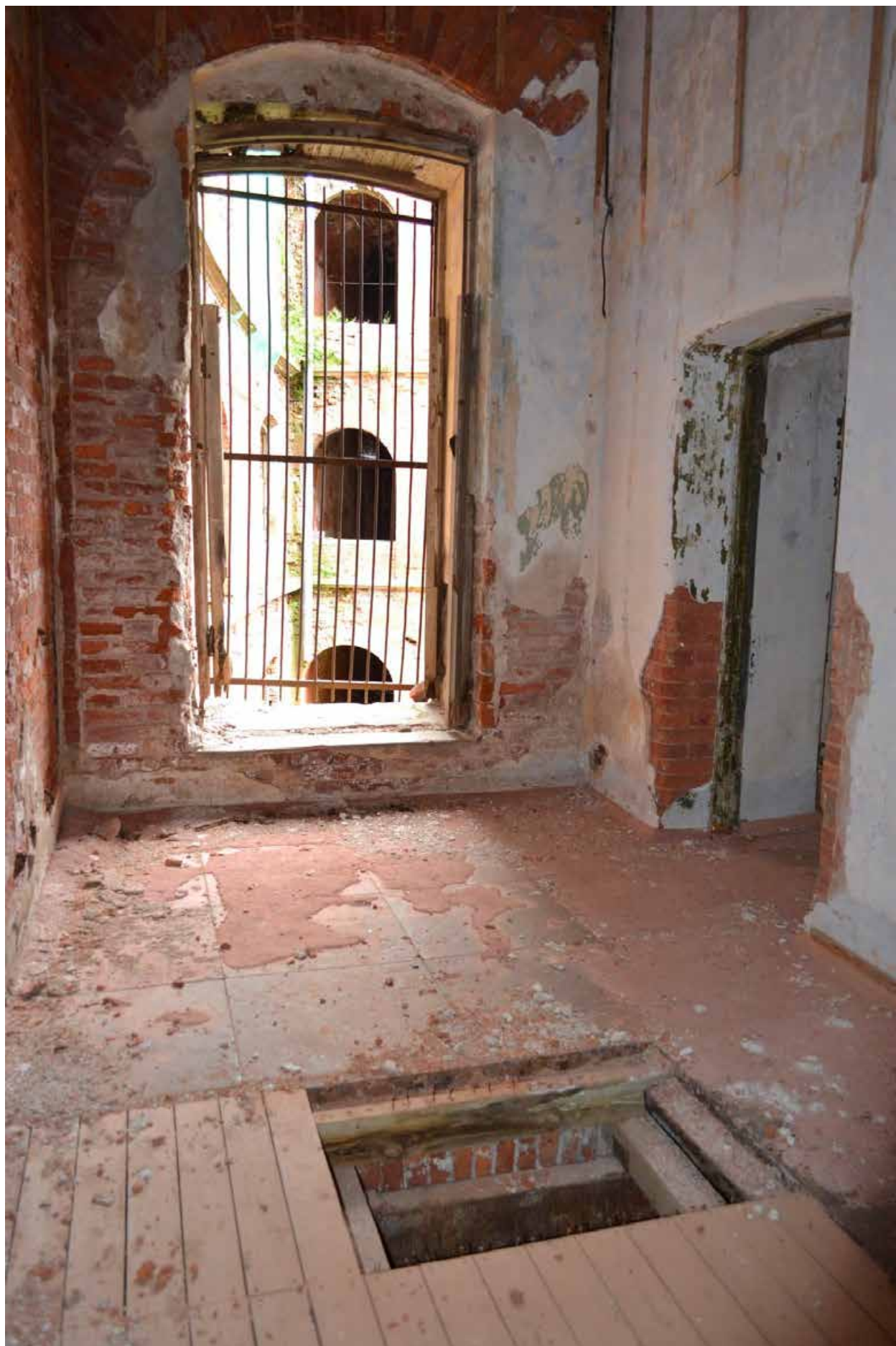
Фото 14. Помещение второго этажа.
