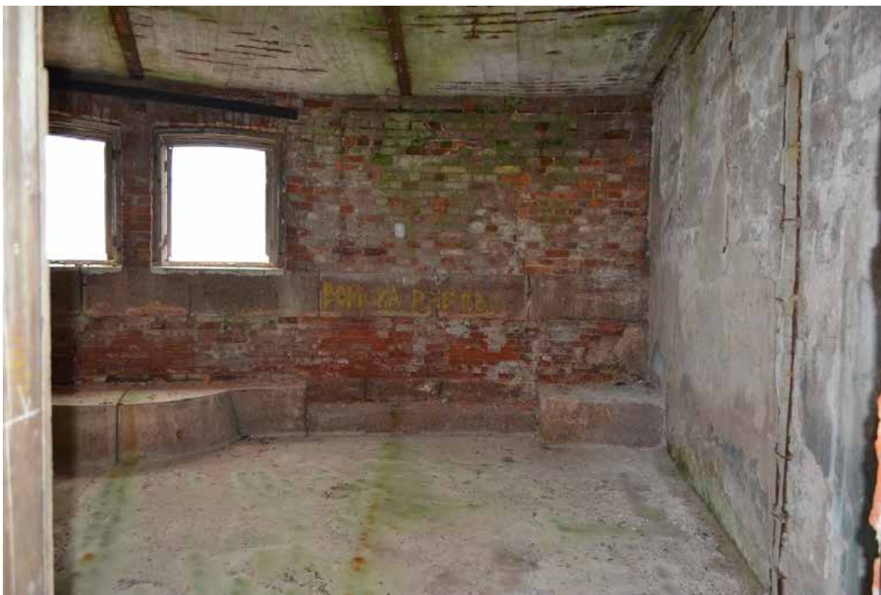
Фото 6. Казематы. Помещения третьего этажа.
