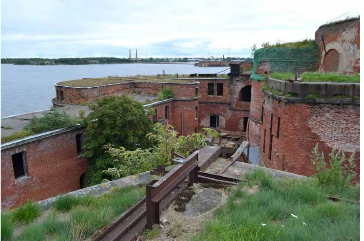
Фото 3. Общий вид кровли.
