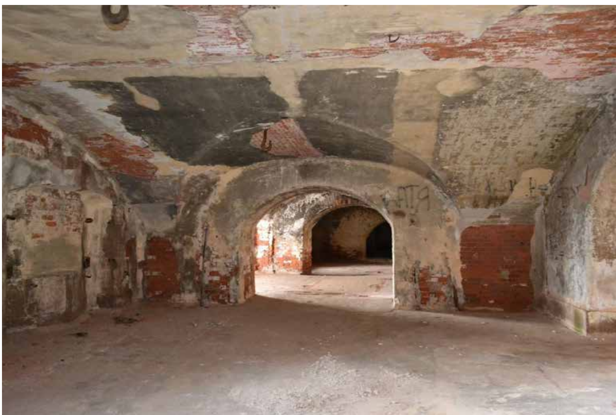
Фото 2. Первый этаж. Помещение казематов.
