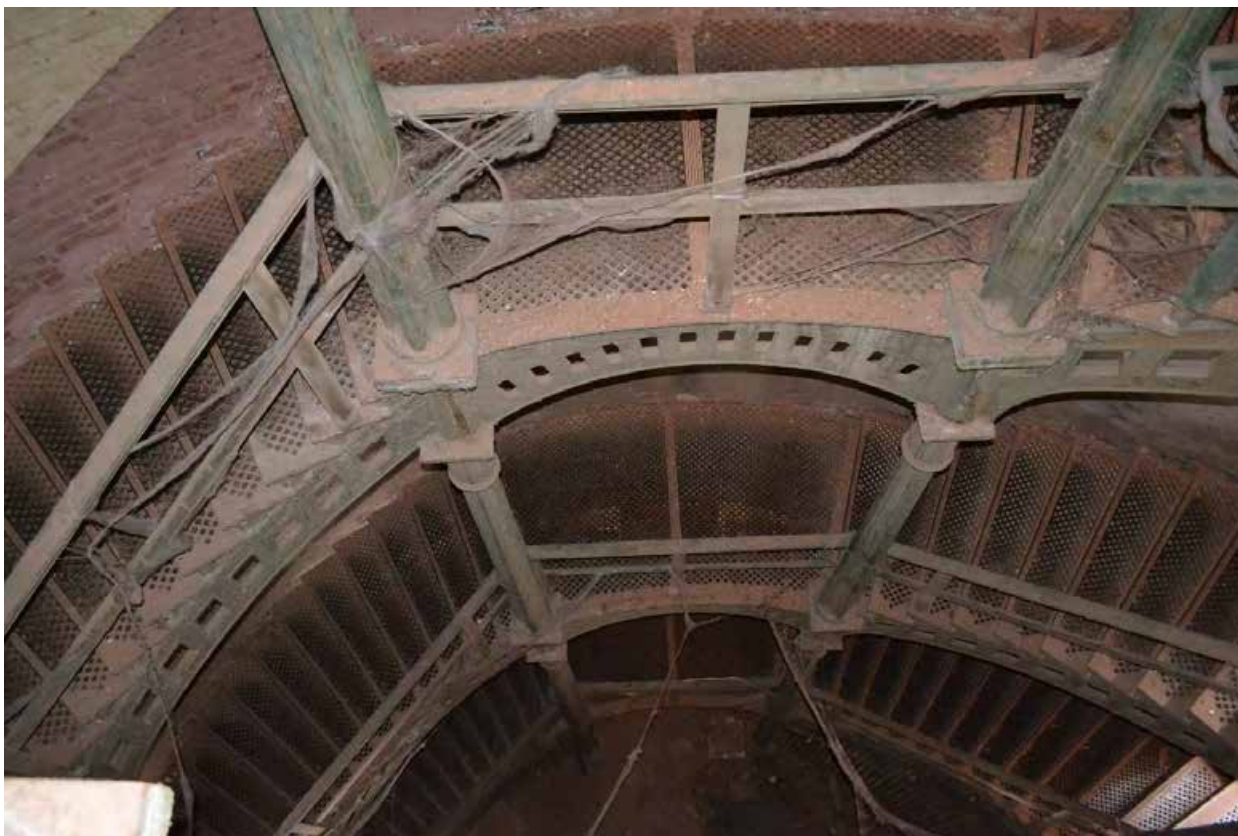
Фото 6. Лестничная площадка в уровне третьего этажа. Вид на первый этаж.
