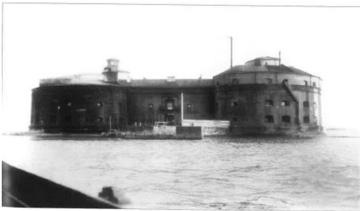
Илл. 102. Форт «Александр I». Вид с острова Котлин. Начало XX в. // Л.И. Амирханов, Ю.П. Голиков, В.В. Чирков, Ю.Е. Иванова. Форт «Император Александр I» – СПб.: «Издательский центр «ОСТРОВ», 2008.
