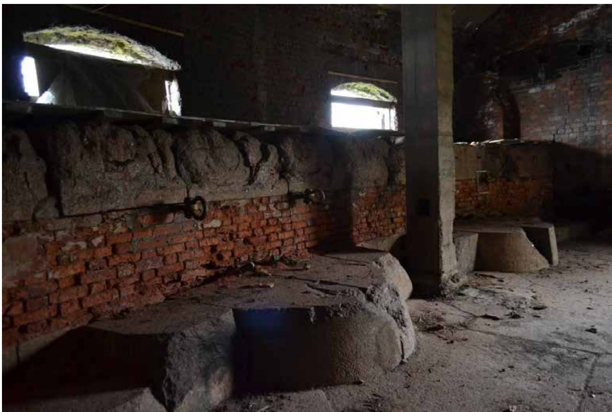
Фото 12. Казематы. Помещения третьего этажа.
