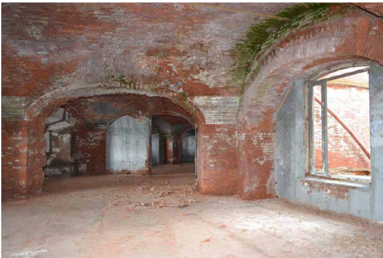
Фото 3. Второй этаж. Казематы. Вид на частично заложенный проем.
