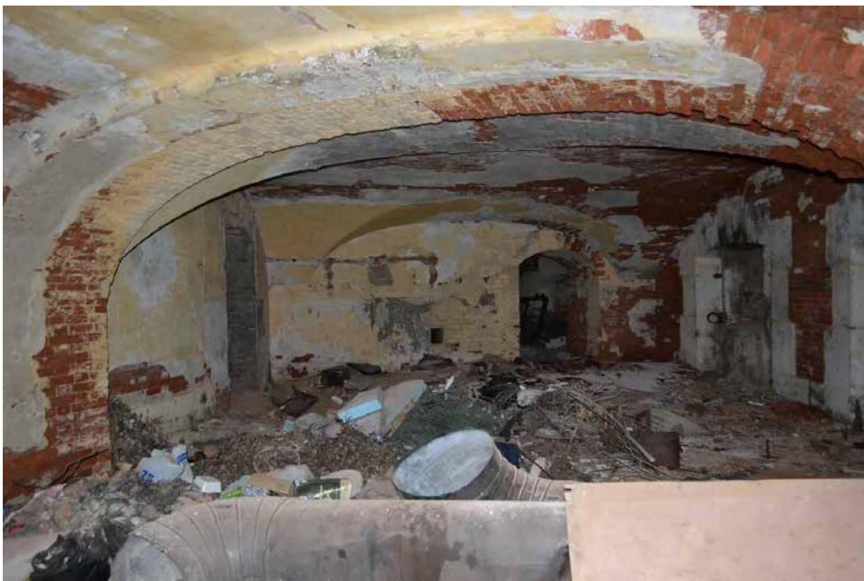
Фото 10. Первый этаж. Помещение казематов.
