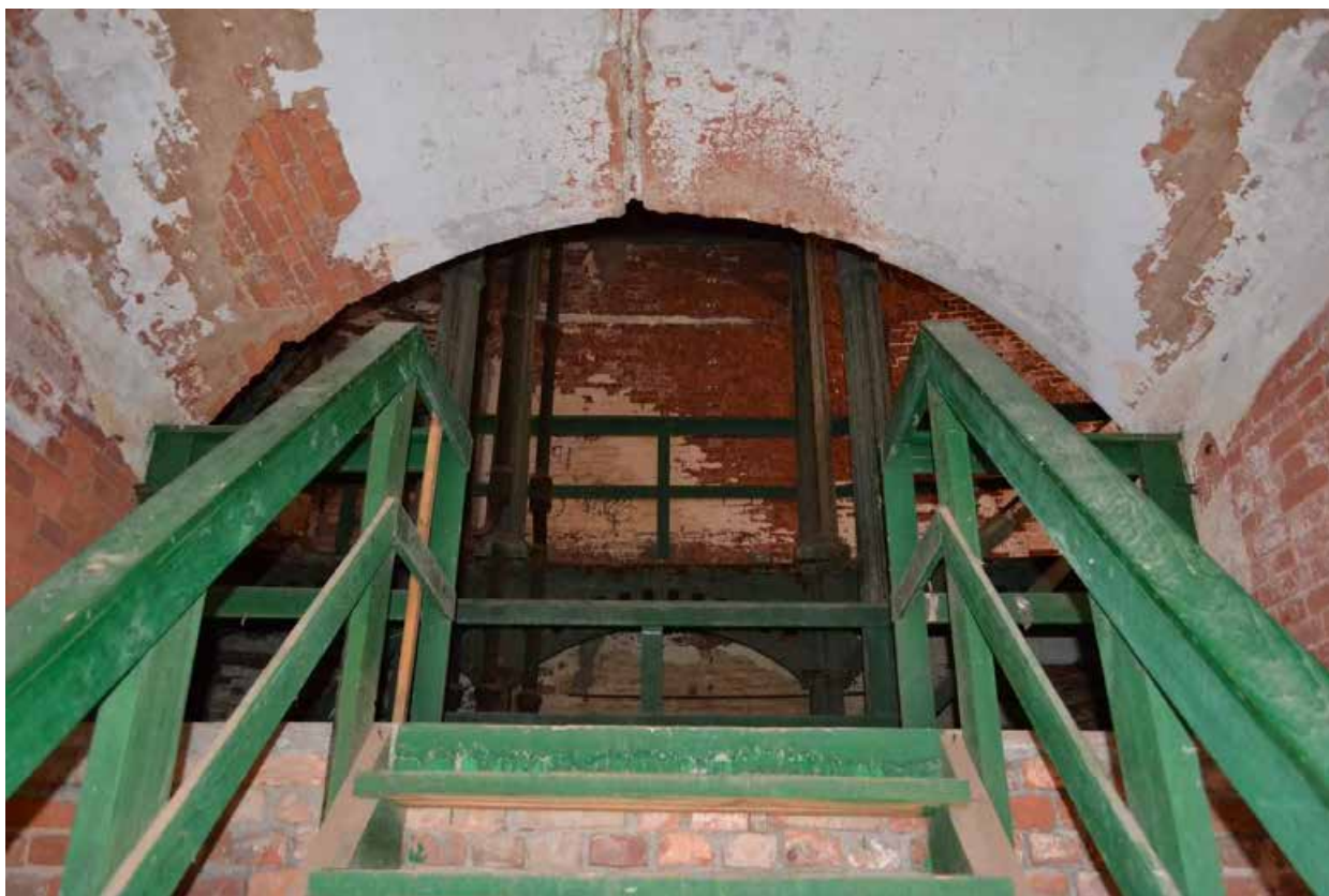
Фото 1. Вход в лестничную клетку западного объема.
