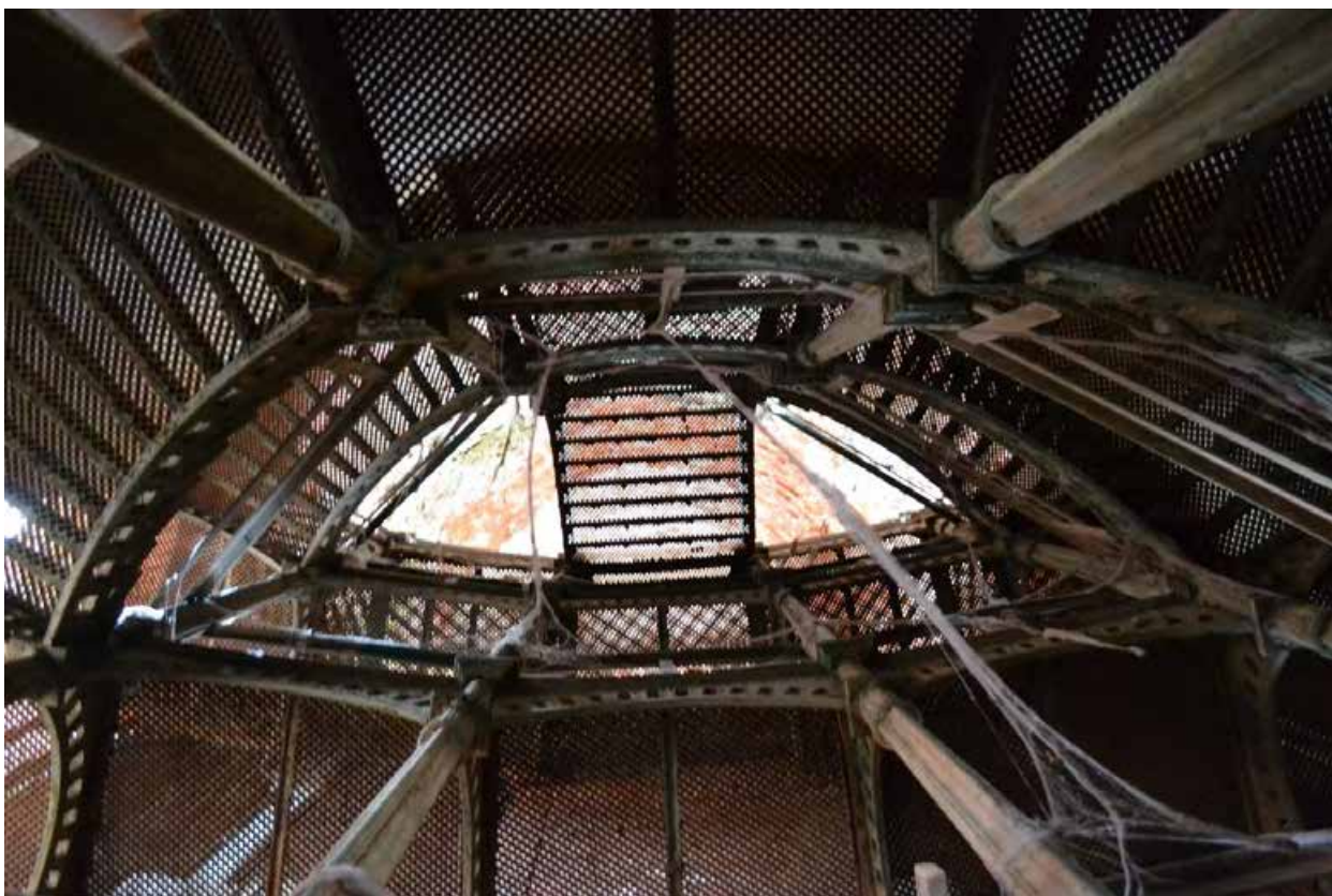
Фото 1. Общий вид чугунной лестницы в восточном объеме.
