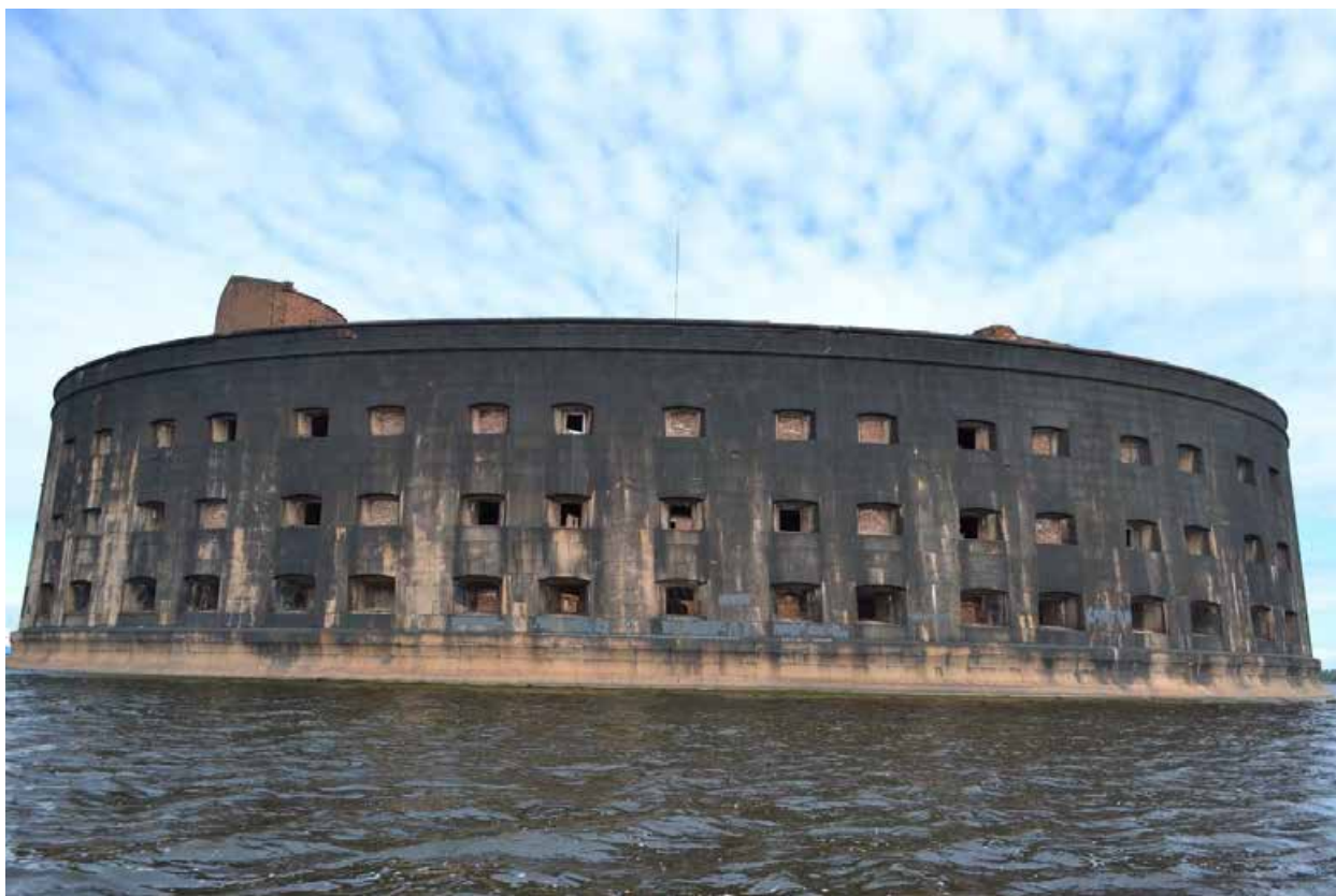
Фото 3. Форт Александр I. Южный фасад. Вид с юга.
