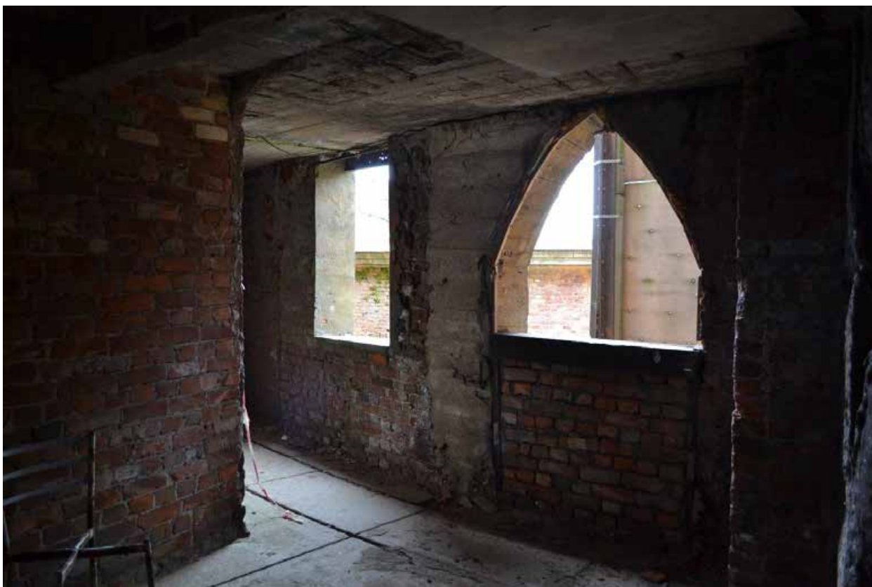
Фото 10. Казематы. Помещения третьего этажа.
