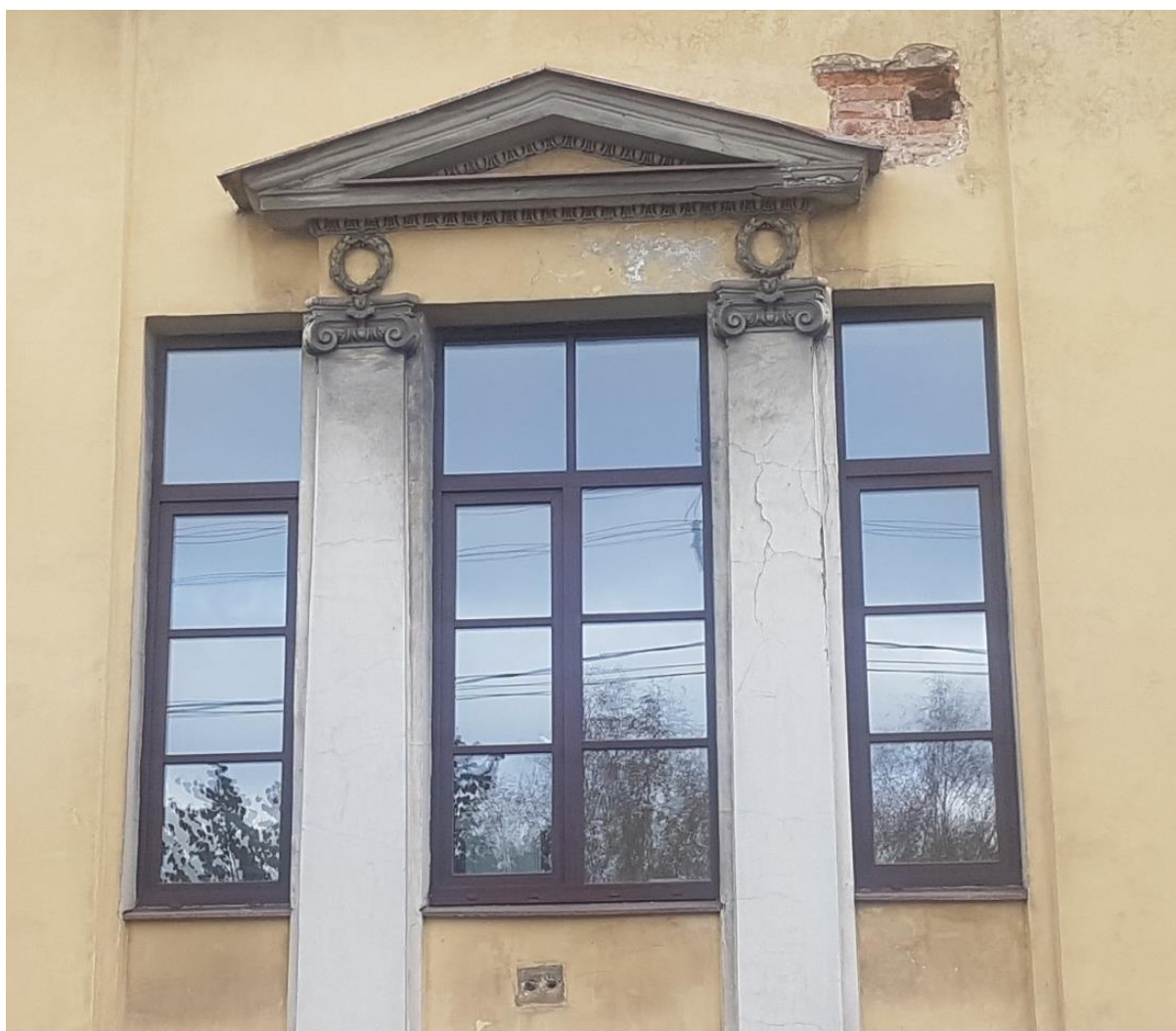
Фото 7. Лицевой фасад. Оформление оконных проемов в уровне 2-го этажа.
