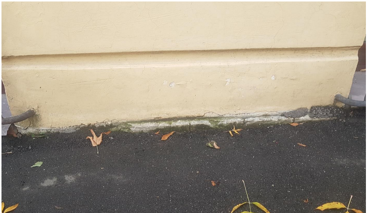
Фото 14. Южный фасад. Цоколь.
