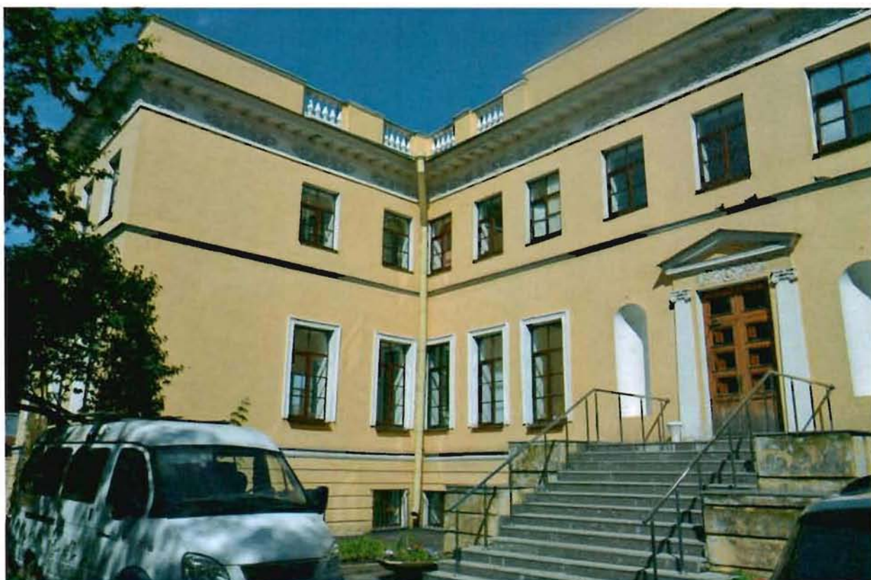
Фото 4. Фрагмент южного и восточного фасада.
