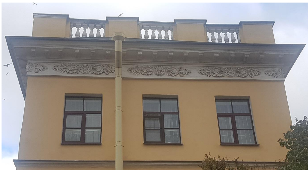
Фото 8. Южный фасад. Оконные проемы в уровне третьего этажа. Парапетное ограждение.
