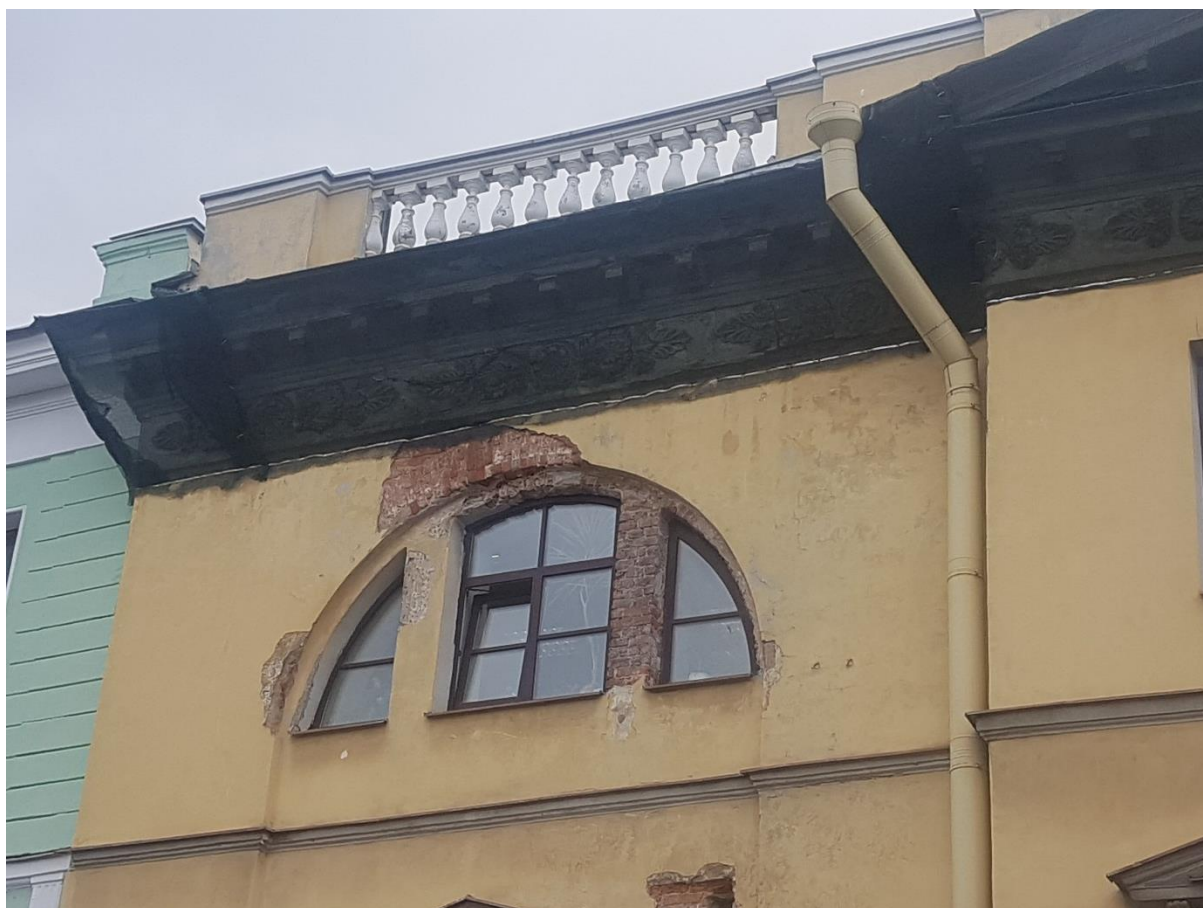
Фото 4. Лицевой фасад. Полуциркульные ниши. Профилированный венчающий карниз.
