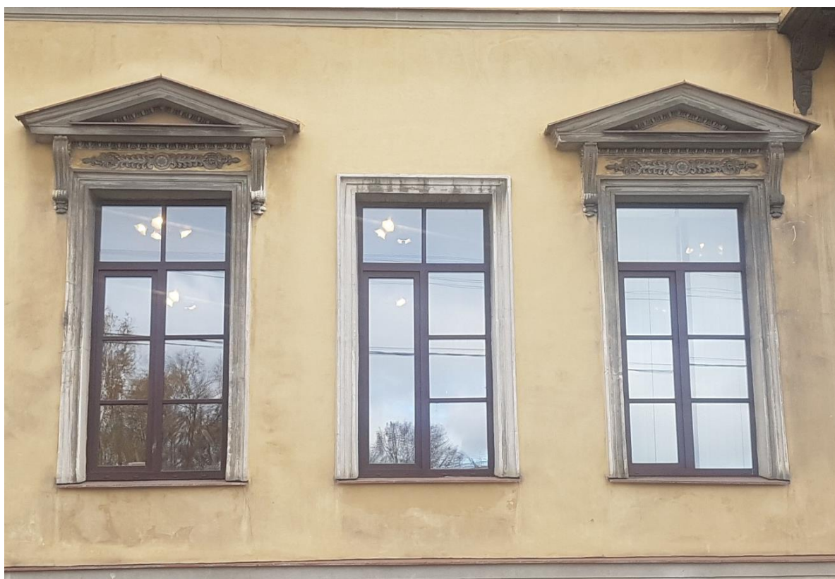
Фото 6. Лицевой фасад. Оформление оконных проемов в уровне 2-го этажа.
