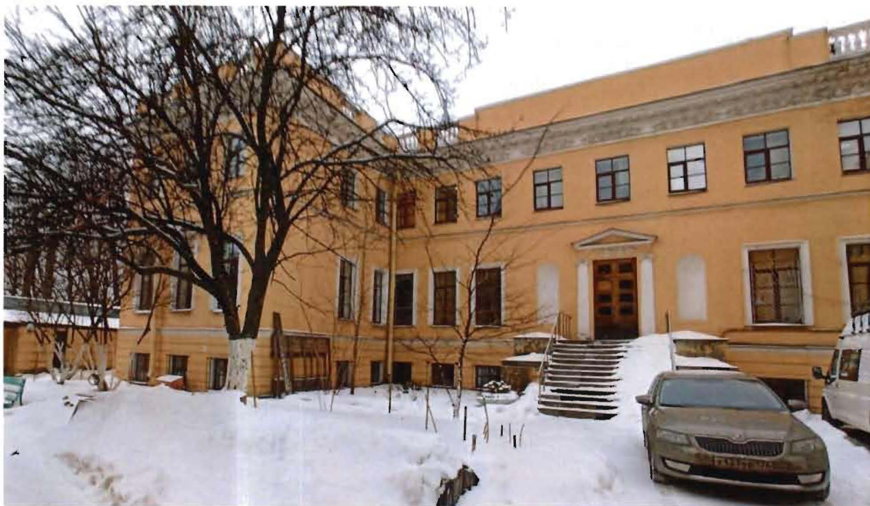
2. Вид с юго-восточной стороны на часть объекта культурного наследия (г. Санкт-Петербург, набережная реки Мойки, дом 120, литера А).
