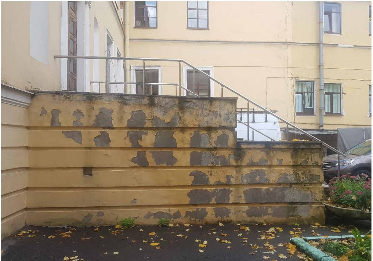
Фото 13. Южный фасад. Лестница.
