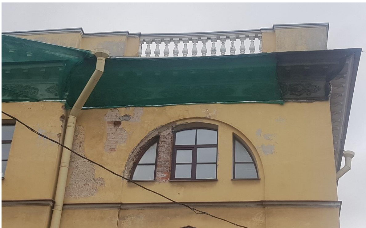
Фото 3. Лицевой фасад. Полуциркульные ниши. Профилированный венчающий карниз.
