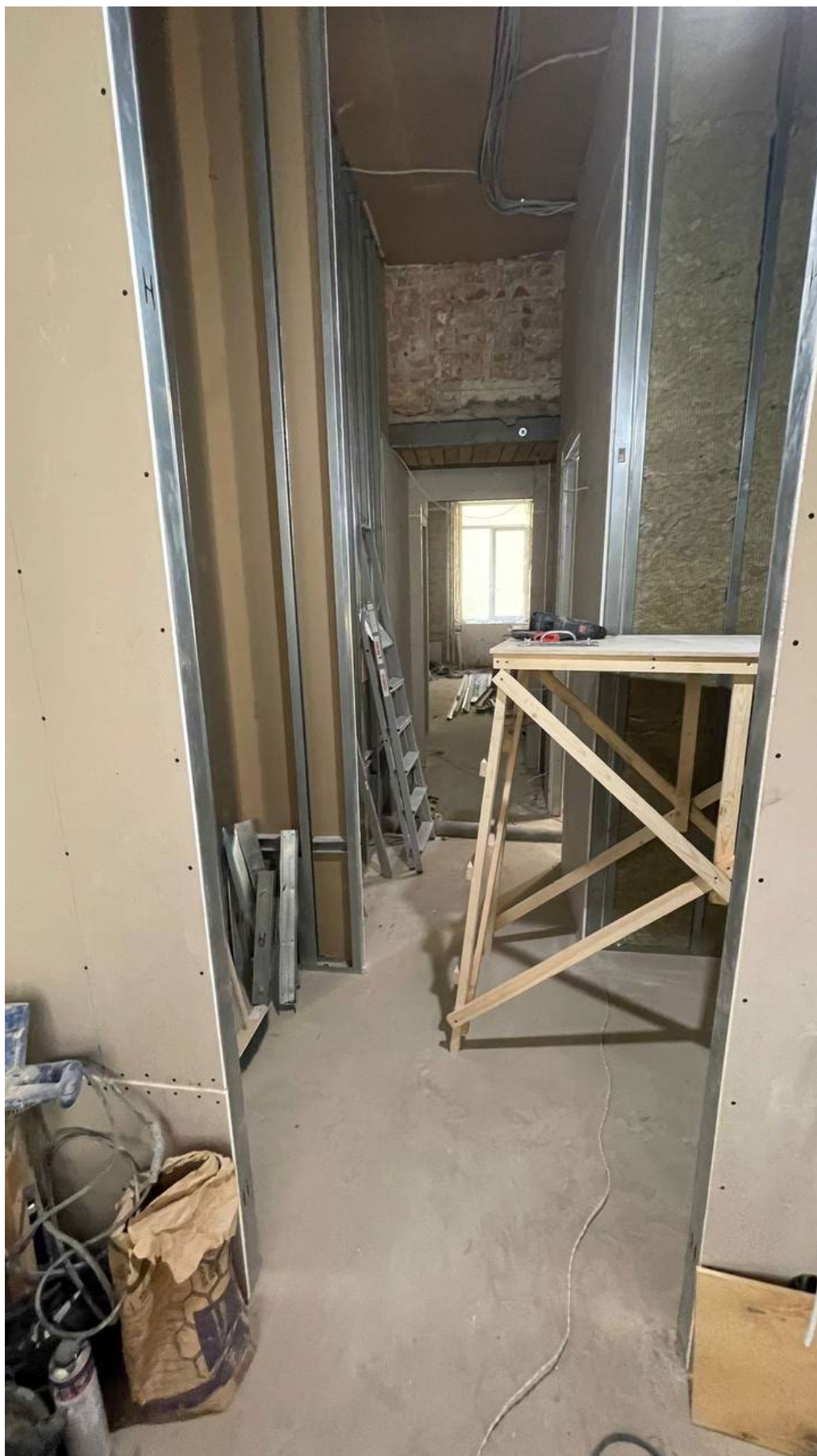
13. Фрагмент интеръера коридора (помещение №1);
