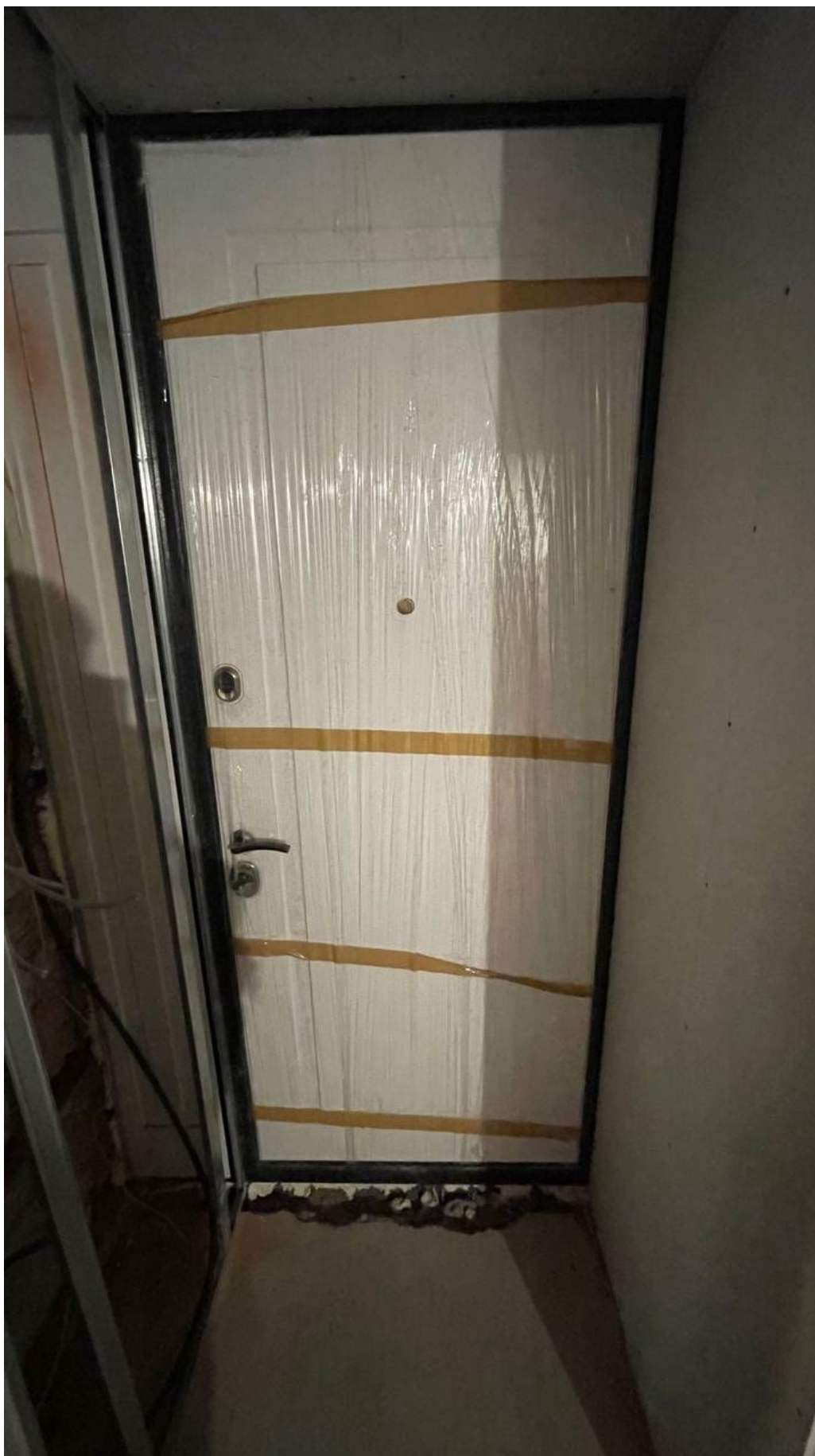
5. Вид на входную дверь в квартире.
