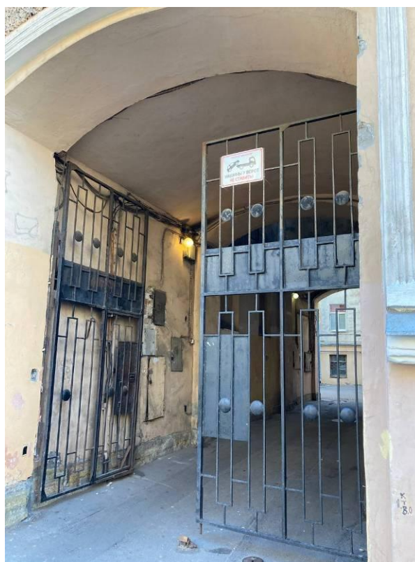
Фото 4. Лицевой фасад выявленного объекта культурного наследия «Дом Н. Протопопова», воротный проезд
