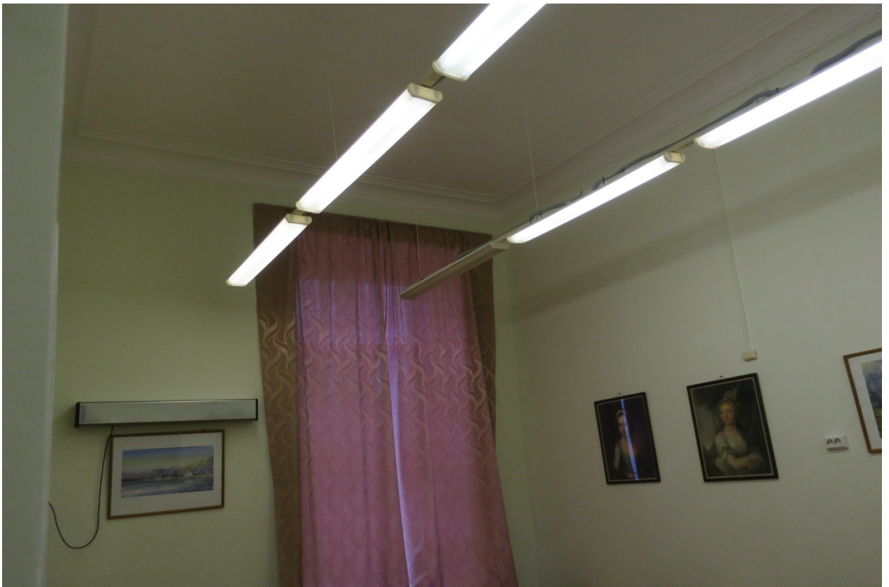
21. Помещение №18 (2-Н) в уровне 1-го этажа объекта культурного наследия федерального значения «Дача Чернышева И.Г. «Александрино», расположенного по адресу: г. Санкт-Петербург, пр. Стачек, д. 226, литера А. 11.03.2022
