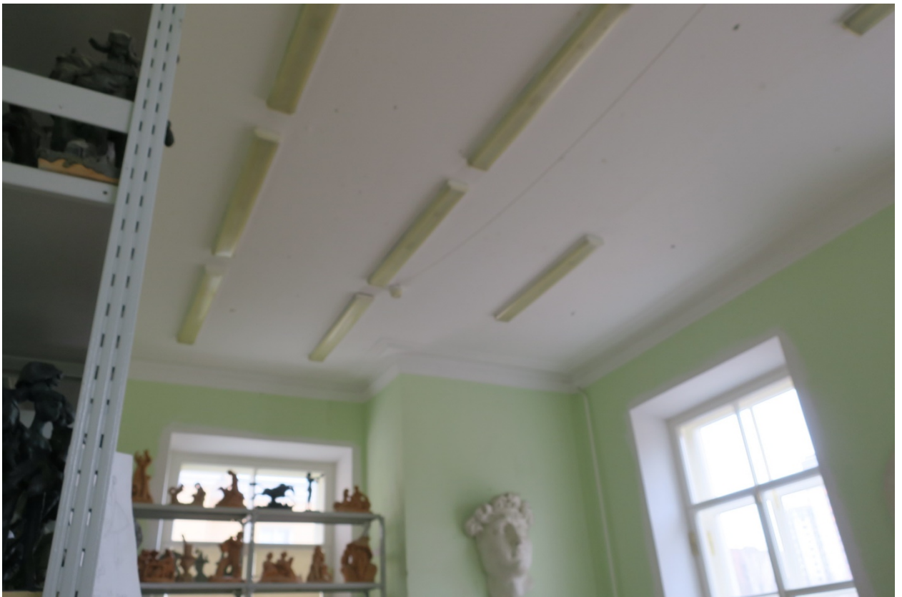
23. Помещение №17 (2-Н) в уровне 1-го этажа объекта культурного наследия федерального значения «Дача Чернышева И.Г. «Александрино», расположенного по адресу: г. Санкт-Петербург, пр. Стачек, д. 226, литера А. 11.03.2022
