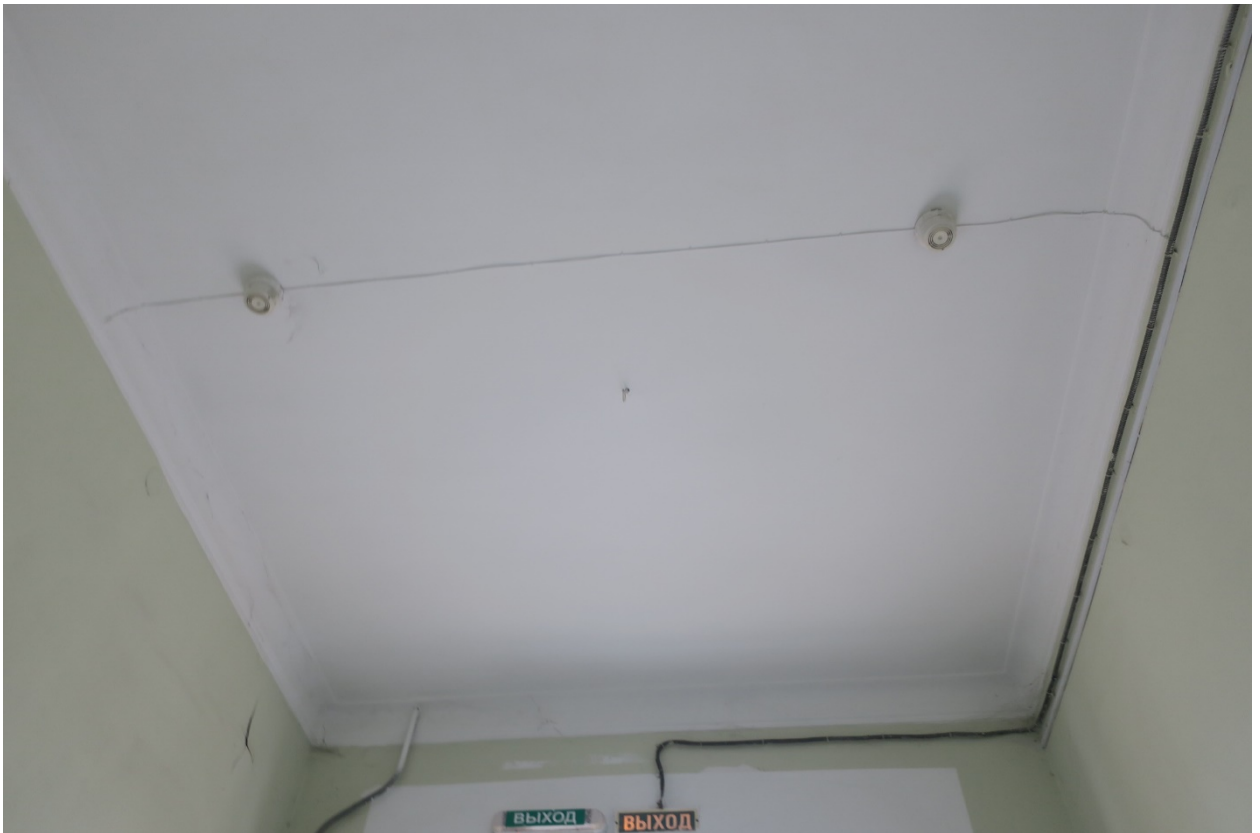
22. Помещение №18 (2-Н) в уровне 1-го этажа объекта культурного наследия федерального значения «Дача Чернышева И.Г. «Александрино», расположенного по адресу: г. Санкт-Петербург, пр. Стачек, д. 226, литера А. 11.03.2022
