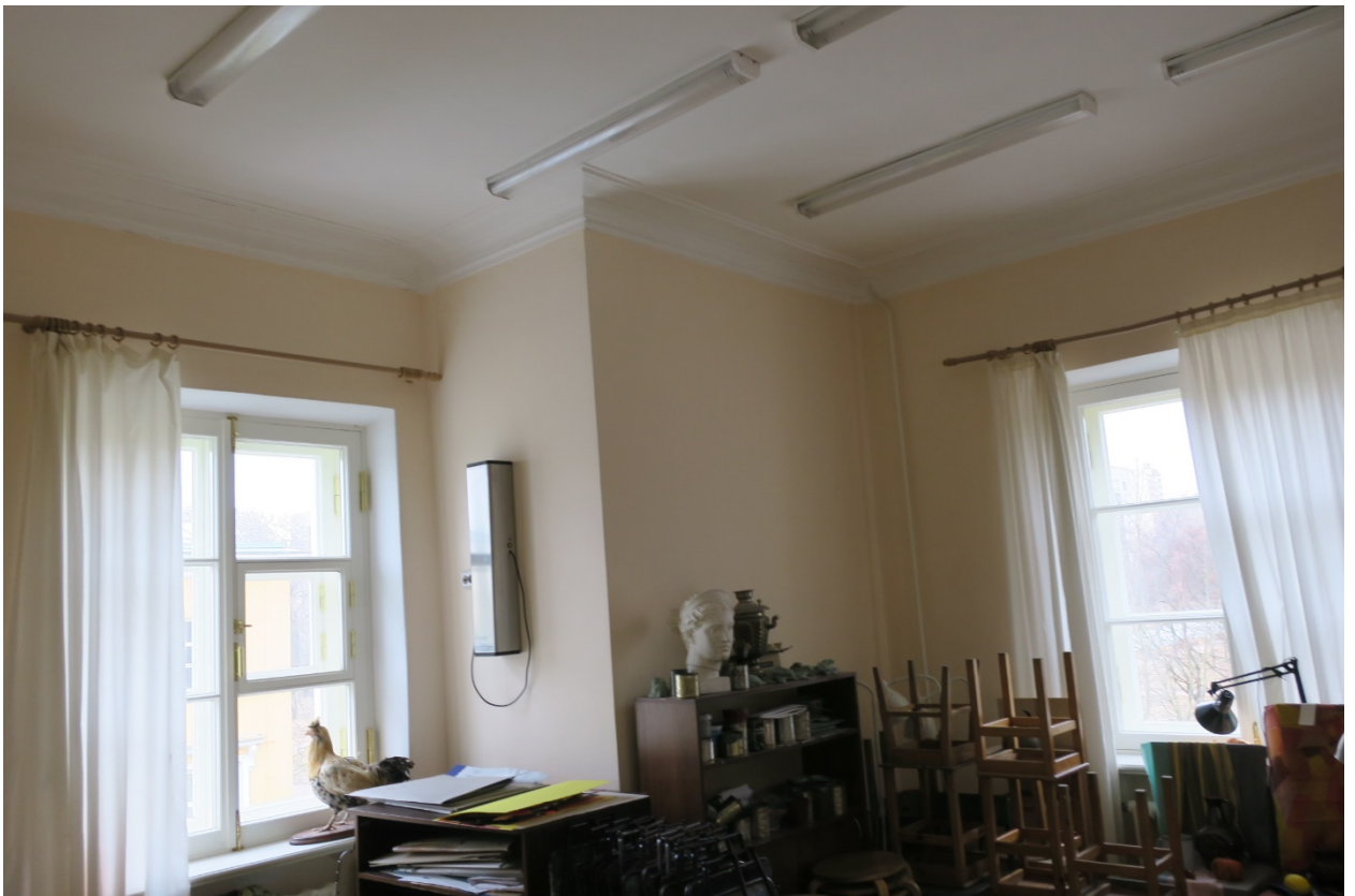
24. Помещение №19 (2-Н) в уровне 1-го этажа объекта культурного наследия федерального значения «Дача Чернышева И.Г. «Александрино», расположенного по адресу: г. Санкт-Петербург, пр. Стачек, д. 226, литера А. 11.03.2022
