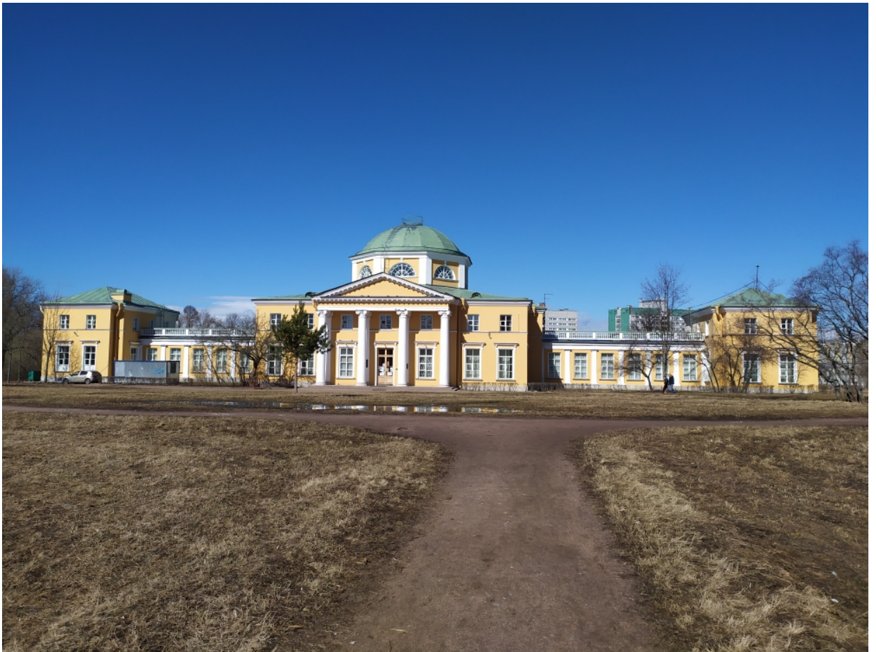
1. Юго- восточный фасад объекта культурного наследия федерального значения «Дача Чернышева И.Г. «Александрино», расположенного по адресу: г. Санкт-Петербург, пр. Стачек, д. 226, литера А. 11.03.2022
