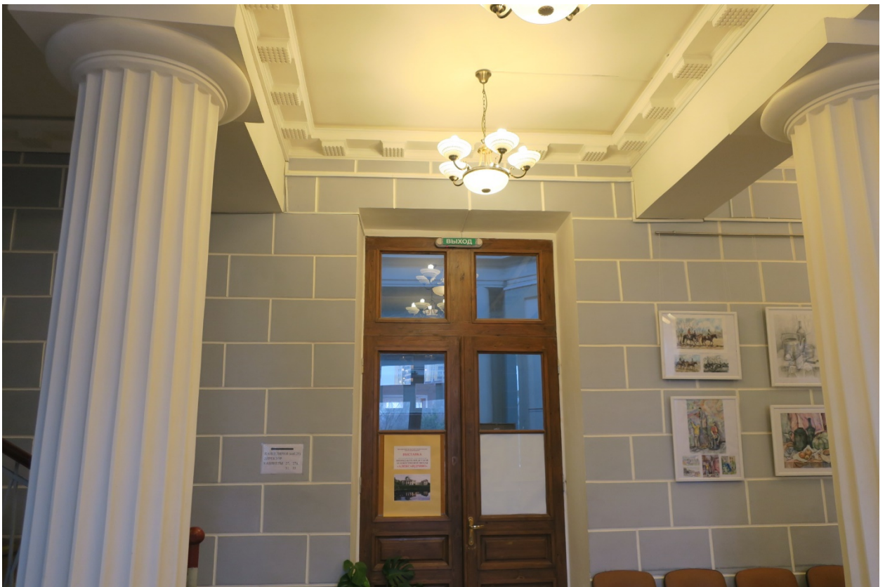
3. Помещение № 32 (2-Н) в уровне 1-го этажа объекта культурного наследия федерального значения «Дача Чернышева И.Г. «Александрино», расположенного по адресу: г. Санкт-Петербург, пр. Стачек, д. 226, литера А. 11.03.2022
