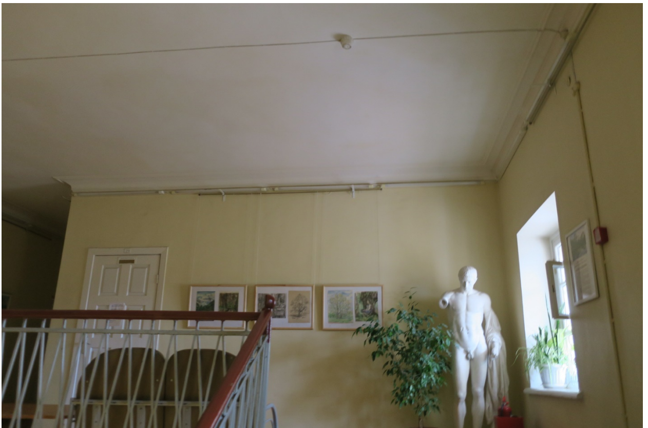
28. Помещение №1 (2-Н) в уровне 2-го этажа объекта культурного наследия федерального значения «Дача Чернышева И.Г. «Александрино», расположенного по адресу: г. Санкт-Петербург, пр. Стачек, д. 226, литера А. 11.03.2022
