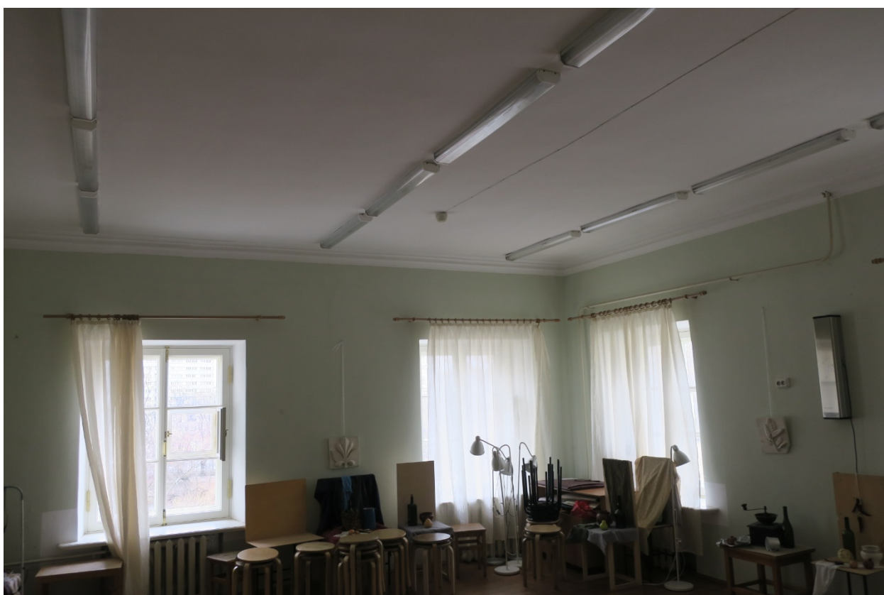
35. Помещение №13 (2-Н) в уровне 2-го этажа объекта культурного наследия федерального значения «Дача Чернышева И.Г. «Александрино», расположенного по адресу: г. Санкт-Петербург, пр. Стачек, д. 226, литера А. 11.03.2022
