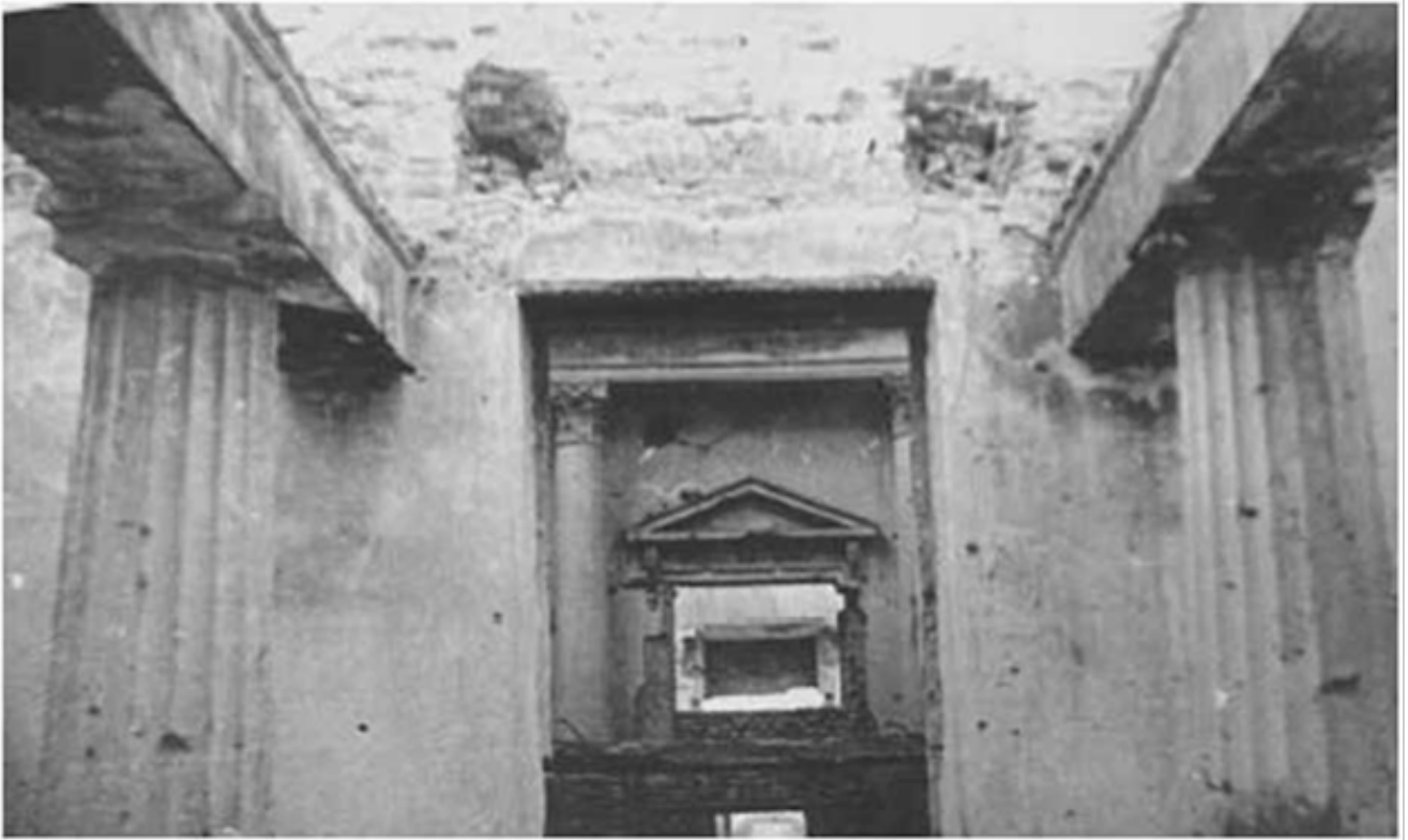
17. Вестибюль. Вид на север. 1940-е гг. // КГИОП. Инв. №: Н-15188
