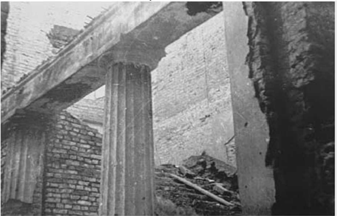
18. Вестибюль. Вид на юго-запад. 1940-е гг. // КГИОП. Инв. №: Н-15188
