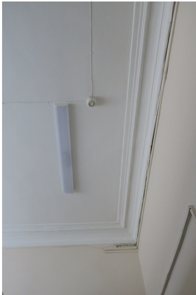
14. Помещение № 4 (2-Н) в уровне 1-го этажа объекта культурного наследия федерального значения «Дача Чернышева И.Г. «Александрино», расположенного по адресу: г. Санкт-Петербург, пр. Стачек, д. 226, литера А. 11.03.2022
