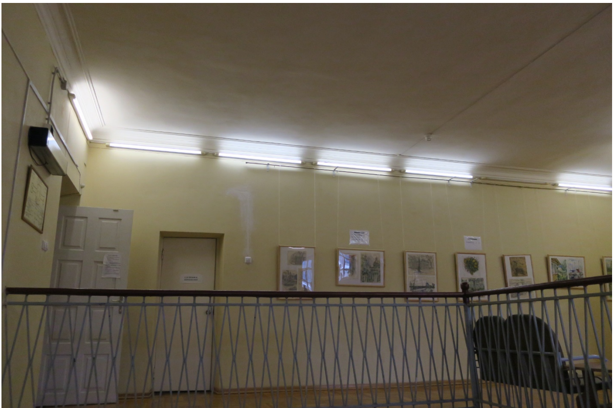
29. Помещение №1 (2-Н) в уровне 2-го этажа объекта культурного наследия федерального значения «Дача Чернышева И.Г. «Александрино», расположенного по адресу: г. Санкт-Петербург, пр. Стачек, д. 226, литера А. 11.03.2022
