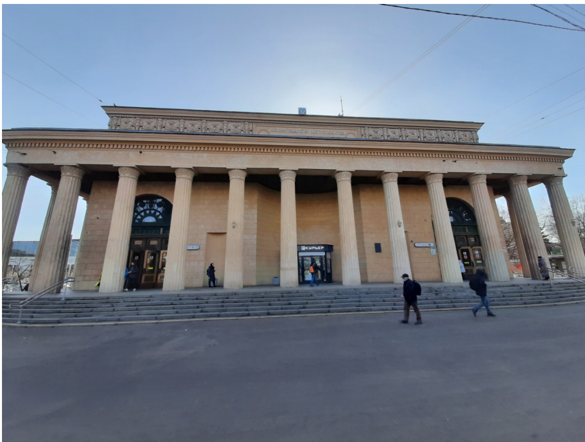
Фото 1 Лицевой фасад объекта культурного наследия регионального значения «Станция метро «Кировский завод», г. Санкт-Петербург, пр. Стачек, д. 70, литера А.
