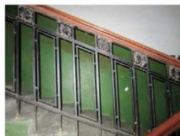
лестница – местоположение (дворовый корпус), тип (двухмаршевая), вид материала ступеней (плиты из известняка), ограждение – вид материала (металл), техника исполнения (ковка), рисунок (вертикальные стойки с розетками);
