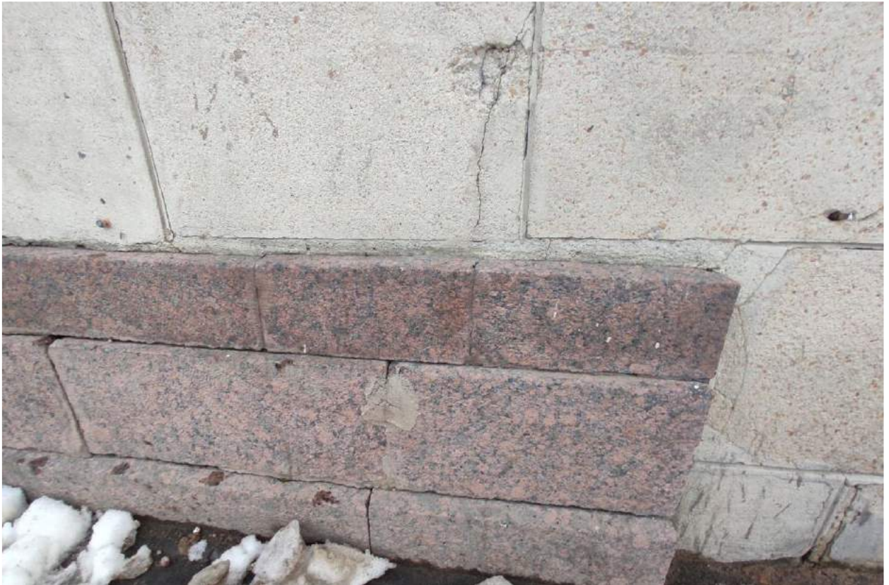
Фото 13. Фасад 1-4 Следы выветривания шовного раствора. Поздние цементные вставки, трещины в штукатурном слое, деструкция терразитовой штукатурки
