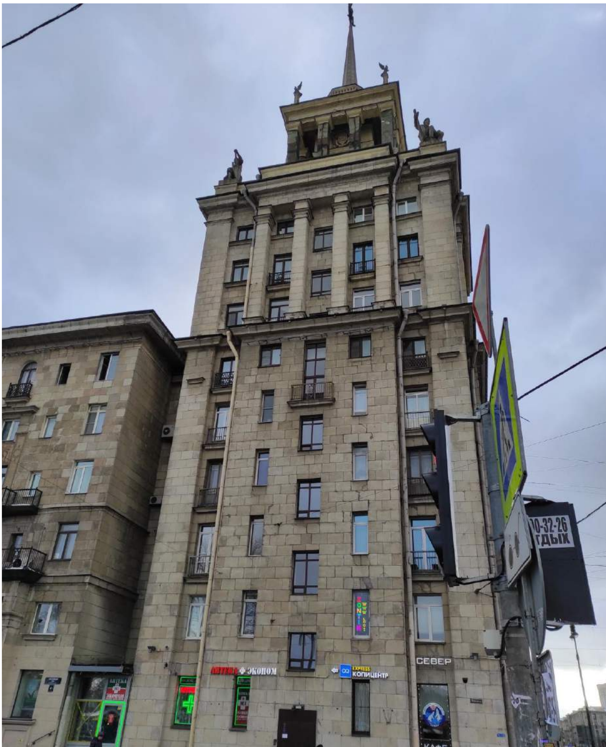
Фото 1. Фасад Г-А. Общий вид
