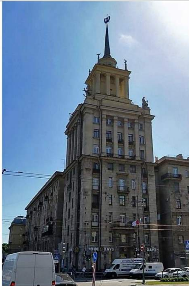
Фото 1.Общий вид здания – башни со стороны Московского пр – та.
