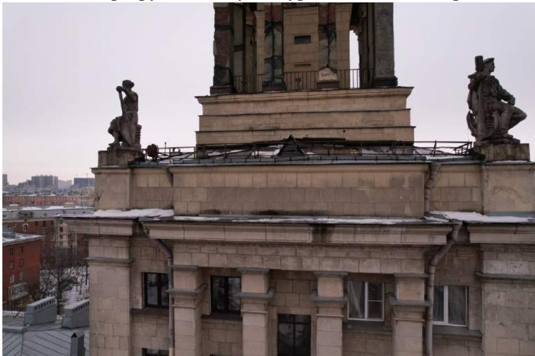
Фото 28. Фасад Г-А. деструкция штукатурного слоя, высолы, поздние цементные вставки, Трещины, коррозия линейных покрытий и покрытия кровли, разрушение штукатурного слоя колонн до кирпичного основания, разрушение скульптур из бетона, биопоражения
