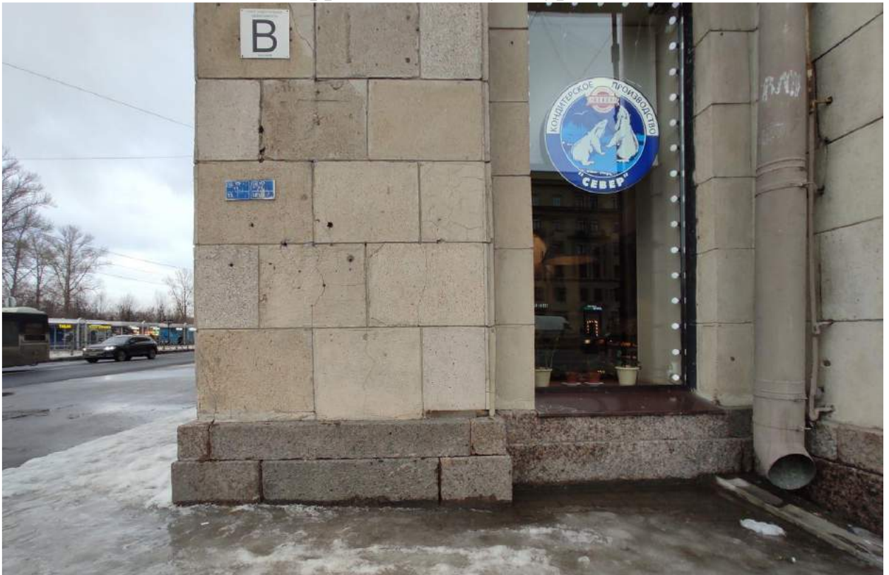
Фото 13. Фасад 1-4 Следы выветривания шовного раствора. Поздние цементные вставки, трещины в штукатурном слое, деструкция терразитовой штукатурки
