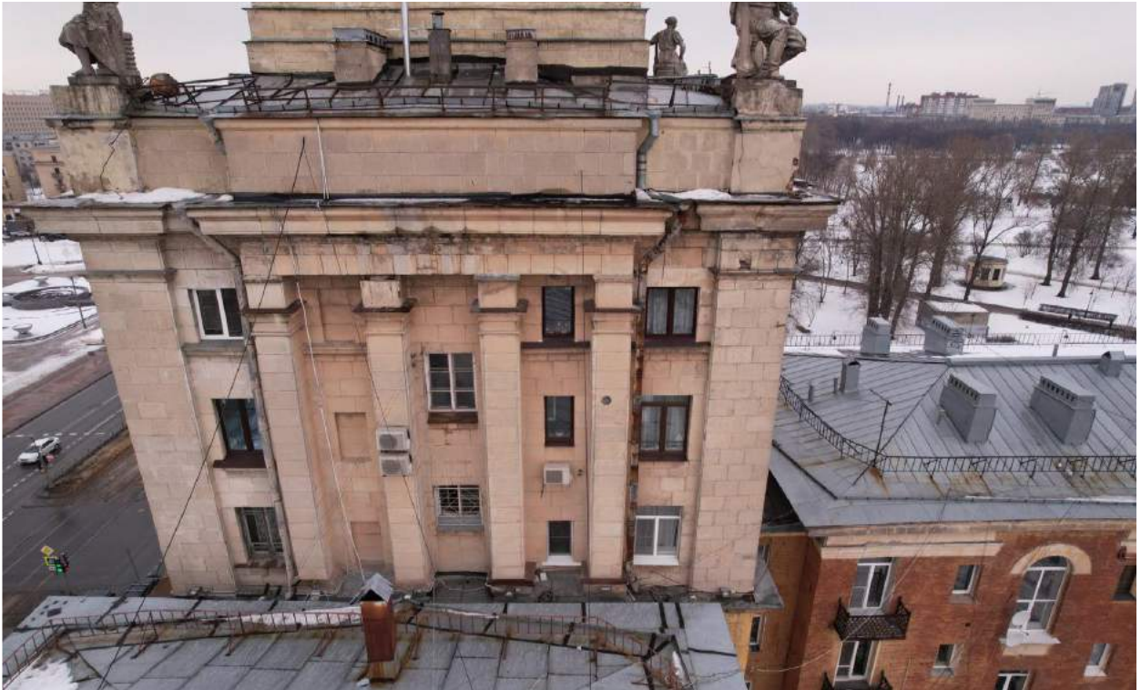
Фото 28. Фасад Г-А. деструкция штукатурного слоя, высолы, поздние цементные вставки, Трещины, коррозия линейных покрытий и покрытия кровли, разрушение штукатурного слоя колонн до кирпичного основания, разрушение скульптур из бетона, биопоражения
