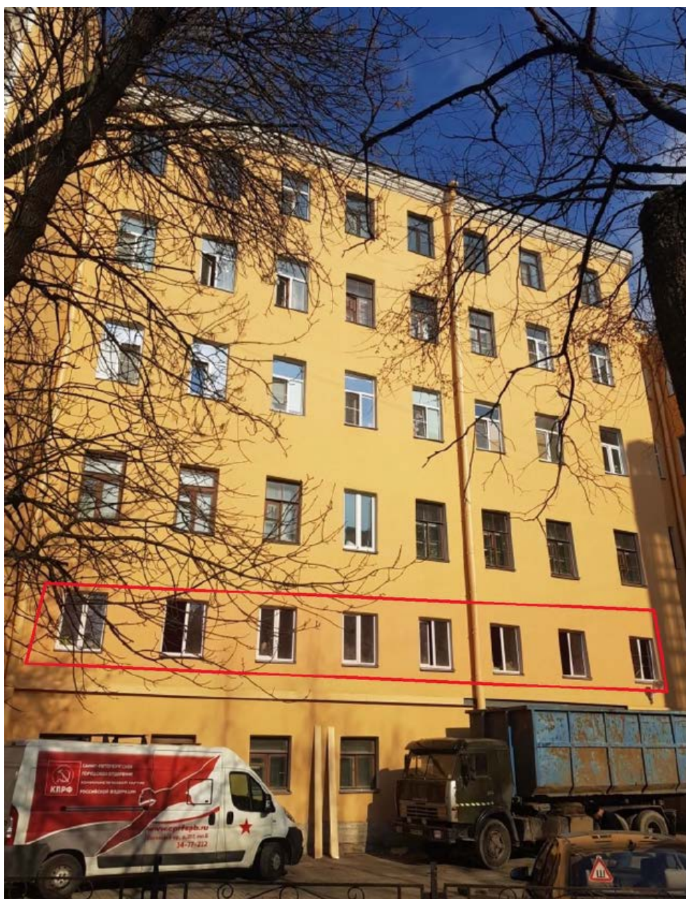
2. Юго-западный дворовый фасад объекта культурного наследия регионального значения «Дом по 2-ой Советской ул. с дворовым флигелем», расположенного по адресу: г. Санкт-Петербург, 2-ая Советская ул., 27/2, литера А, входящего в состав объекта культурного наследия регионального значения «Дом Галунова И.В.».
