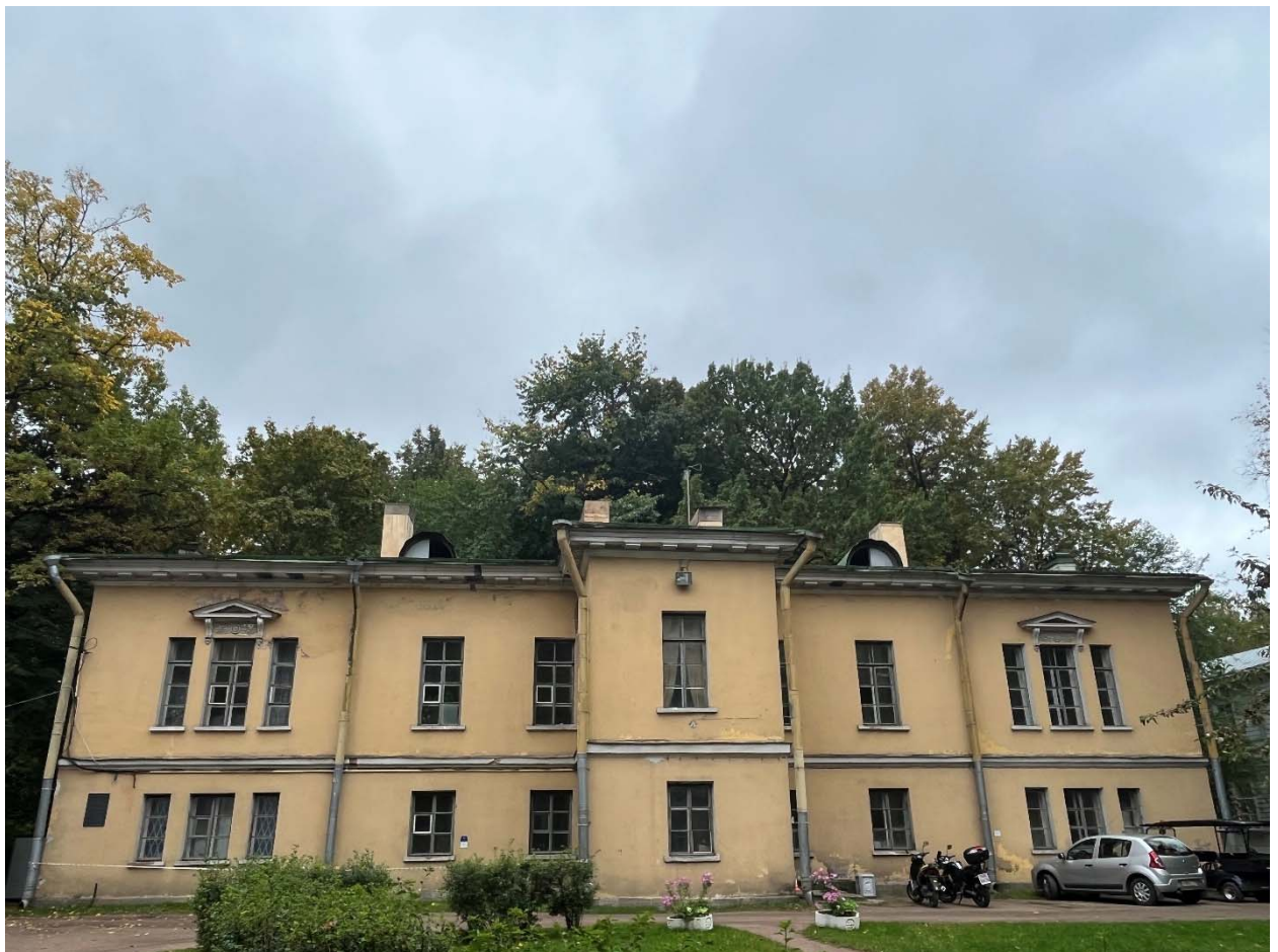
Фото №1. Северный фасад, общий вид.
