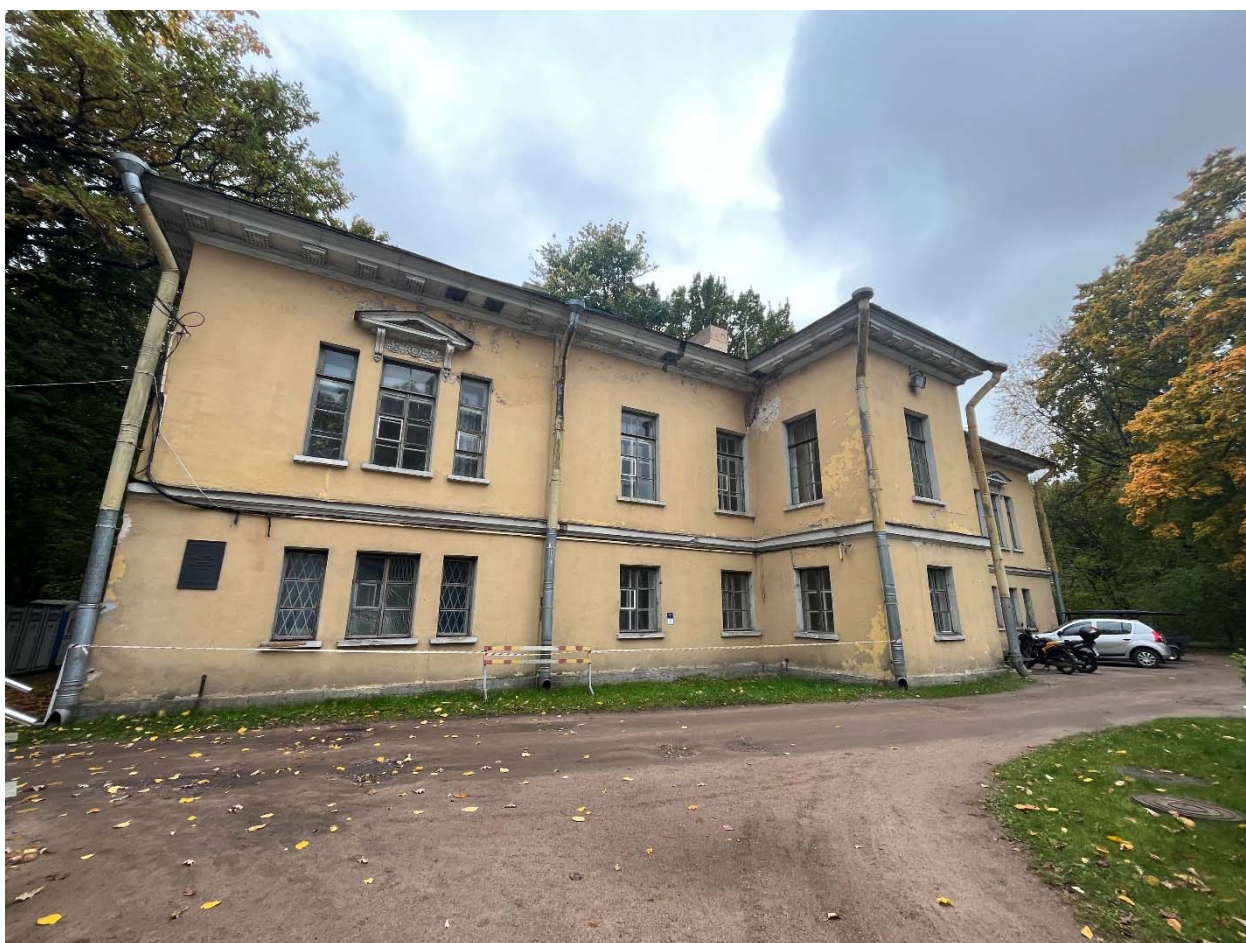
Фото №2. Северный фасад, общий вид.
