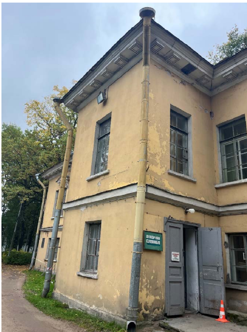
Фото №11. Южный фасад, ризалит, вход в здание.
