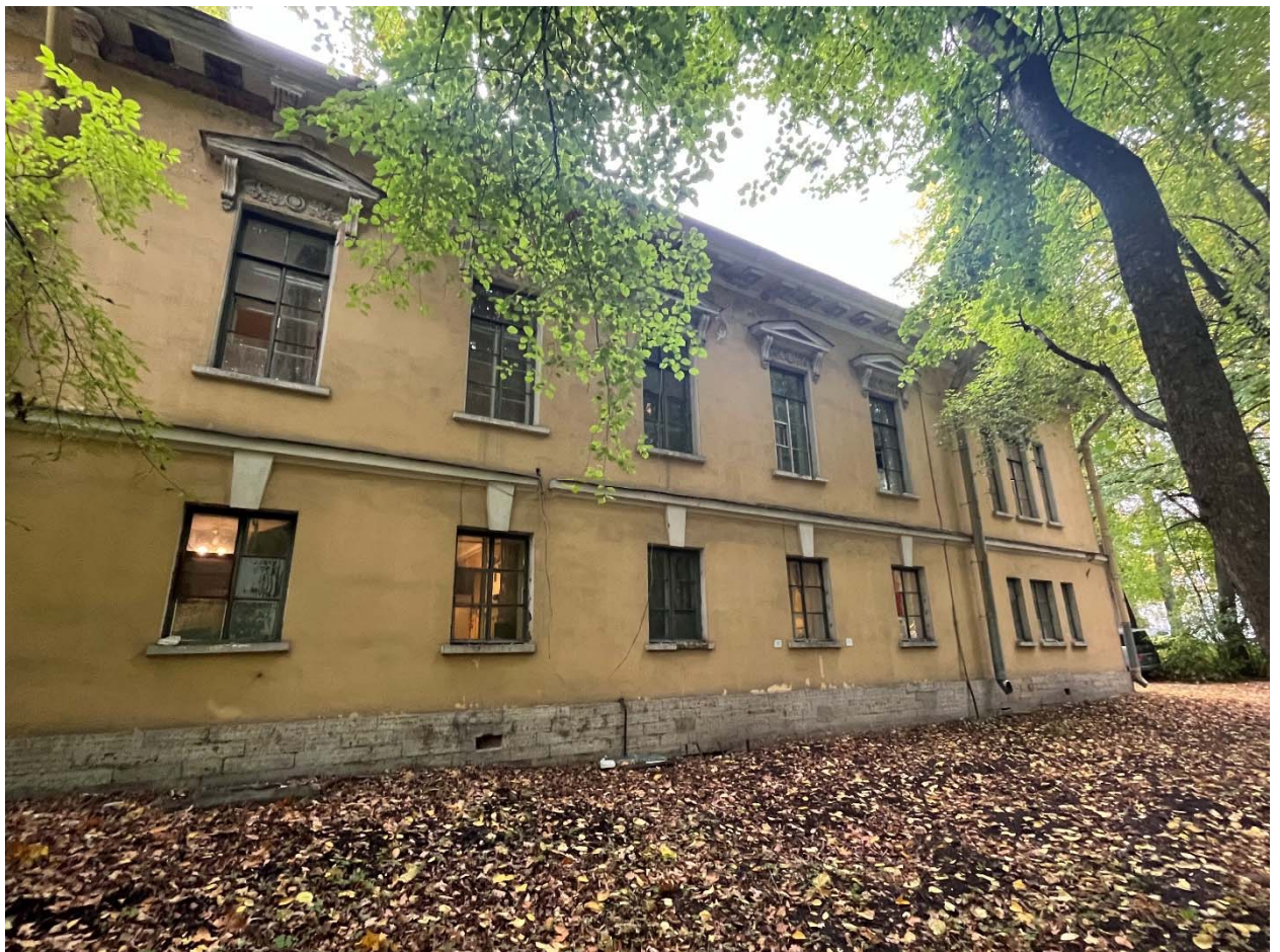
Фото №6. Южный фасад, общий вид.
