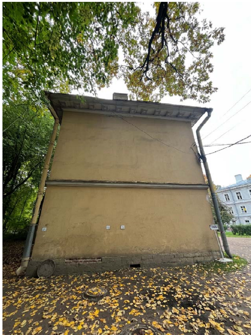
Фото №4. Восточный фасад, общий вид.
