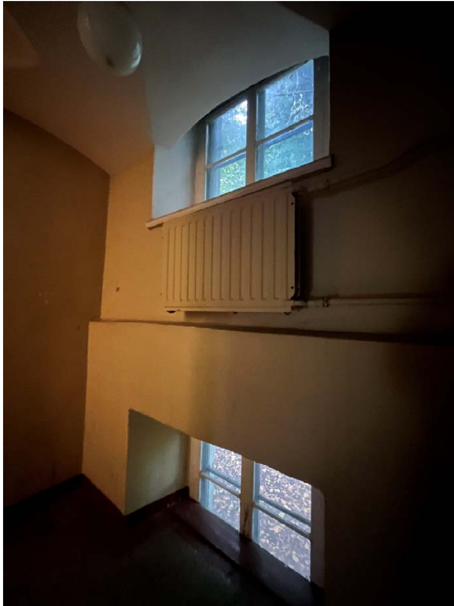
Фото №32. Помещение №1-Н, лестничная клетка.
