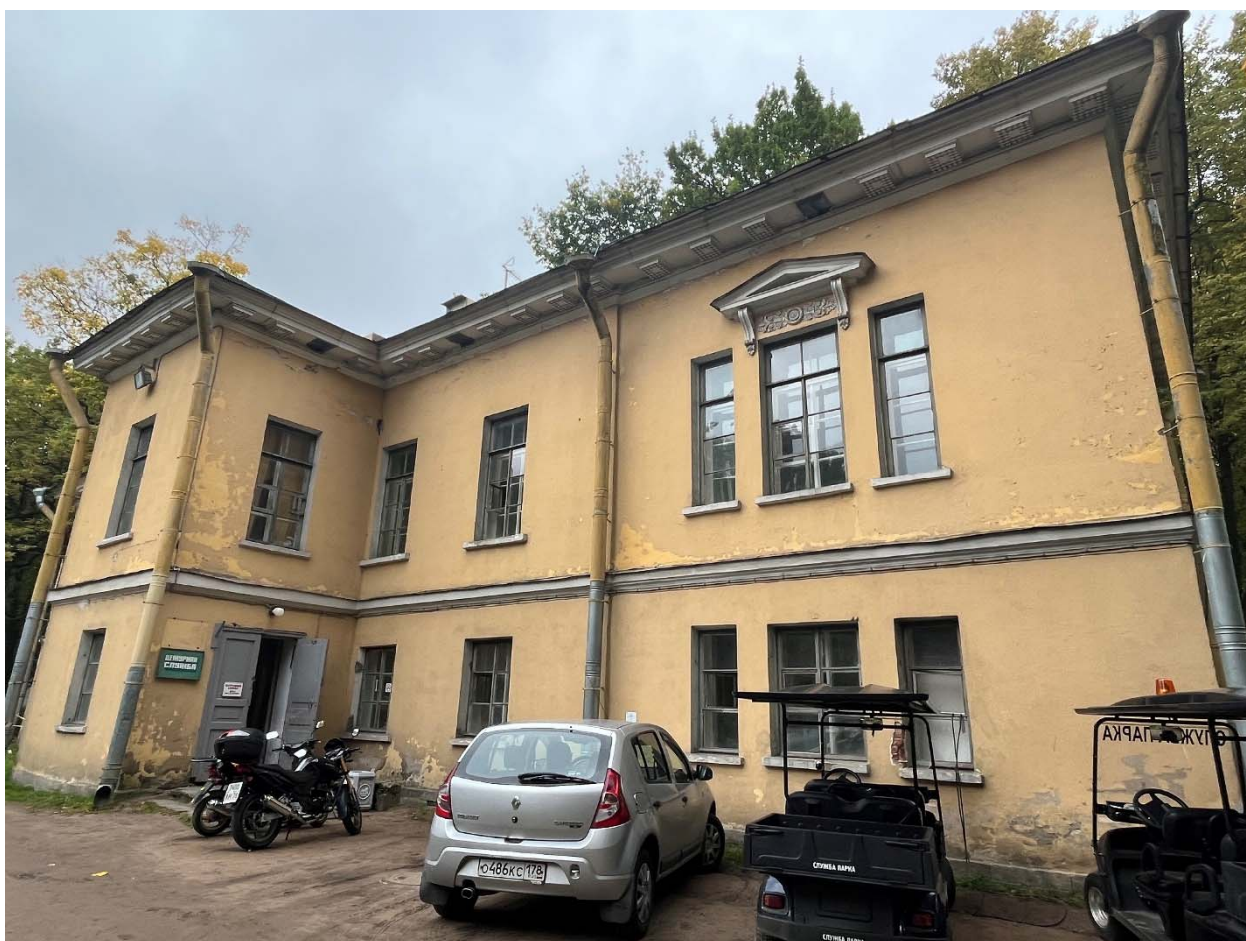
Фото №10. Южный фасад, общий вид.
