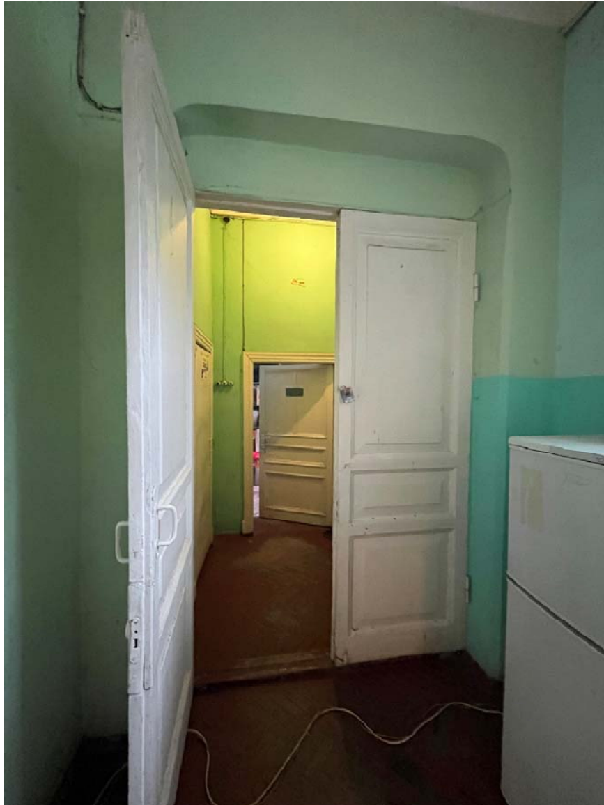
Фото №38. Помещение №1-Н(35).
