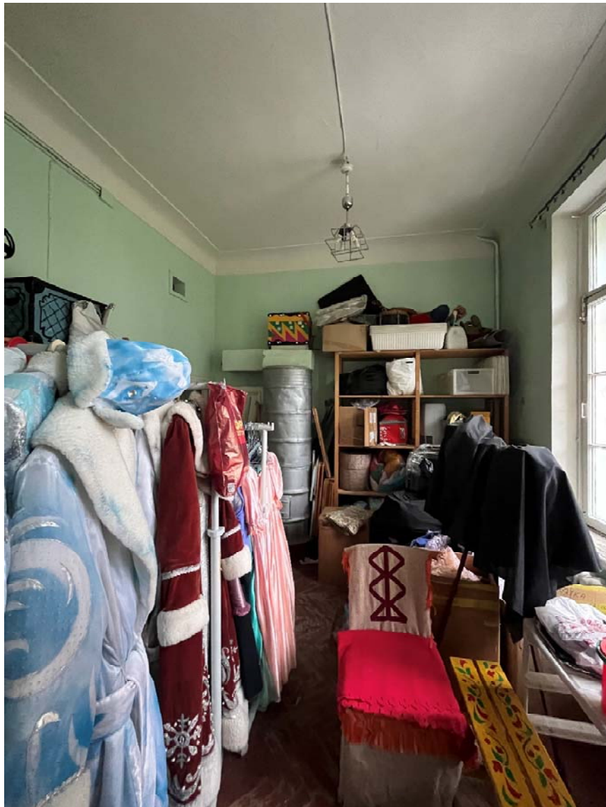
Фото №39. Помещение №1-Н(32).
