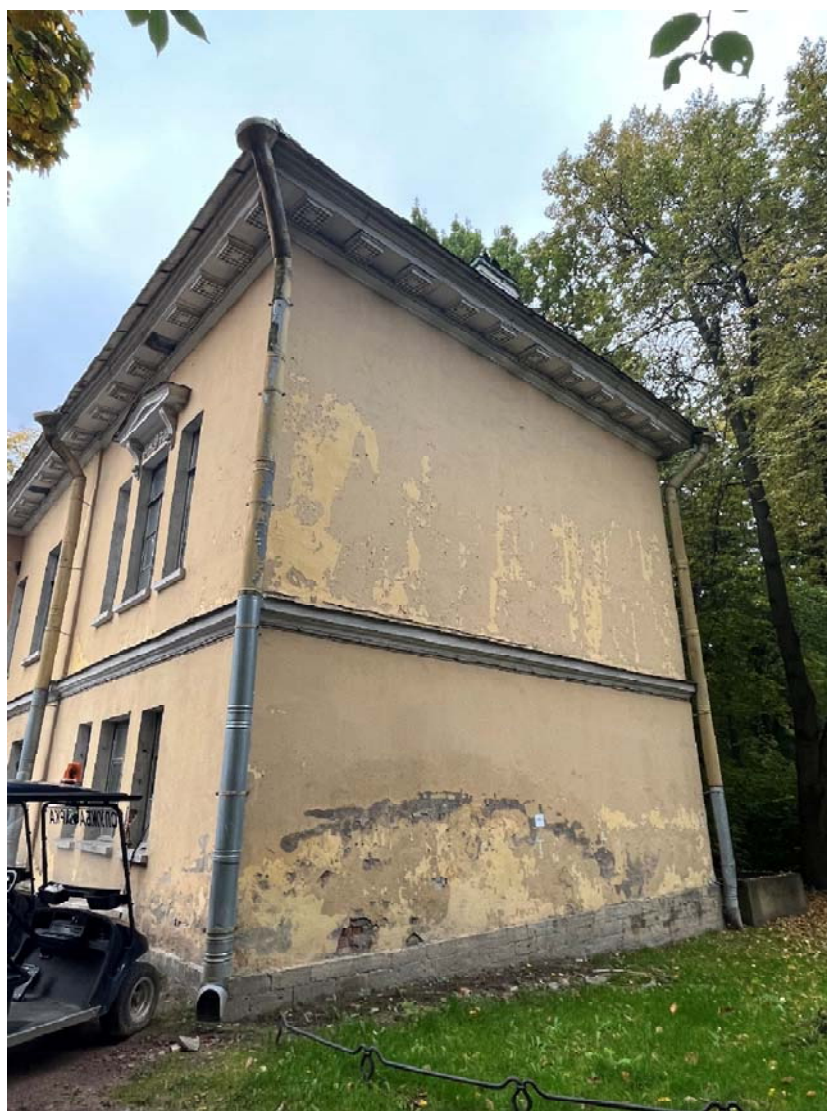
Фото №8. Западный фасад, общий вид.
