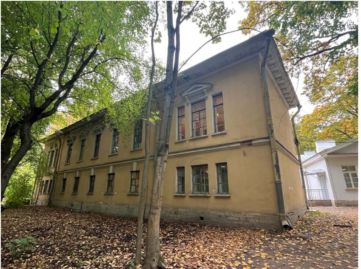
Фото №5. Южный фасад, общий вид.
