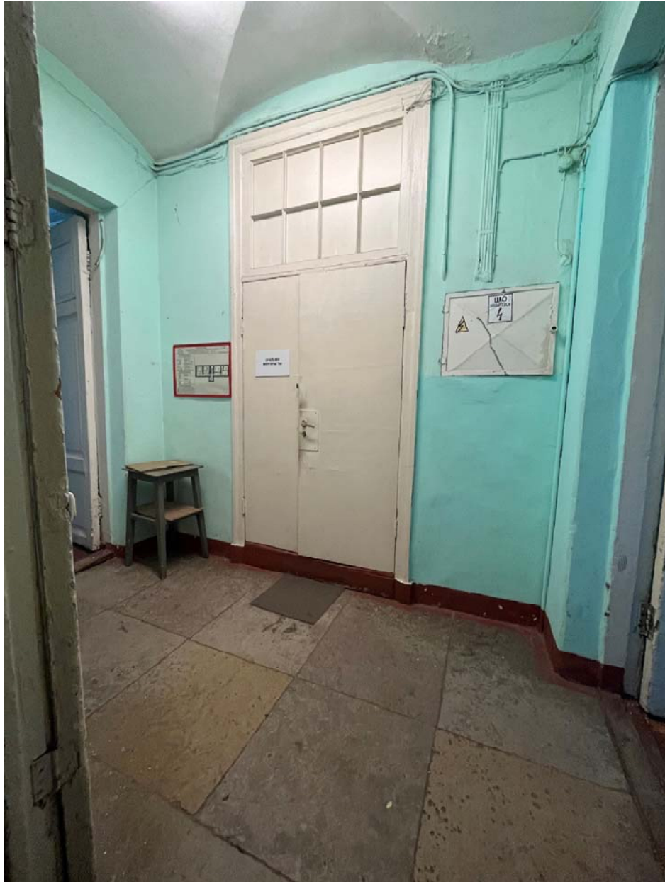
Фото №34. Помещение №1-Н(19).
