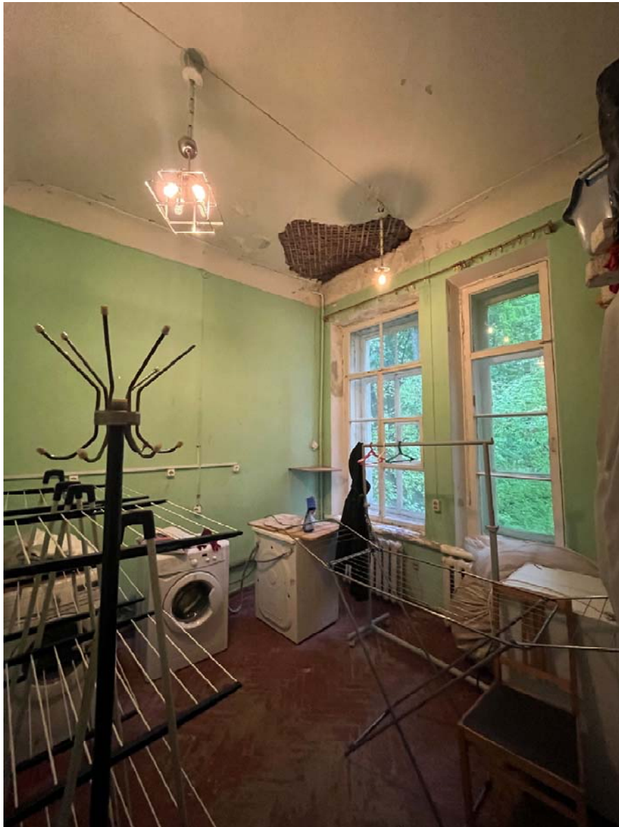
Фото №41. Помещение №1-Н(31).
