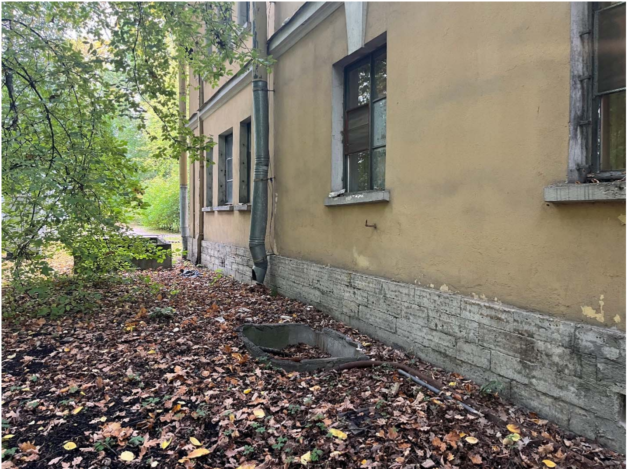
Фото №7. Южный фасад, цокольная часть.
