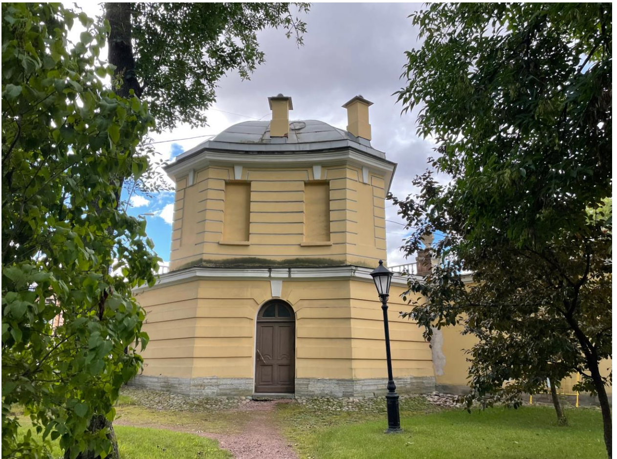
Фото 4. Северный фасад здания павильона.
