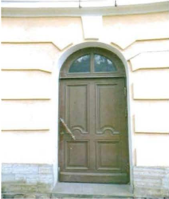
5. Входной дверной проем
