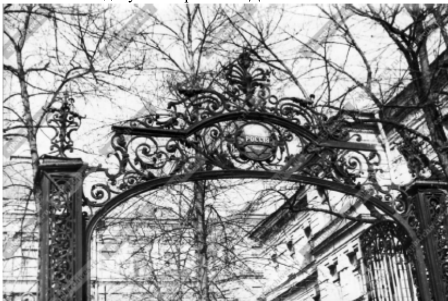
16. Вид верхней части ограды жилого дома № 27-29 по Моховой улице (бывший жилой дом страхового общества "Россия", архитекторы Л.Н.Бенуа, Н.Д.Прокофьев, конец 1890-х годов). ЦГАКФФД СПб. Фотодокумент Ар 230700 Дата съёмки: 05 мая 1978 г.
