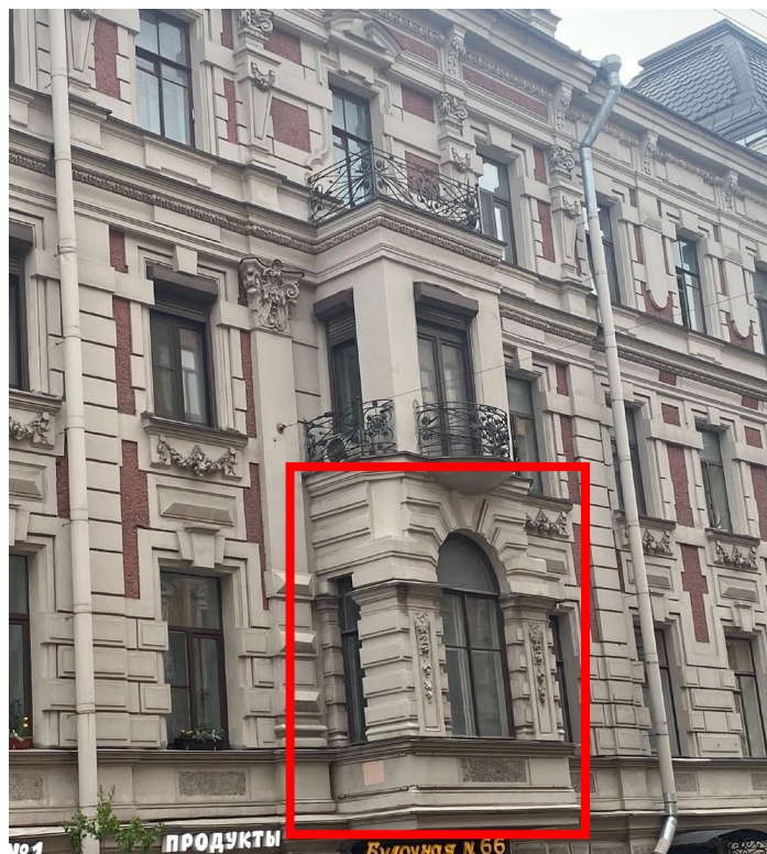
2. Фрагмент лицевого фасада на Моховой ул.
