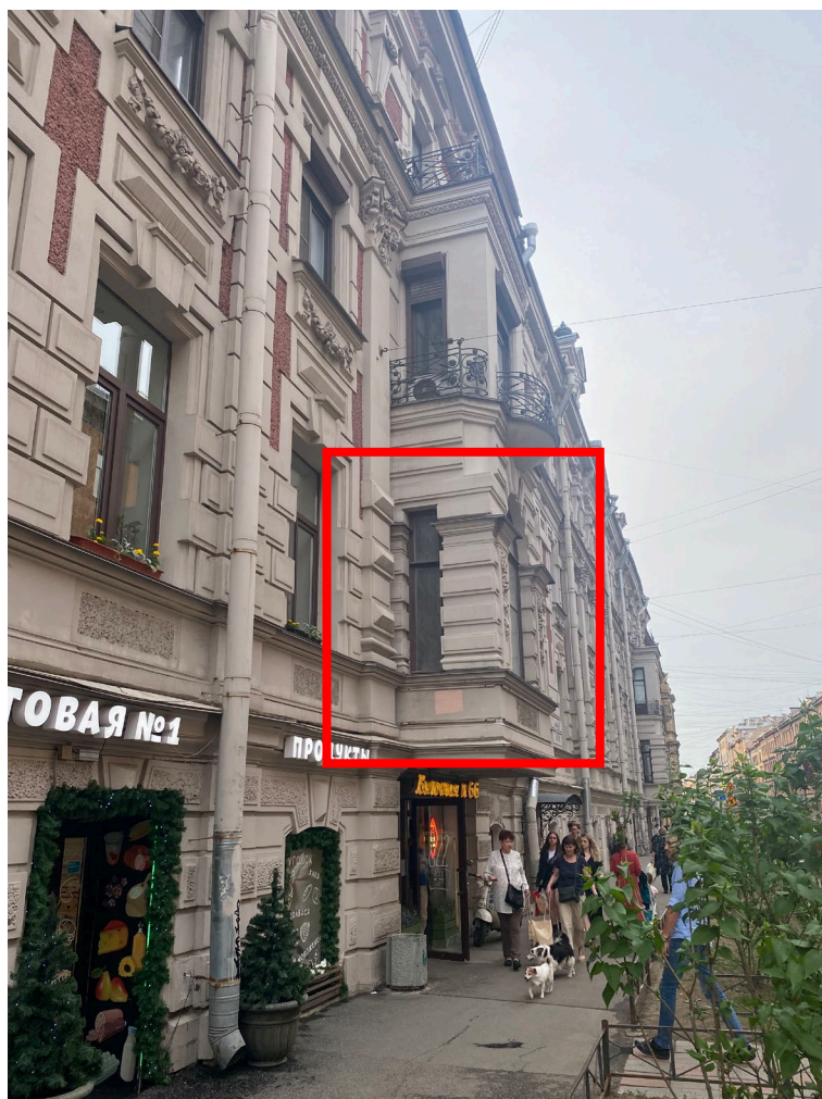
1. Лицевой фасад на Моховой ул.
