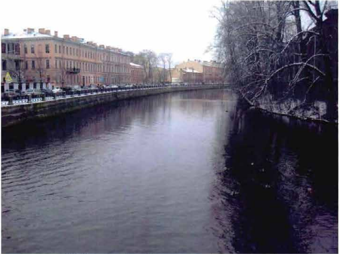
15. Набережные. Вид с Поцелуева моста (по течению реки)
