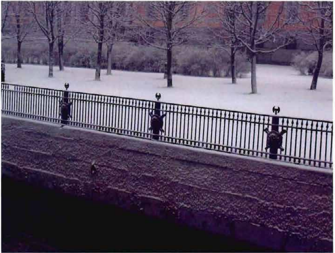
3. Ограждение набережной со стороны Михайловского (Инженерного) замка
