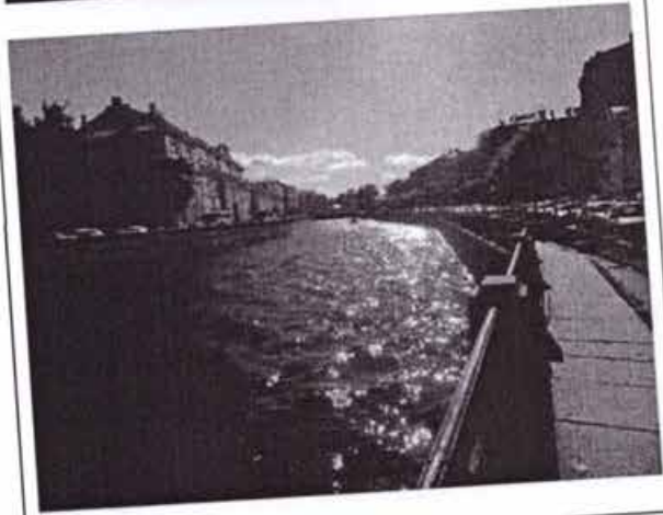
1. «Мост Инженерный Первый», 1824-1826 гг., инж. Базен П.П., 1952-1954 гг., инж. Левин Б.Б., 1953 г., арх. Ротач А.Л., расположенный по адресу: Санкт-Петербург, через р. Мойку по р. Фонтанке наб.
