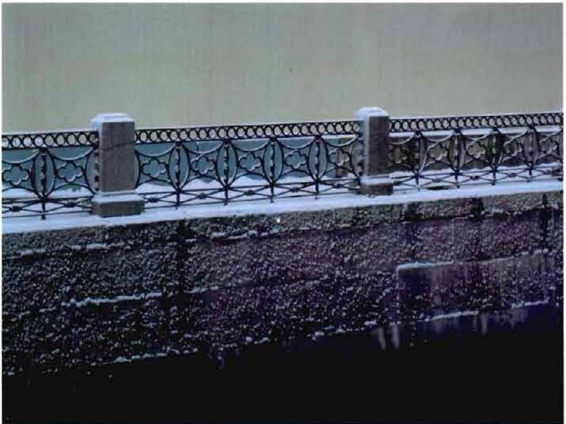
6. Ограждение набережной. Левобережная стенка
