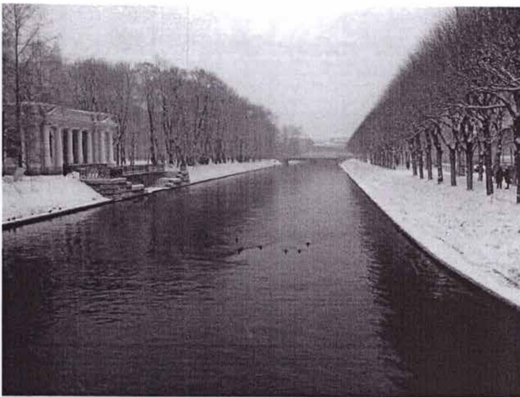
4. Набережные. Вид с моста Михайловского (1-го Садового) по течению реки. Липовая аллея на участке набережной от моста Михайловского (1-го Садового) до 2-го Садового моста (правый берег)
