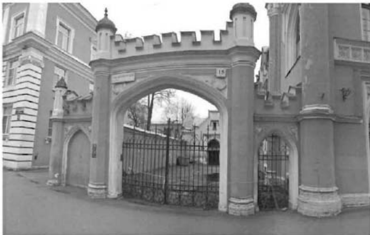
22. Часть ограды, примыкающая к западному фасаду Главного корпуса.
