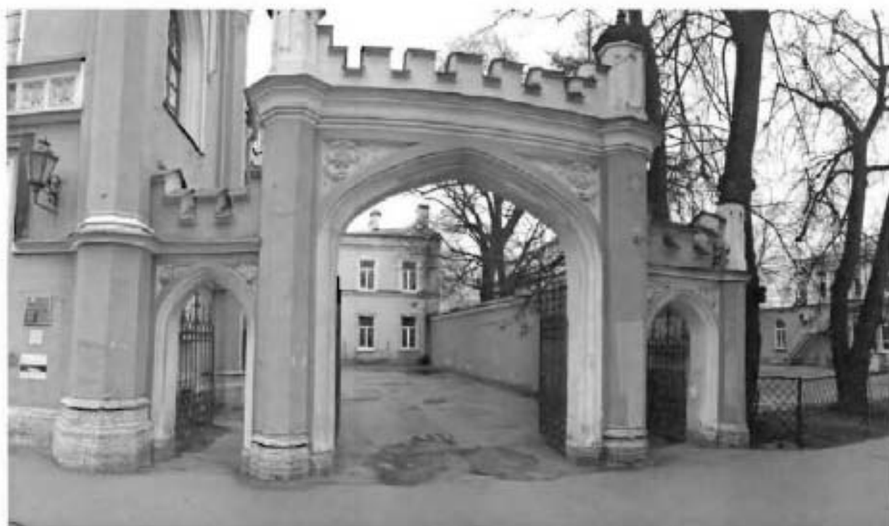
23. Часть ограды, примыкающая к восточному фасаду Главного корпуса.
