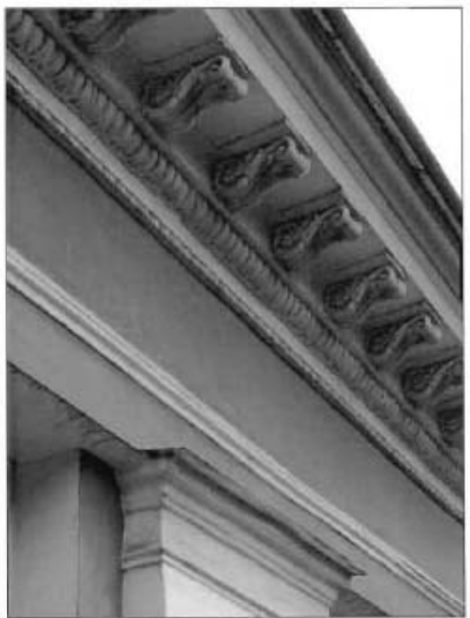
6. Западный фасад. Фрагмент. Венчающий карниз.
