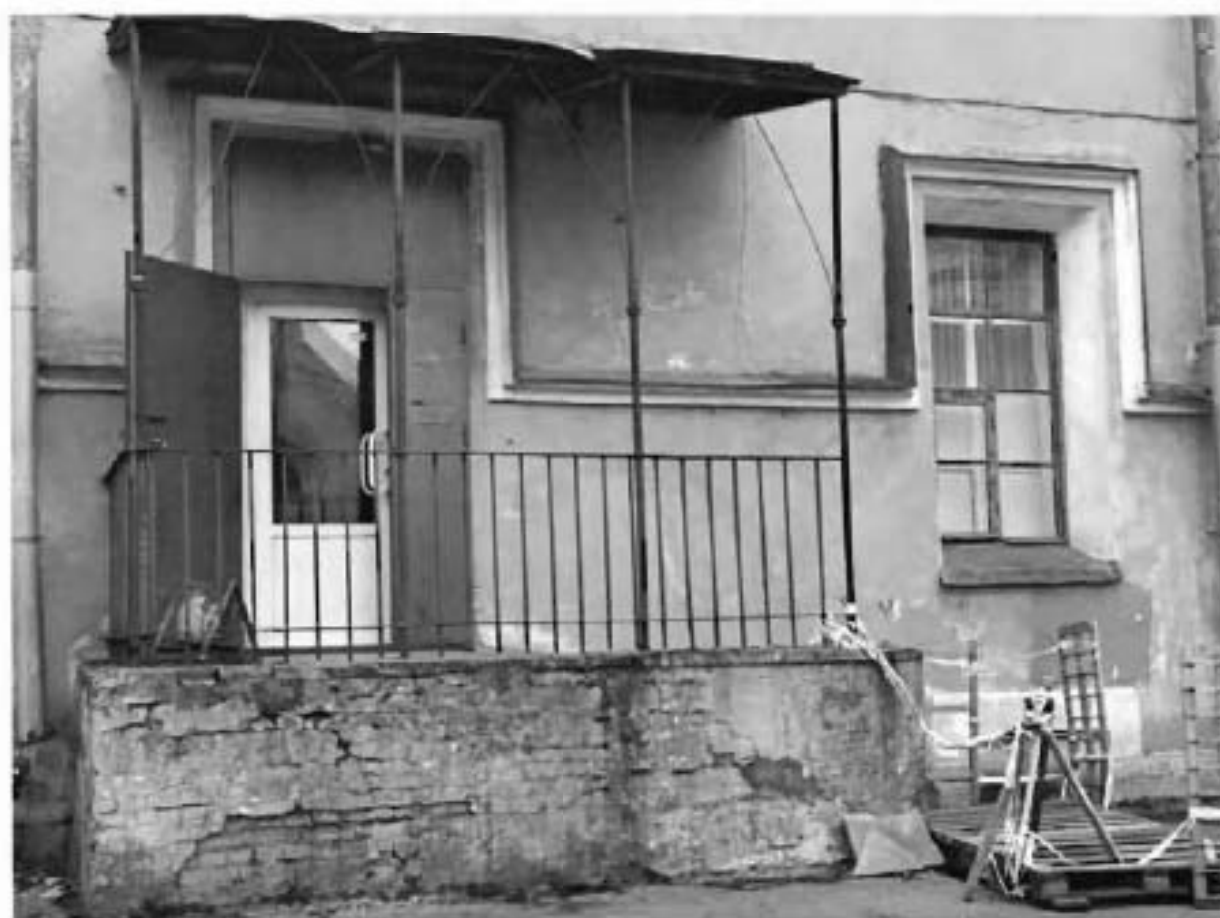
4. Крыльцо дворового фасада.
