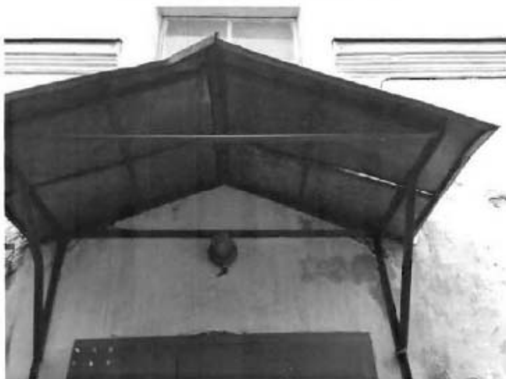
17. Козырек над дверным заполнением западного фасада.
