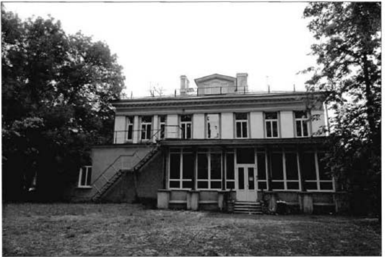
4. Западный фасад. Общий вид.
