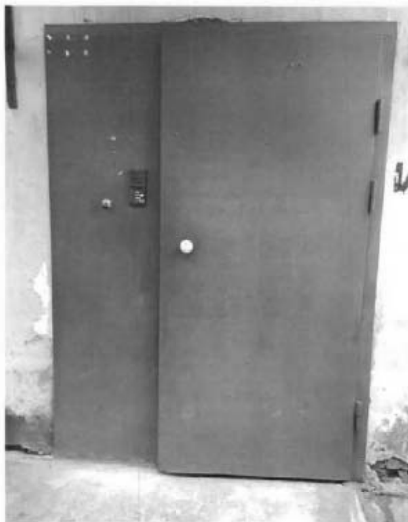
16. Дверное заполнение западного фасада.
