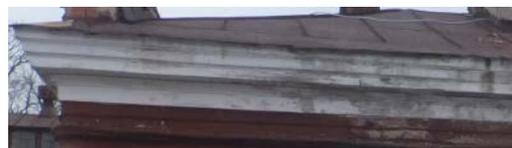
оформление завершения южных торцов боковых объемов и северного торца восточного объема ступенчатыми аттиковыми стенками, оформленными четырехугольными филенками и завершенными штукатурными профилированными карнизами;
