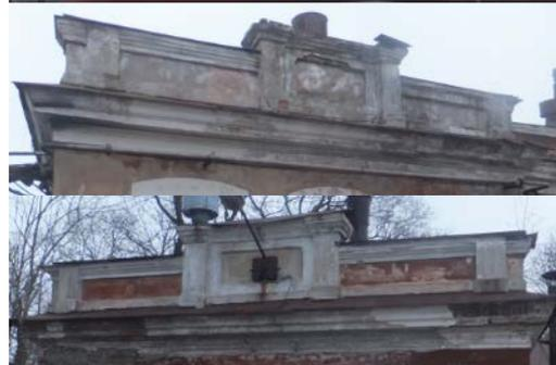
оформление завершения центральной части северного фасада центрального объема треугольным фронтоном с гладким тимпаном и профилированными карнизами;
