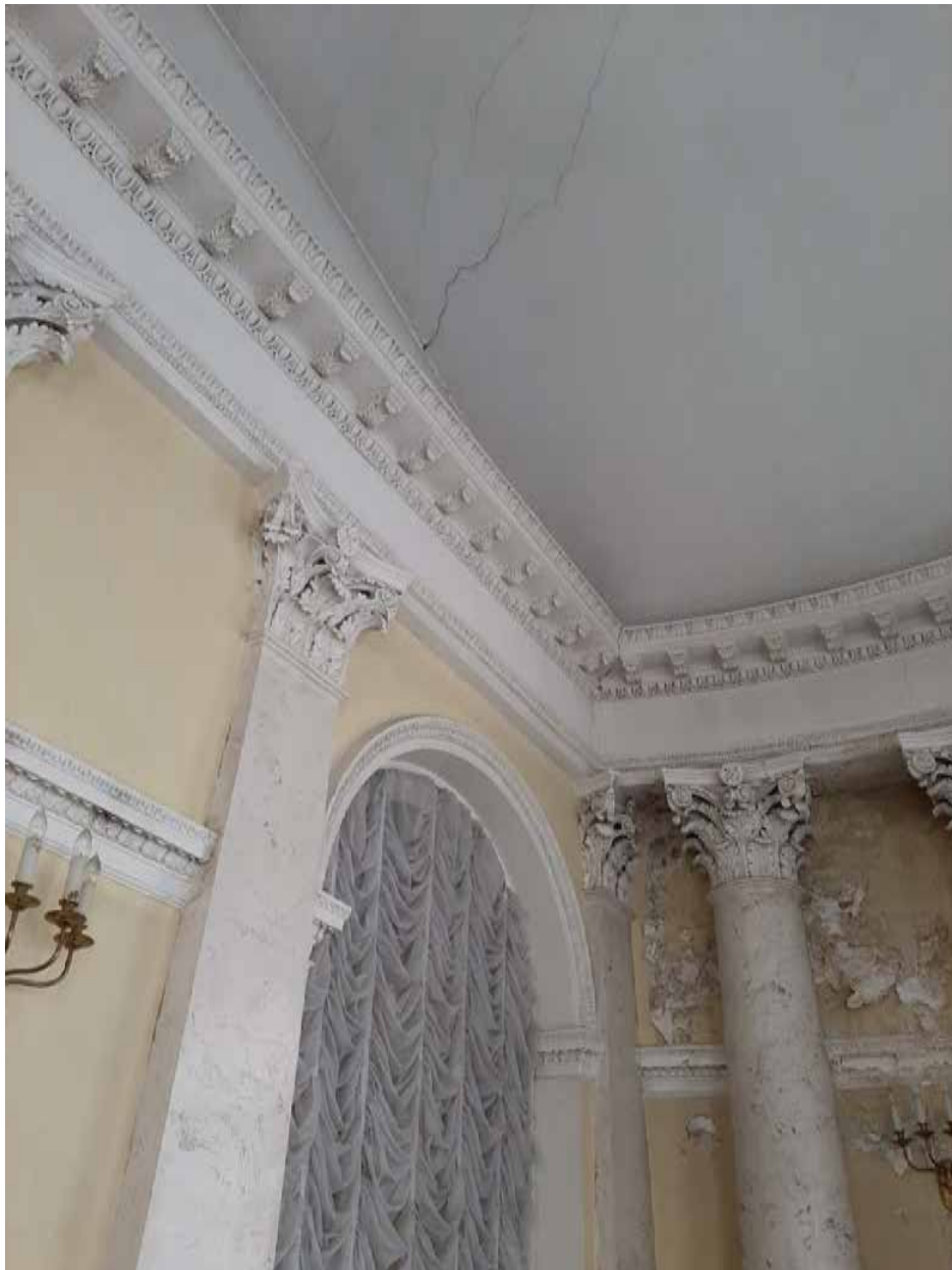
Фото 11. СПбГИК. Лестница ротонды. 3 этаж
