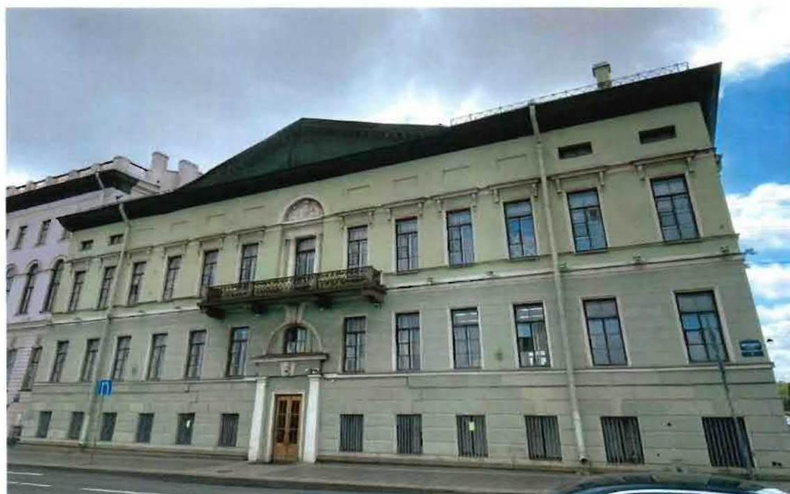
2. Общий вид на объект культурного наследия.
