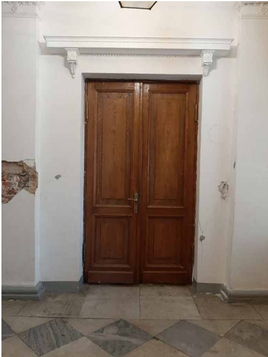
Фото 16. СПбГИК. Проход из входного вестибюля в помещения 1 этажа
