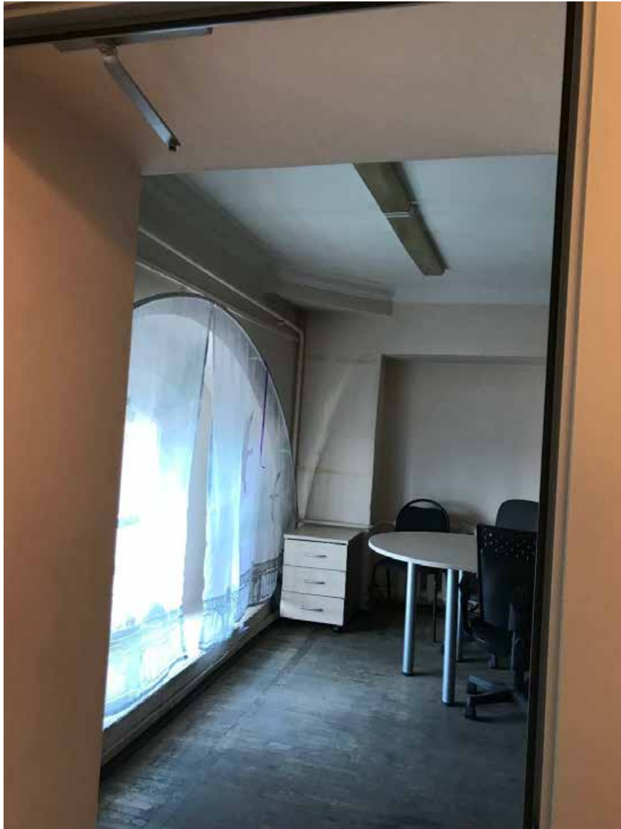
Фото 28. СПБГИК. Помещение 2 этажа
