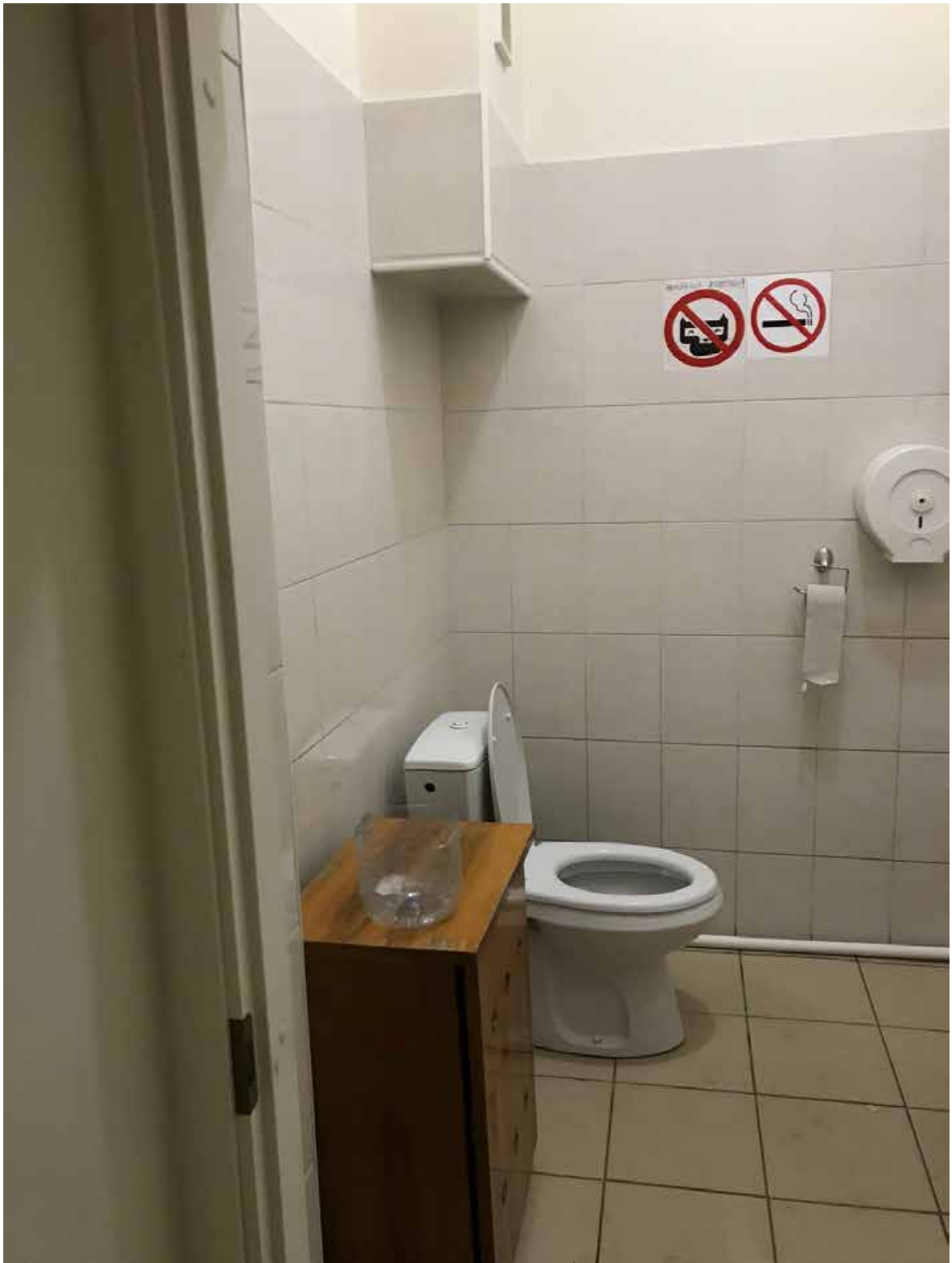
Фото 25. СПбГИК. Сан.узел 1 этажа
