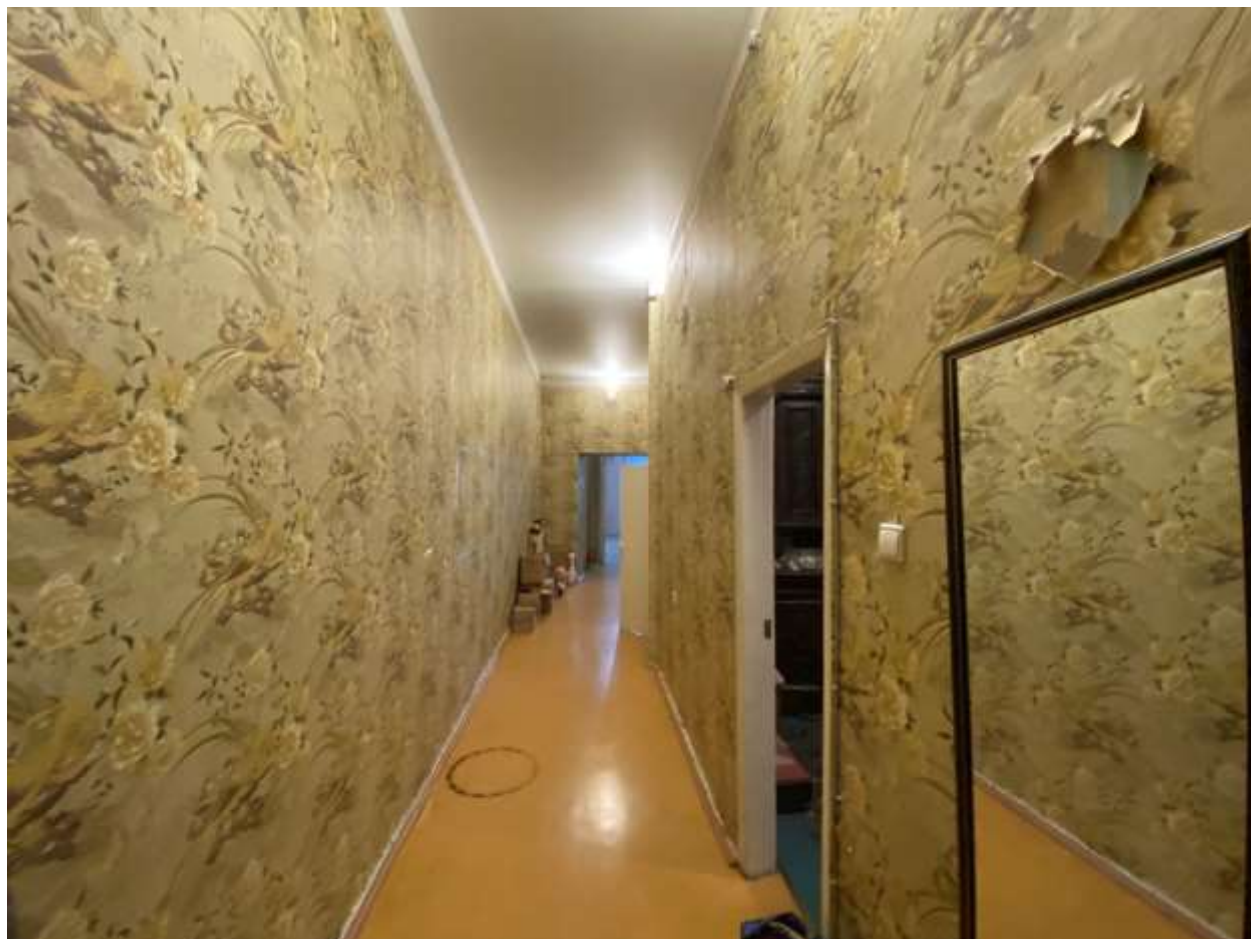
Фото 9. Помещение № 1. Коридор. Вид с северо-запада.
