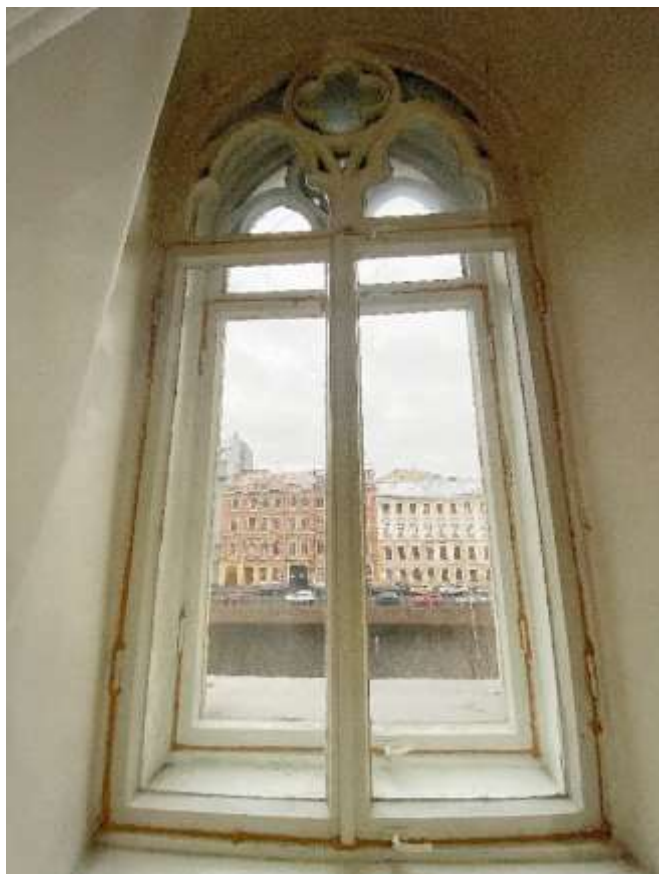
Фото 16. Помещение № 4. Историческое оконное заполнение. Вид с северо-запада.
