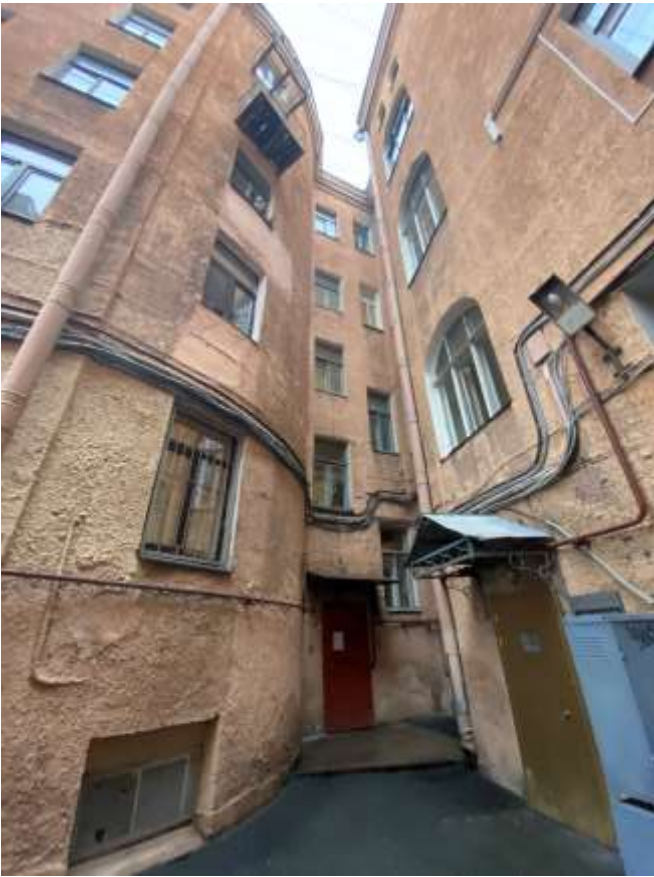
Фото 5. Фрагмент юго-западного дворового фасада. Вид с запада.
