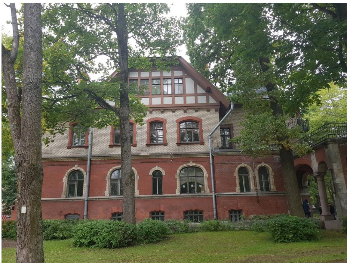
Фото 2. Лицевой восточный фасад объекта культурного наследия регионального значения «Дом Гудовича В.В. со служебным флигелем, садом и оградой»
