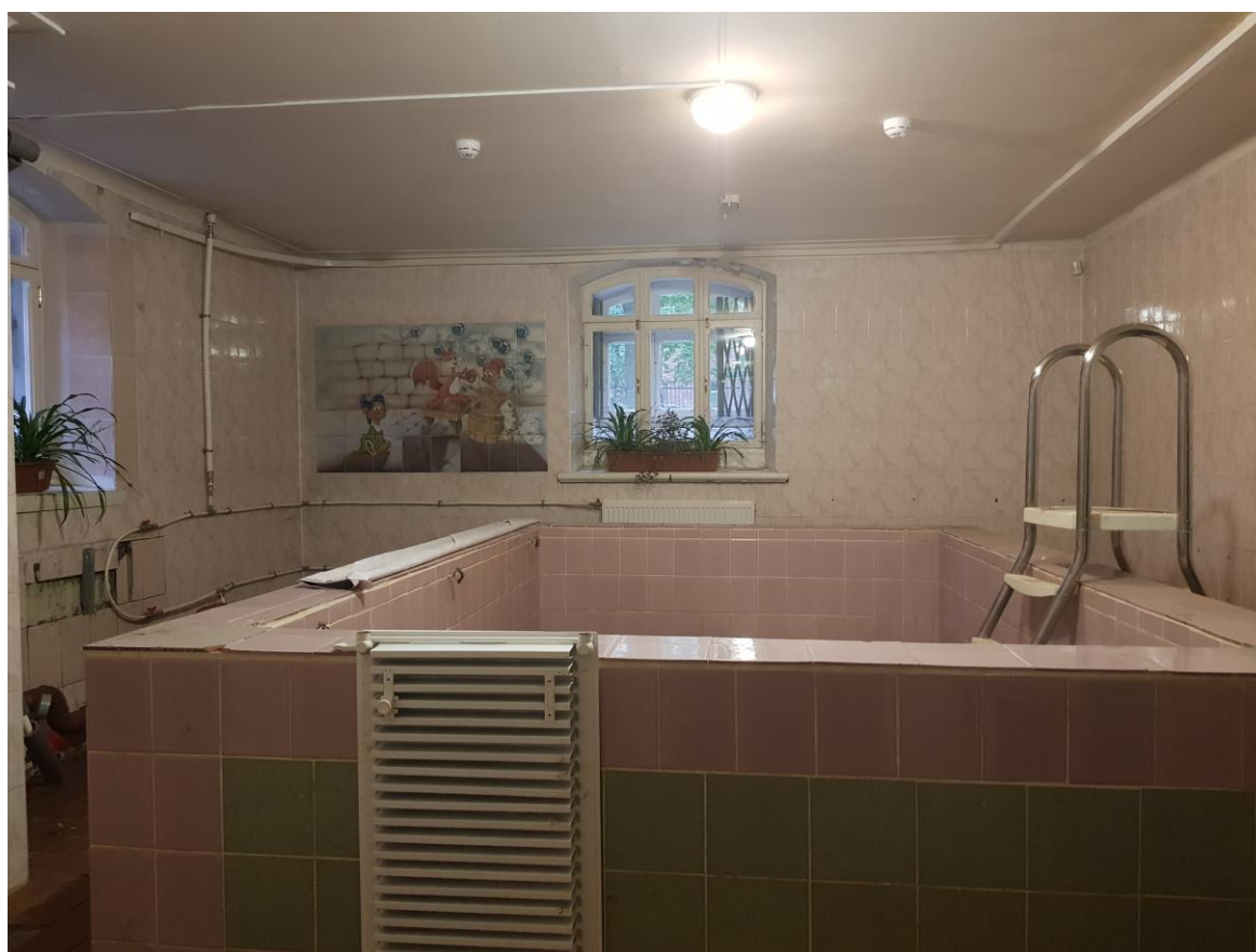
Фото 6. Интерьер объекта культурного наследия регионального значения «Дом Гудовича В.В. со служебным флигелем, садом и оградой», подвал
