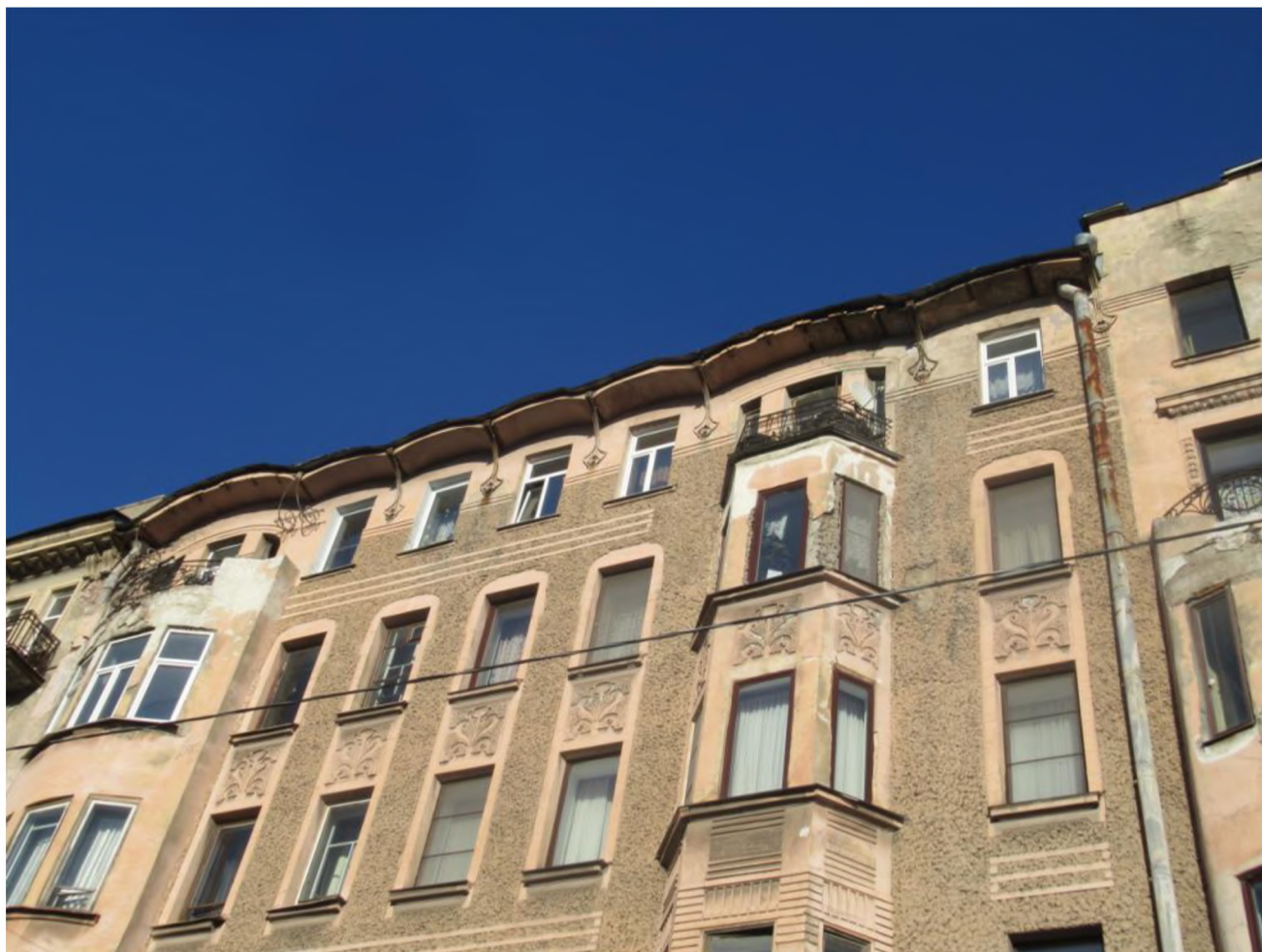
4. Лицевой (юго-западный) фасад здания. Фрагмент. Вид с 6-й линии В.О.
