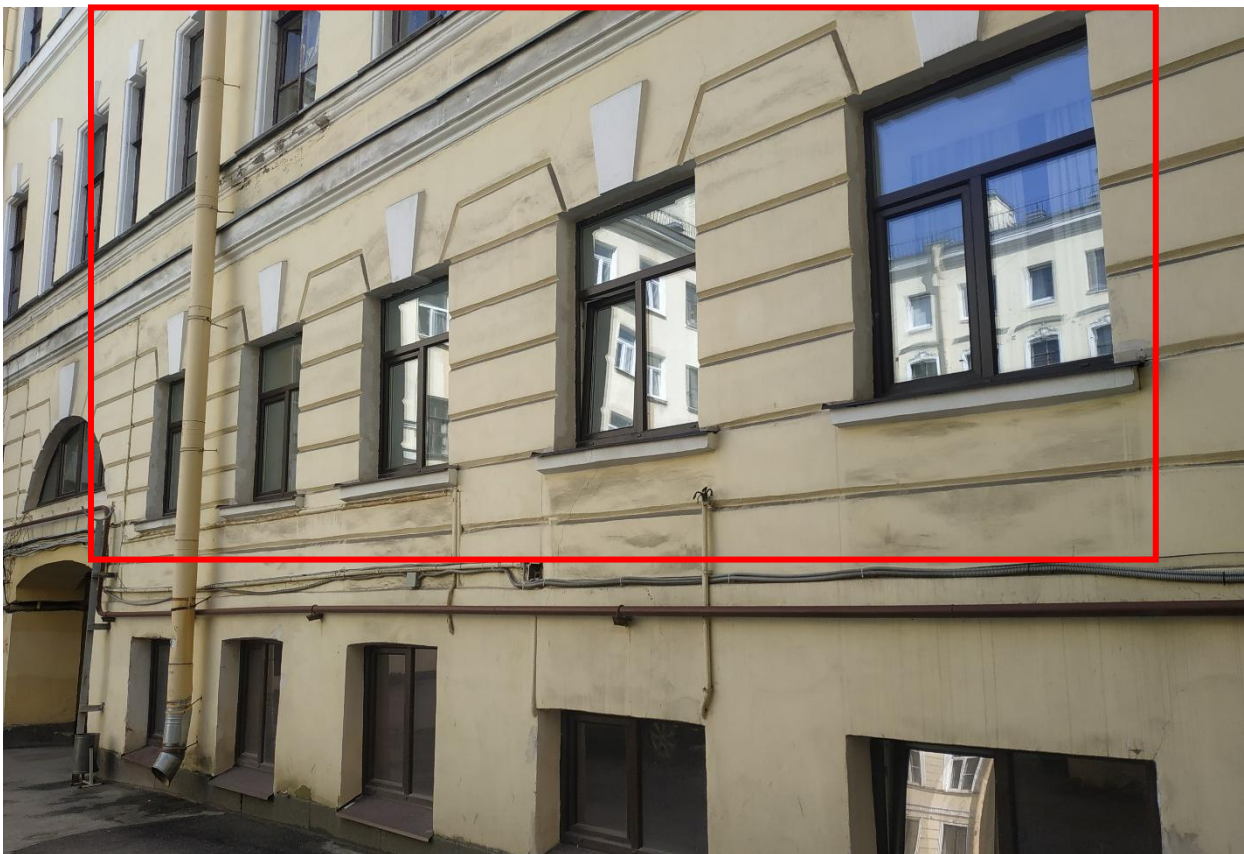
Фото 5. Фрагмент дворового фасада. Заполнения оконных проемов кв. №1.
