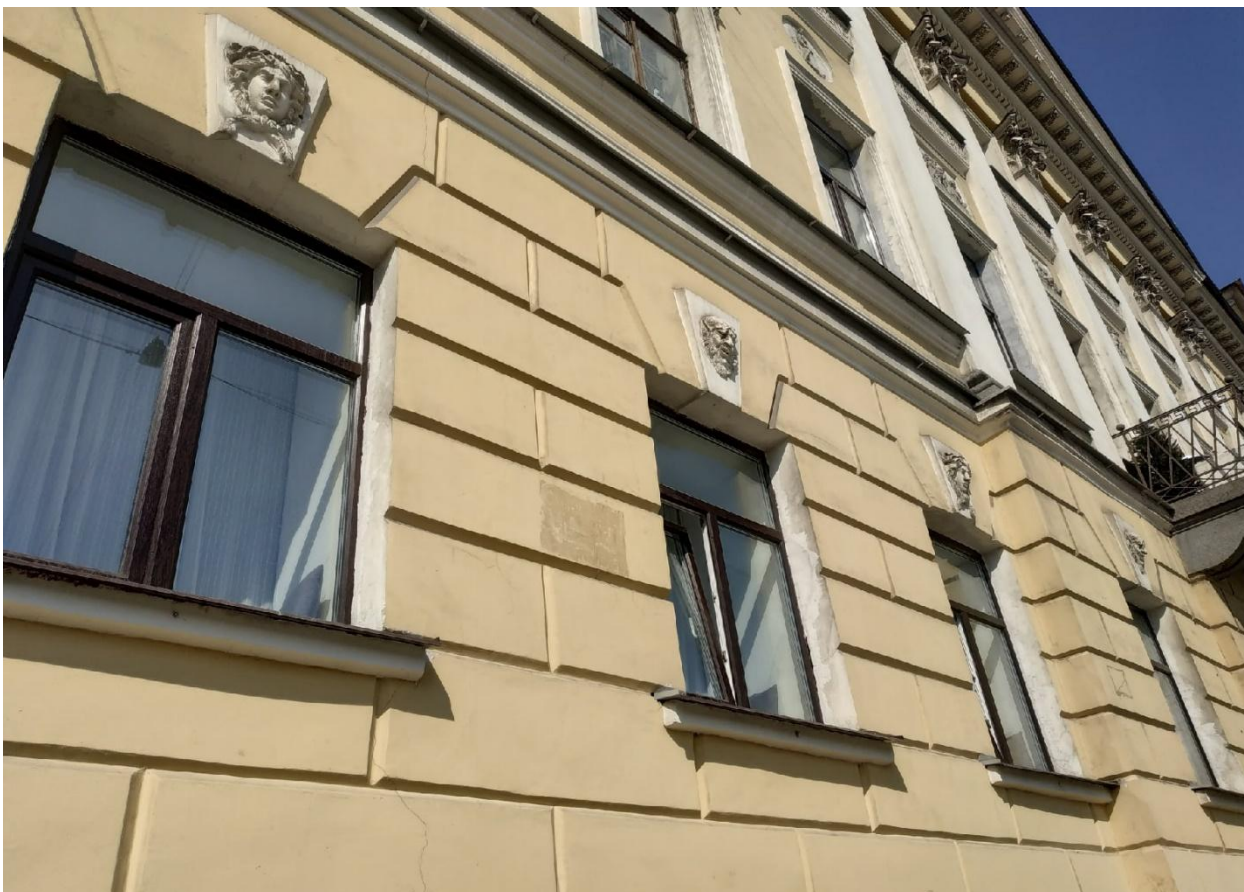
Фото 3. Фрагмент лицевого фасада. Заполнения оконных проемов кв.№1
