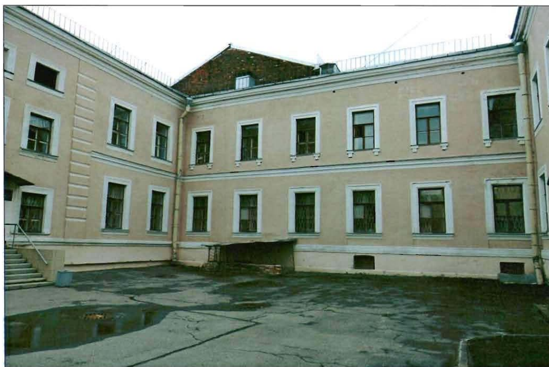
5. Общий вид дворовых фасадов с юго-запада.
