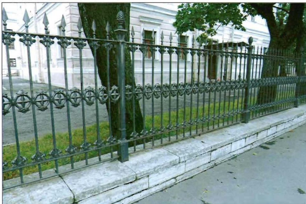
7. Общий вид чугунной ограды
