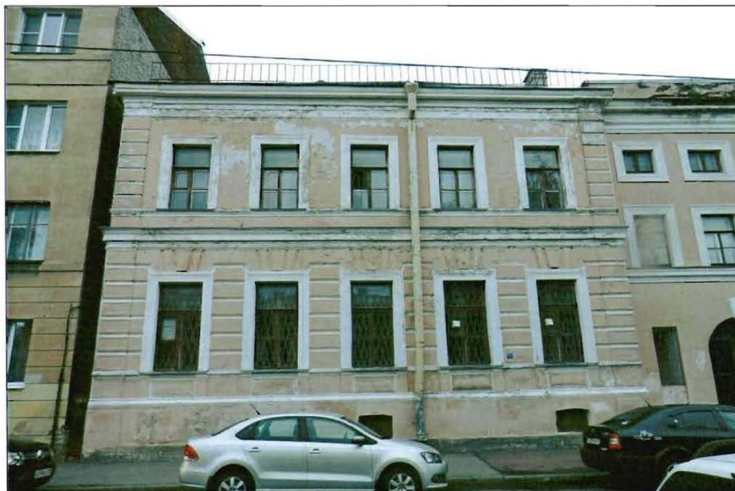
3. Северный фасад по ул. Александра Попова.
