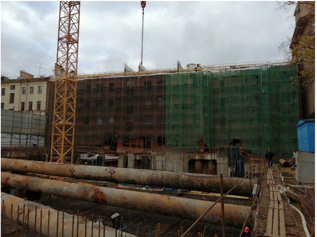
Фото 2. Объект «Производственный корпус» в составе ансамбля, объекта культурного наследия регионального значения «Постройки мебельно-столярной фабрики Ф.А.Мельцера», расположенного по адресу: Санкт-Петербург, наб. реки Карповки, дом 27, литера Б (Б4). Дворовый фасад.
