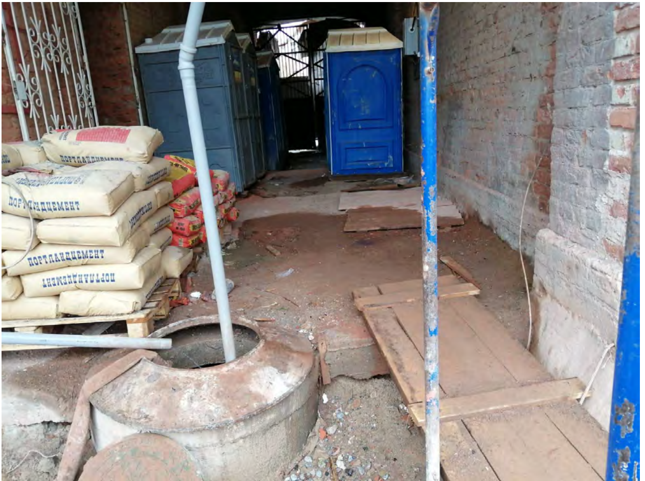
Фото 5. Объект «Производственный корпус» в составе ансамбля, объекта культурного наследия регионального значения «Постройки мебельно-столярной фабрики Ф.А.Мельцера», расположенного по адресу: Санкт-Петербург, наб. реки Карповки, дом 27, литера Б (Б4). Арочный проем здания, колодец.
