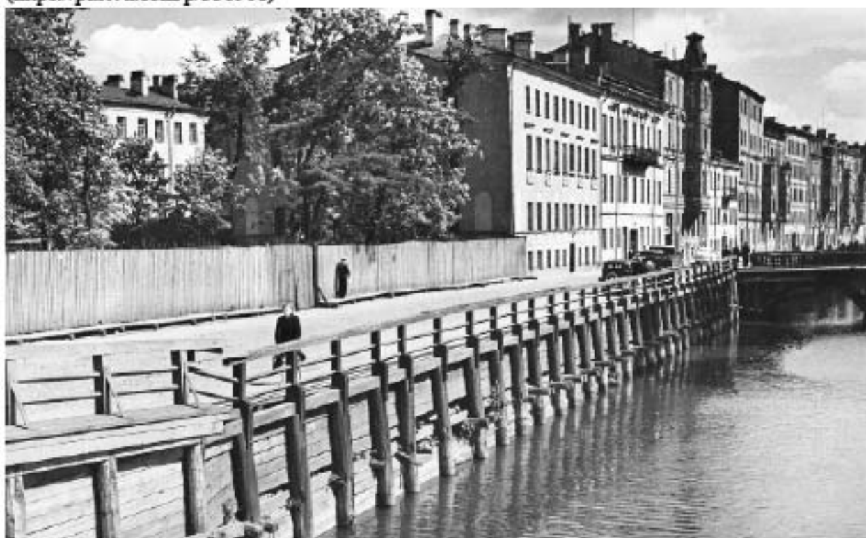
Илл. 40. Фотография от Храповицкого моста 1957 года до реконструкции ( https://pastvu.com/p/336906 )
