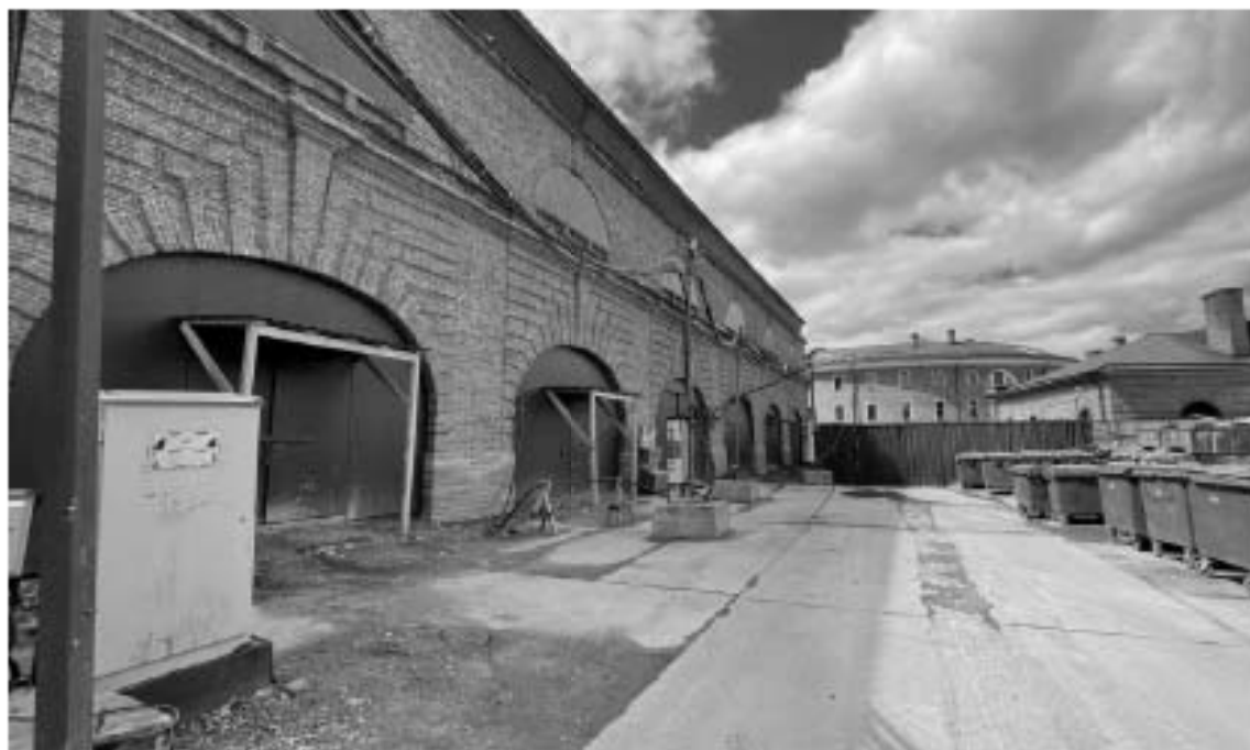
3. Объект «Склады лесные (три) с аркой»
