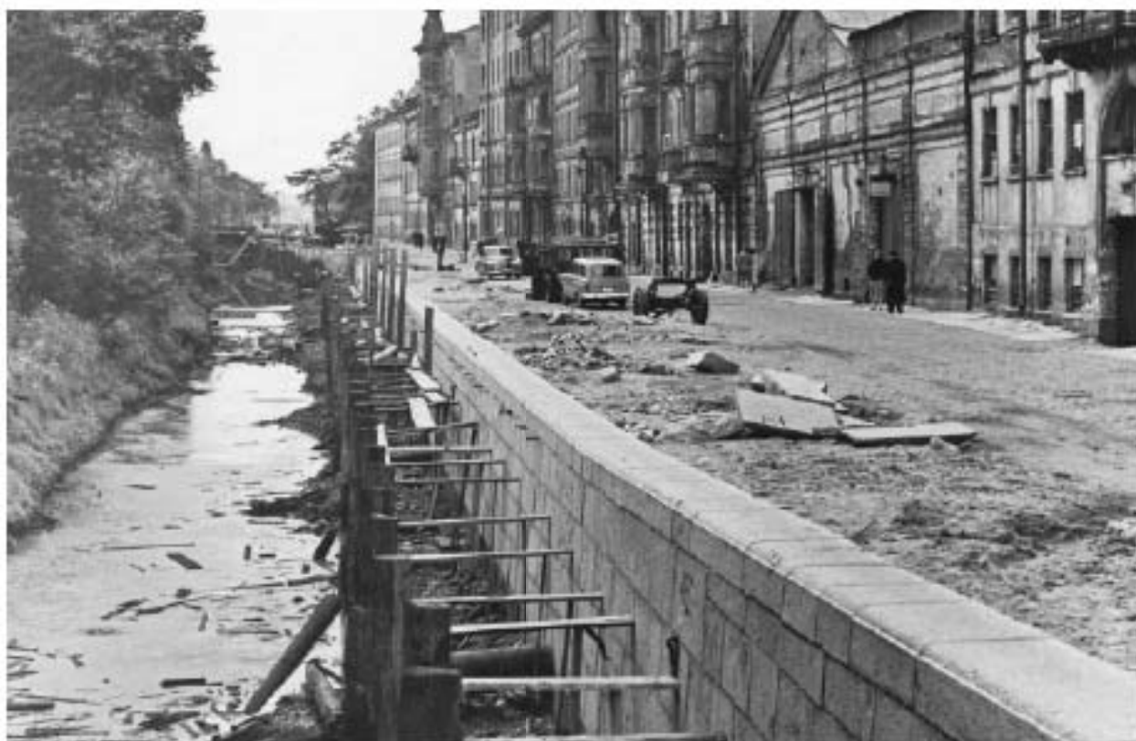
Илл. 39. Фотография от 1-го моста Круштейна 1957 года в процессе реконструкции ( https://pastvu.com/p/336901 )
