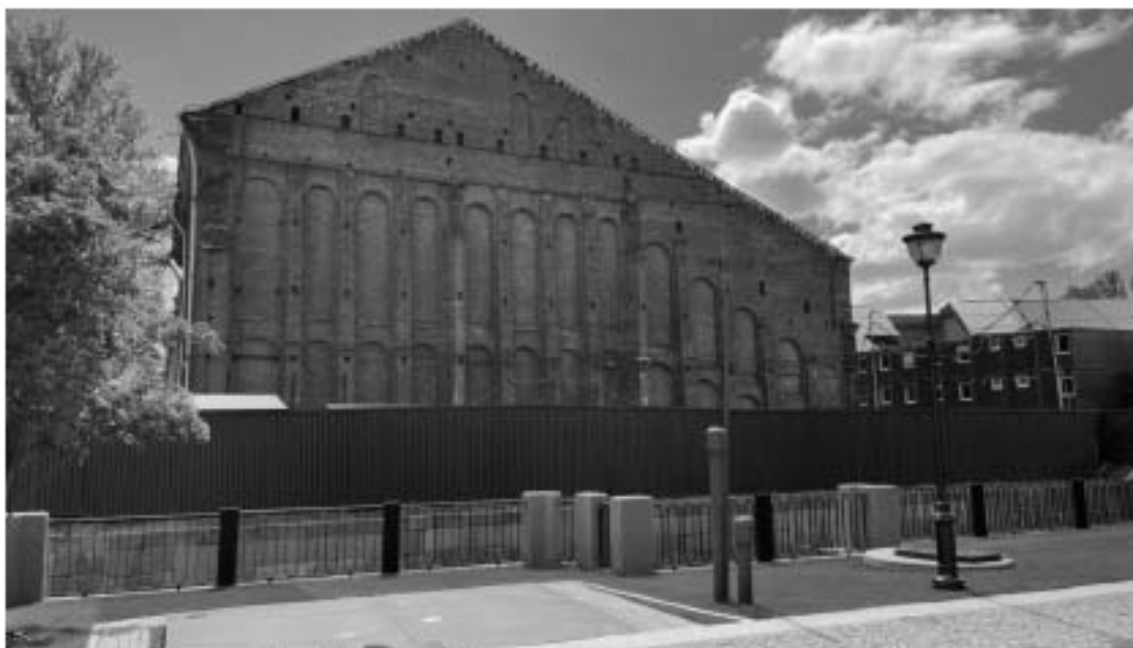
1. Объект «Склады лесные (три) с аркой»
