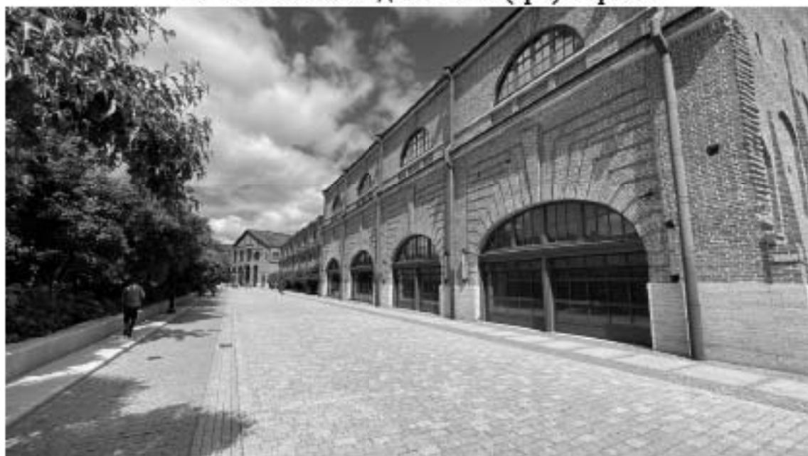
4. Объект «Склады лесные (три) с аркой»
