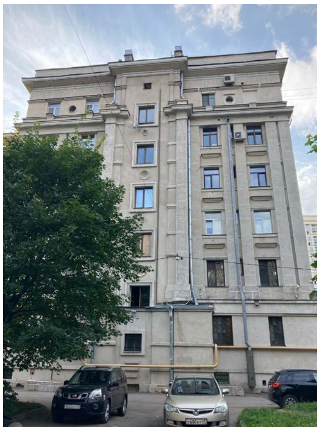
Фото 7. Фрагмент дворового фасада объекта культурного наследия регионального значения «Жилые дома Ленсовета (2 здания)»
