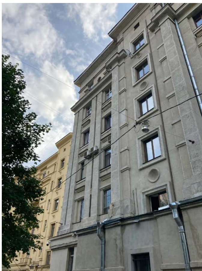
Фото 6. Фрагмент дворового фасада объекта культурного наследия регионального значения «Жилые дома Ленсовета (2 здания)»
