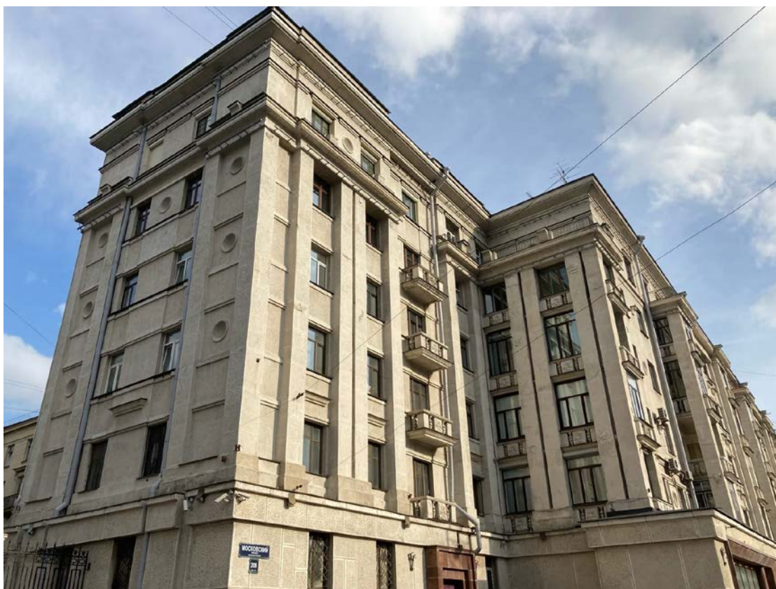
Фото 4. Фрагмент лицевого фасада объекта культурного наследия регионального значения «Жилые дома Ленсовета (2 здания)»
