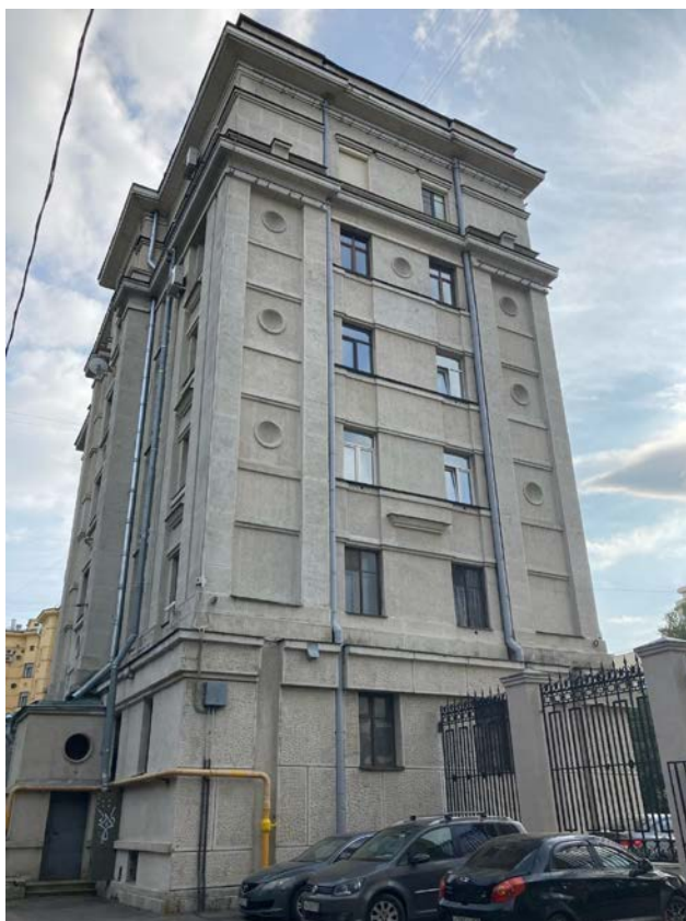
Фото 5. Фрагмент фасада объекта культурного наследия регионального значения «Жилые дома Ленсовета (2 здания)»
