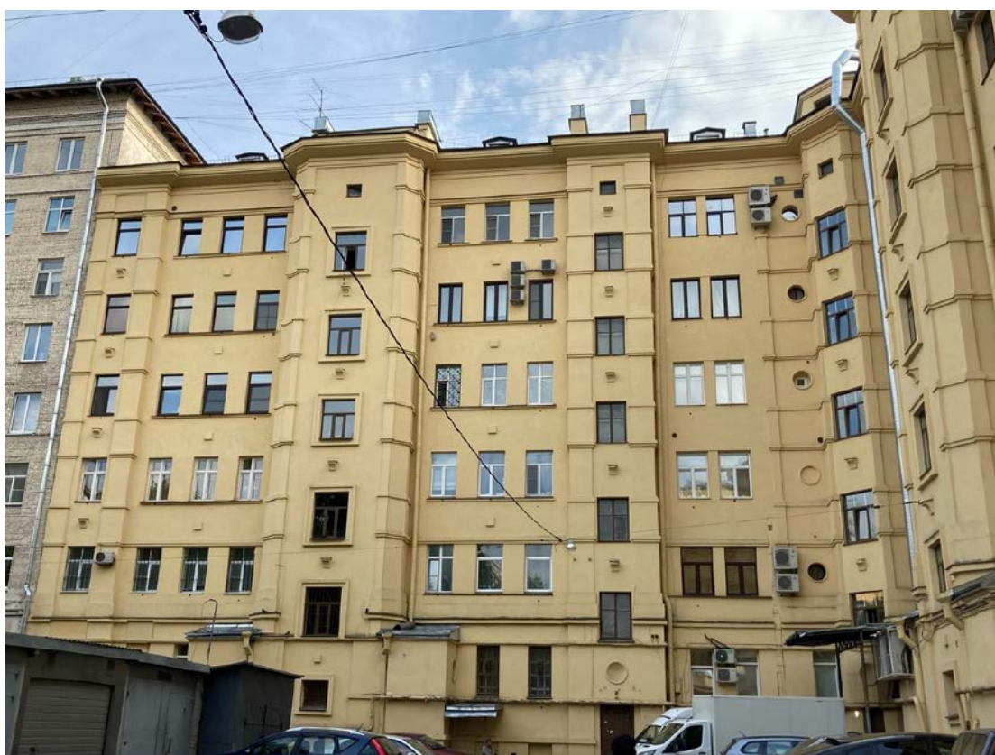
Фото 10. Фрагмент дворового фасада объекта культурного наследия регионального значения «Жилые дома Ленсовета (2 здания)»
