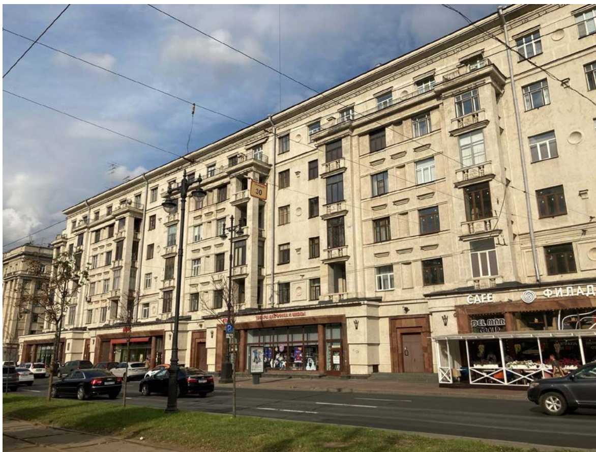
Фото 3. Фрагмент лицевого фасада объекта культурного наследия регионального значения «Жилые дома Ленсовета (2 здания)»
