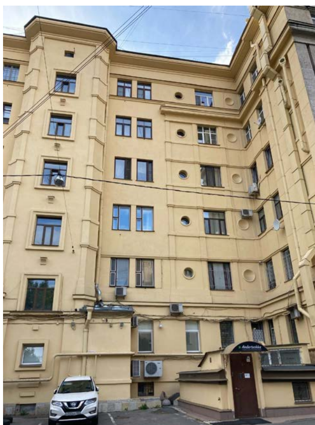
Фото 8. Фрагмент дворового фасада объекта культурного наследия регионального значения «Жилые дома Ленсовета (2 здания)»
