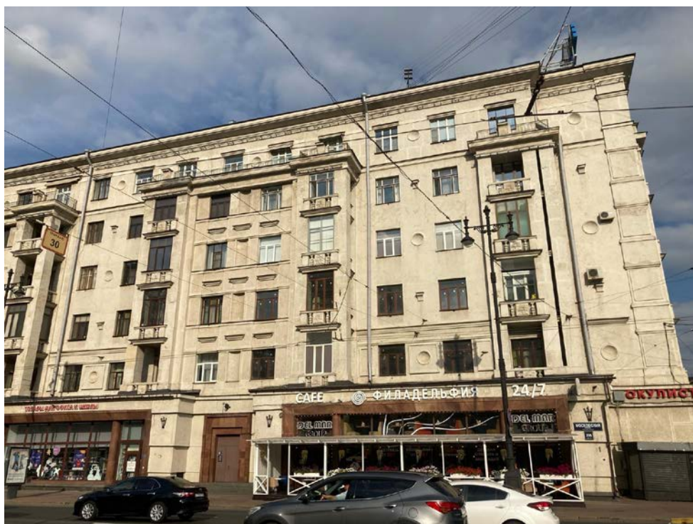
Фото 2. Фрагмент лицевого фасада объекта культурного наследия регионального значения «Жилые дома Ленсовета (2 здания)»
