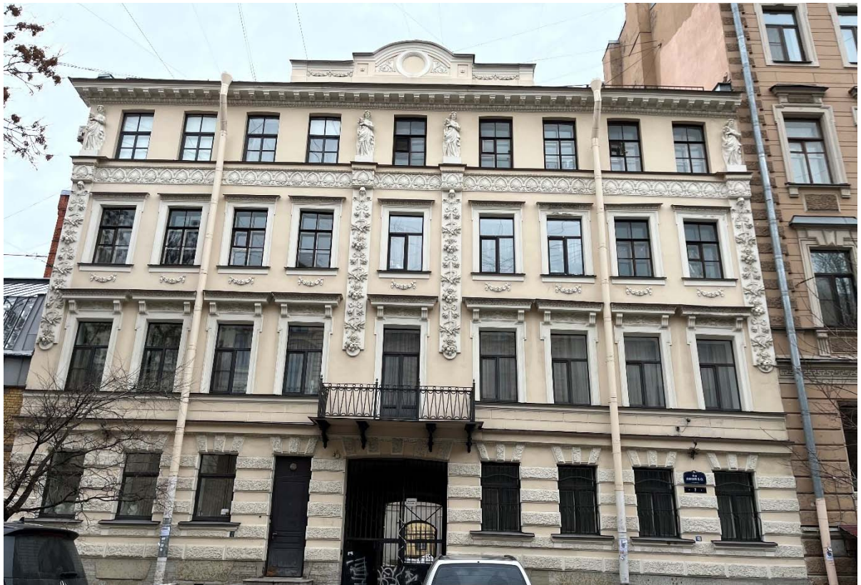
Фото №1. Лицевой юго-западный фасад.
