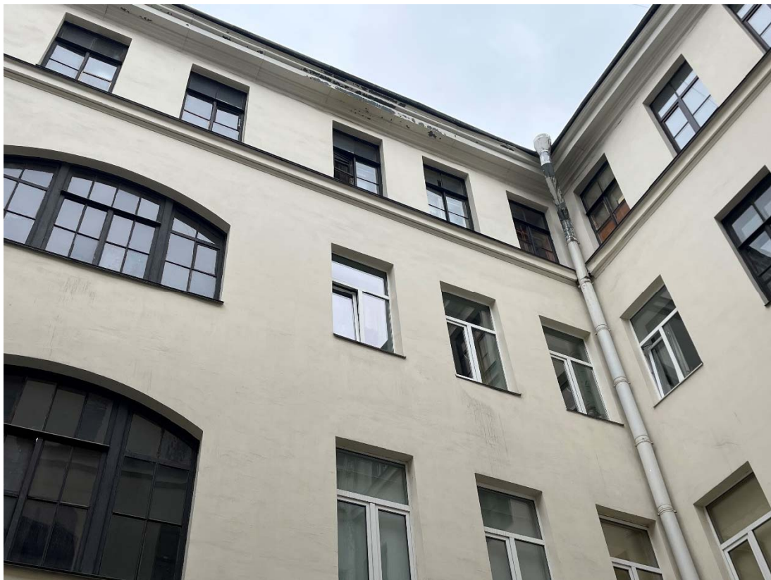
Фото №2. Фрагмент дворового северо-западного фасада, окна проектируемой квартиры в уровне третьего этажа.
