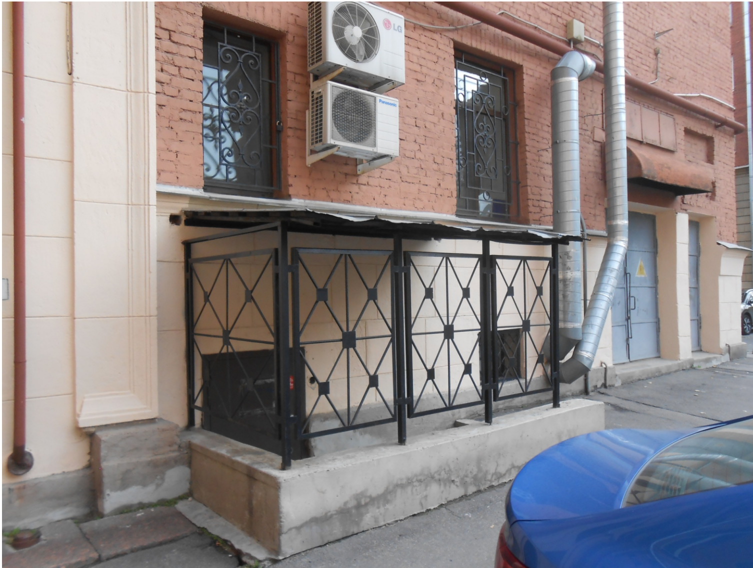
10. “Жилой дом”. Санкт-Петербург, Московский район, ул. Бассейная, д. 41, лит. А. Фасад со стороны двора. Фрагмент. Фото: 13.10.2022 г.
