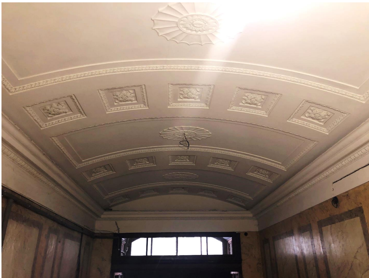
Фото 3. Потолок вестибюля парадной лестницы. Вид с юга на север.
