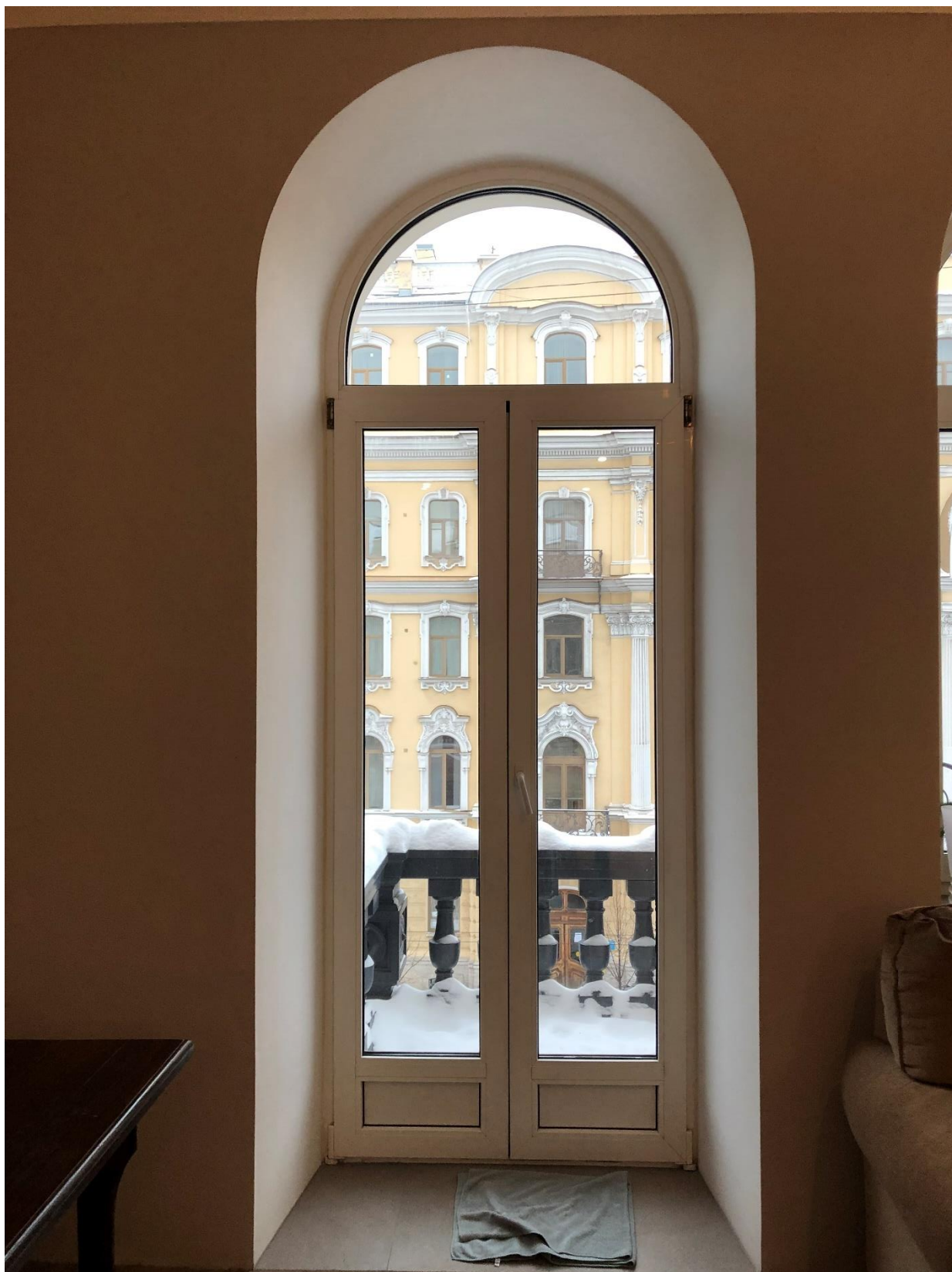
Фото 22. Вид на балконную дверь.
