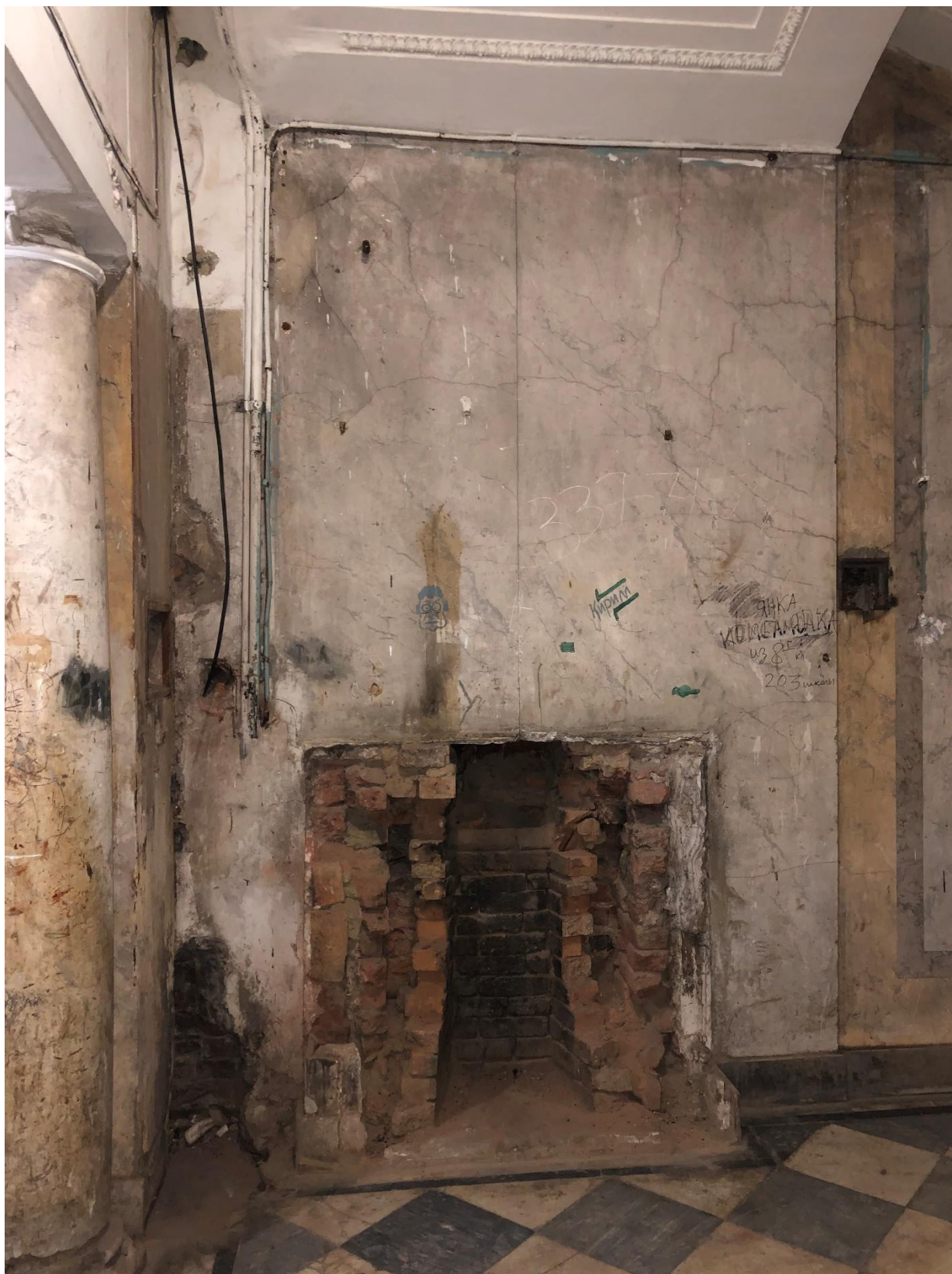
Фото 5. Вестибюль парадной лестницы.
