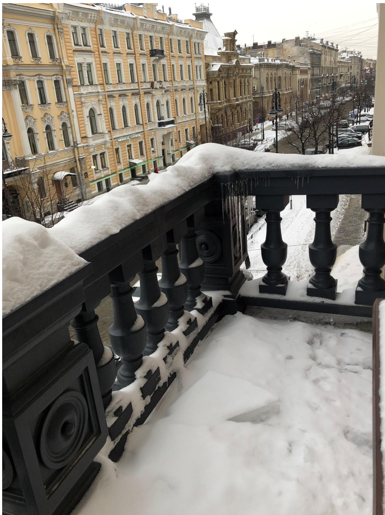
Фото 23. Балкон. Вид на ул. Чайковского по направлению на восток.
