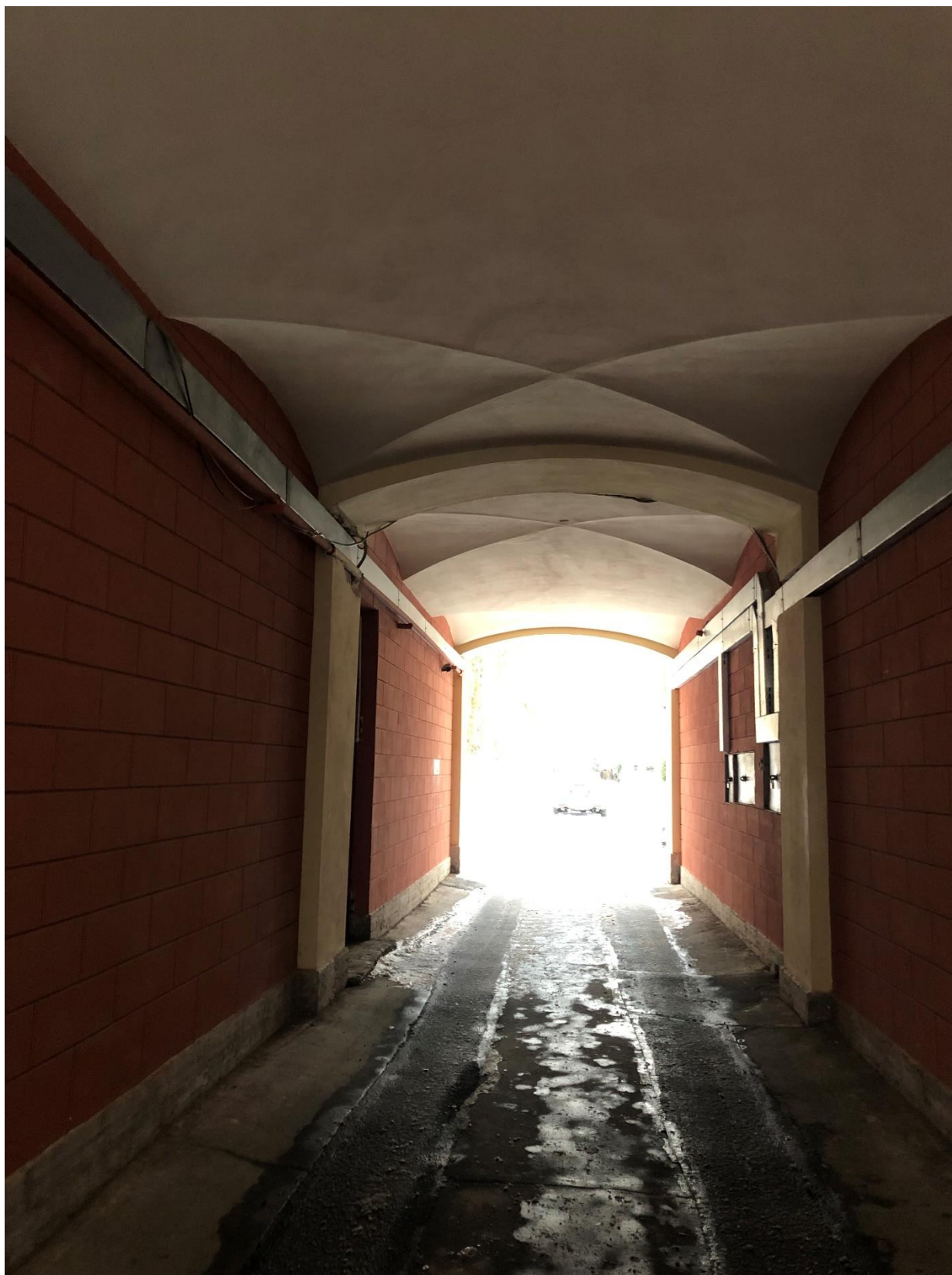
Фото 5. Вид на воротный проезд. Вход со стороны лицевого фасада.
