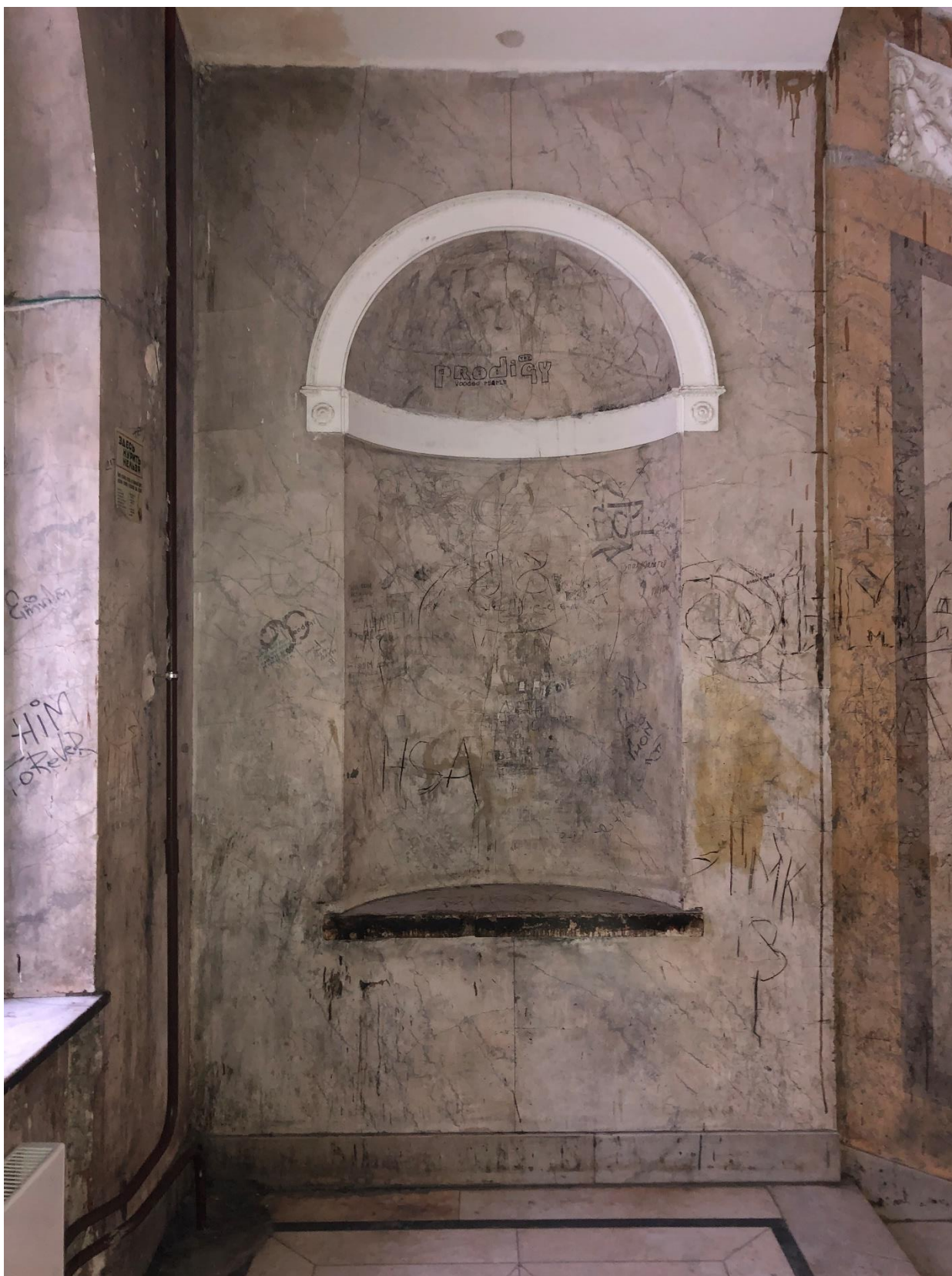
Фото 7. Ниша с завершением конхой в уровне лестничной площадки между 1-м и 2-м этажами.
