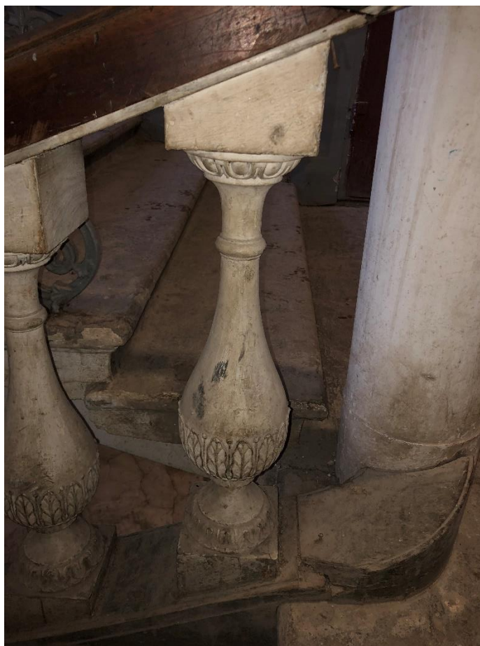
Фото 9. Балясина лестничного ограждения между 2-м и 3-м этажами.
