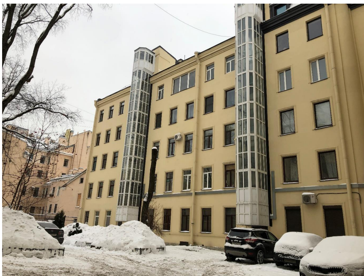
Фото 7. Вид на дворовый фасад западного корпуса.
