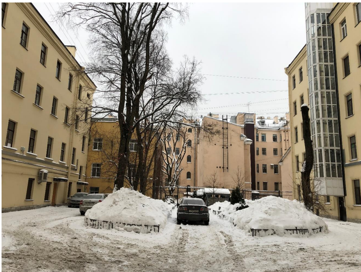
Фото 6. Вид на дворовую часть с севера на юг.
