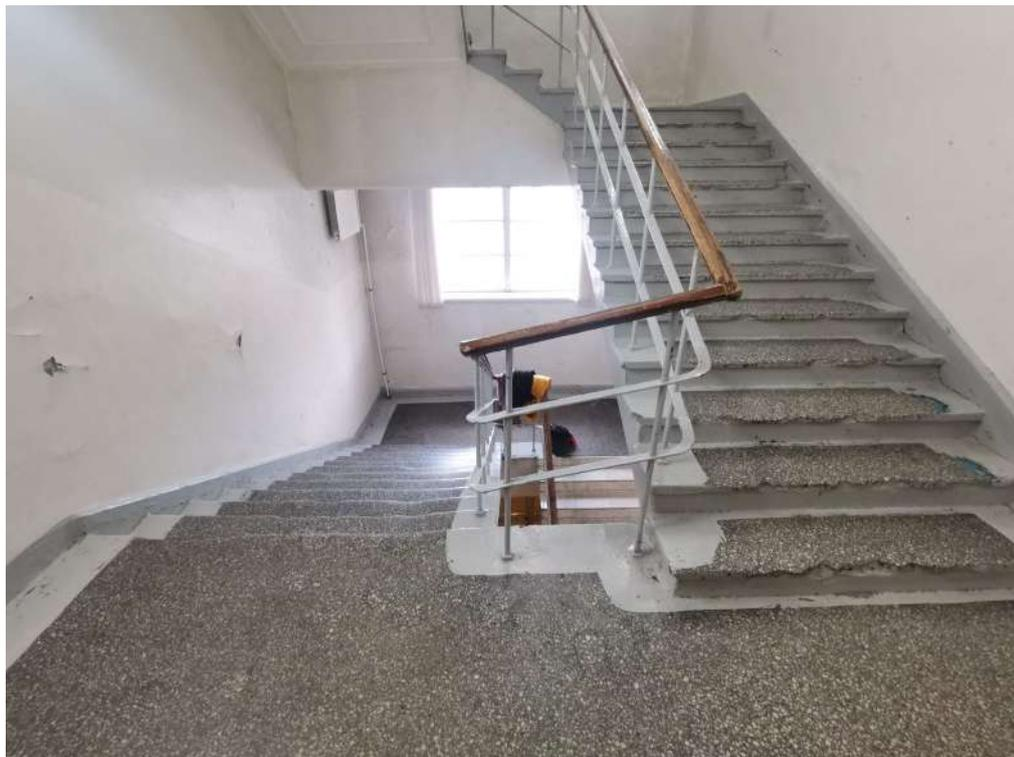
*Фото 23. Общий вид на лестницу. Наблюдаются сколы бетонных проступей, истирание покрытия, общая загрязненность.*
