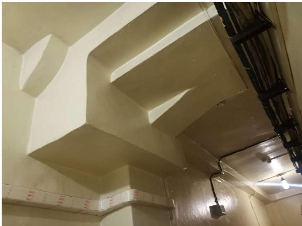
*Фото № 32 Фрагмент верхней части арки с опорой на пилоны со следами некачественного позднего ремонта*
