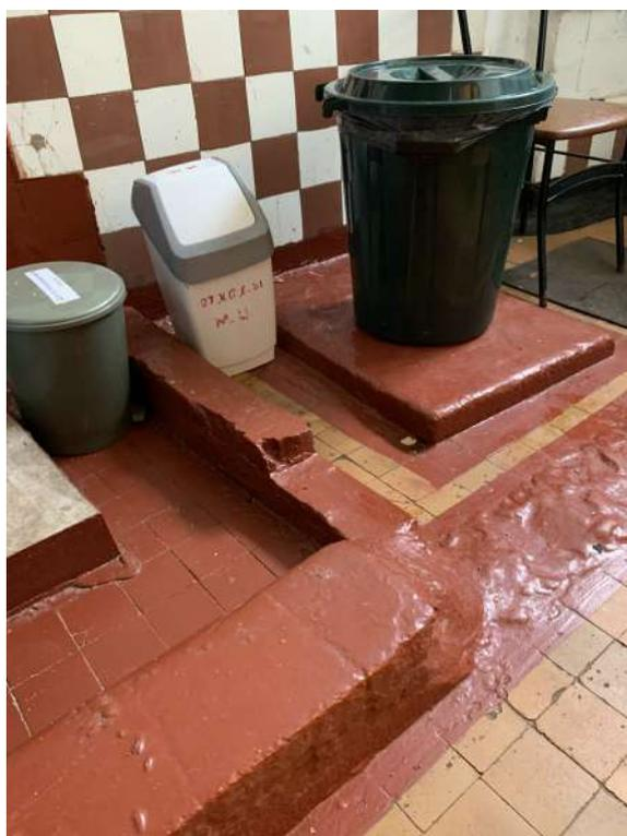
*Фото №46. Фрагмент пола. Наблюдаются следы позднего некачественного ремонта*
