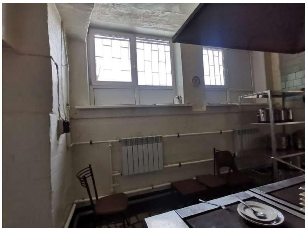
*Фото № 58 Фрагмент фасадной стены со стороны Горячего цеха. Наблюдаются неровности в отделке выступающей части стены. На потолке наблюдается вздутие красочного слоя*
