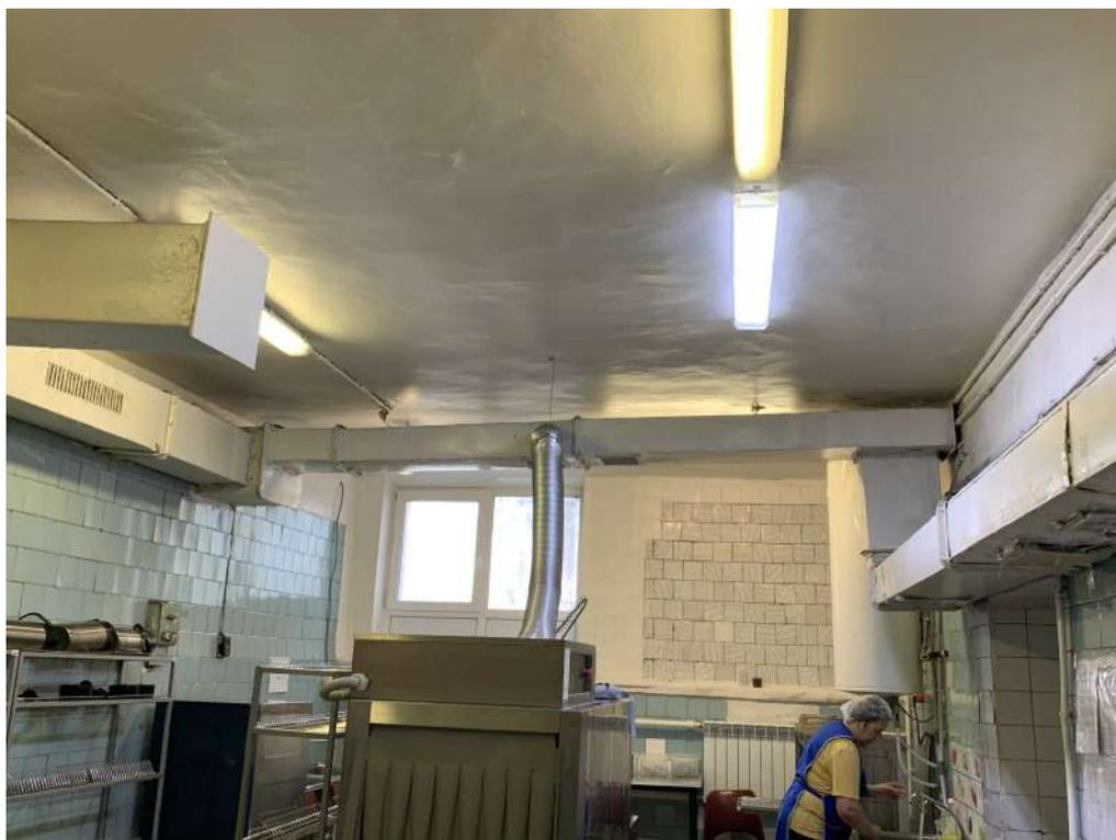
*Фото №20 Общий вид помещения Моечной кухонной посуды (пом. №53). Отделка помещения сильно загрязнена, на потолке видны трещины и сколы на штукатурном слое*
