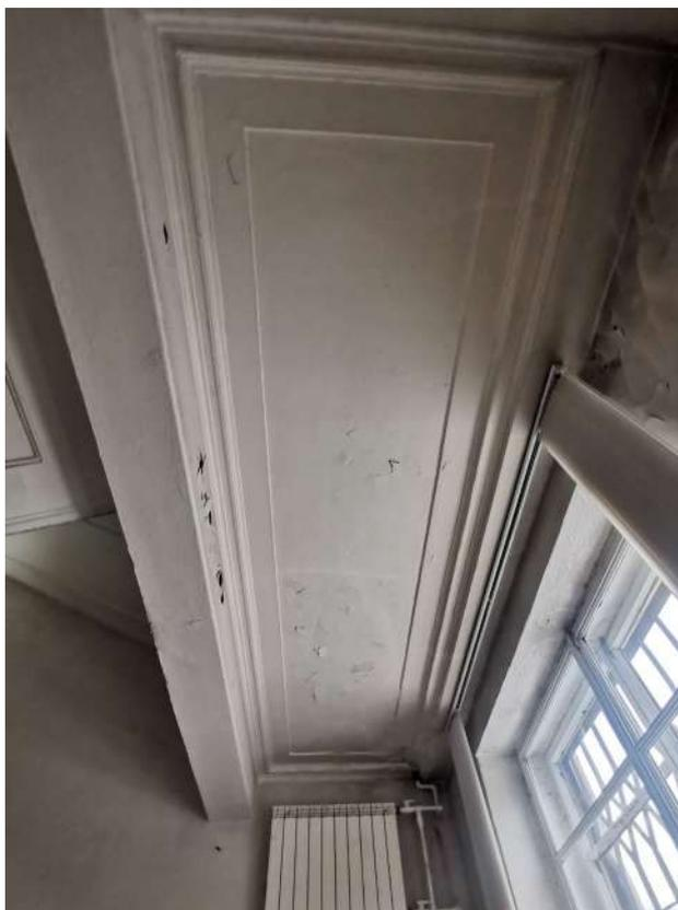
*Фото 16. Фрагмент потолка с междуэтажной площадки. Наблюдаются трещины, потеки и отслоения штукатурного слоя, общая загрязненность.*
