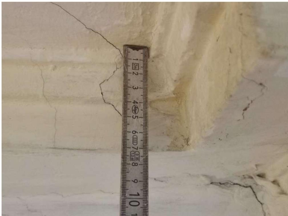
*Фото 11. Фрагмент потолка с лепниной в мужской раздевалке. Наблюдаются трещины и отслоение штукатурного слоя, потеки, общая загрязненность.*
