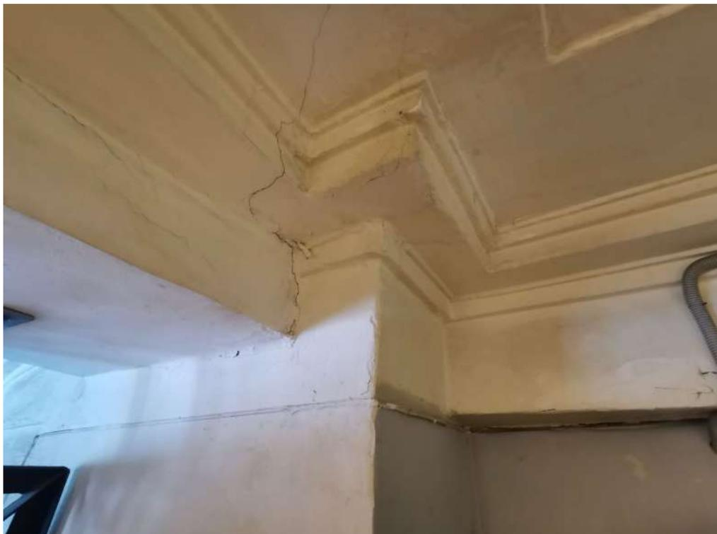
*Фото 9. Фрагмент потолка с лепниной в мужской раздевалке. Наблюдаются трещины и отслоение штукатурного слоя, множественные наслоения красочного слоя, потеки и общая загрязненность.*
