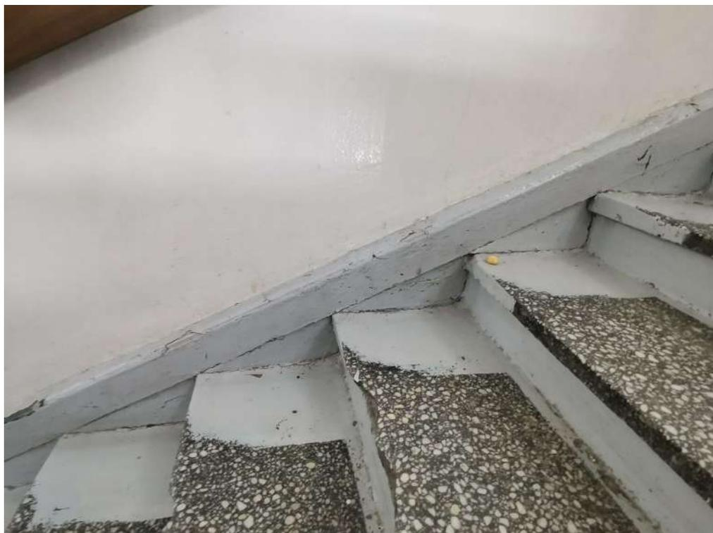
*Фото 44. Фрагмент ступеней. Наблюдаются сколы бетонных проступей, истирание покрытия, общая загрязненность.*
