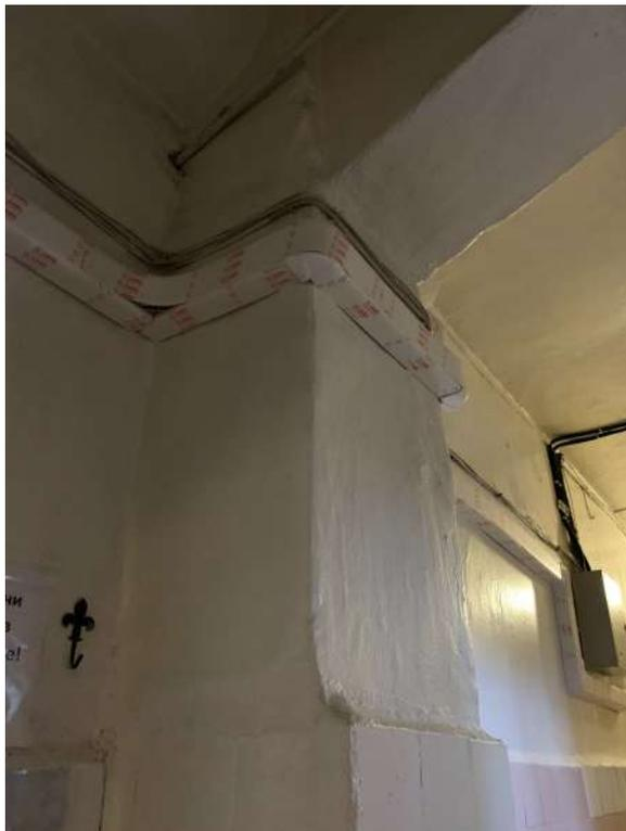
*Фото №27 Фрагмент помещения коридор (пом. №33) арка с опорой на пилоны. Общий износ отделочных материалов*
