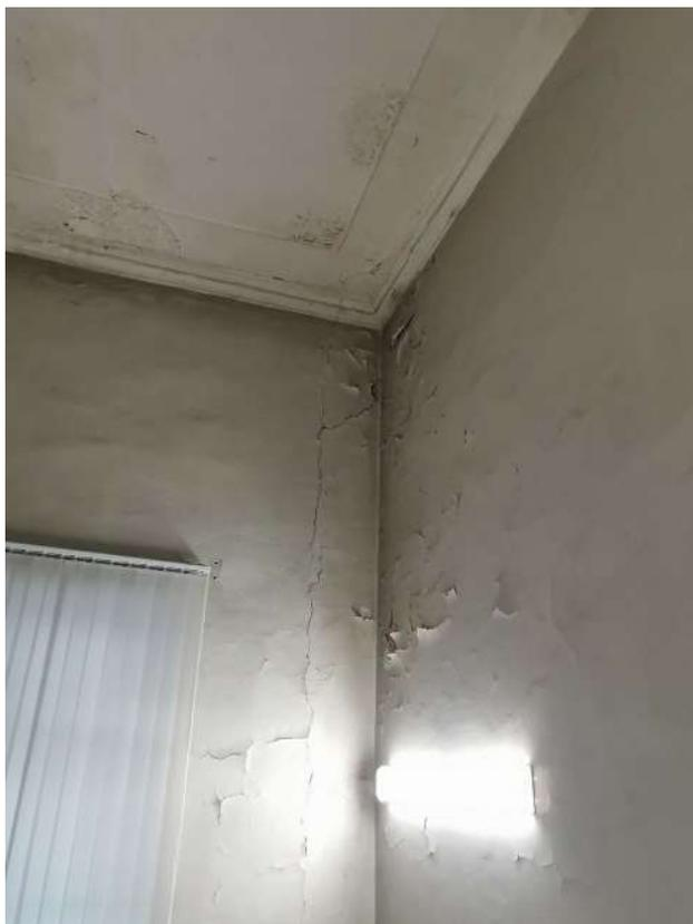
*Фото 41. Фрагмент стены. Наблюдаются трещины и отслоение штукатурного слоя в местах замачивания.*
