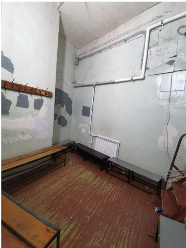
*Фото 19. Общий вид мужской раздевалки. Наблюдаются следы некачественного ремонта, истирание и растрескивание деревянного покрытия пола, общая загрязненность.*
