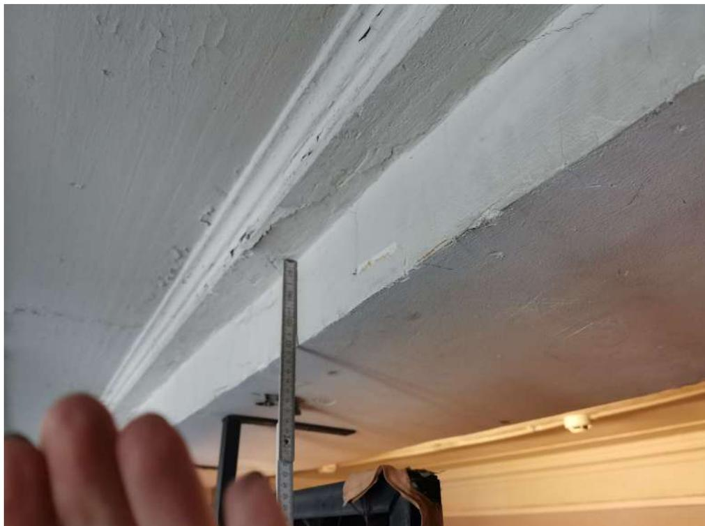
*Фото 16. Фрагмент потолка с лепниной в спортивном зале. Наблюдаются трещины и отслоение штукатурного слоя, потеки и общая загрязненность.*
