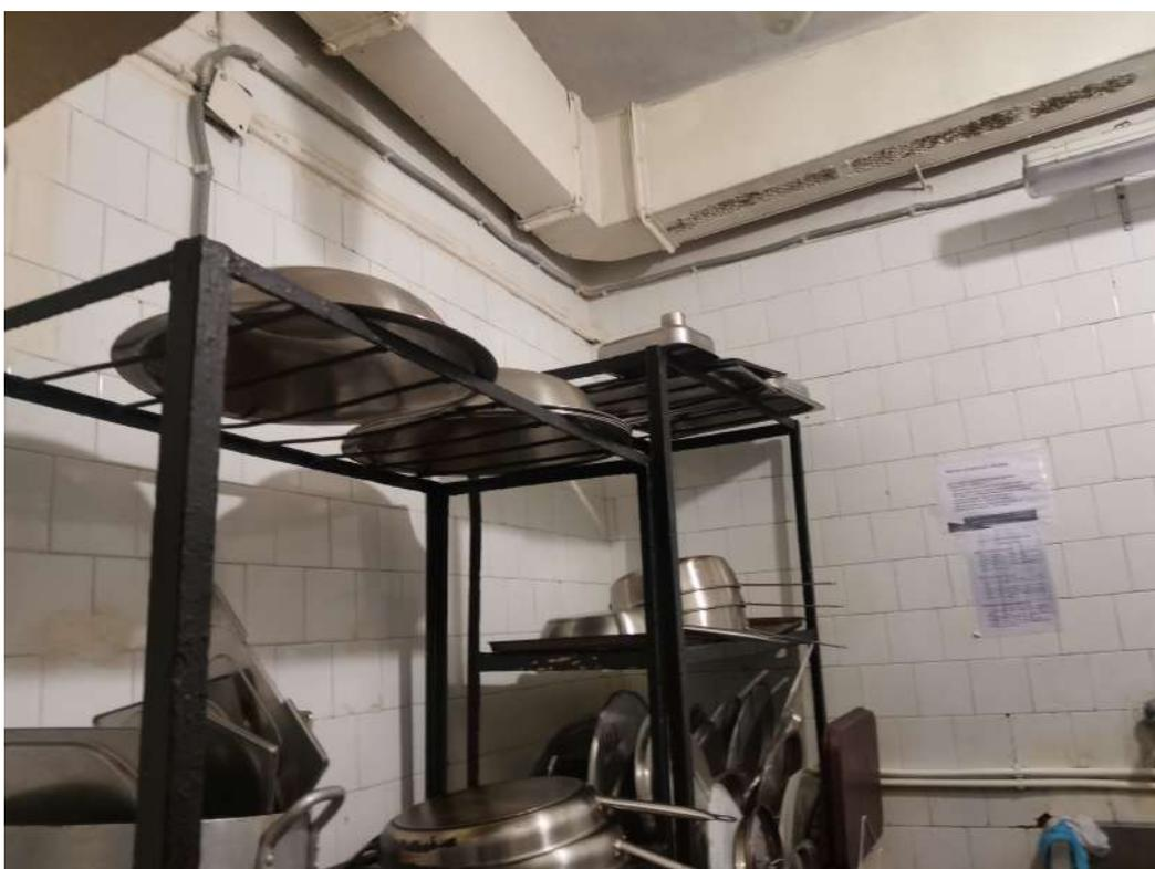
*Фото №69 Фрагмент помещения моечной. Наблюдаются следы загрязнений красочными составами*
