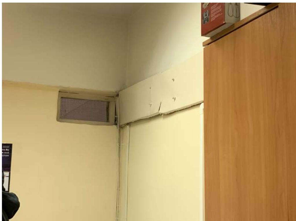
*Фото №42 Фрагмент стены в кабинете заведующей. Наблюдаются трещины и неровности в отделке*
