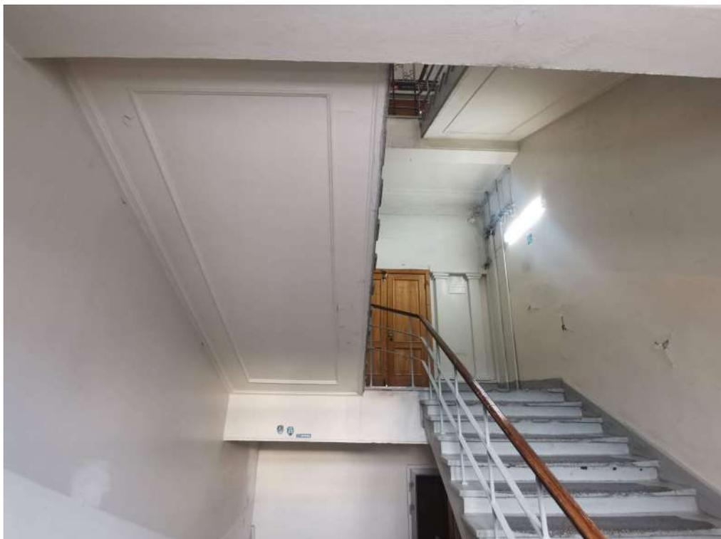
*Фото 15. Общий вид на площадку 2 этажа. Наблюдаются следы некачественного ремонта, отслоение красочного слоя, общая загрязненность.*
