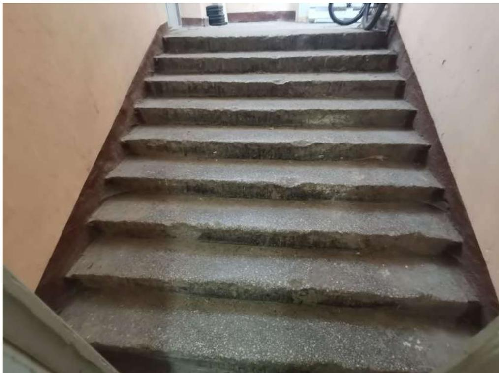
*Фото 3. Фрагмент лестницы. Наблюдаются сколы бетонных проступей, истирание покрытия.*
