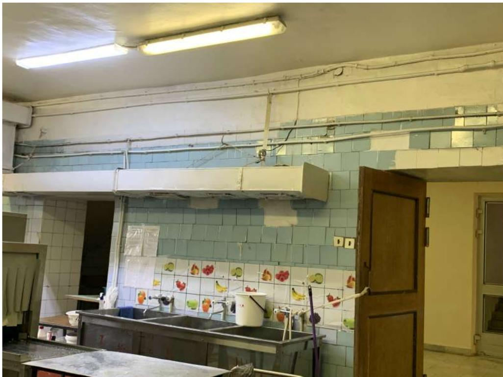
*Фото № 23 Вид на вход в зону грязной посуды и выход из помещения (пом. №53). Наблюдается сильный износ отделочных материалов*
