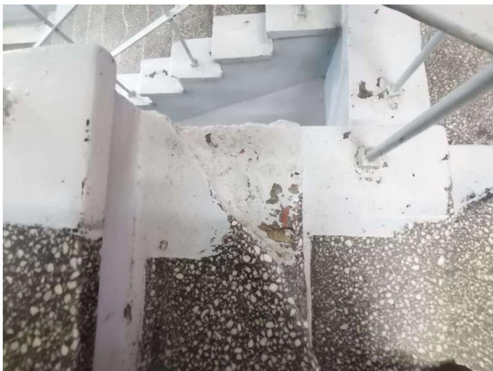
*Фото 34. Фрагмент ступени. Наблюдается сколы бетонных проступей, истирание покрытия мрамором и техникой терраццо,*
