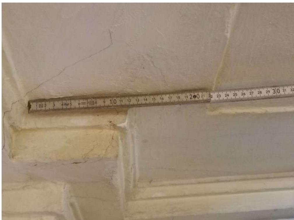
*Фото 12. Фрагмент потолка с лепниной в мужской раздевалке. Наблюдаются трещины и отслоение штукатурного слоя, потеки, общая загрязненность.*
