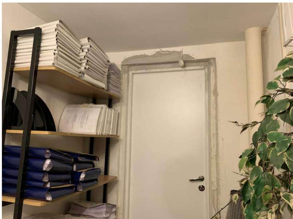
*Фото № 16 Фрагмент помещения кабинет бухгалтерии (пом. №62). Наблюдаются следы некачественного позднего ремонта*
