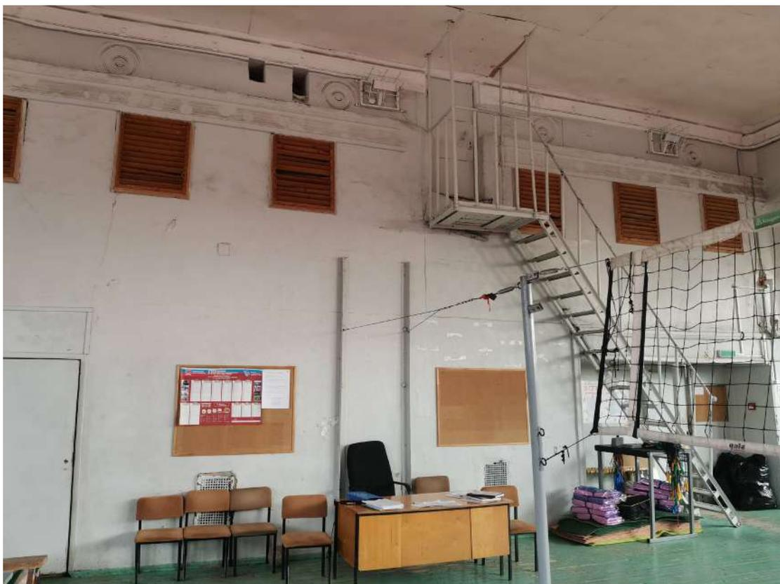
*Фото 13. Общий вид спортивного зала. Наблюдается трещины и отслоение штукатурного слоя, коробление подшивки потолка, потеки и общая загрязненность.*
