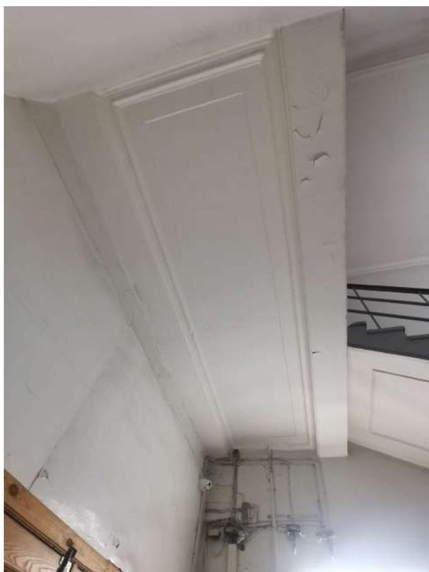
*Фото 22. Фрагмент потолка. Наблюдается шелушение и отслоение красочного слоя.*
