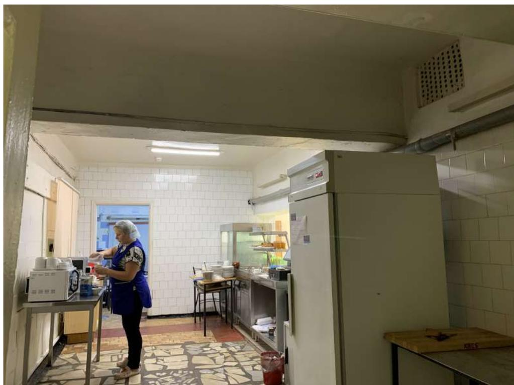
*Фото №38 Общий вид на помещение Раздача №2. Наблюдается сильный износ отделочных материалов. Полы в неудовлетворительном состоянии*
