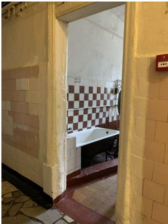
*Фото №4.3 Вид на вход в помещение Овощной цех. Наблюдаются загрязнения красочным составом, Следы некачественного позднего ремонта*
