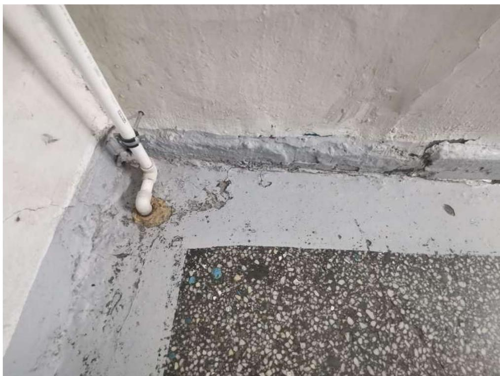
*Фото 36. Фрагмент пола. Наблюдается трещины, истертость красочного слоя, общая загрязненность.*
