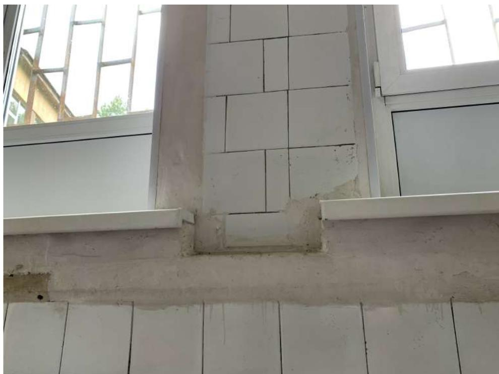
*Фото №50 Фрагмент подоконника. Наблюдается загрязнение красочным составом. Частичное отсутствие отделочных материалов*
