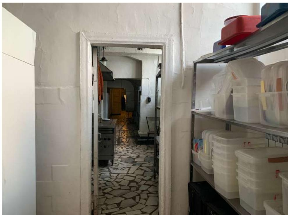
*Фото № 52 Фрагмент дверного проема между Холодным и Горячим цехами. Отделка стен в неудовлетворительном состоянии*
