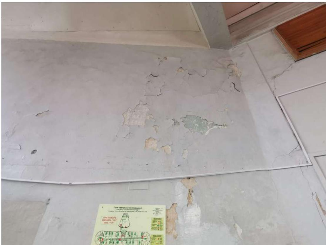
*Фото 15. Фрагмент стены. Наблюдается старение, загрязнение и шелушение окрасочного покрытия стен.*
