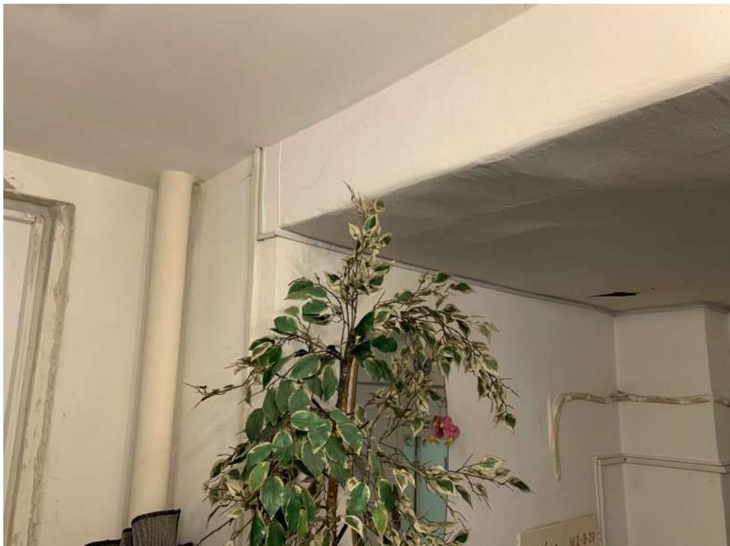
*Фото № 15 Фрагмент кабинета бухгалтерии (пом. №62). Наблюдаются трещины и бухтение штукатурного слоя*
