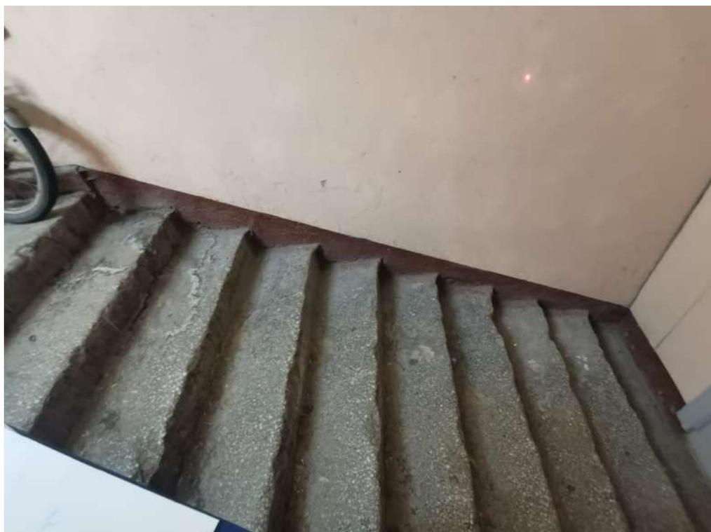
*Фото 4. Фрагмент лестницы. Наблюдаются сколы бетонных проступей, истирание покрытия.*
