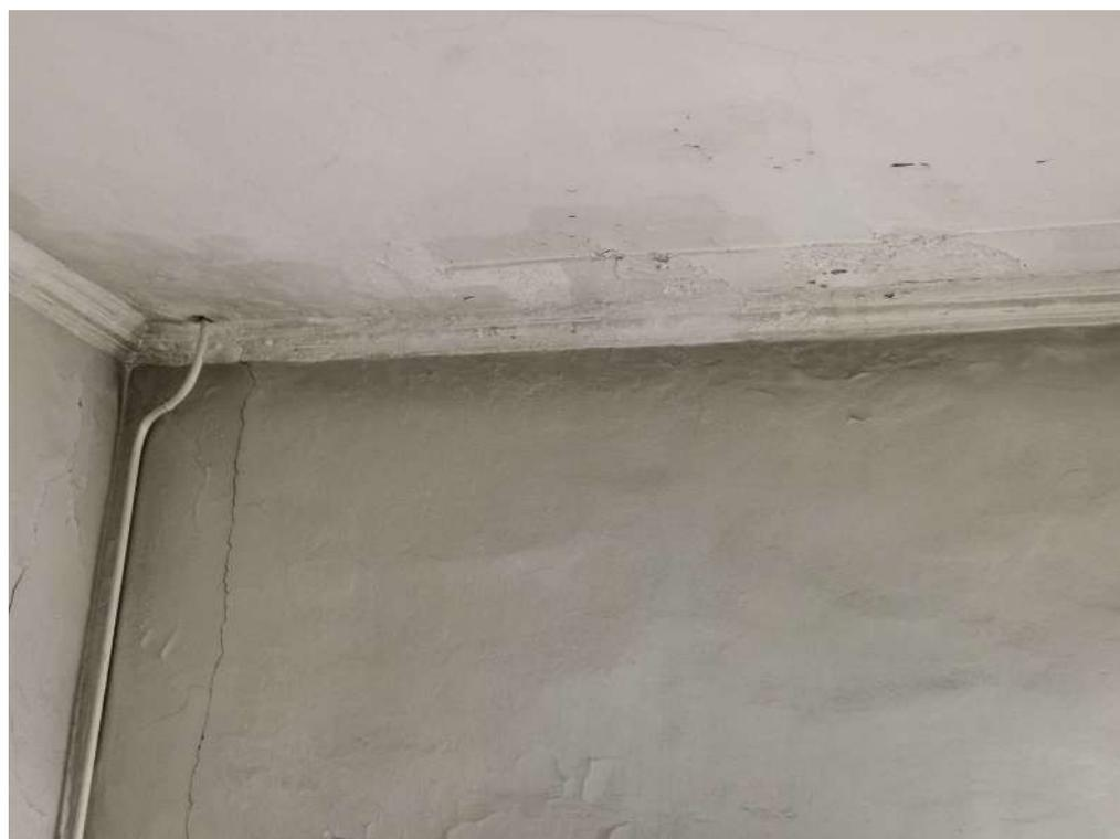
*Фото 38. Фрагмент стены. Наблюдаются трещины, частичные утраты лепнины и разрушения штукатурного слоя в местах замачивания.*
