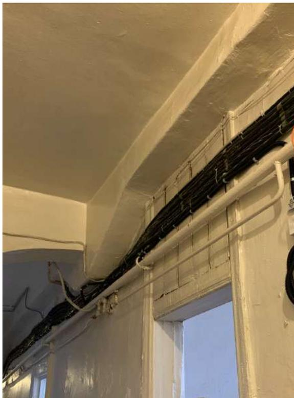
*Фото № 25 Фрагмент арки с опорой на пилоны. Следы некачественного позднего ремонта. Сильное загрязнение, бухтение красочного слоя.*
