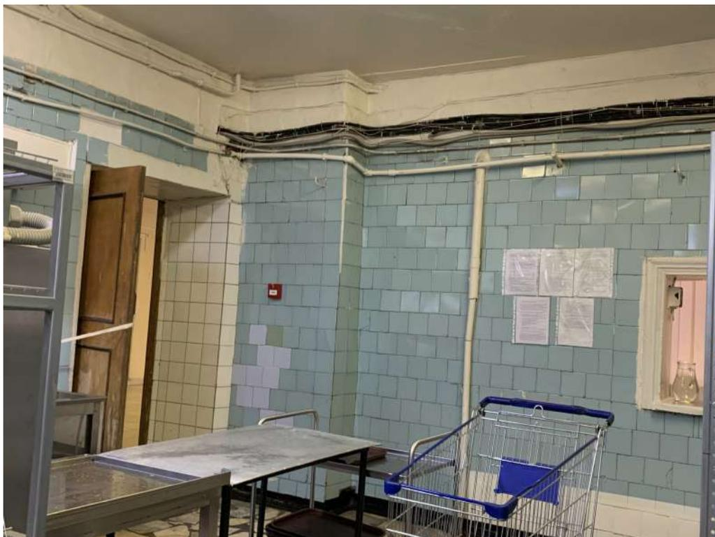
*Фото № 21 Вид на вход в помещение моечной кухонной посуды (пом. №53). Наблюдаются следы некачественного позднего ремонта, частичная утеря плитки в отделке, сильный износ дверного заполнения, шелушение и дбухтение штукатурного слоя*
