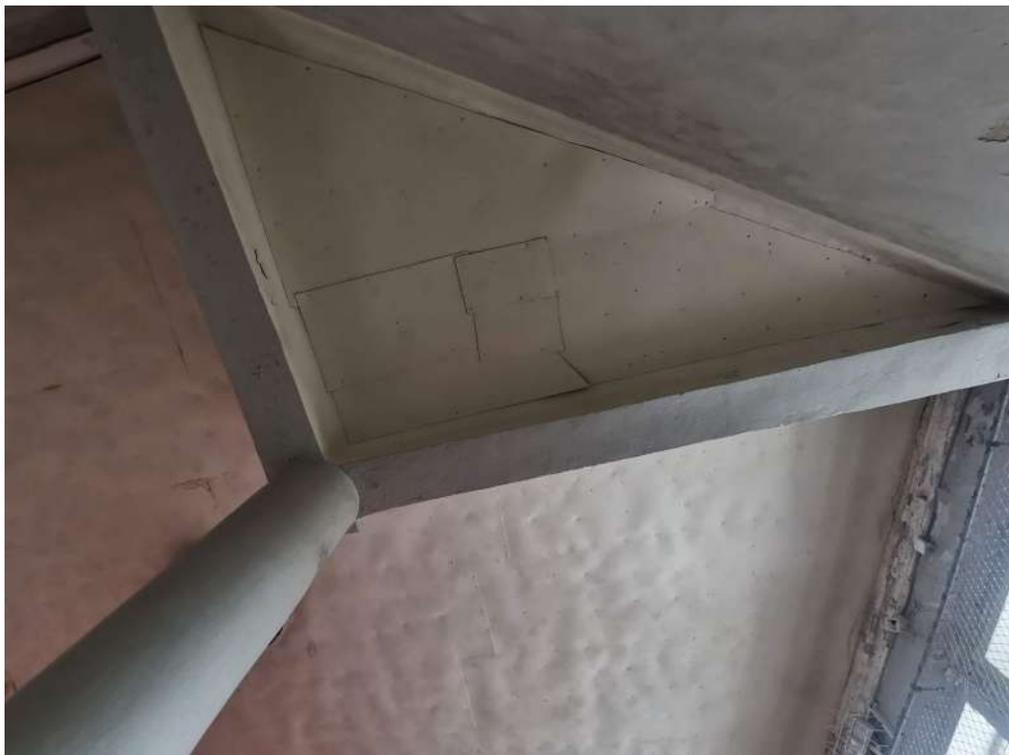
*Фото 11. Фрагмент выступающей части. Наблюдаются трещины и коробление подшивки потолка, общая загрязненность.*
