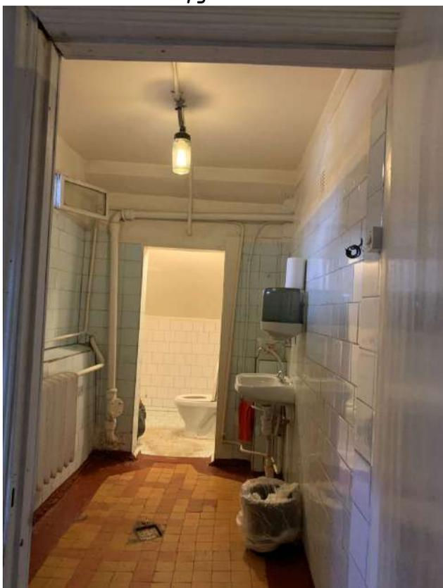
*Фото №79 Вид на дверное заполнение. Наблюдается рассыхание дверной коробки*
