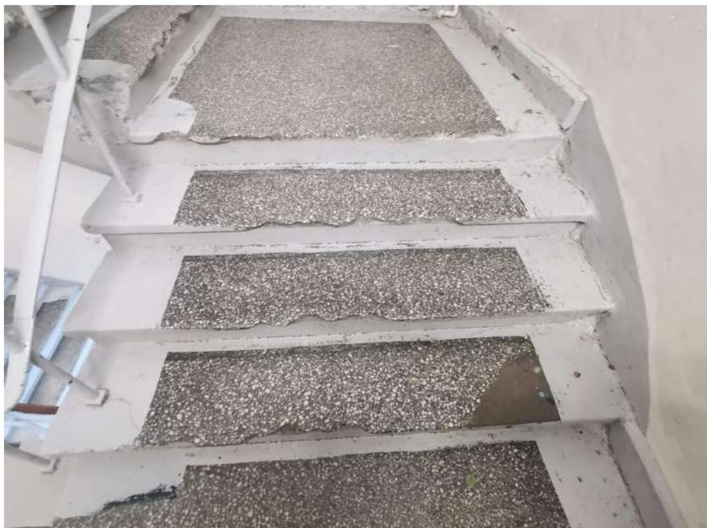
*Фото 27. Фрагмент ступеней. Наблюдаются сколы бетонных проступей, истирание покрытия, общая загрязненность.*
