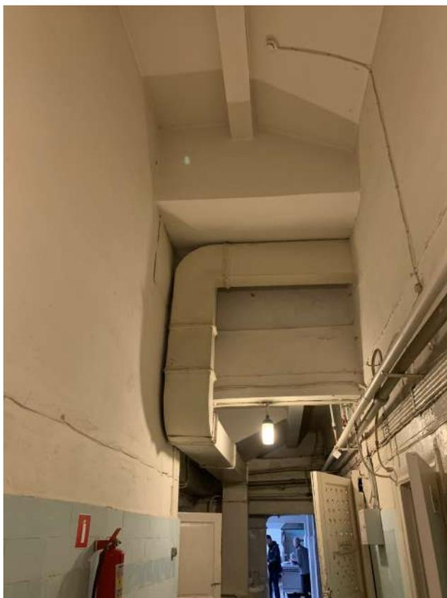
*Фото №64 Вид на верхнюю часть Коридора №2. Наблюдается деструкция красочного слоя, открытая разводка коммуникаций*
