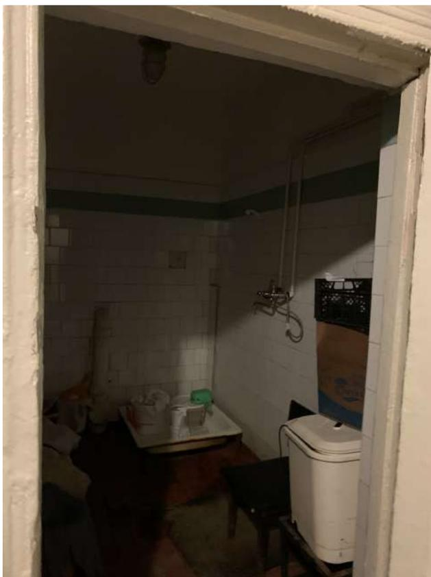
*Фото № 74 вид на помещение душевой и инвентарной. Наблюдается сильный износ керамической плитки и санитарного оборудования*
