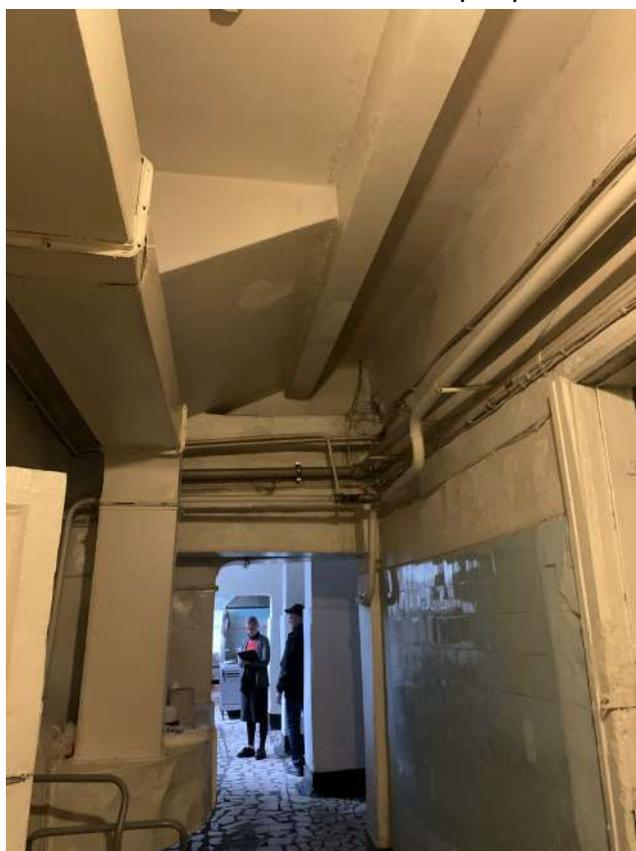
*Фото №64 Вид на Горячий цех со стороны коридора №2. Наблюдается сильный износ и загрязненность отделочных материалов*
