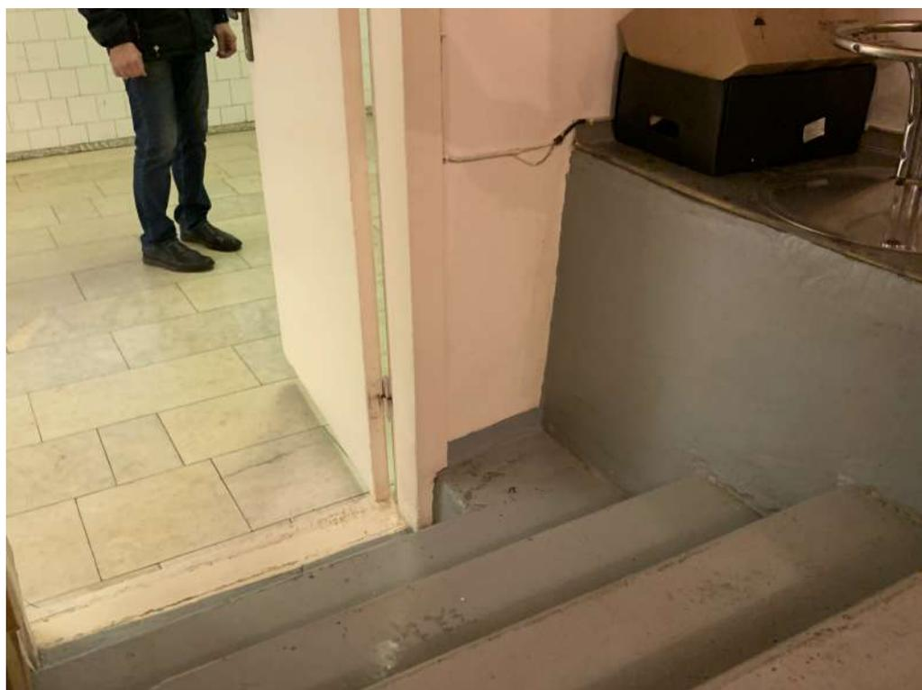
*Фото № 18 Фрагмент напольных покрытий из кабинета бухгалтера (пом. №62). Наблюдается сильная истертость покрытий пола, бухтение штукатурного слоя*
