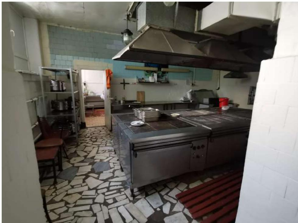
*Фото №55 Вид на кухонное оборудование в помещении Горячий цех. Отделка стены керамической плиткой в неудовлетворительном состоянии*
