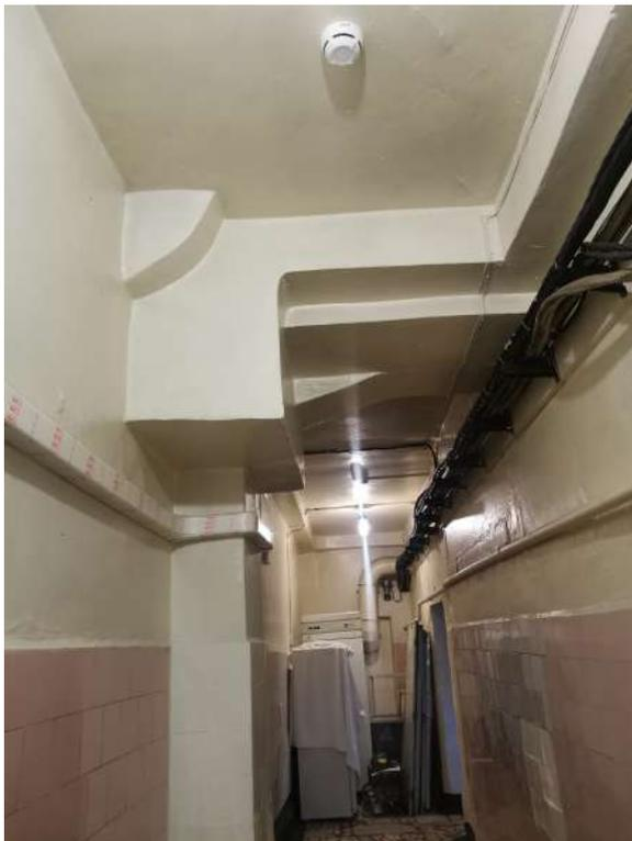
*Фото № 31 Фрагмент помещения коридор (пом. №33) арки с опорой на пилоны. Сильный износ отделочных материалов, общее загрязнение*
