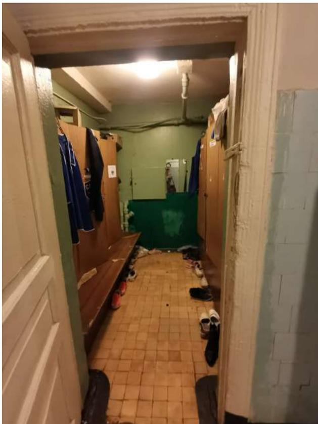
*Фото № 76 Вид на дверное заполнение в помещении Раздевалки. Наблюдаются неровности и множественные красочные слои на наличниках*
