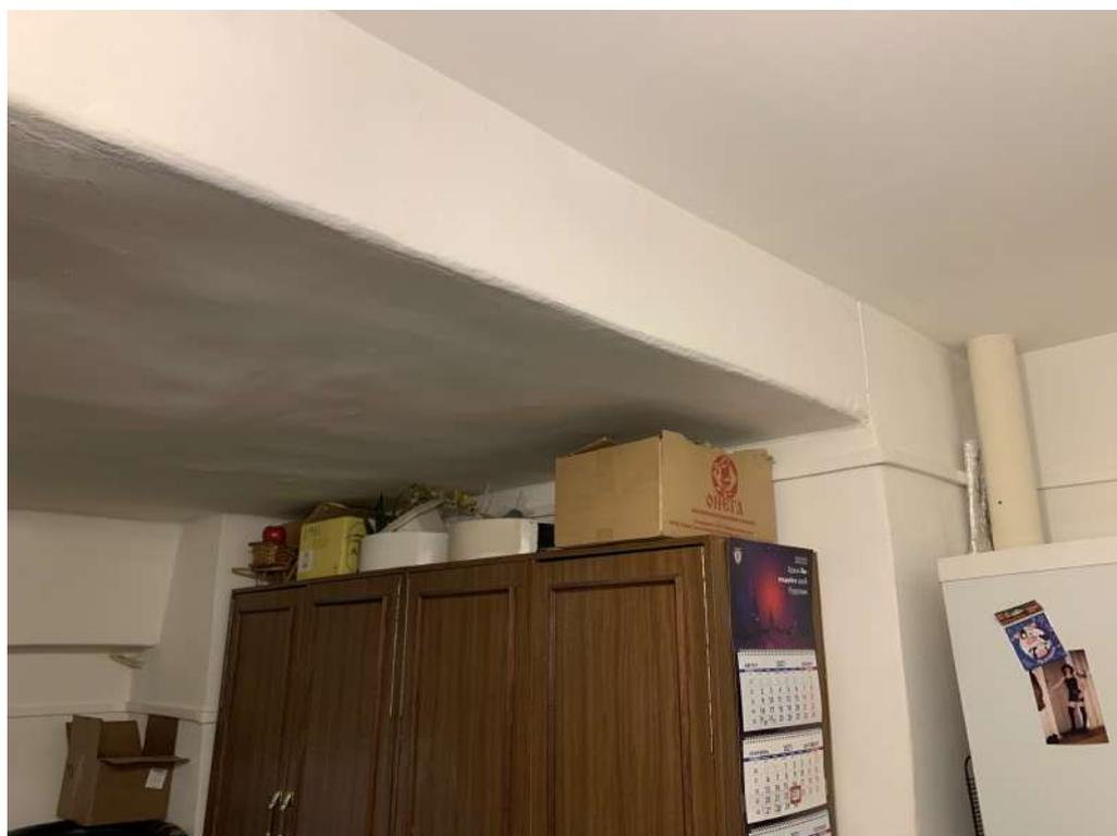
*Фото №14 Фрагмент кабинета бухгалтерии (пом. №62). Наблюдаются следы некачественного позднего ремонта*
