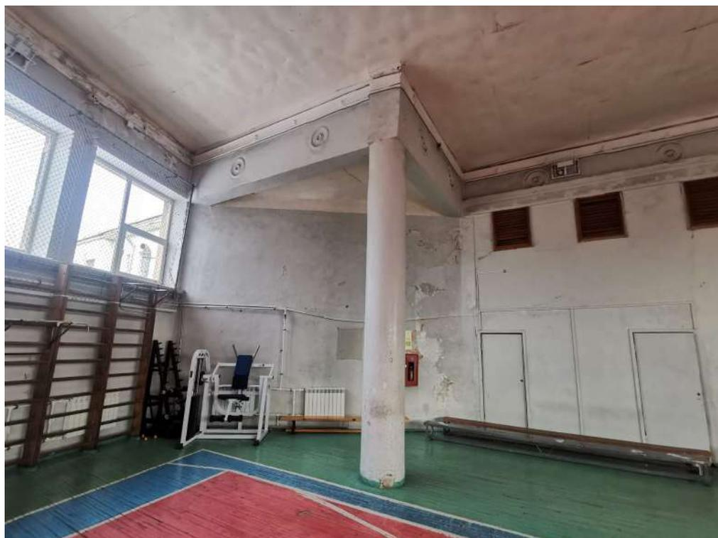
*Фото 10. Общий вид на колонну. Наблюдается старение, загрязнение и шелушение окрасочного слоя, частичная утрата лепного декора.*
