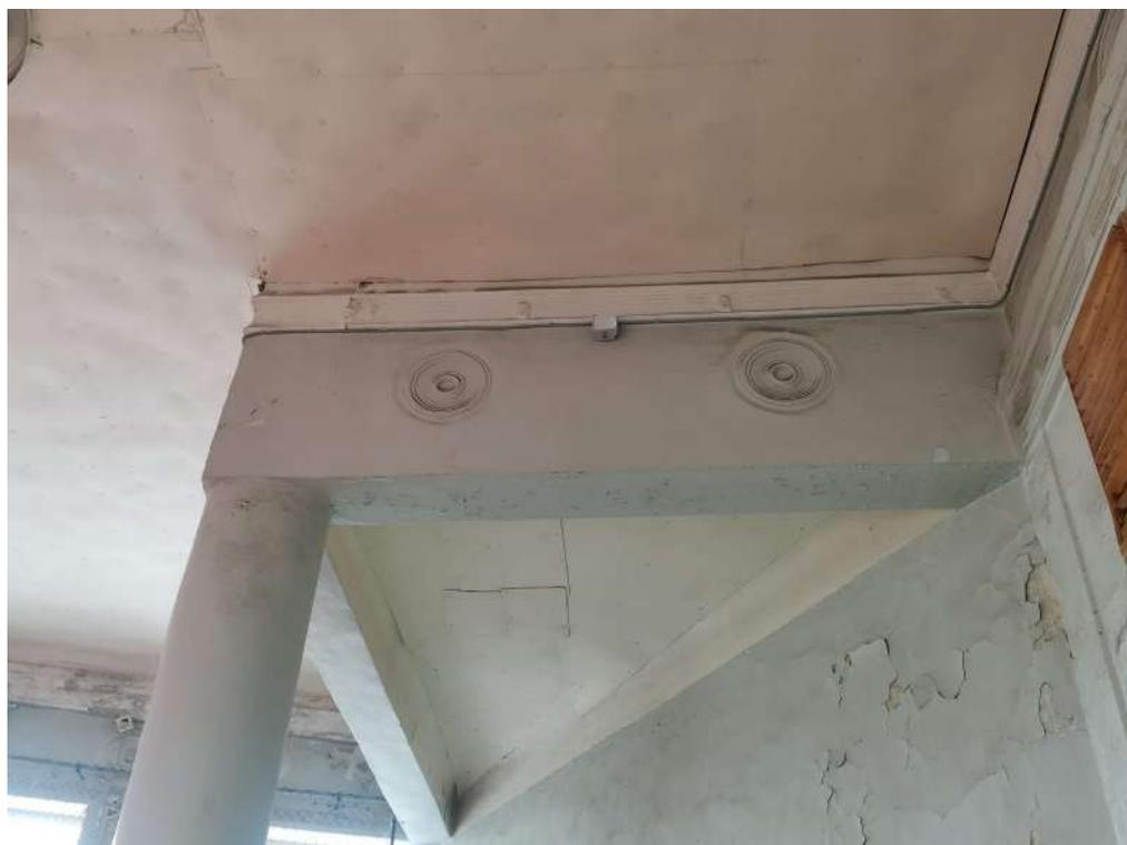
*Фото 12. Фрагмент выступающей части. Наблюдаются трещины и отслоение штукатурного слоя, множественные наслоения красочного слоя, коробление подшивки потолка, потеки и общая загрязненность.*
