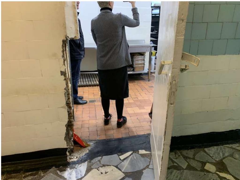
*Фото № 35 Фрагмент входа в помещения кондитерская (пом. №51). Наблюдается грубое частичное расширение дверного проема. Общее загрязнение керамической плитки*
