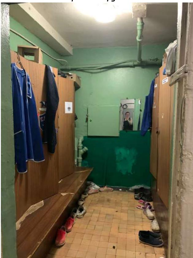
*Фото №75 Общий вид на помещение раздевалки. Мебель рассохлась и частично утратила верхний слой*
