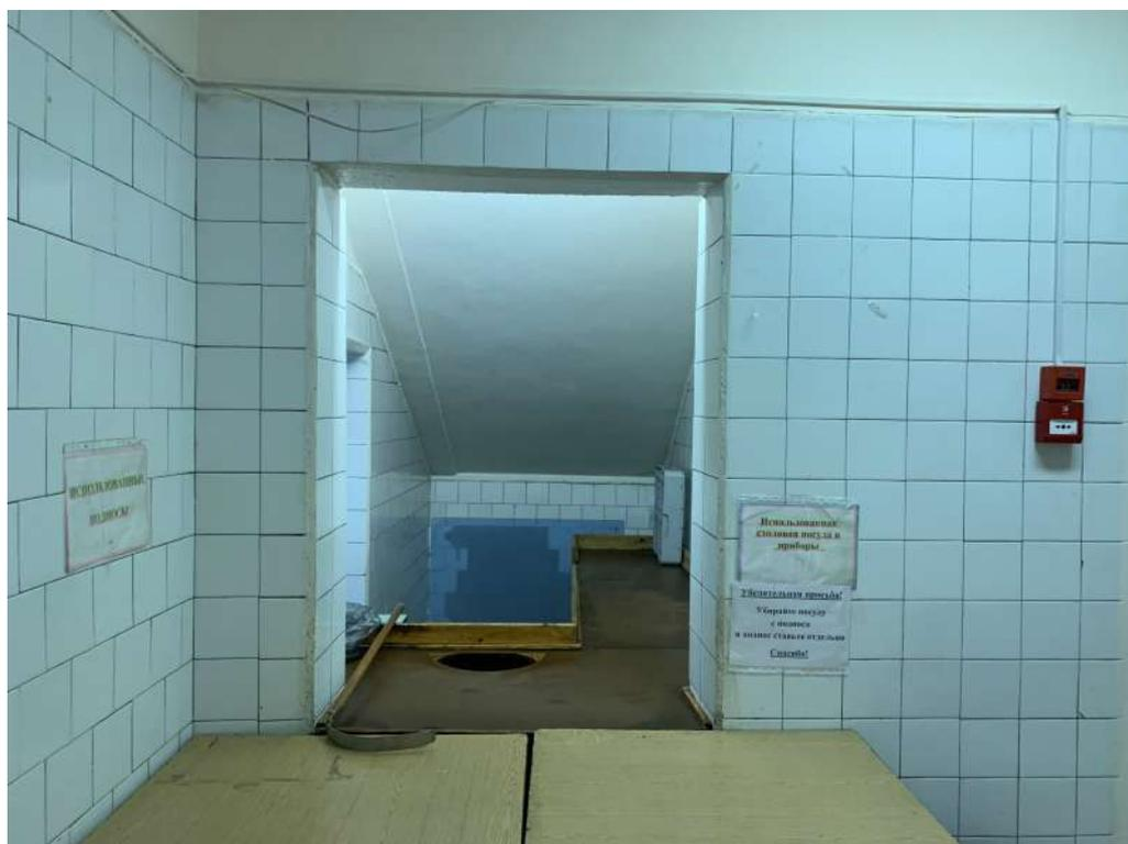
*Фото № 10 Вид на окно для приема грязной посуды. Наблюдается сильный износ покрытий, размещение цеха не соответствует СанПиНу 2.3/2.4.3590–20. пом. №58)*
