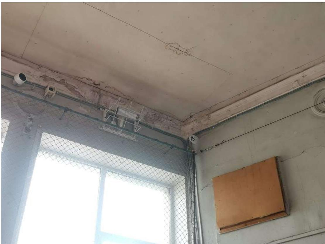
*Фото 7. Фрагмент стены. Наблюдаются трещины и отслоение красочного слоя, частичная утрата лепнины, коробление подшивки потолка, потеки и общая*
