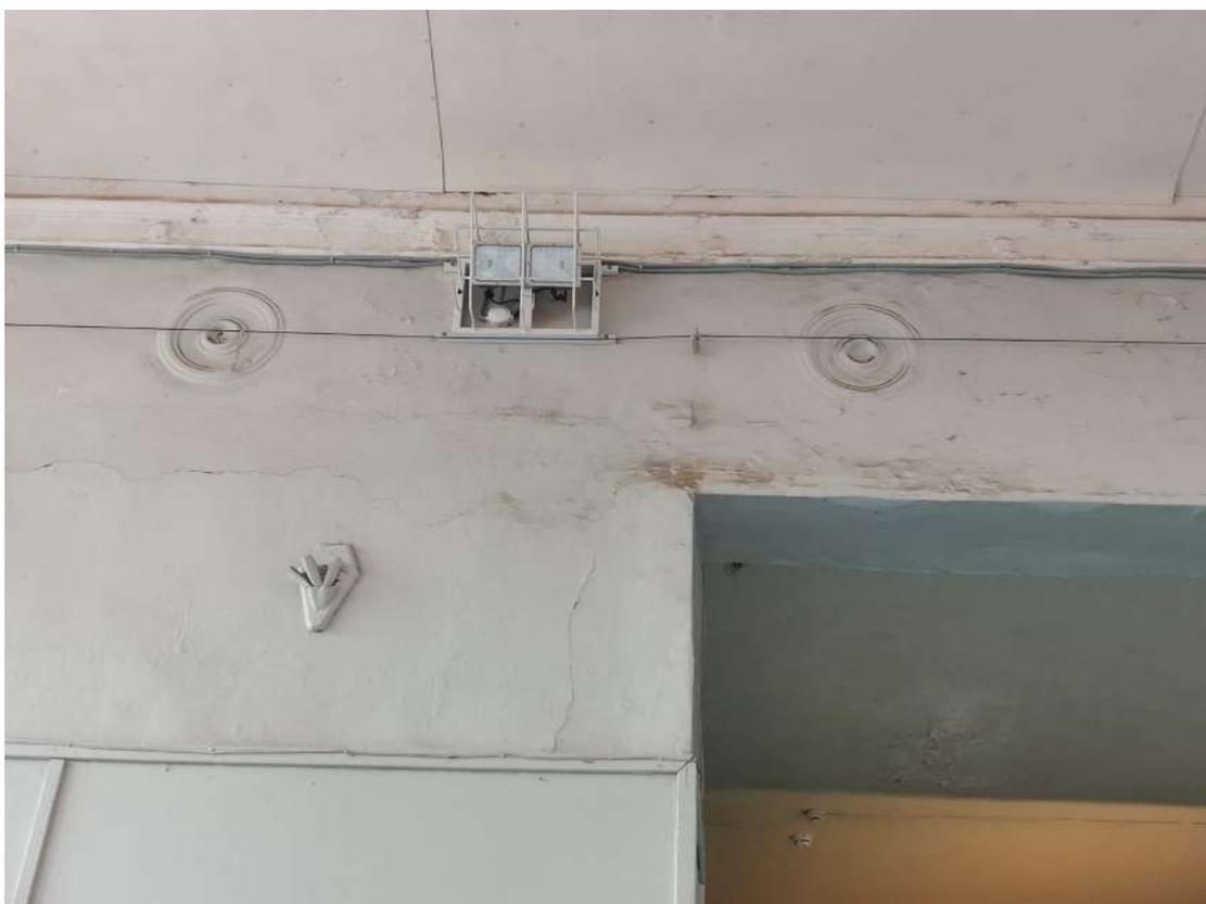
*Фото 7. Фрагмент стены. Наблюдаются трещины, коробление подшивки потолка, потеки и общая загрязненность.*
