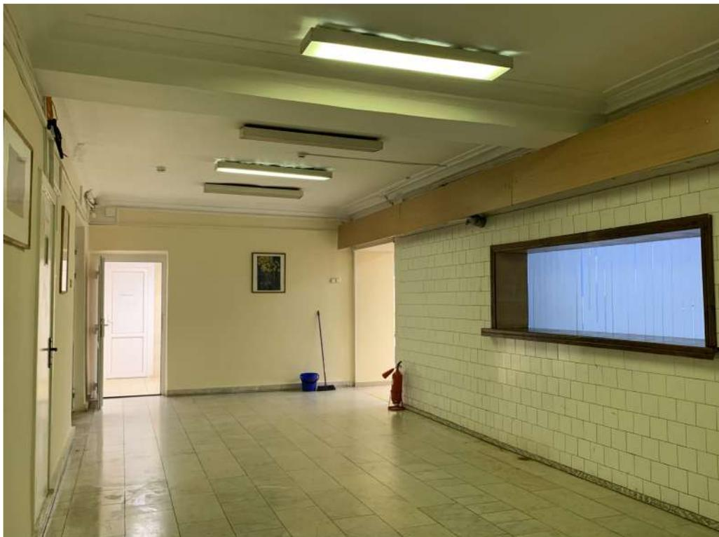
*Фото № 7 Общий вид помещения холла (пом. №58). Наблюдается сильный износ отделочных материалов*
