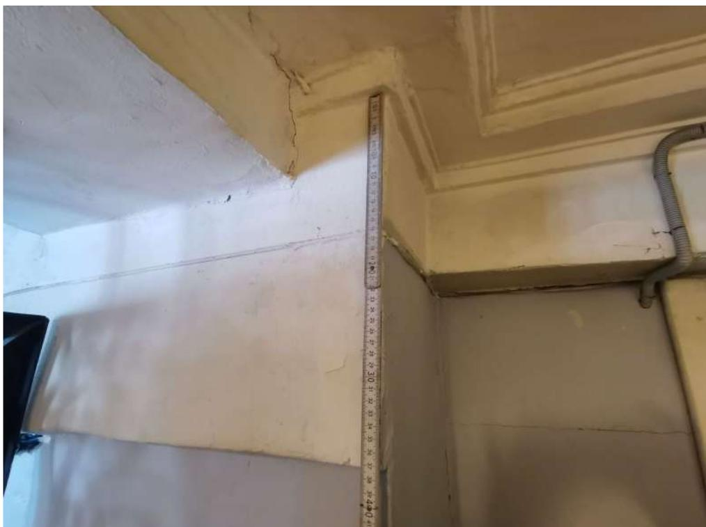
*Фото 10. Фрагмент потолка с лепниной в мужской раздевалке. Наблюдаются трещины и отслоение штукатурного слоя, множественные наслоения красочного слоя, потеки, общая загрязненность.*
