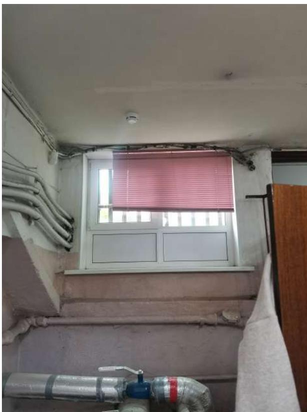
*Фото №83 Вид на оконное заполнение в помещении Склада продуктов. Неровности красочного слоя. Прокладка сетей открытым способом*
