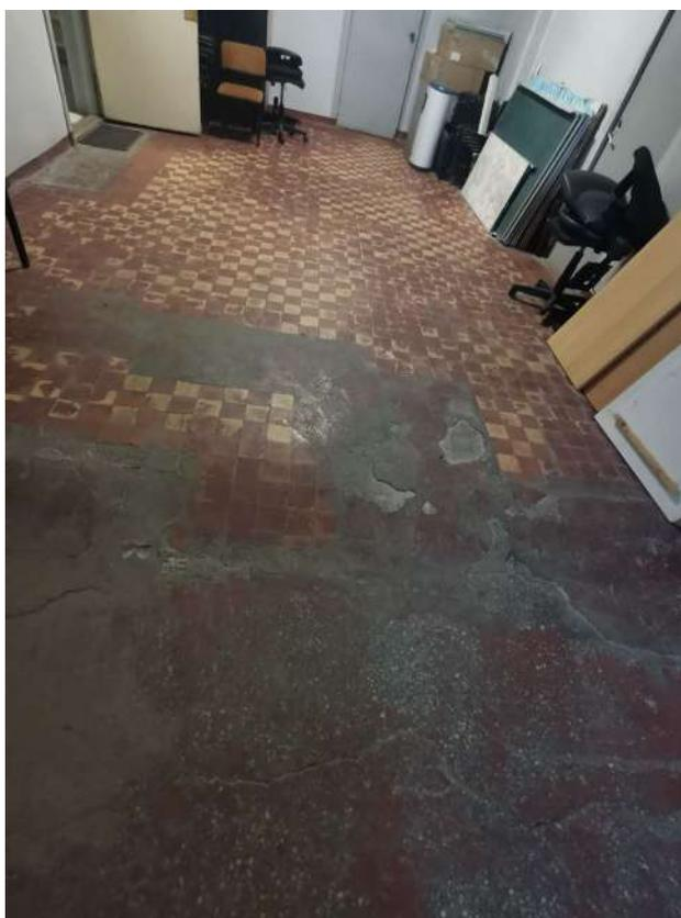
*Фото 16. Фрагмент пола. Наблюдается износ и потертости плитки.*
