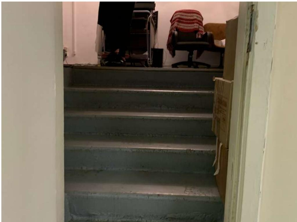
*Фото № 17 Вид на лестницу при входе в кабинет бухгалтера (пом. №62). Наблюдается сильный износ покрытия лестницы*
