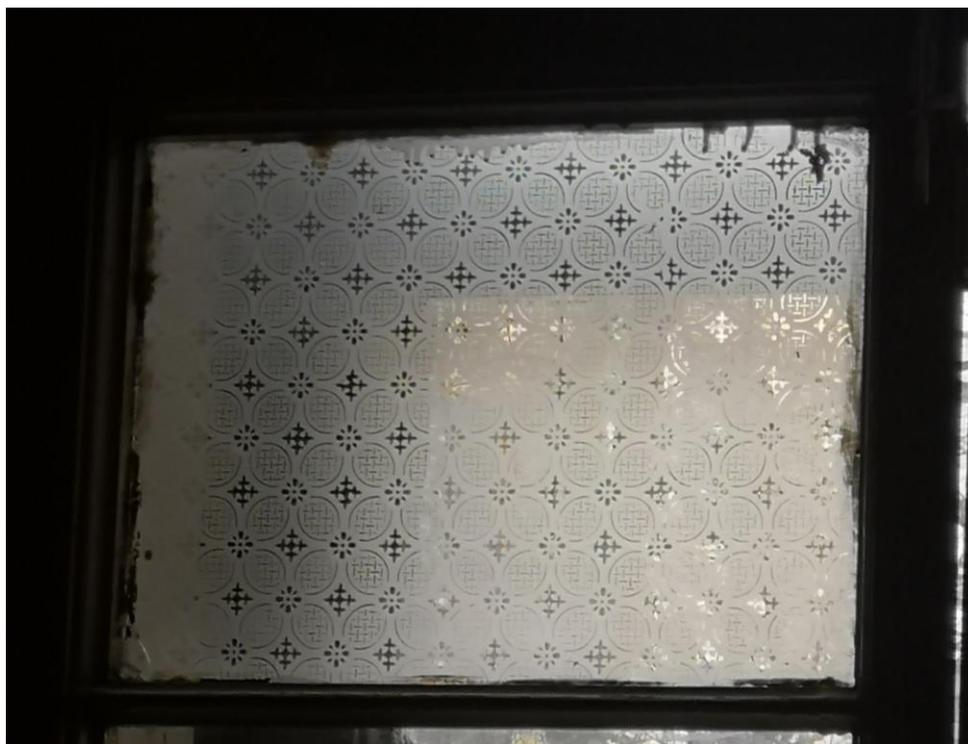
Фото.43. Травленное стекло. Заполнение рамы оконного проема на первом этаже.
