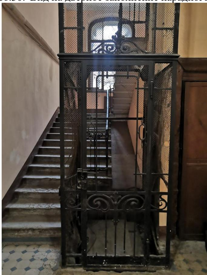
Фото.31. Вид на сохранившиеся металлические конструкции лифта.
